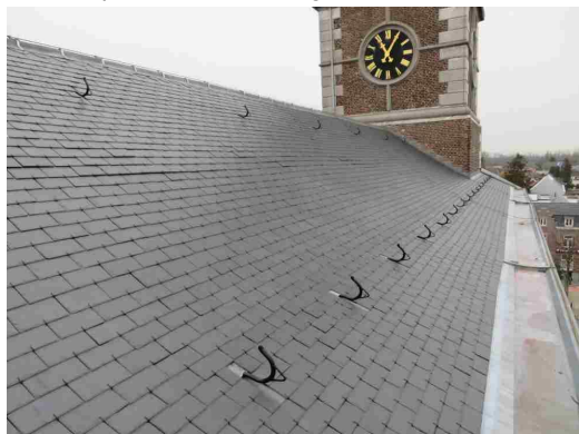
Correct geplaatste en voldoende genormeerde ladderhaken.
