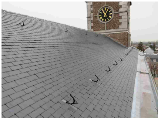
Goten dan dakvlakken verkeren in goede staat.
