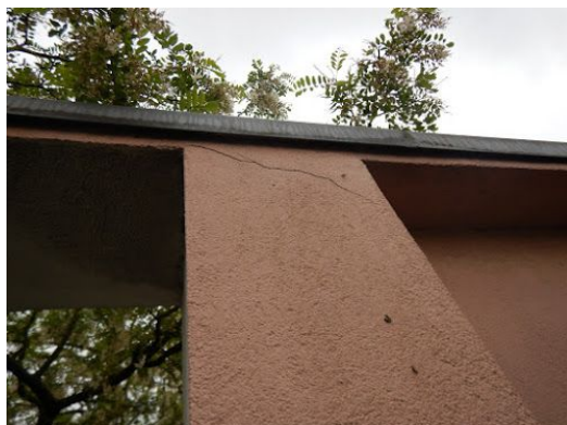
Lichte scheurvorming bovenaan de doorgang naar balkon [3]
