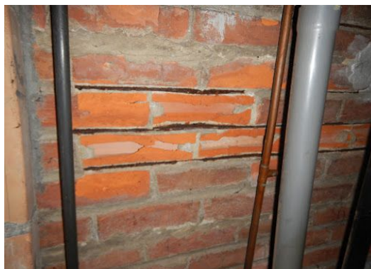
Verzwakte vloerplaat door roesten voegwapening
