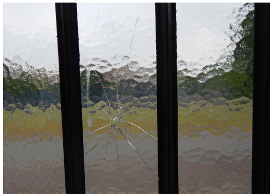
Ster in het keukenraam in de voorgevel
