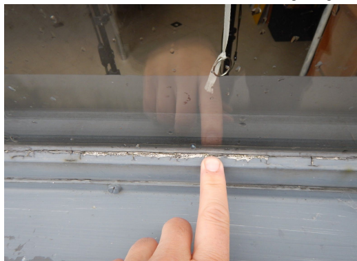
Slechte condensafvoer met vochtschade tot gevolg.
