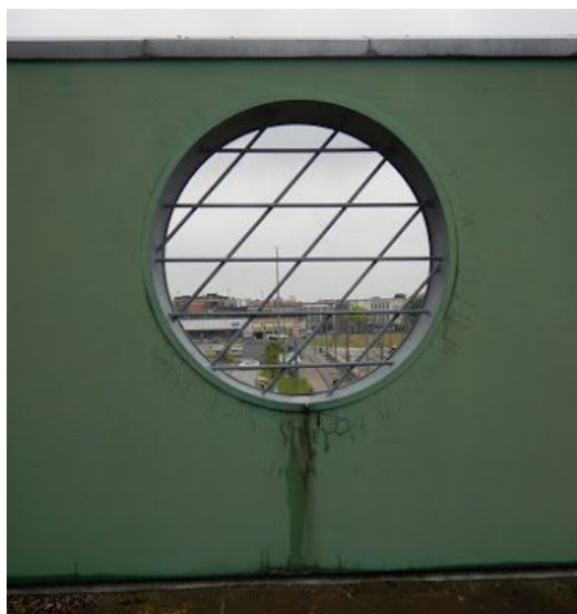
Zijde terras: schade aan de bepleistering
