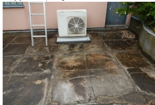
Stremmen goede afwatering door opstelling airco-unit
