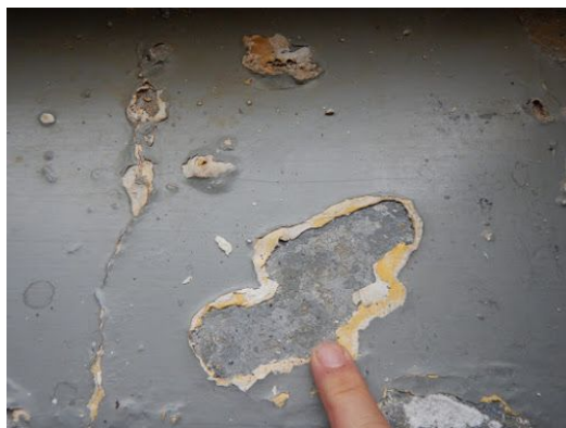
Opgestuwde afwerkklagen en sporen oorspronkelijke verflagen
