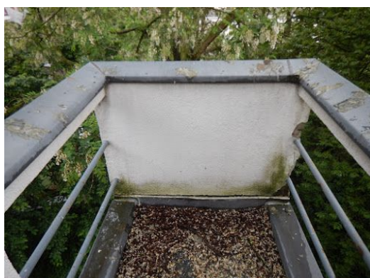
Openstaande aansluiting gemetselde borstwering en vervuilde vloer
