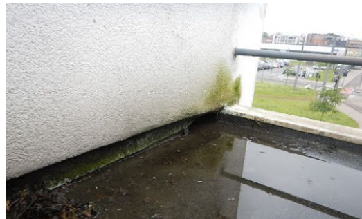
Balkon [4]: afvoeropening in de binnenopstand
