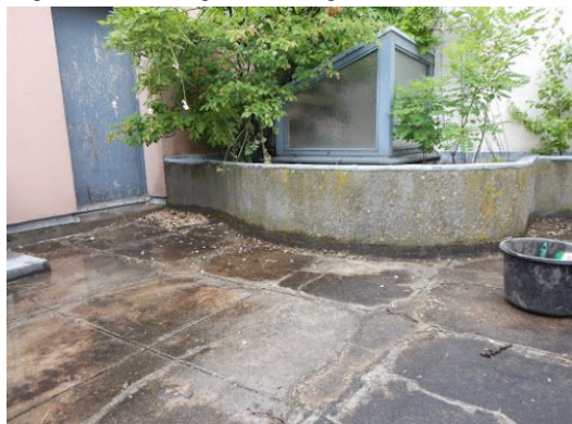
Bloembakken terras: aftekening opstanden dakfolie (donkere rand op de borstwering)
