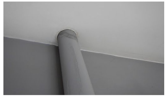
Inpandige afvoer dak [1]
