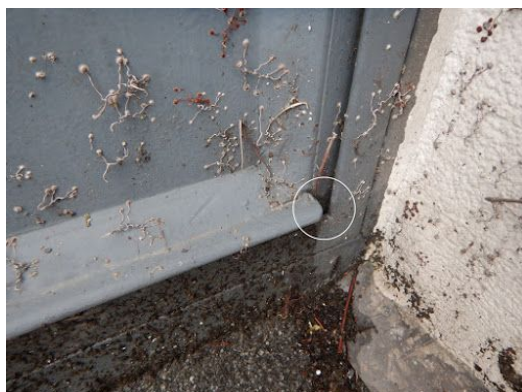
balkon [4]: deurdorpel sluit niet waterdicht aan op de deurkader
