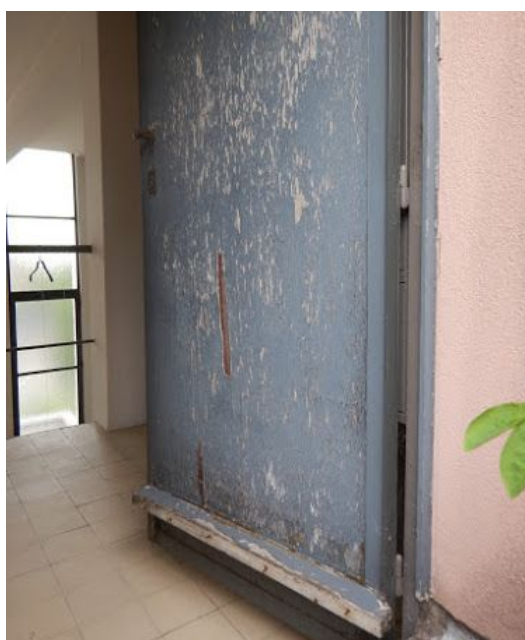
Afbladderend verfsysteem
