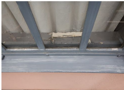
Slechte condensafvoer met vochtschade tot gevolg.
