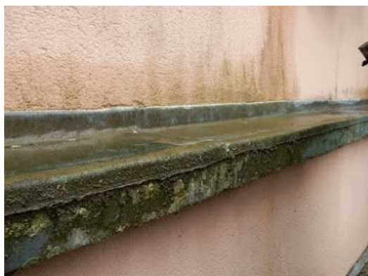
Opspattend regenwater en algenvorming
