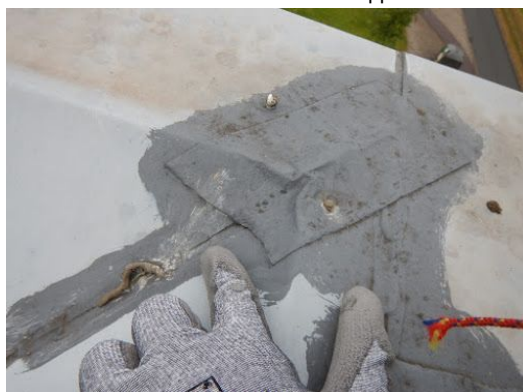
Ingescheurde herstelling
