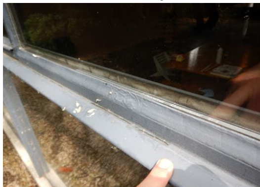
Beschadigd verfsysteem
