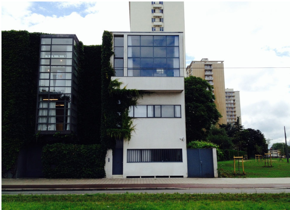
> Façade de la maison Guiette, avec la voirie du tramway et le caténaire passant devant la maison.
