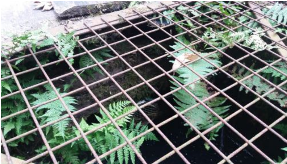
Figuur 45 - Uitmondende drainagebuis met rooster in Berta 4
