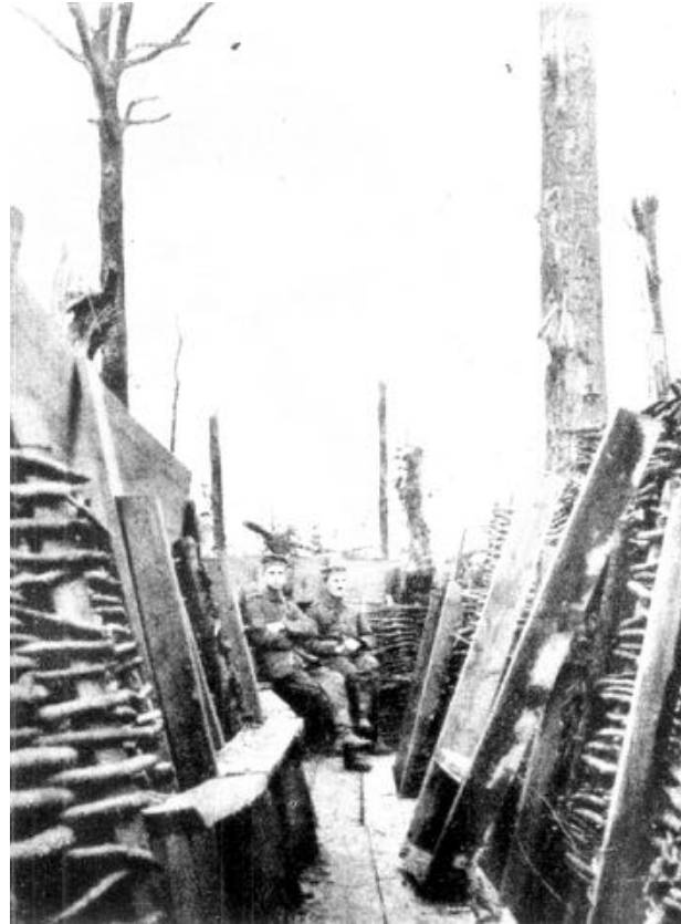
Figuur 18 - Zomer 1916 - Twee Duitsers van RIR 213 in Bayernwald. Let op de typische vlechtwerkbouw, de A-frames voor observatie en/of om uit de loopgraven te klauteren en de bedekking van de grond met planken. (Bostyn F., Vancoillie J., Barton P. & Vandewalle J. (2000). Bayernwald – Het Croonaertbos in de Eerste Wereldoorlog, p. 47)
