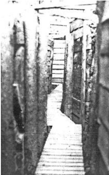
Figuur 25 - Overwelfde verbindingsgalerij tussen de bunkers en de diepe mijnschacht in 1983. (Bostyn F., Vancoillie J., Barton P. & Vandewalle J. (2000). Bayernwald – Het Croonaertbos in de Eerste Wereldoorlog, p. 174)
