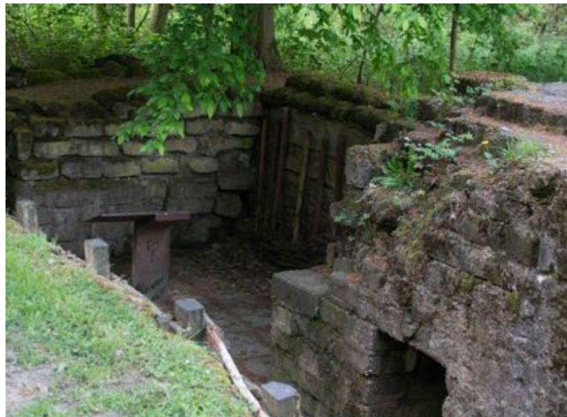
Figuur 16 - Foto van de bunker anno 2018
