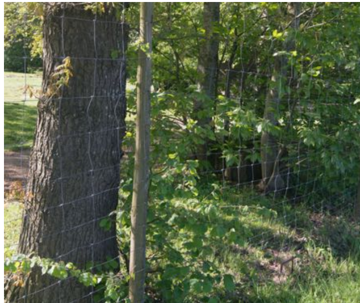
Figuur 62 - Detail draadafsluiting met houten palen
