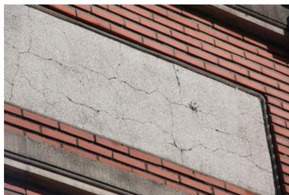
Afbeelding 47 : Pleisterwerk straatgevel vertoont veel barsten en ook plaatselijk afgebroken. (Bron: Maarten Dobbelaere)
