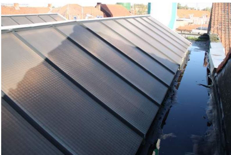
Afbeelding 45: Plat dak met lichtstraten, enkele gebarsten glazen panelen, regenwater en vuil op plat dak. (Bron: Maarten Dobbelaere)
