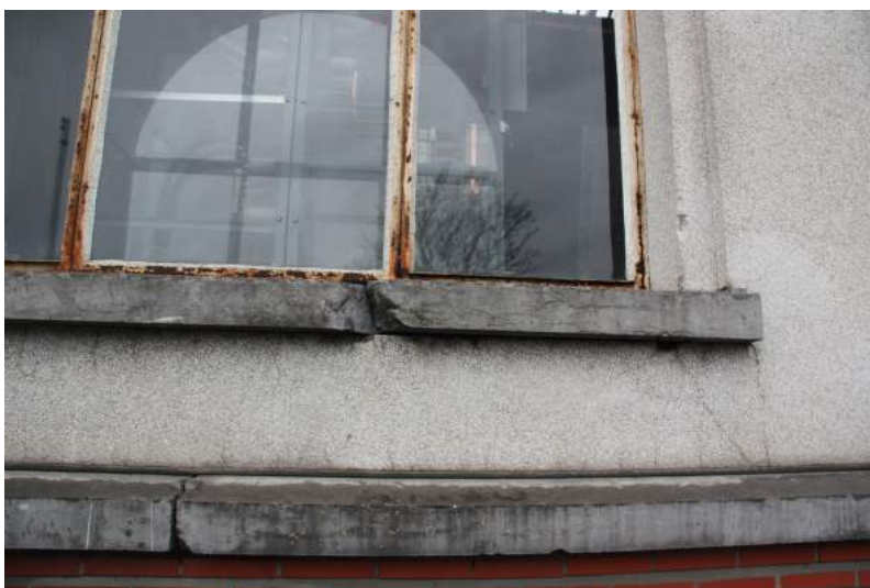
Afbeelding 51: Dorpel voorgevel, met afgebroken stukken en uitgespoelde voegen. (Bron: Maarten Dobbelaere)
