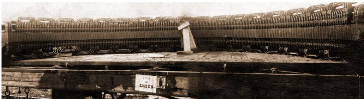
Afbeelding 27: Stator aangevoerd per trein 1936. (Bron: Stad Izegem)
