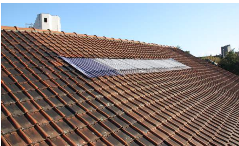
Afbeelding 44: Schuin dakvlak tweebeukige centrale met pvc-lichtstraat. (Bron: Maarten Dobbelaere)
