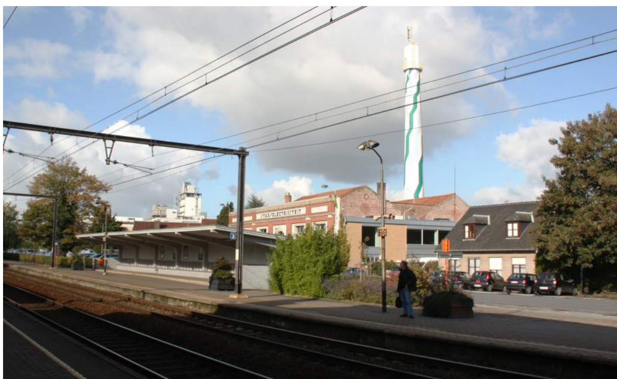
Afbeelding 4: Centrale gezien vanaf de oostzijde, vanop het treinplatform. Zicht op de gerenoveerde kantoorruimtes. (Bron: Maarten Dobbelaere 2010)
