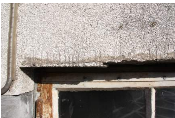
Afbeelding 47 : Pleisterwerk straatgevel vertoont veel barsten en ook plaatselijk afgebroken. (Bron: Maarten Dobbelaere)
