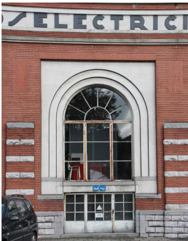
Afbeelding 35: Voorgevel met stalen schrijnwerk - 2010 (bron: Maarten Dobbelaere)
