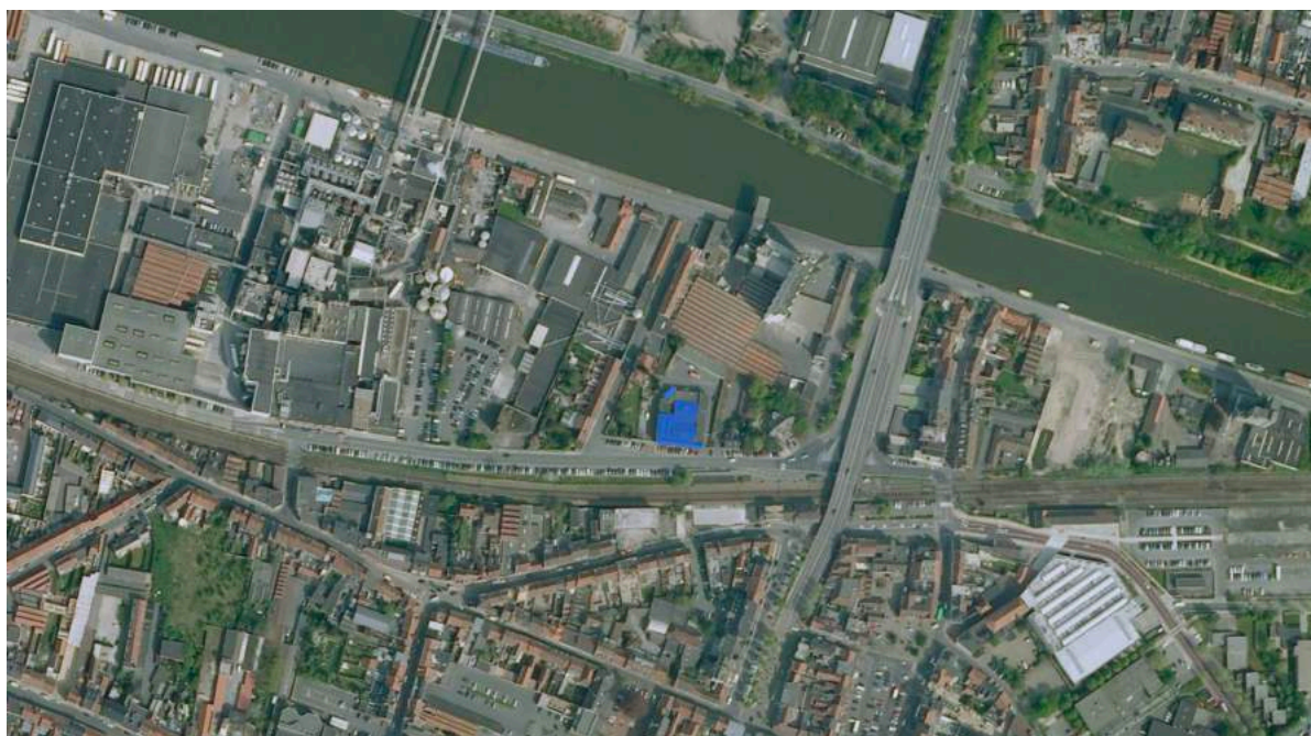
Afbeelding 1: Elektriciteitscentrale Izegem. (Bron: Google Earth)
