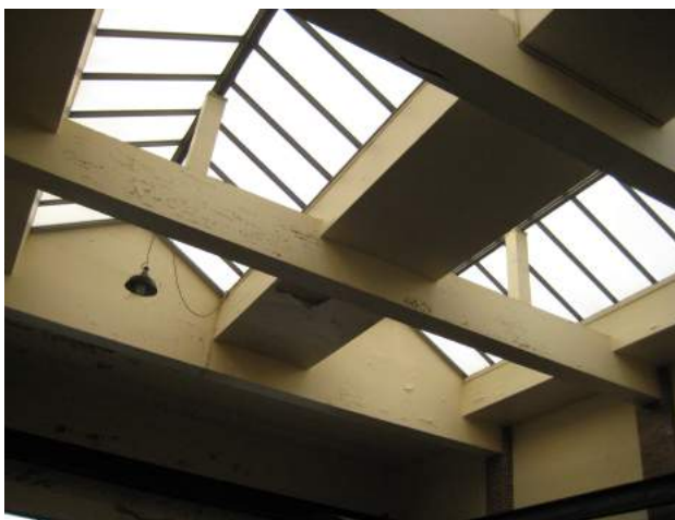
Afbeelding 54: Afladderende verf met scheurvorming in plafond- en constructiebekleding machinezaal. Beschadigd verf- en pleisterwerk met aan linkerkant afbeelding inzetwand mogelijk asbesthoudend. (Bron: Maarten Dobbelaere)
