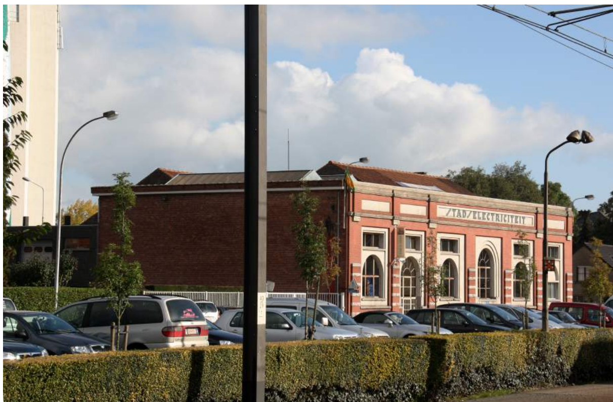
Afbeelding 3: Elektriciteitscentrale gezien vanaf de westzijde. (Bron: Maarten Dobbelaere 2010)
