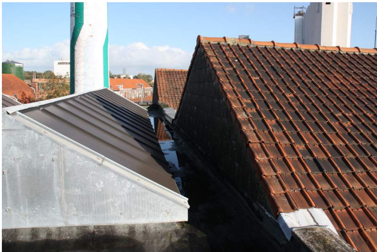
Afbeelding 36: Overgang plat dak met lichtstraten naar hellend dak 2010 (Bron: Maarten Dobbelaere)
