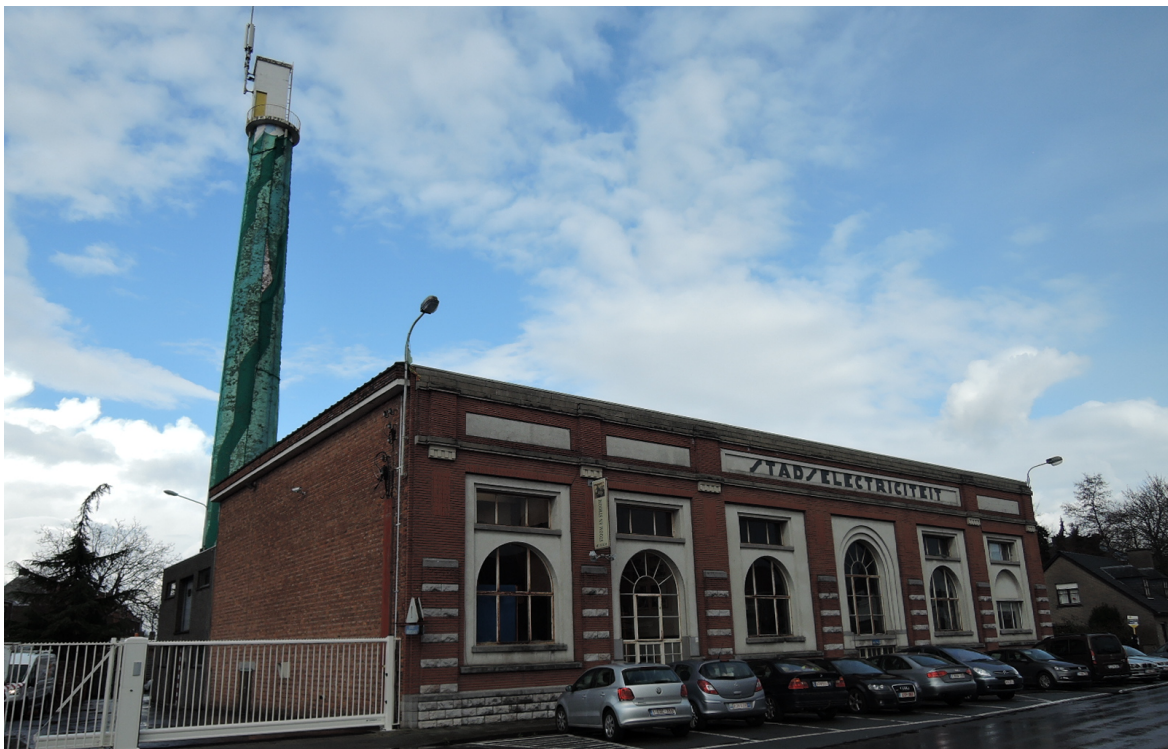
Afbeelding 2: Aanzicht voorgevel/ schoorsteen met afbladderende verf en draadnetten - 2016 (Bron: Monumentenwacht)
