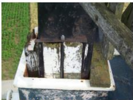
door houtrot aangetaste kopspieën en lieswiggen
