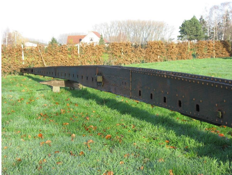
Bron/foto: Jan Bauwens, originele oude geklinknagelde roede Verhaeghe Decuyper ligt aan de Faurconniersmolen te Oordegem.
