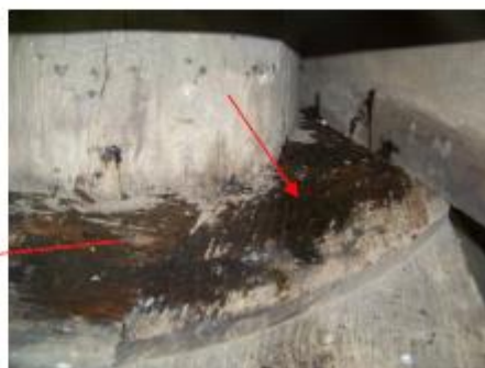
Inspectie 2016: de molenaar had net voor onze inspectie nog vlug het 'sleep' oppervlak van de zetel ingesmeerd!!!
