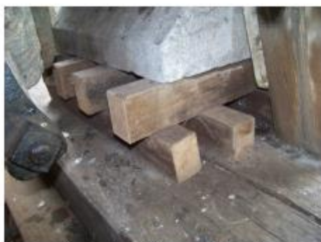
eigenaardige ondervulling van de banesteel
