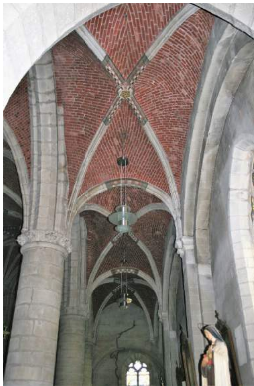
Figuur 82: Zicht op de vochtschade van de gewelven van de zuidelijke zijbeuk, 2018
