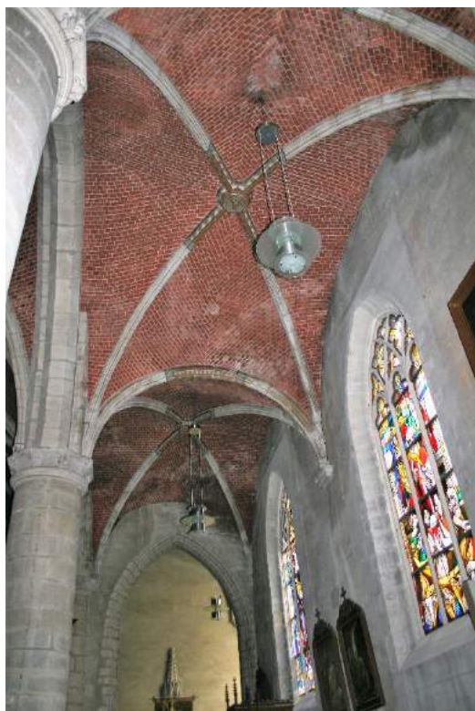
Figuur 82: Zicht op de vochtschade van de gewelven van de zuidelijke zijbeuk, 2018
