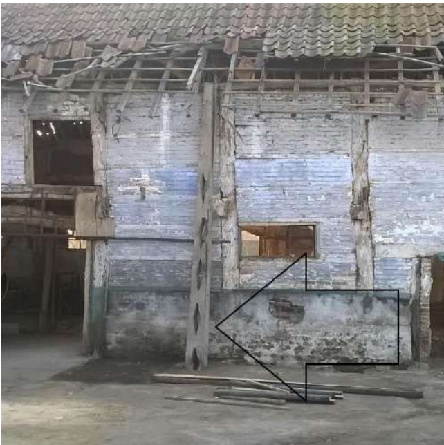
Afb. 81: Betonnen steunpilaar.
