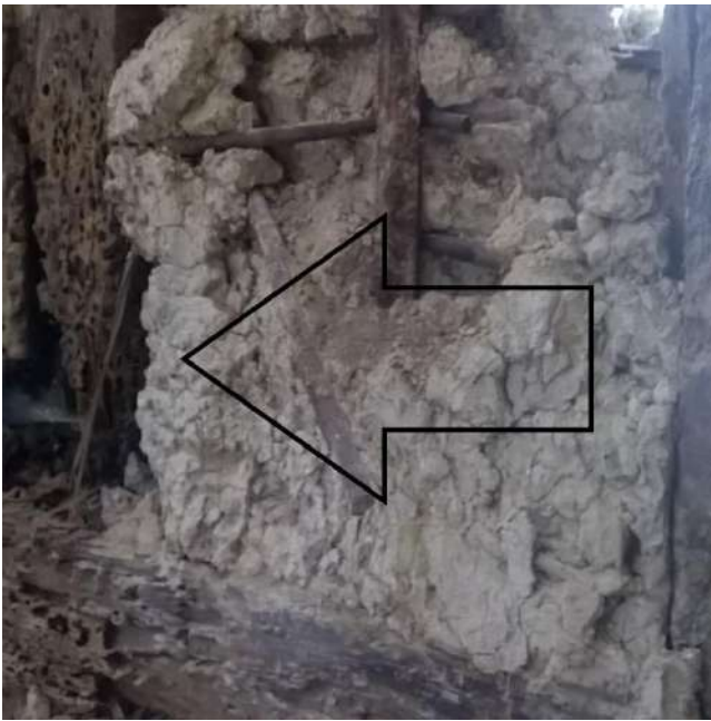
Afb. 57: Door insecten aangetast hout.
