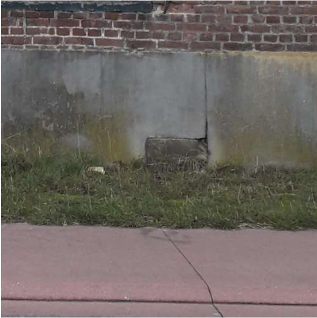
Afb. 31: Kelderraam gedempte kelder.
