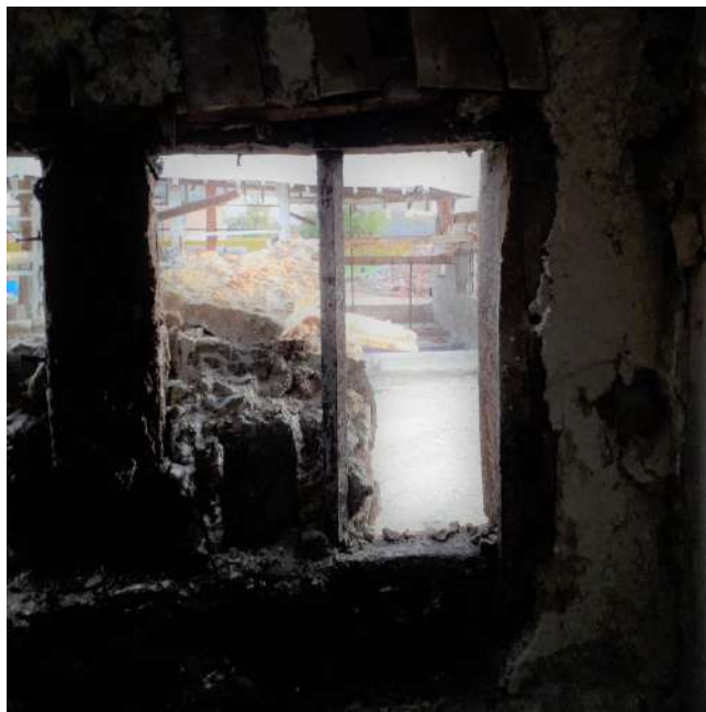
Afb. 46: Kleine getraliede vensteropening koergevel.
