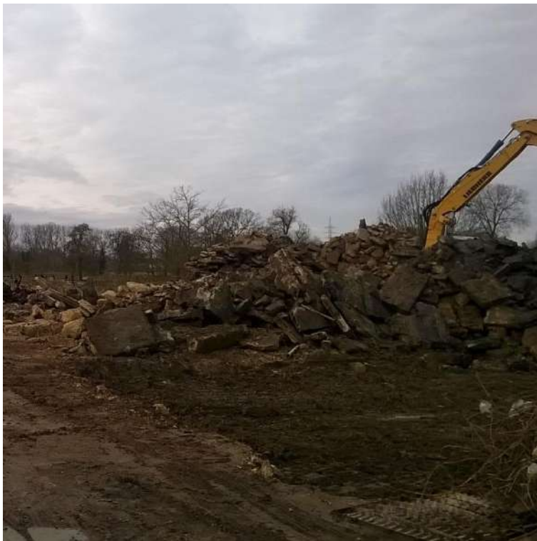
Afb. 22: Perceel achter hoeve, tijdens het verwijderen van de verhardingen.
