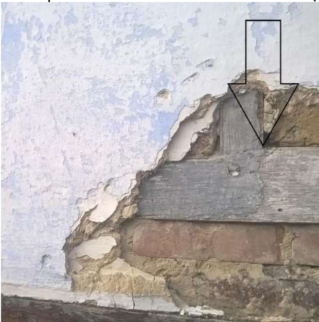
Afb. 43: Overleemd en geveerd vakwerk koergevel.
