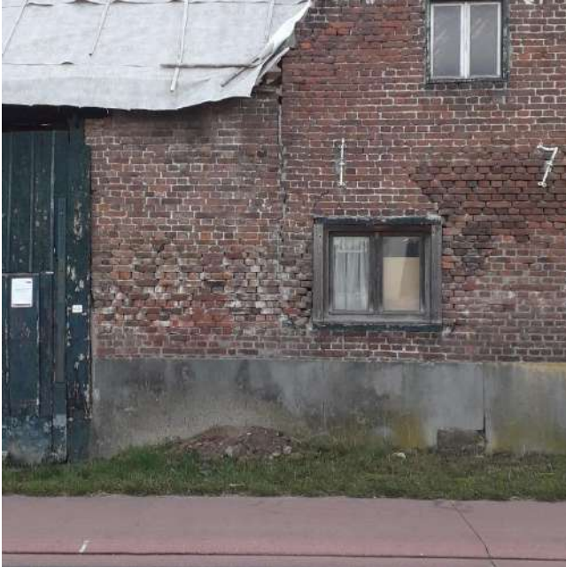
Afb.60: Bouwnaad poorthuis – woonhuis.
