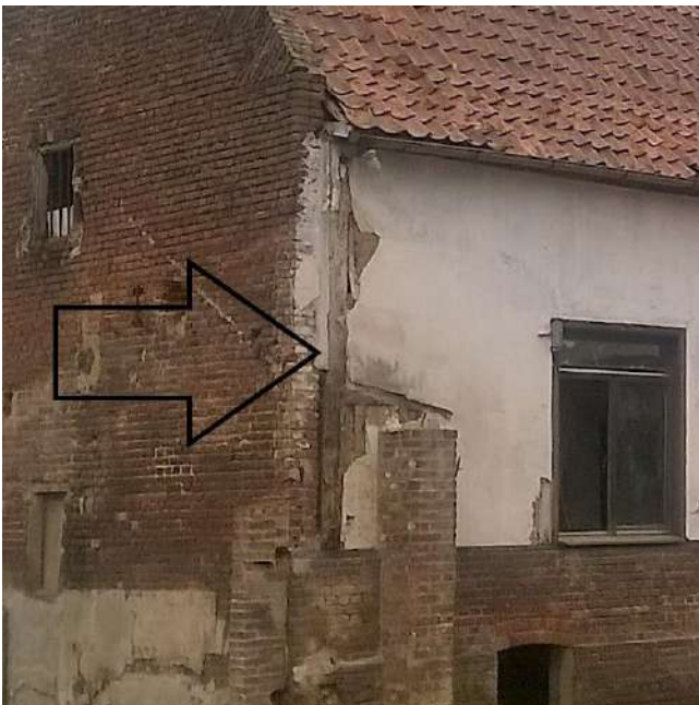
Afb. 38: Verticale stijl achter huidige bakstenen gevel.
