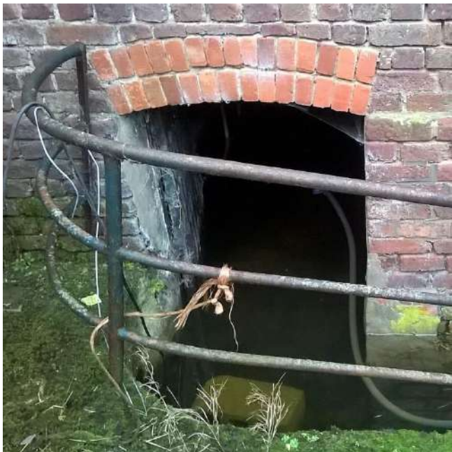
Afb. 47: Ingang kelder aan koergevel.
