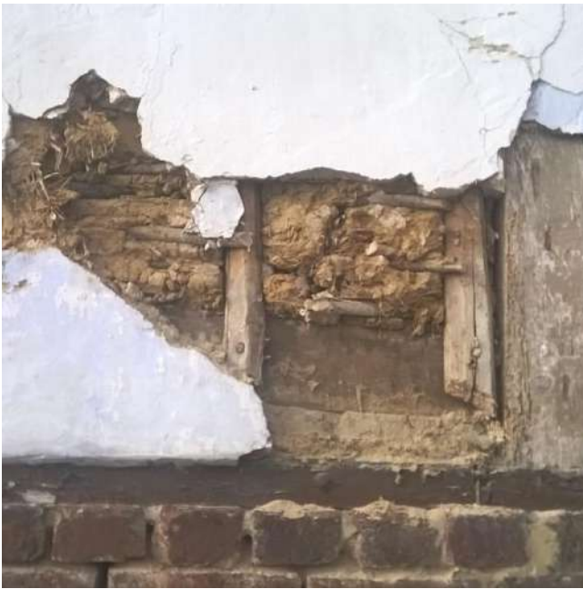
Afb. 41: Kempisch vitswerk, koergevel.
