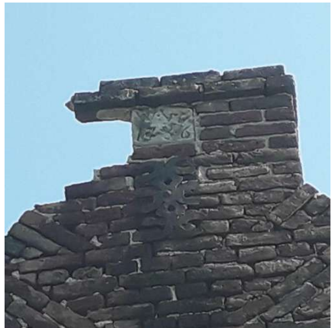
Afb. 39: Detail schouw achtergevel, anker en jaarsteen
