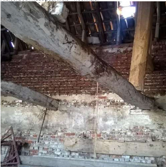
Afb.62: Moerbalken poorthuis, verbinding met straatgevel.
