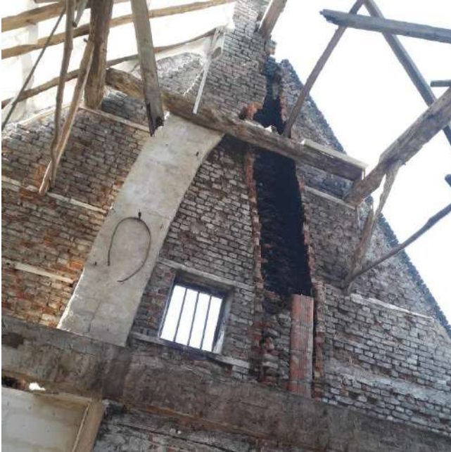
Afb. 36: Ingestorte schoorsteen, achtergevel.
