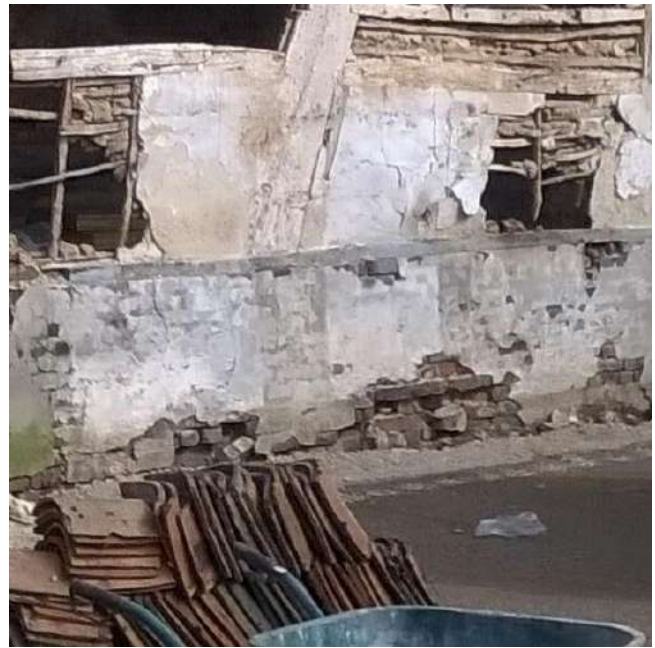
Afb. 68: Bakstenen plint koergevel poorthuis.
