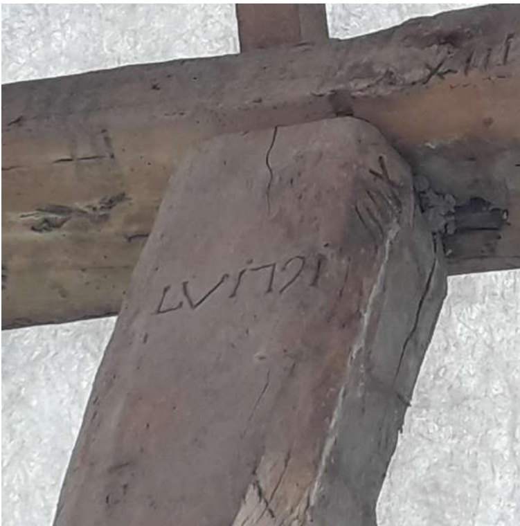
Afb. 10: Detail vakwerk schuur, as 5, opschrift "LV 1791".
