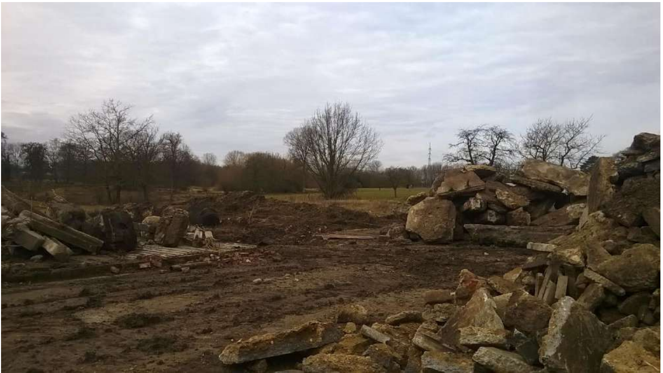
Afb. 27: Perceel achter hoeve, tijdens het verwijderen van de verhardingen.
