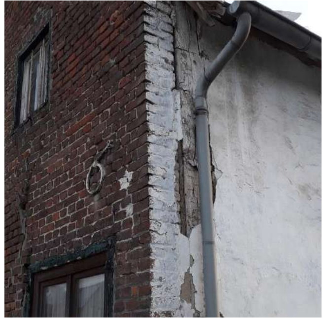
Afb. 32: Verticale stijl oorspronkelijke vakwerkgevel achter huidige bakstenen gevel.
