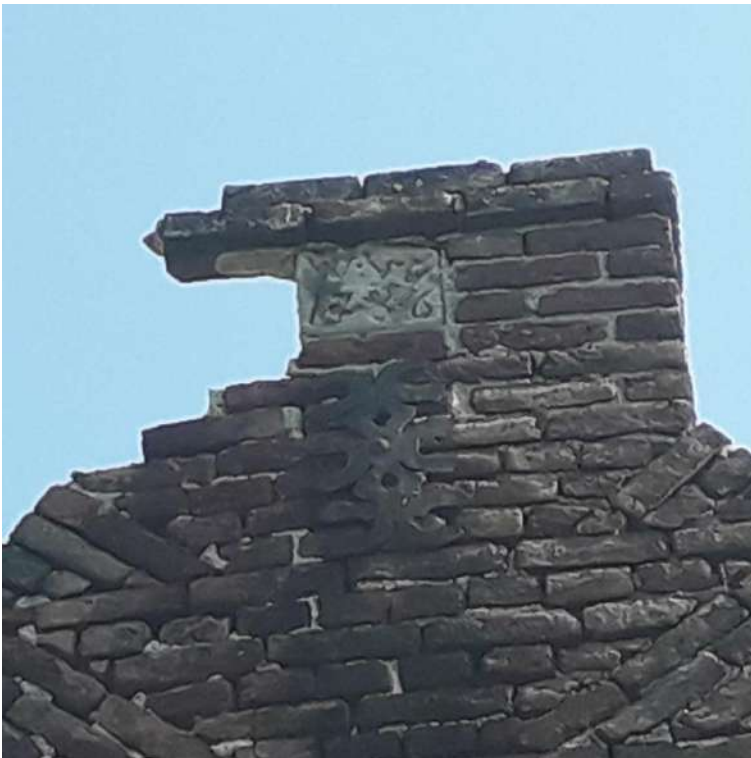
Afb. 9: Detail kopschouw woonhuis, erfzijde, zandsteen met jaartal "1786".
