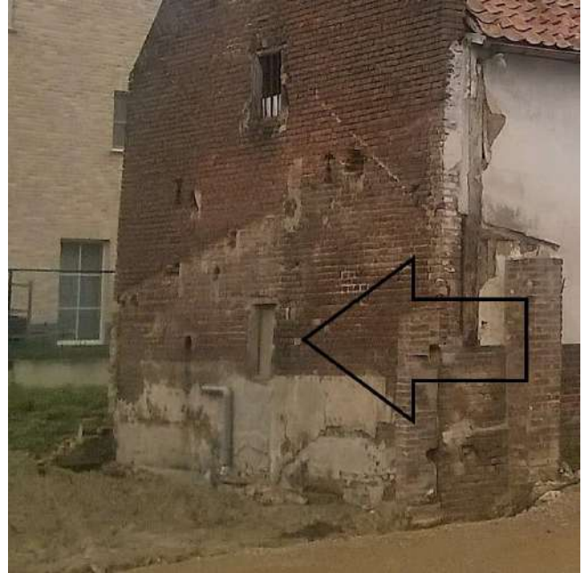
Afb. 37: Dichtgemaakte opening, achtergevel.
