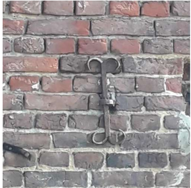
Afb. 34: Anker straatgevel.
