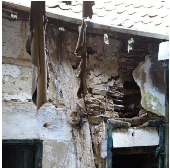
Afb. 70: Gevitste en geleemde vullingen poorthuis.
