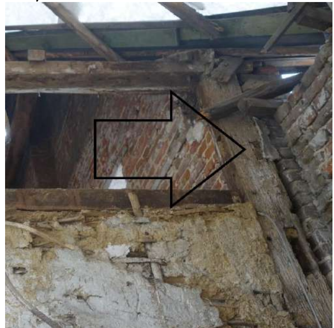
Afb. 44: Tweede pengat in hoekstijl oorspronkelijke vakwerken voorgevel.
