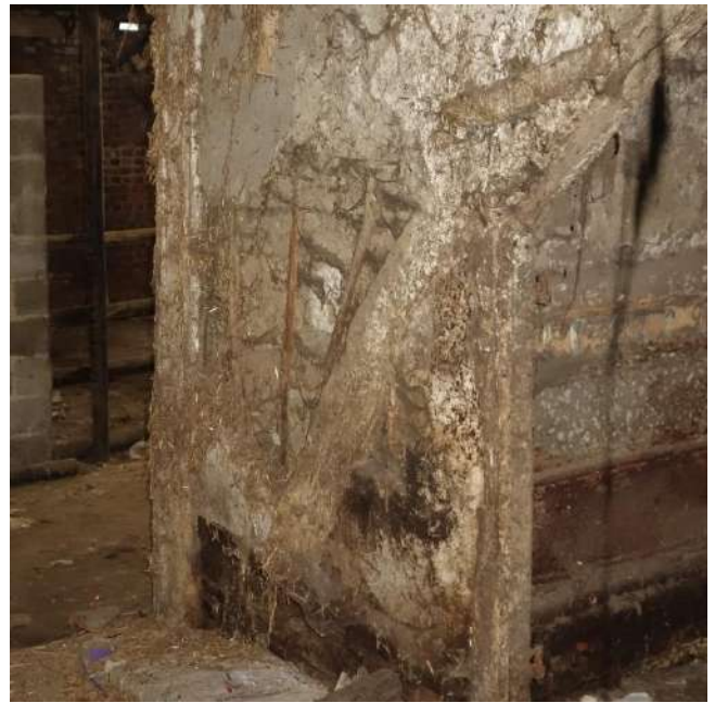
Afb. 80: Oorspronkelijke lemen vulling schuur.
