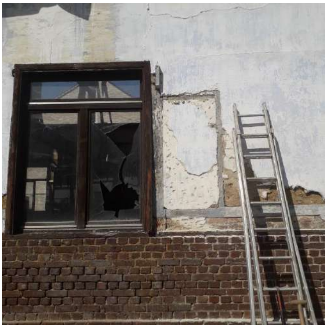
Afb. 45: Restanten dubbel bolkozijn met bovenlicht Koergevel.
