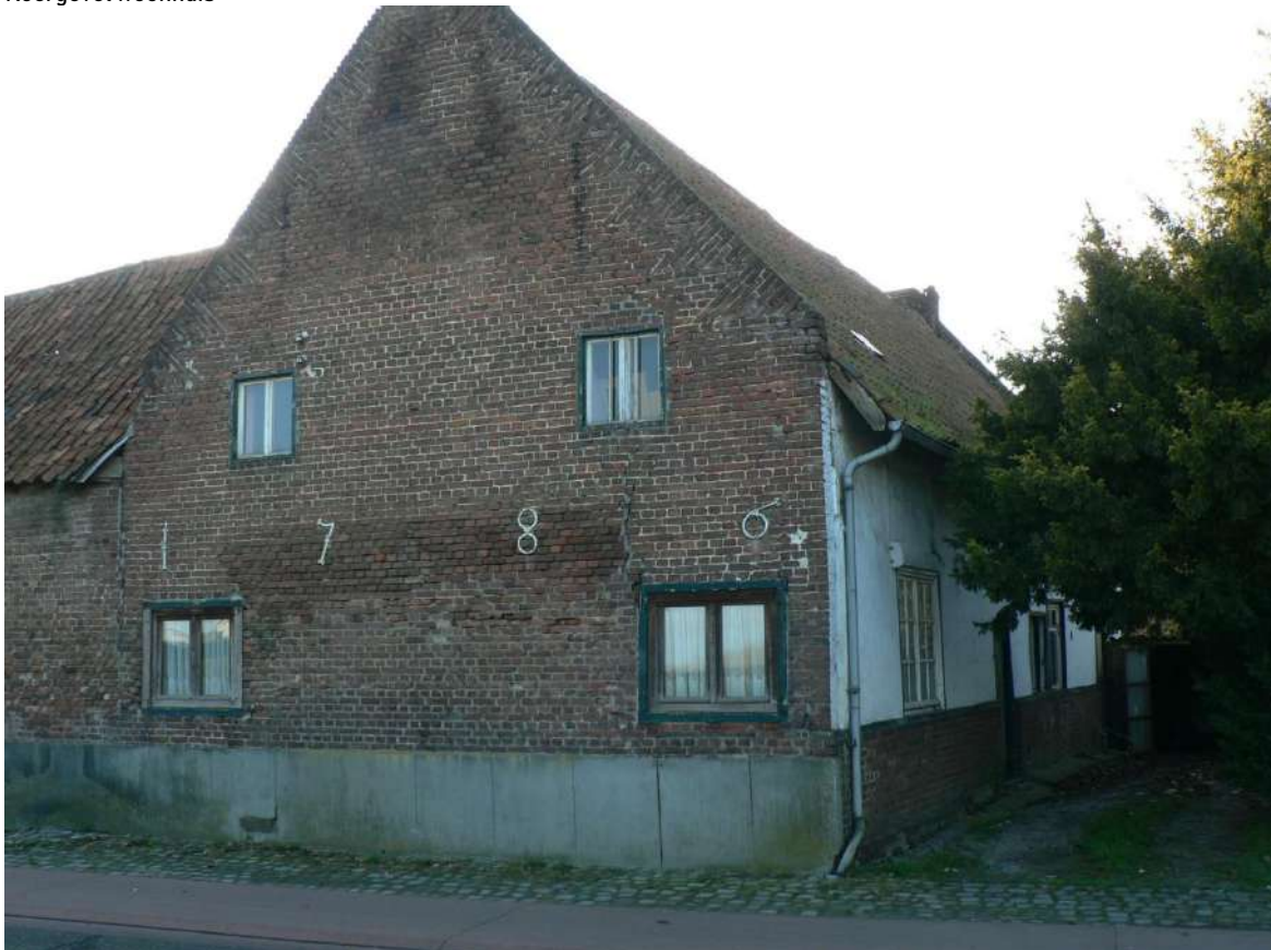
Straat- en veldgevel woonhuis
