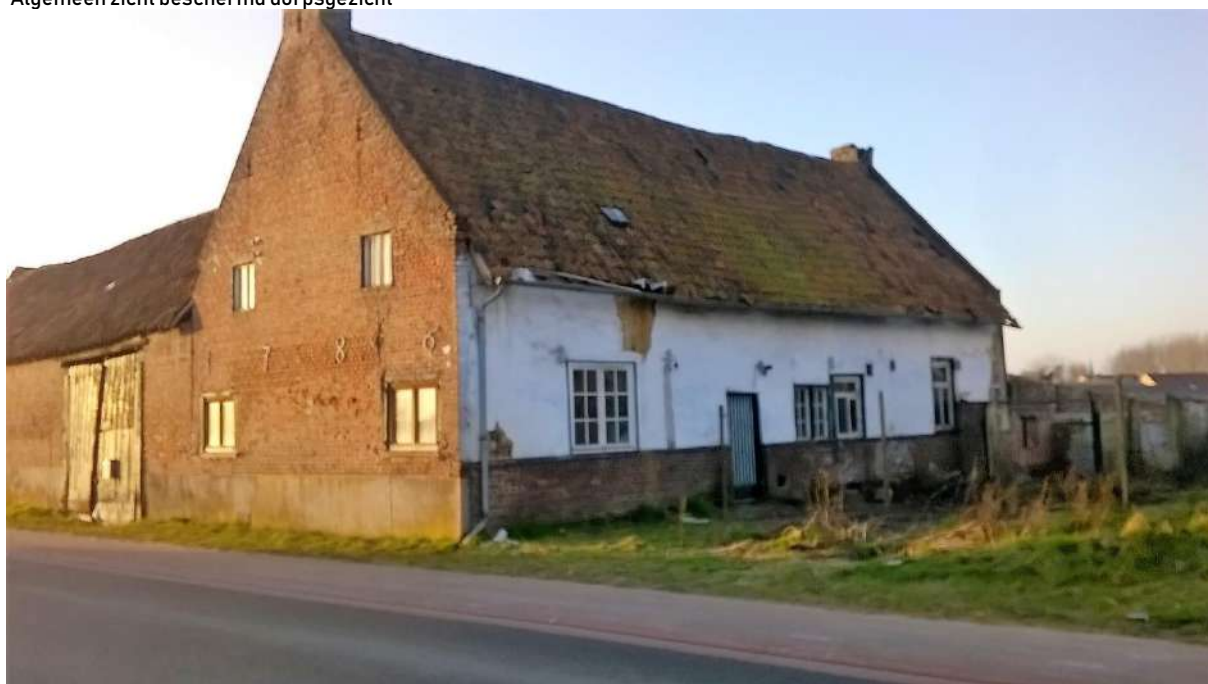
Straat- en veldgevel woonhuis
