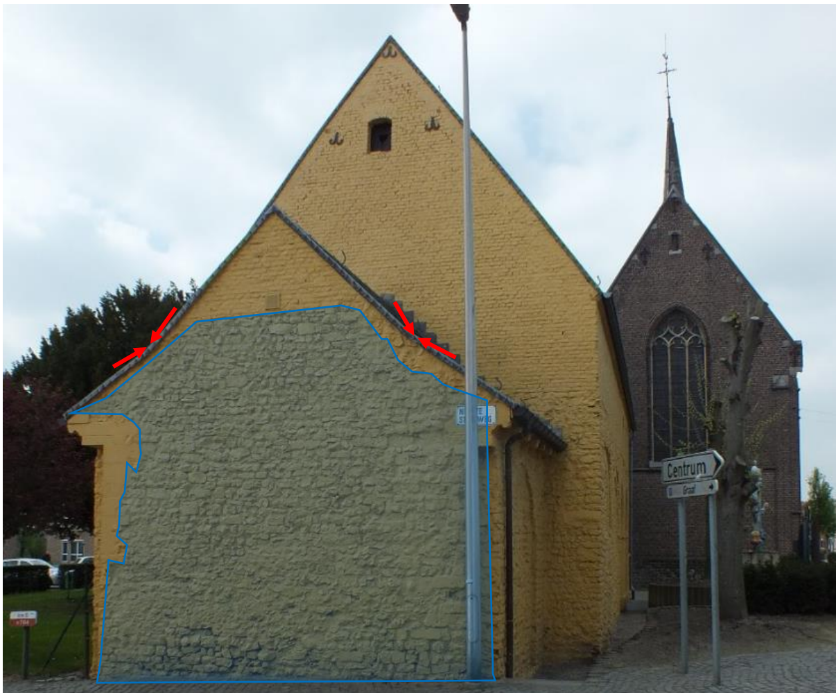
Figuur 20: Noordelijke gevel van het koor – deels ingevuld met silexblokken (blauw). Het dak heeft een duidelijke ‘knik’ (rode pijlen). Bron: MASSART
