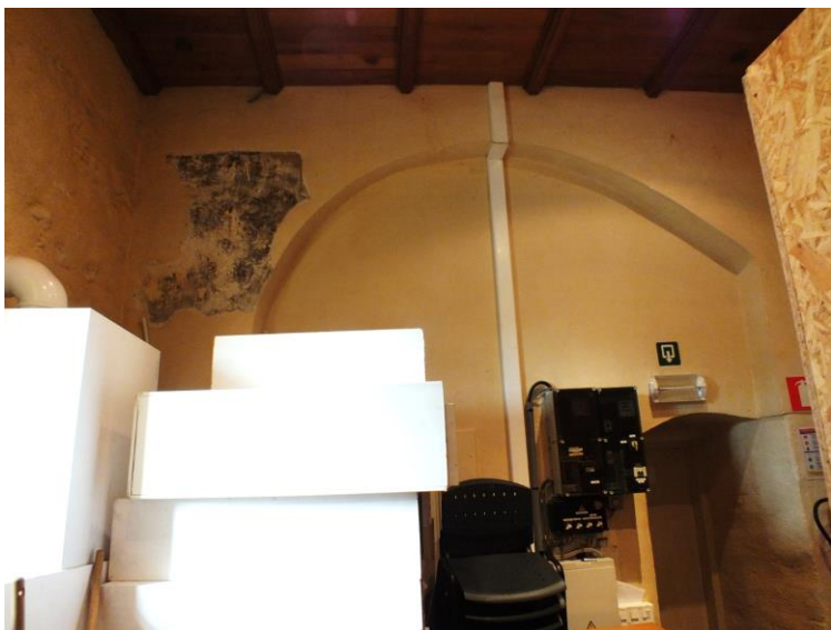
Figuur 34: Zicht op de westelijke binnenmuur van het koor - rondbogige koorboog
