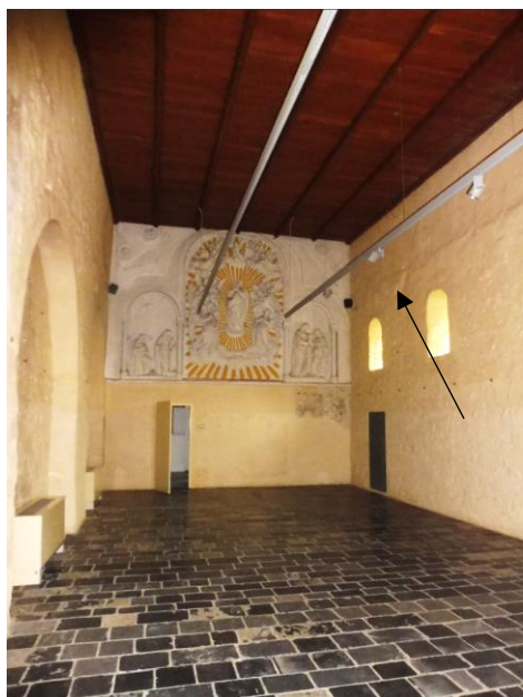
Figuur 26: Zicht op de oostelijke binnenmuur met gotische verlenging
