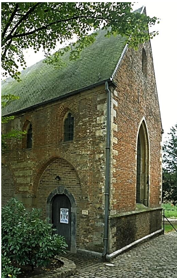
Figuur 21: Bouwspoor van de plaats waar zich het westelijke toegangspoortje bevond. Vóór 1993. Bron: https://inventaris.onroerenderfgoed.be/aanduidingsobjecten/3325
