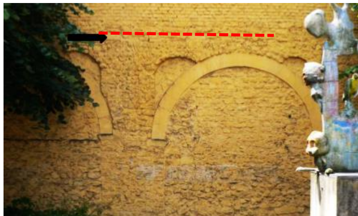
Figuur 16: Detail van de twee dichtgewerkte rondbogige traveebogen met een ingewerkte boog in witte steen en de daklijn. Bron: MASSART
