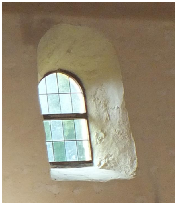
Figuur 33: Detail venster zuidelijke gevel – romaans gedeelte
