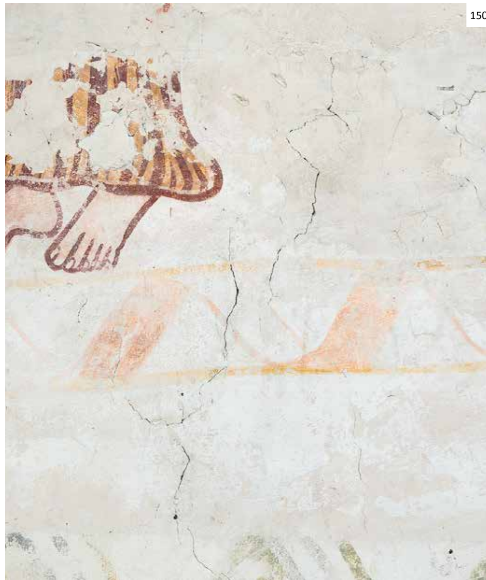
148. Afbladderende verf gewelf [GROOTAERS J.: 2014]
