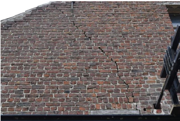
Figuur 3.10.a en 3.10.b: Zware scheur langs linkerzijde gevel (foto links) en raam rechts van het rad met aangepaste witstenen dorpel (foto rechts)
