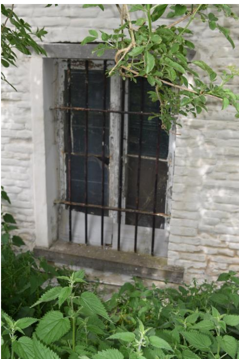
Figuur 3.12: Houten raam van de slaapkamer met ontlastingsboog, arduinen dorpel en linteel
