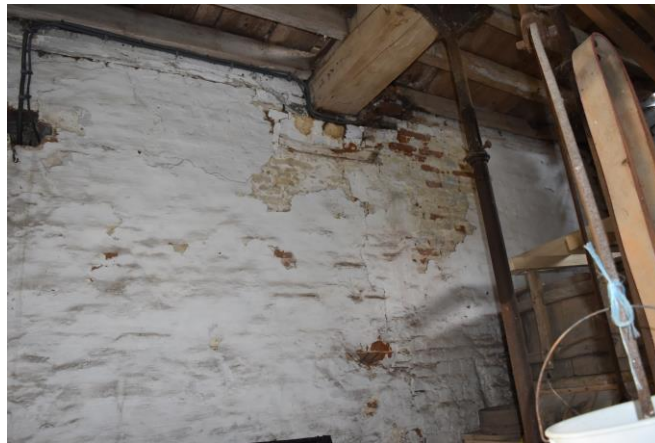
Figuur 3.31.a en 3.31.b: De oostgevel met de afscheuring van het metselwerk boven de inkomdeur (foto links) en het naar binnen gekantelde metselwerk onder de opleg van de moerbalk (foto rechts)
