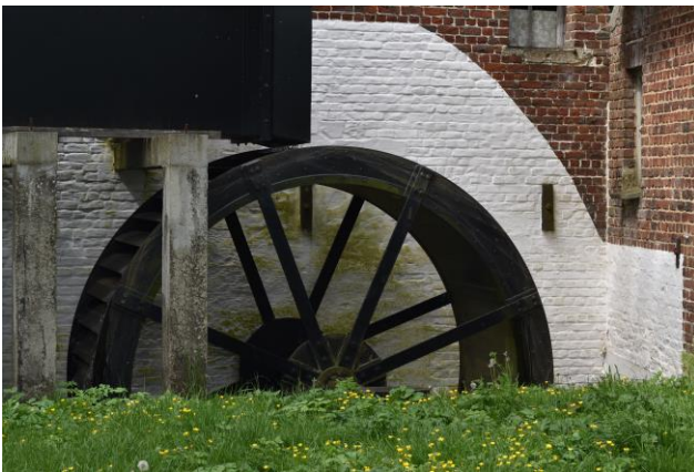
Figuur 3.17.a en 3.17.b: Het ijzeren bovenslagrad met bouten en klinknagels, heeft een diameter van ongeveer 3,50 m. De wateras is in ijzer met gietijzeren lagerblokken.
