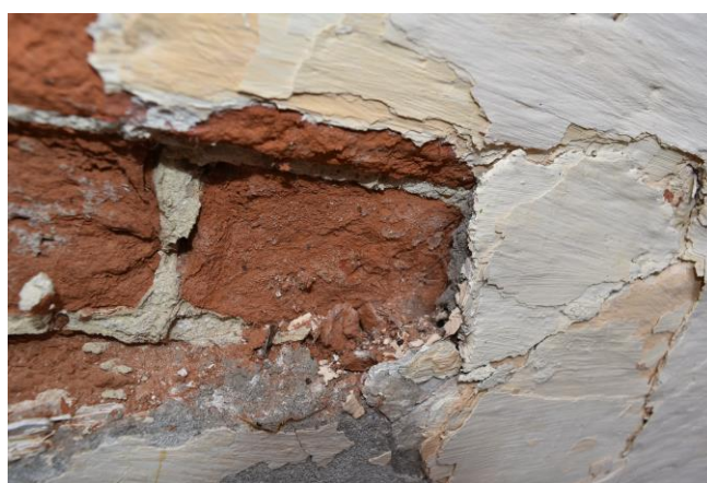
Figuur 3.79.a en 3.79.b: ettelijke lagen kalkverf, met sterk variërende concentraties van oker, maskeert de vorstschade van het onderliggend metselwerk.
