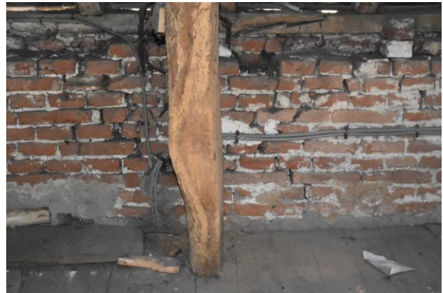
Figuur 3.35a en 3.35.b: De topgevel tussen beide graanzolders zit niet in verband gemetst met de opkant (foto links) - Het gescheurde metselwerk van de opkant (foto rechts)
