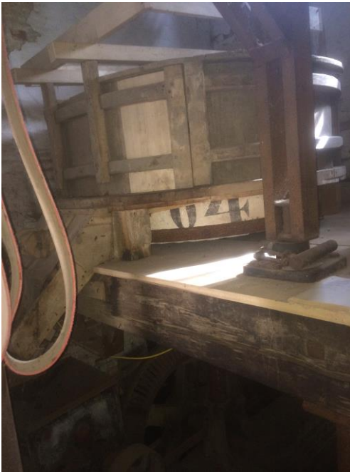
Figuur 3.45. linker steenkoppel. Van dit natuurstenen (kwartsiet) steenkoppel is nog slechts de helft (de ligger) aanwezig.
