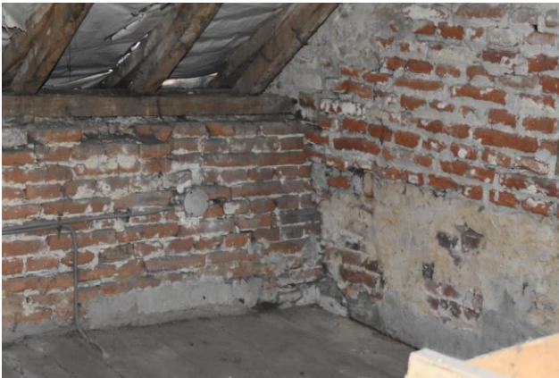
Figuur 3.35a en 3.35.b: De topgevel tussen beide graanzolders zit niet in verband gemetst met de opkant (foto links) - Het gescheurde metselwerk van de opkant (foto rechts)
