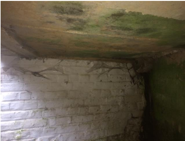
Figuur 3.19.a en b: afvoerkanaal vanaf het rad naar de beek.
