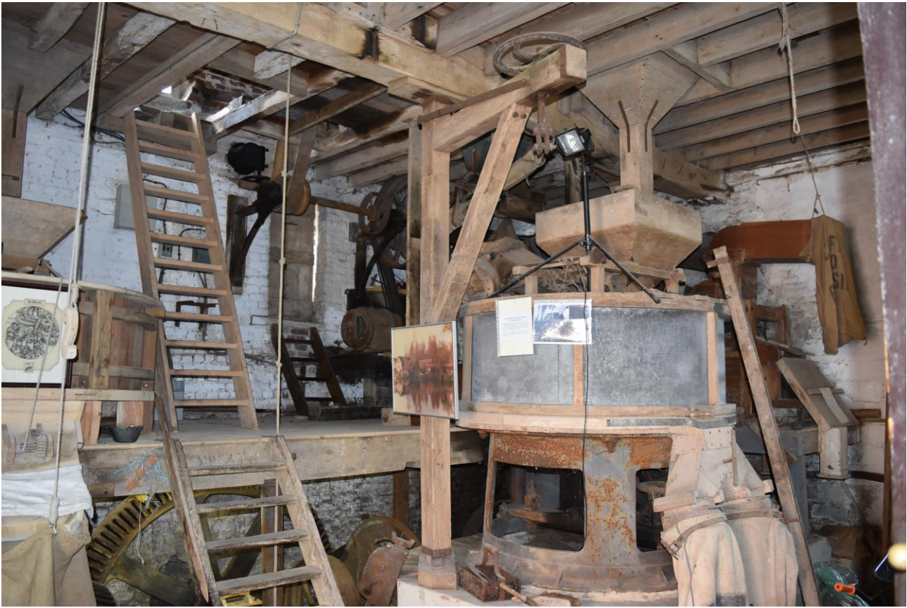
Figuur 3.49: de rechterzijde van de steenzolder
