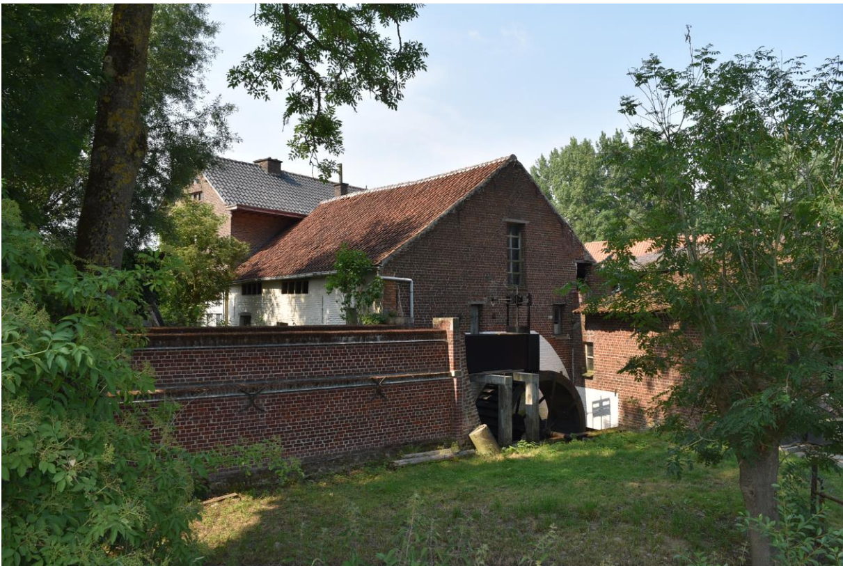
Figuur 3.7: De watergevel en maalsluis vanaf de beek
