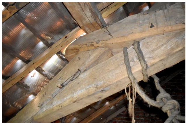
Figuur 3.36.a en 3.36.b: Het spant boven het woondeel met telmerk II
