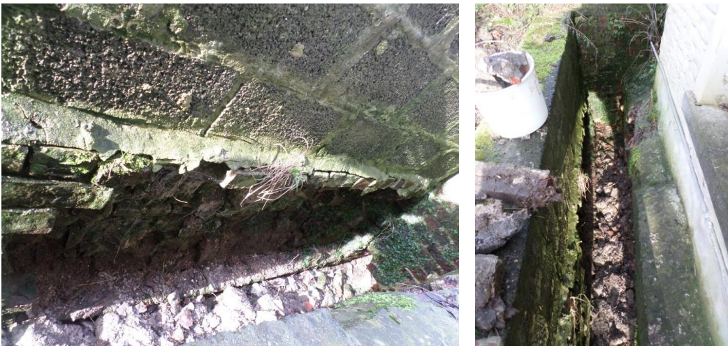
Figuur 3.80.a en 3.80.b: de keermuur met inkalvend metselwerk
