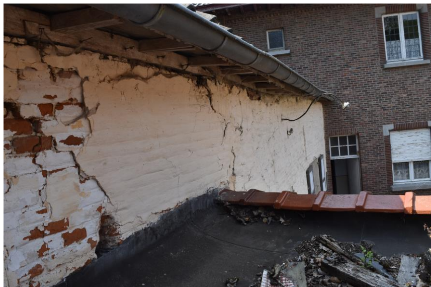
Figuur 3.6.a en 3.6.b: De zware verticale scheur (foto links) en de slechte staat van de bovendakse gevel (foto rechts)
