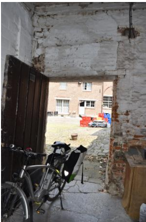
Figuur 3.31.a en 3.31.b: De oostgevel met de afscheuring van het metselwerk boven de inkomdeur (foto links) en het naar binnen gekantelde metselwerk onder de opleg van de moerbalk (foto rechts)
