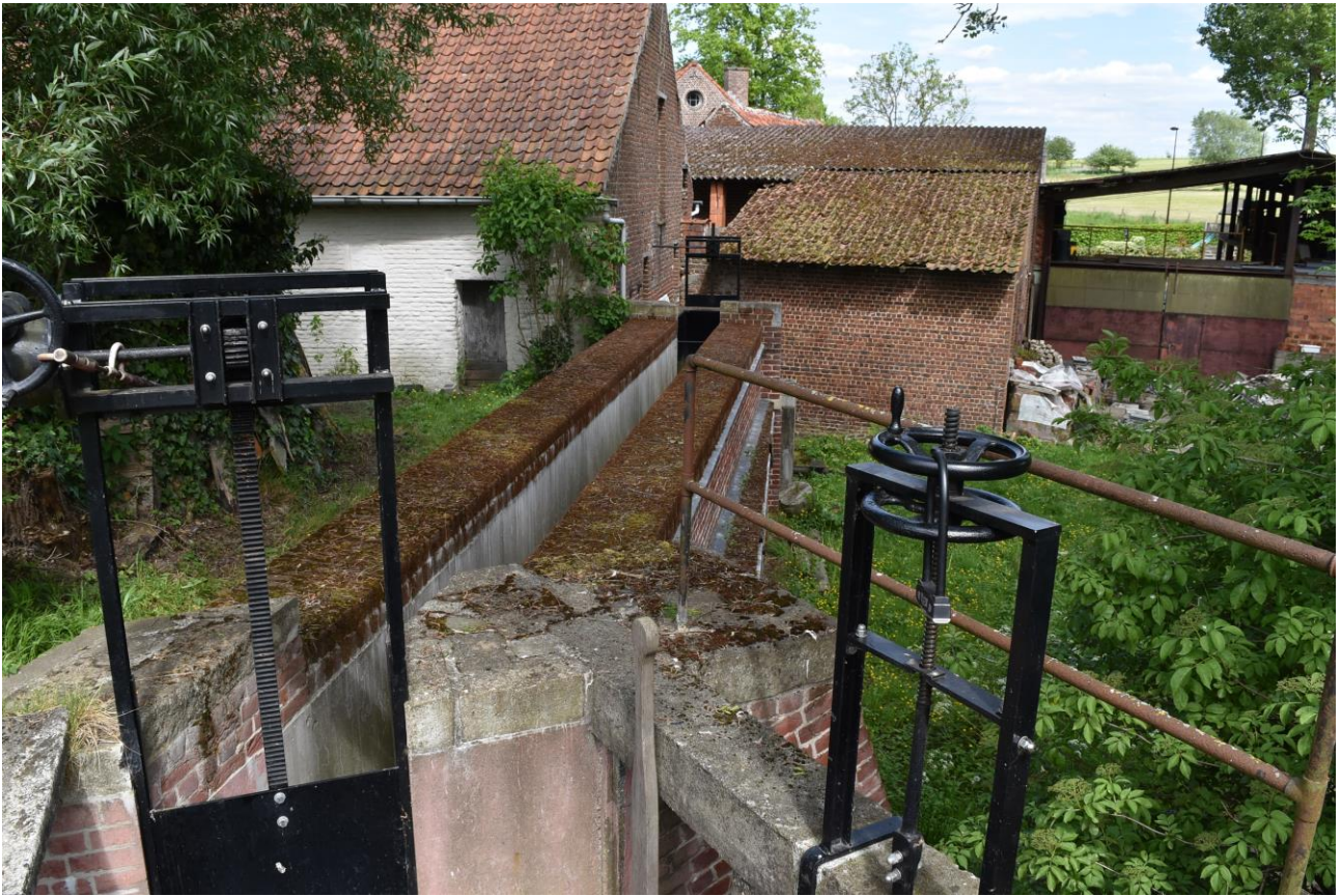
Figuur 3.16: Maalgoot en sluiswerk
