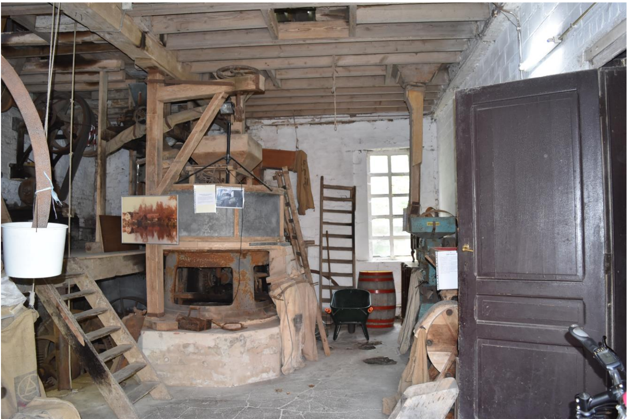
Figuur 3.27: De benedenverdieping van de molen, met het open gelijkvloers, de asput en de steenzolder. Rechts op de foto de deur naar het inkomzas van de bijhorende molenwoning.
