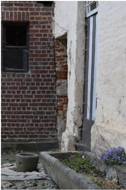
Figuur 3.5: De inkomdeur naar de molen vormt een knikpunt in de verticale scheefstand van de molen
