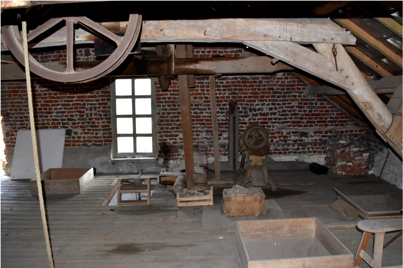
Figuur 3.56: houten trechters in de zoldervloer. Deze staan via een houten buis in verbinding met een kaar of graanbak, die boven het steenkoppel, de graanpletter of graantrieur gemonteerd staan (zie ook beschrijving en foto's bij de benedenverdieping).
