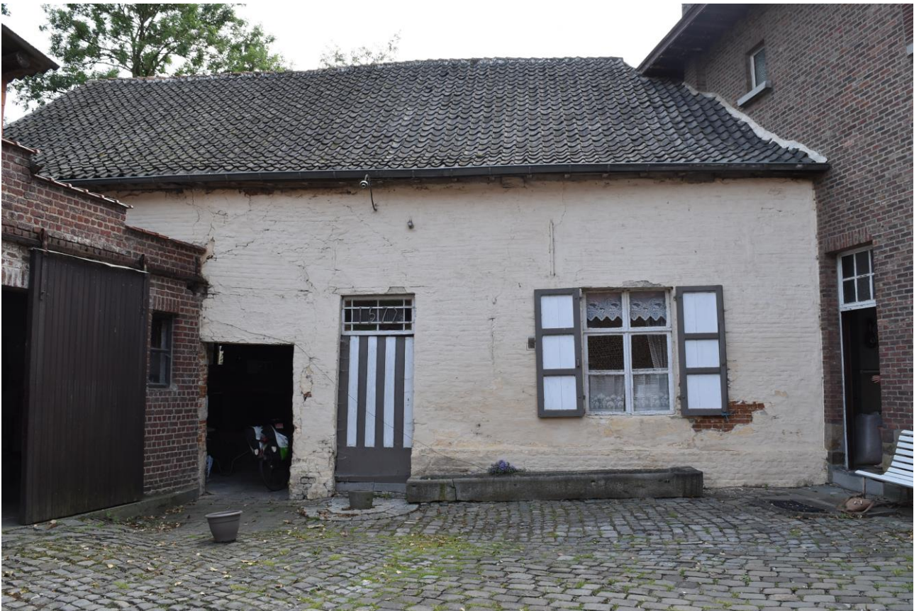
Figuur 3.2: Gevel koerzijde
