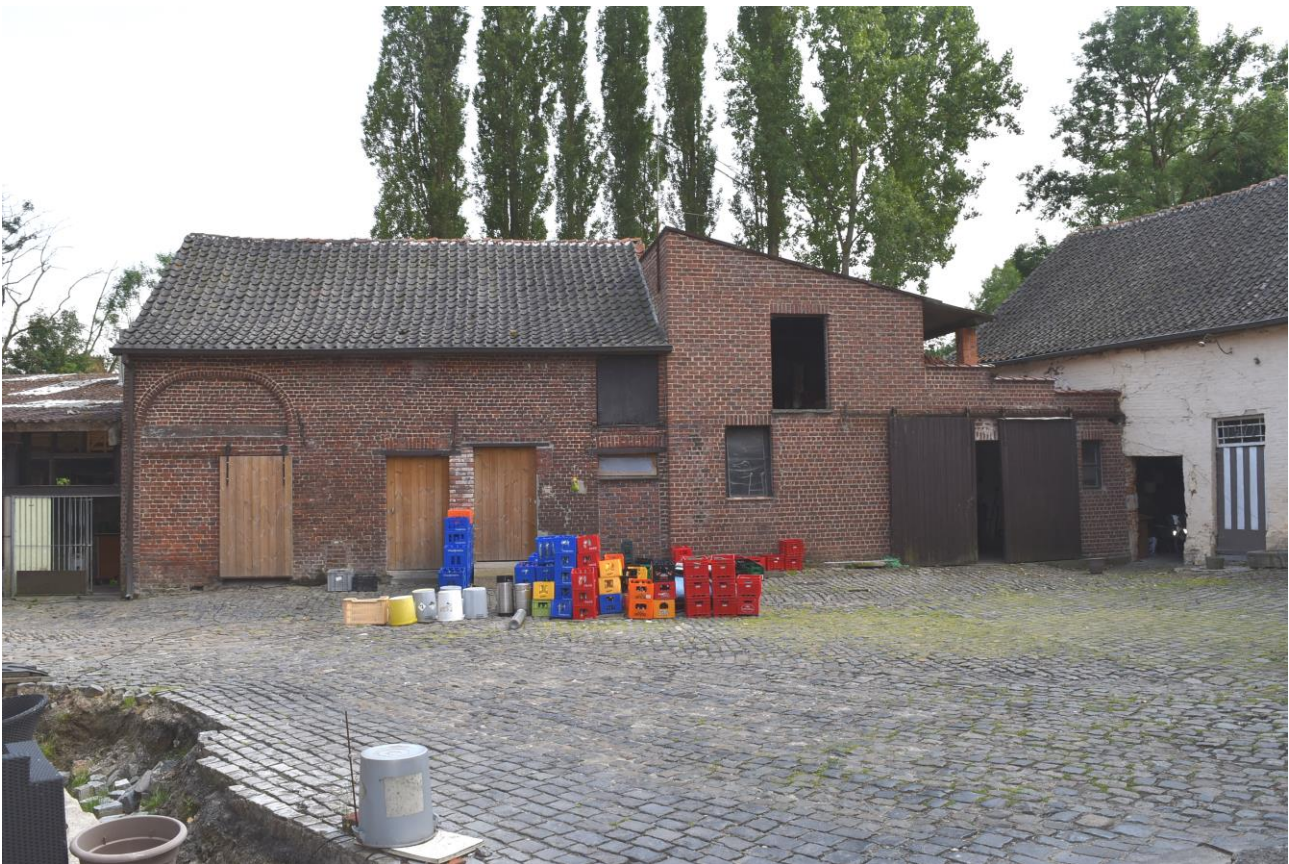
Figuur 3.91: melkvee- en varkensstal met links het deel uit 1860 en rechts het deel uit 1962
