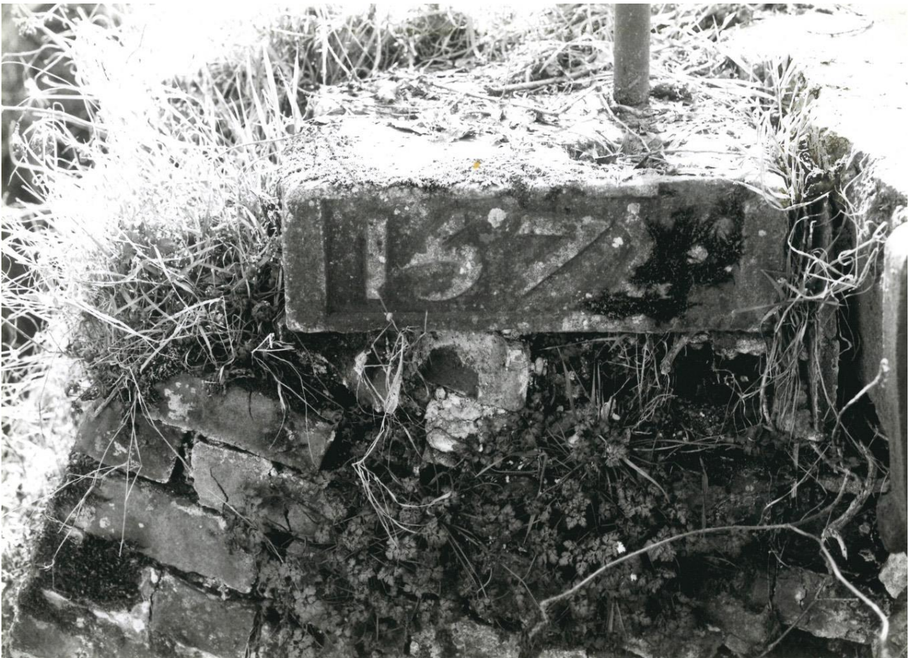
Figuur 2.1: Datumsteen ter hoogte van het sluiswerk, situatie voor de herstelwerken van 2012 (J.Verpaalen)
