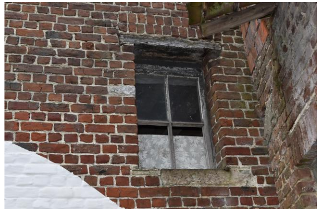
Figuur 3.10.a en 3.10.b: Zware scheur langs linkerzijde gevel (foto links) en raam rechts van het rad met aangepaste witstenen dorpel (foto rechts)
