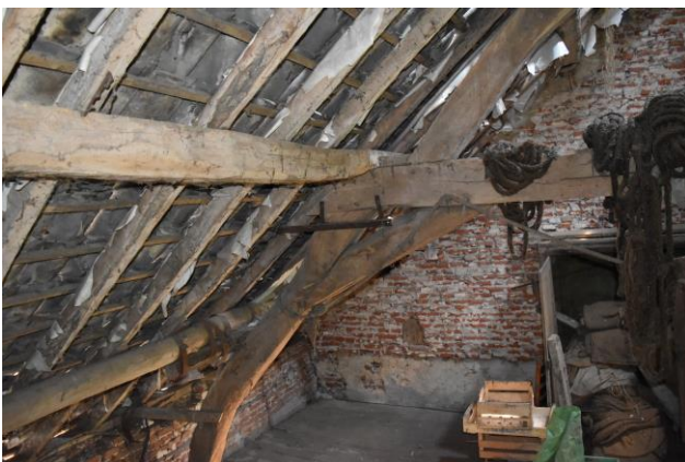
Figuur 3.36.a en 3.36.b: Het spant boven het woondeel met telmerk II
