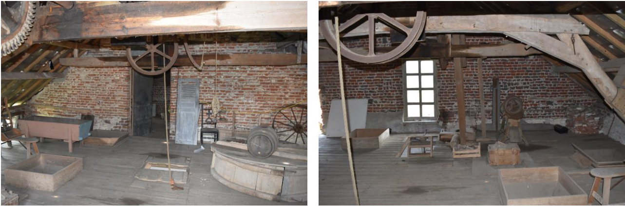
Figuur 3.32.a en 3.32.b: de graanzolder boven de molen, op de foto links kijkende naar de topgevel tussen beide zolders en op de foto rechts kijkende naar de watergevel.
