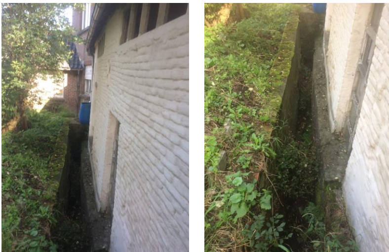
Figuur 3.13.a+b: keermuur langs linkerzijde van de westgevel
