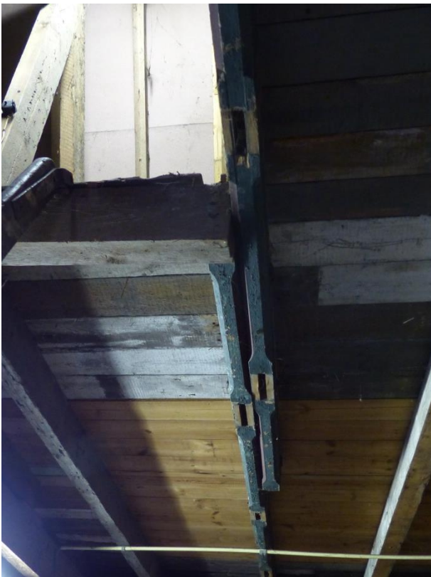
Figuur 77 Roostering hersteld met fragmenten deur (17.10.2018)
