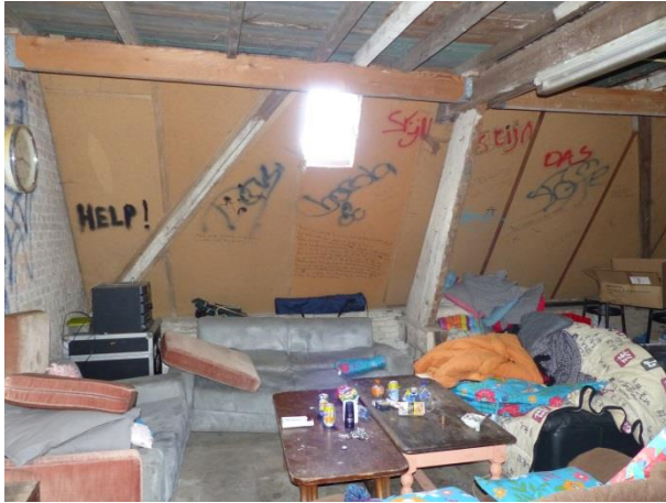
Figuur 35 A-spant met vernieuwde gordingen (17.10.2018)
