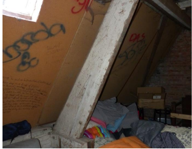
Figuur 73 Houtvezelplaat op hellende dakvlakken (17.10.2018)
