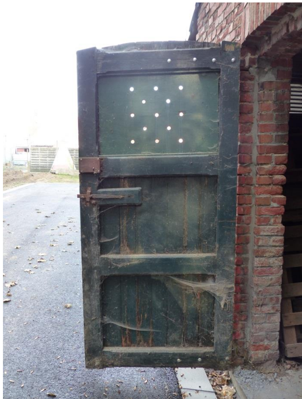
Figuur 52 Deur annex (18.10.2018)
