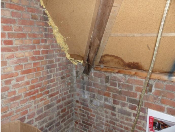
Figuur 41 Aftekeningen van voormalig lek t.h.v. zalinggoot (17.10.108)
