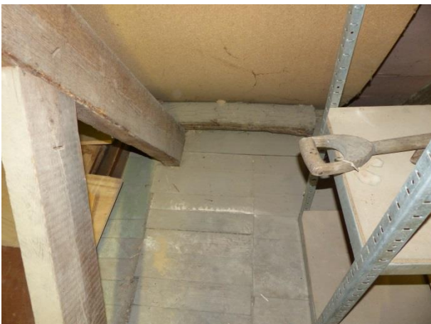
Figuur 79 Oorspronkelijke beplanking in rood dennenhout. Boormeel uit spant op beplanking (17.10.2018)
