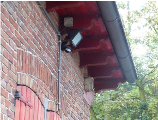
Figuur 33 Dakoverstek met geprofileerde hondjes en hanggoot in koper (17.10.2018)
