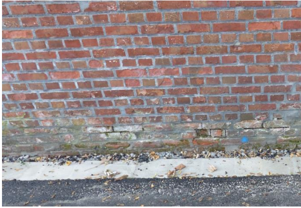
Figuur 27 Opstijgend vocht met zoutuitbloeiingen (17.10.2018)
