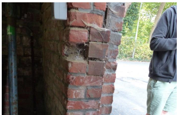
Figuur 26 Annex: Herstelling met ander type baksteen (17.10.2018)
