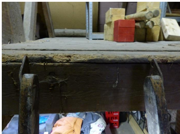
Figuur 80 Houtborende insecten in beplanking (17.10.2018)
