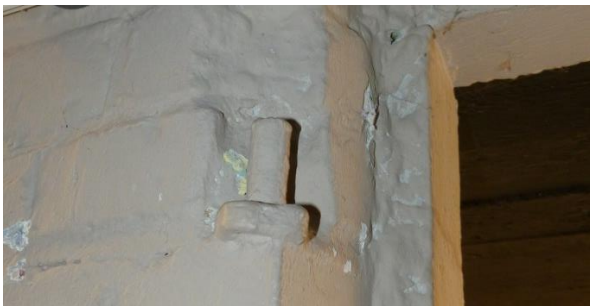
Figuur 82 Ingeklemd duimhengsel naar tweede deel annex (17.10.2018)
