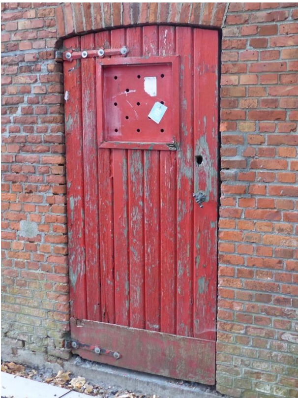
Figuur 51 Deur annex (18.10.2018)
