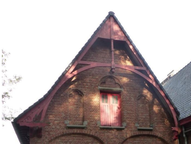
Figuur 34 Windveer met ingeschreven (louter esthetisch?) gespan (17.10.2018)
