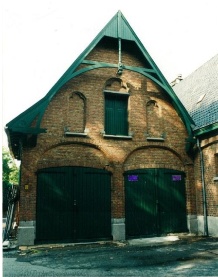
Figuur 14 Foto van het koetshuis in 1996. Het houten buitenschrijnwerk van zowel het koetshuis als de uitbreiding uit de jaren 1950 heeft een donkergroene kleur. (Bron: https://beeldbank.kortrijk.be/ )
