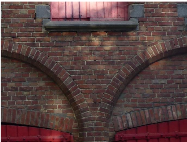
Figuur 22 Detail voegen voorgevel (17.10.2018)
