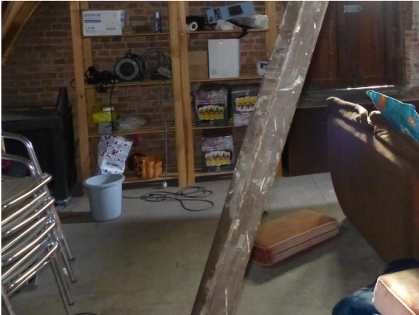
Figuur 75 Houtvezelplaten op houten roostering (17.10.2018)
