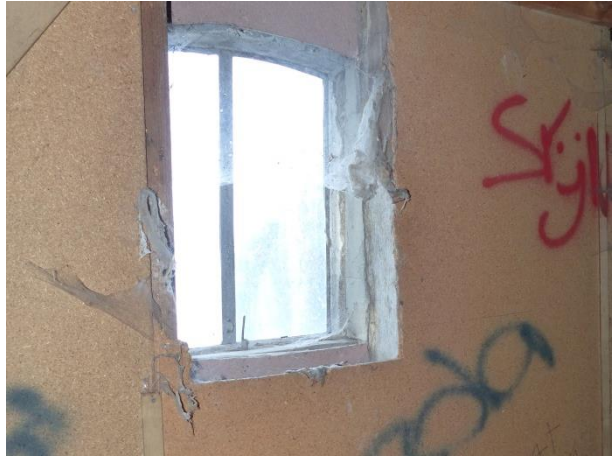
Figuur 42 Metalen dakvlakvenster (17.10.2018)
