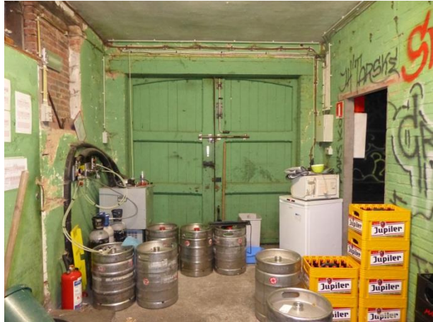
Figuur 67 Zicht op rechterpoort in voorgevel. Deel metselwerk voormalige rechterzijgevel gesloopt. Nieuwe metselwerkwand deelt ruimte op in twee delen. (17.10.2018)
