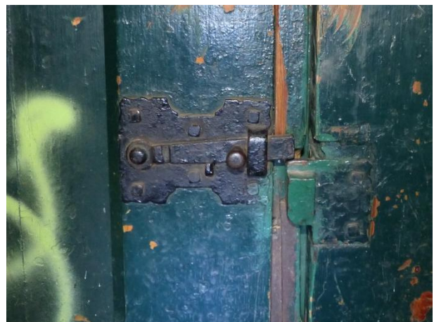
Figuur 48 Oorspronkelijk sluitwerk: klink (binnenzijde) (17.10.2018)
