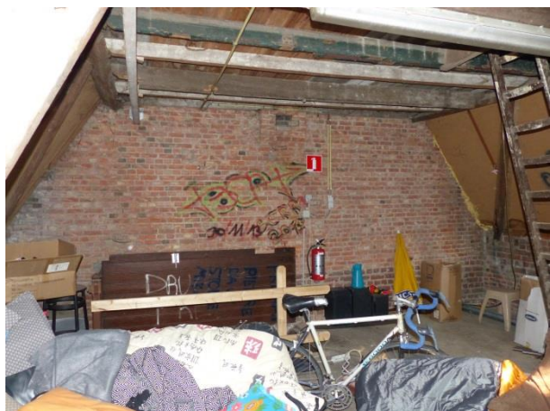
Figuur 71 Zichtbaar metselwerk op zolder, achtergevel (17.10.2018)
