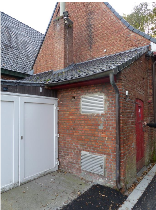
Figuur 24 Annex: Delen metselwerk hersteld. Schouw uit latere periode. (17.10.2018)
