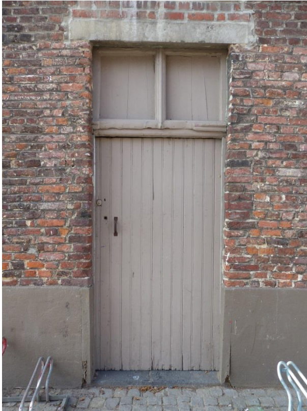
Figuur 76 Toegangsdeur schuur (17.10.2018)
