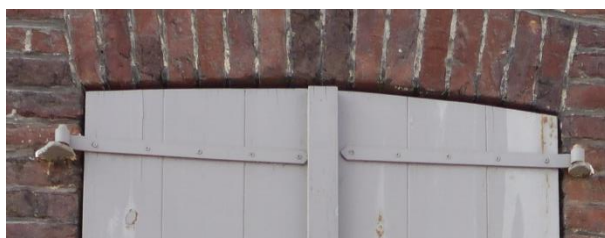
Figuur 63 Smeedijzers en industrieel vervaardigde hengsels (17.10.2018)
