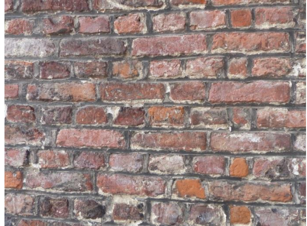
Figuur 16 Gedagstreepte kalkvoegen, vervuild en verweerd. (17.10.2018)
