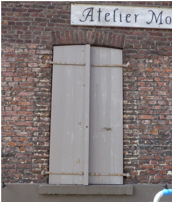
Figuur 61 Buitenluiken in gesloten toestand. Gecorrodeerde smeedijzers hengsels (17.10.2018)
