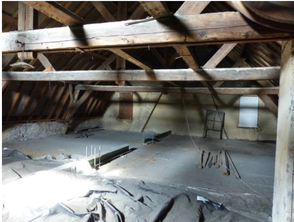
Figuur 103 Stalen liggers dragen moerbalken zolderroosting (17.10.2018)
