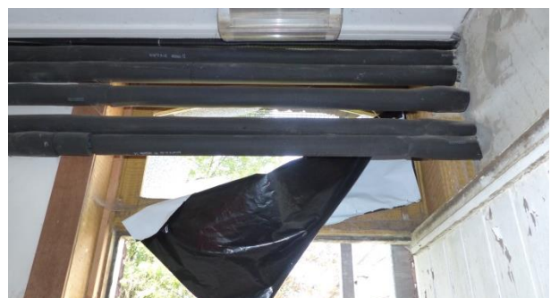
Figuur 98 Structuurglas in bovenlicht gebroken (17.10.2018)
