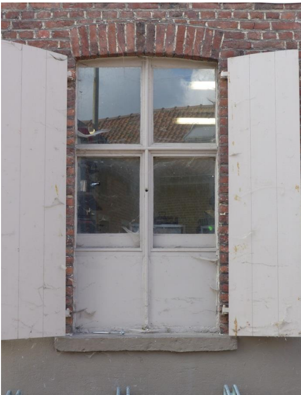
Figuur 23 Dorpels in blauwe hardsteen, geschilderd in de kleur van de plint. Buitschrijnwerk achter slag gevat in segmentboogvormige openingen. (17.10.2018)
