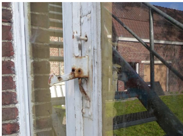
Figuur 92 Sluitwerk buitenluiken (17.10.2018)
