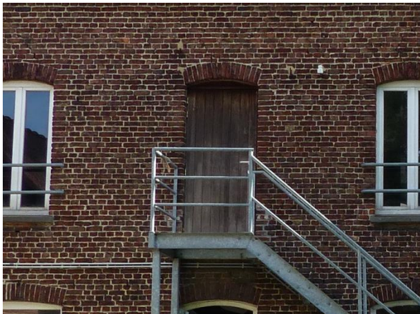
Figuur 99 Deur verdieping (17.10.2018)
