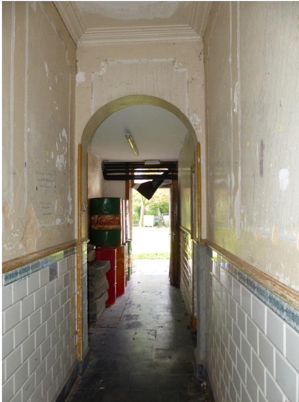
Figuur 111 (links) Lambrisering met wit-geglazuurde metrotegels en fries (17.10.2018)
