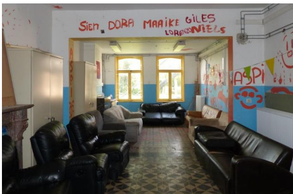
Figuur 132 Lokaal 3: cementtegels (17.10.2018)
