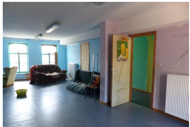
Figuur 148 Nieuwe deuren op verdieping (17.10.2018)
