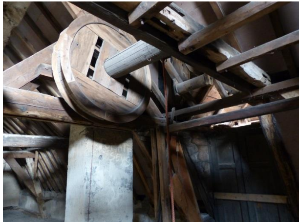
Figuur 54 Spant lokaal verstevigd voor katrolsysteem (17.10.2018)
