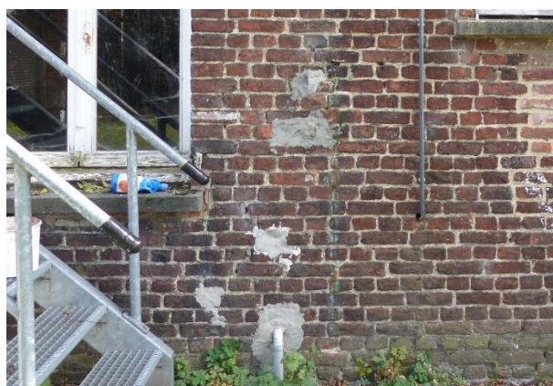
Figuur 39 Herstellingen met cementmortel (17.10.2018)
