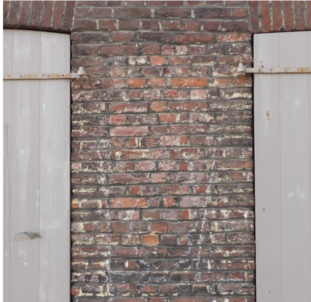
Figuur 19 (links) Zone metselwerk in andere kleur van aangebouwde garage tot voordeur woonhuis. Grens ligt gelijk met bovenzijde schrijnwerk (17.10.2018)
