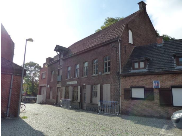
Figuur 15 Dubbelhuis van vijf traveeën met links, in het verlengde van het woonhuis, een schuur van twee traveeën. (17.10.2018)
