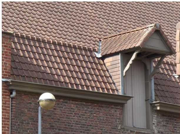
Figuur 45 Dakuitbouw katrolsysteem (17.10.2018)
