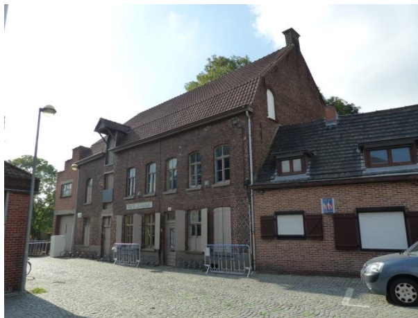
Figuur 3 Molenaarshuis in het straatbeeld, gezien vanaf het noorden
