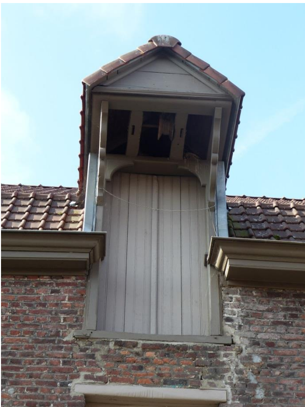
Figuur 82 Luiken zolderverdieping (17.10.2018)
