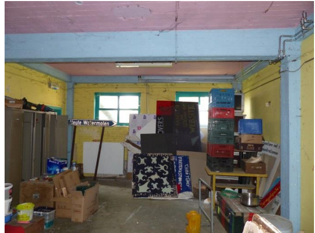
Figuur 104 Betonnen skelet in volume schuur (17.10.2018)
