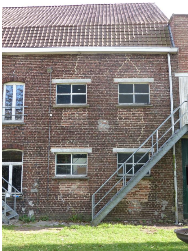
Figuur 37 Barsten en dichtgemetselde openingen schuur (17.10.2018)
