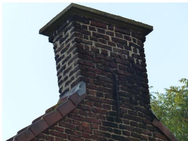
Figuur 29 Herstellingen voegwerk schouw met kalkmortel. Dekplaat in geprefabriceerd beton, bedekt met korstmossen (17.10.2018)
