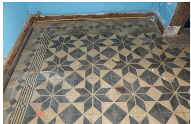
Figuur 133 Lokaal 3: cementtegels en rode plint (17.10.2018)
