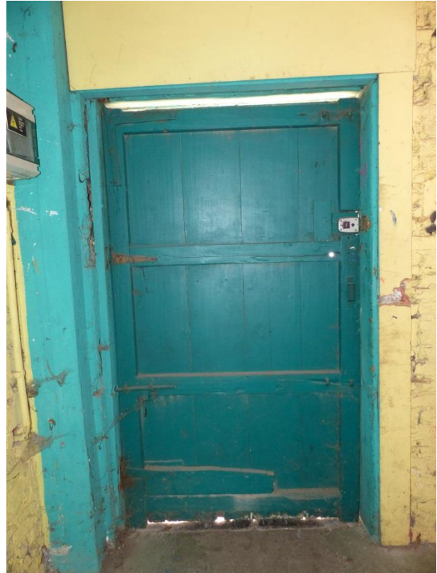
Figuur 77 Toegangsdeur schuur (17.10.2018)
