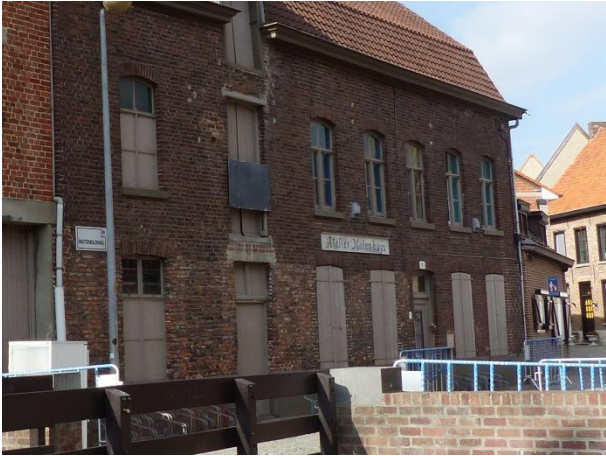
Figuur 19 (links) Zone metselwerk in andere kleur van aangebouwde garage tot voordeur woonhuis. Grens ligt gelijk met bovenzijde schrijnwerk (17.10.2018)
