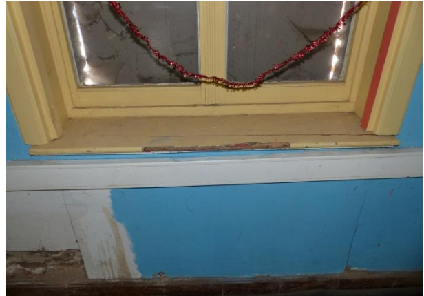
Figuur 122 Lokaal 3: gipskarton langs voorgevel (17.10.2018)
