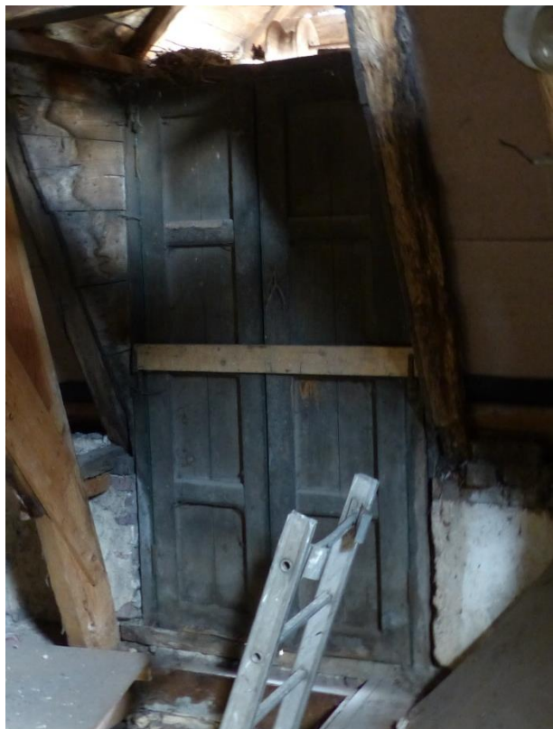
Figuur 83 Luiken zolderverdieping
