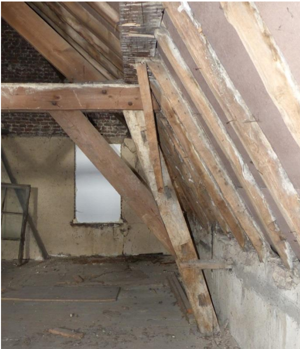
Figuur 53 Stijl uit recuperatiemateriaal (voormalige moerbalk) bij spant I (17.10.2018)
