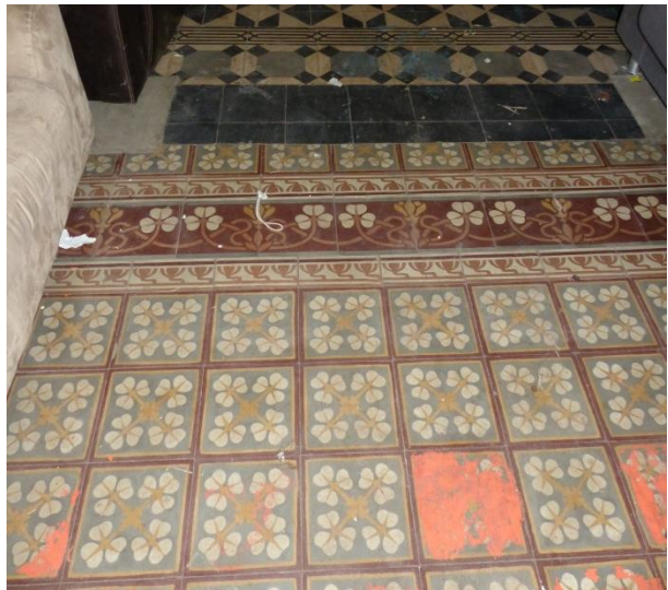
Figuur 134 Lokaal 3: cementtegels (17.10.2018)
