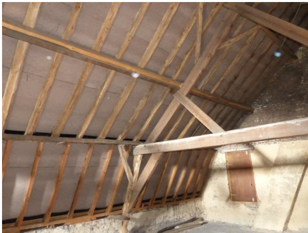
Figuur 59 Aantal gordingen reeds verstevigd (17.10.2018)
