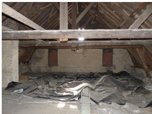
Figuur 31 Linkerzijgevel gezien vanop zolder: dichtgemetselde raamopeningen (17.10.2018)
