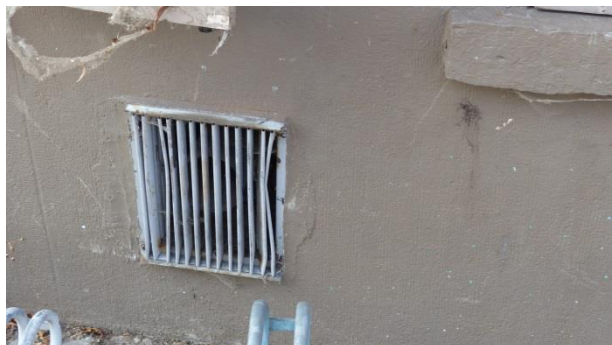
Figuur 25 Gevelvremde elementen: gasverwarming (17.10.2018)
