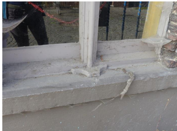
Figuur 64 Opzetstuk om afstand tussen luiken en ramen te garanderen (17.10.2018)
