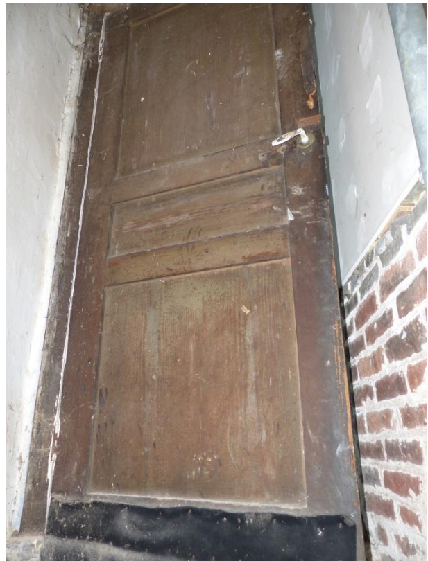
Figuur 147 Deur kelder > keuken (17.10.2018)
