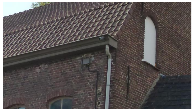
Figuur 47 Achtergevel: bakgoot bekleed met witte PVC-planchetten (17.10.2018)
