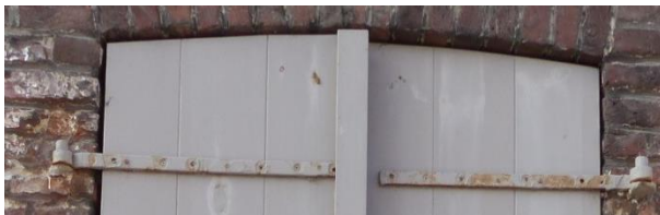
Figuur 61 Buitenluiken in gesloten toestand. Gecorrodeerde smeedijzers hengsels (17.10.2018)
