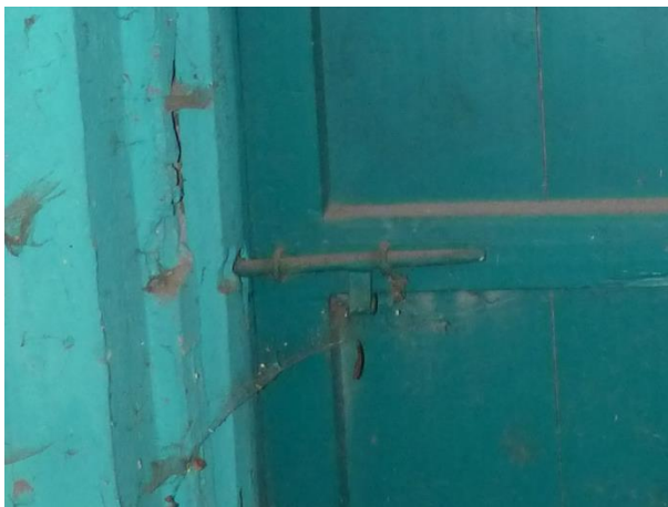
Figuur 78 Smeedijzeren schuifgrendel aanwezig aan beide zijden van de deur (17.10.2018)
