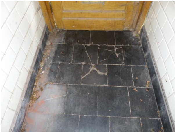
Figuur 130 (links) Gang: gebarsten tegels t.h.v. voordeur (17.10.2018)
