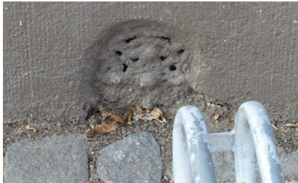
Figuur 22 Gevelrooster in plint (17.10.2018)
