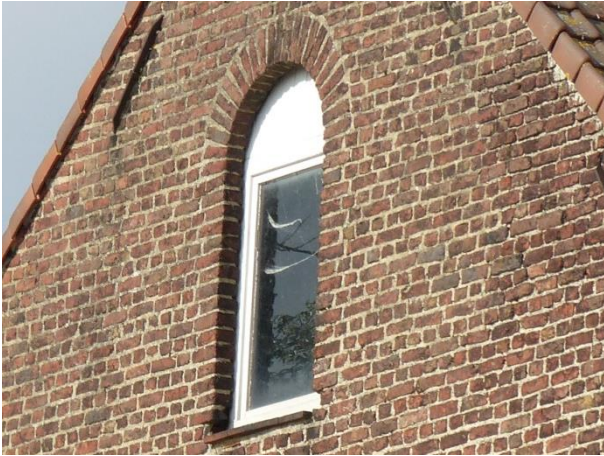
Figuur 32 (links) en Figuur 33 (rechts) Dorpels in gebakken aarde (17.10.2018)
