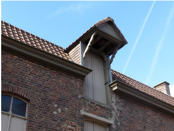
Figuur 46 Voorgevel: geprofileerde houten kroonlijst (17.10.2018)
