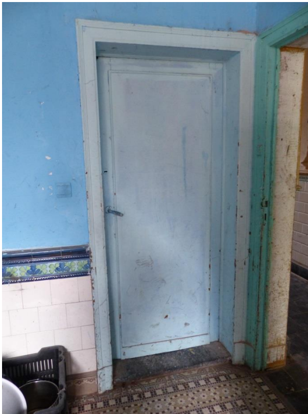
Figuur 146 Deur keuken > kelder (17.10.2018)
