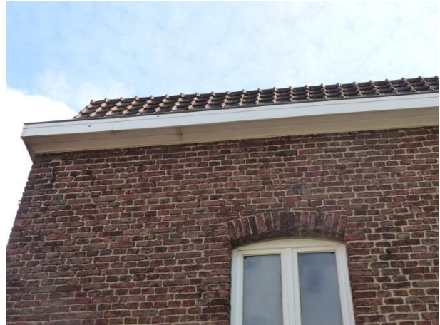
Figuur 47 Achtergevel: bakgoot bekleed met witte PVC-planchetten (17.10.2018)
