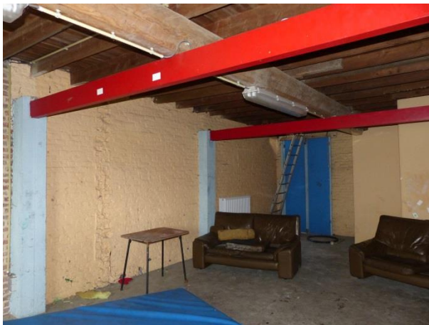
Figuur 105 Betonnen skelet in volume schuur (17.10.2018)
