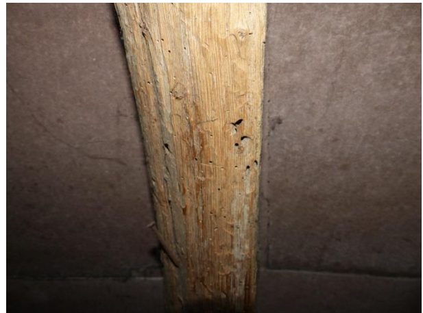
Figuur 60 Houtborende insecten: uitvliegopeningen met sterk verschillende diameter en vraatgangen (17.10.2018)
