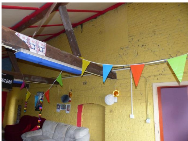
Figuur 30 Linkerzijgevel gezien vanuit recentere aanbouw: dichtgemetselde raamopeningen (17.10.2018)
