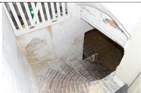
Kelder (bereikbaar vanuit hal) © M in O.
