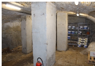
Afbeelding 153: Toegevoegde kolommen kelder woning 13/3
