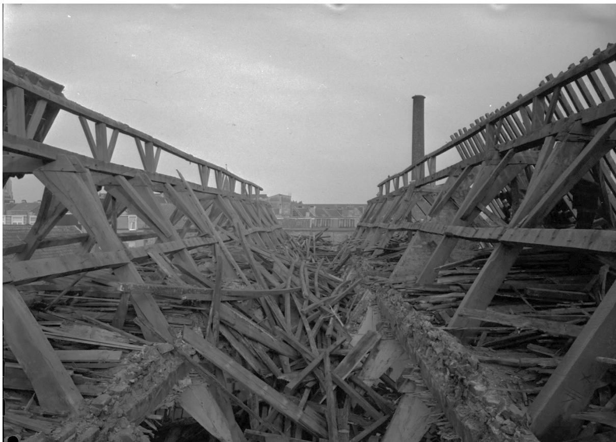
Afbeelding 179: het centrale pakhuis, met mogelijk gemetselde gewelven op de scheerzolder (zie het metselwerk op de gordingen van deze spanten, ongebruikelijk voor een houten vloer).
