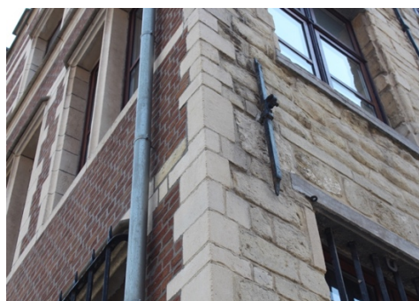
Afbeelding 62: Anker oorspronkelijke voorgevel en historiserende kopse gevel
