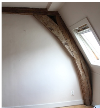
Afbeelding 74: Kromme spantbenen, woning 13/3
