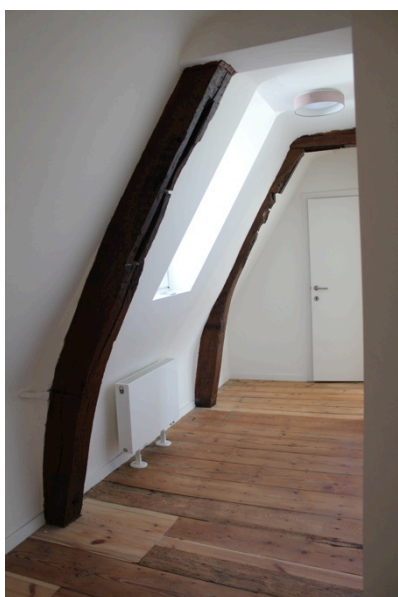
Afbeelding 173: Verwijderde korbelen, woning 13/2
