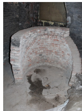
Afbeelding 83: Restant waterput, kelder woning 15
