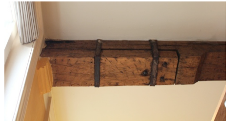
Afbeelding 73: Balkkop op console, oude herstellingen, woning 13/1
