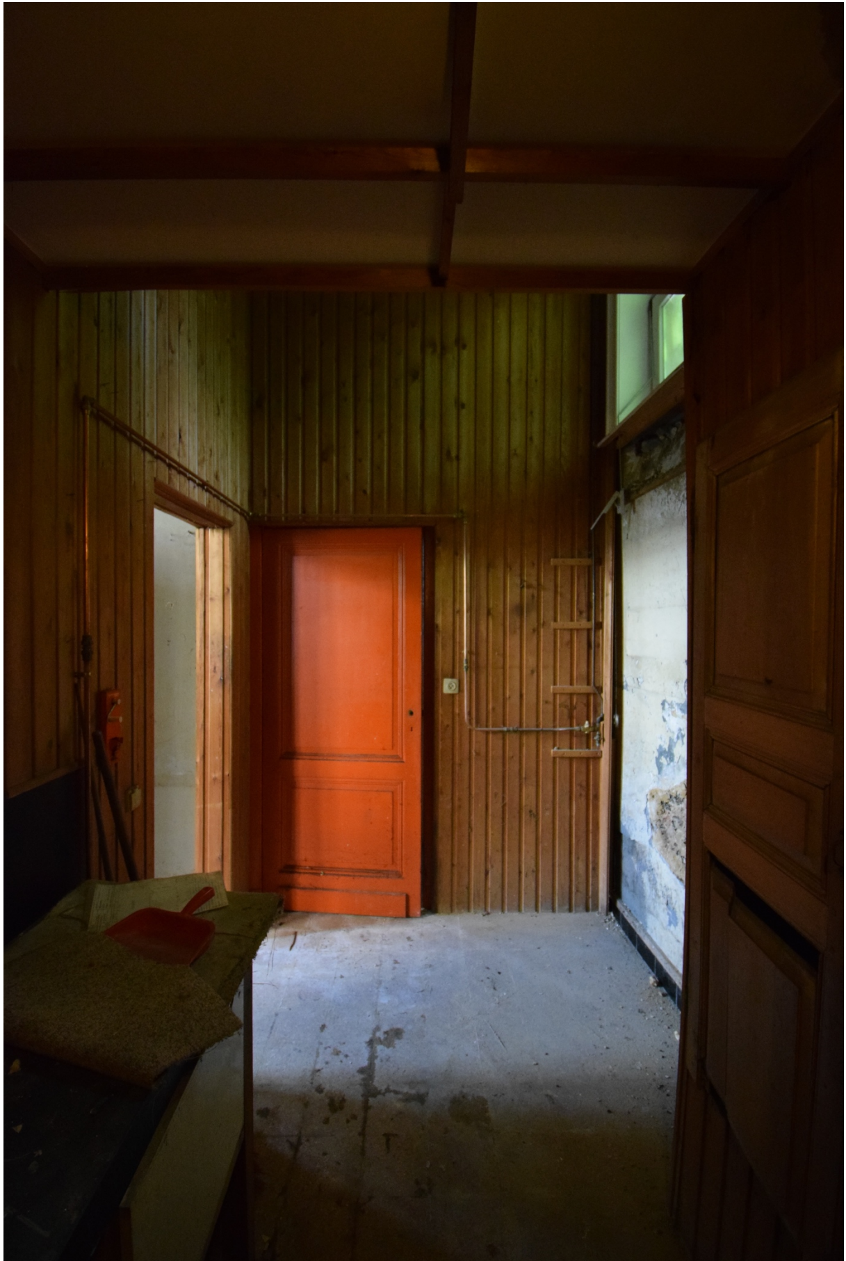
Afbeelding 192: Bijkeuken, links doorgang naar de keuken en rechts klein raam in scheidingsmuur met Venusstraat 17
