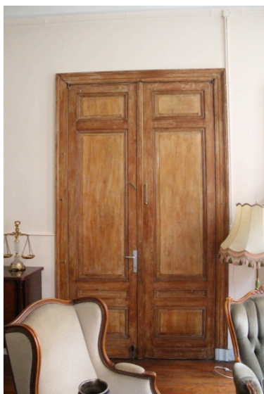
Afbeelding 112: Dubbele paneeldeur, woning 15
