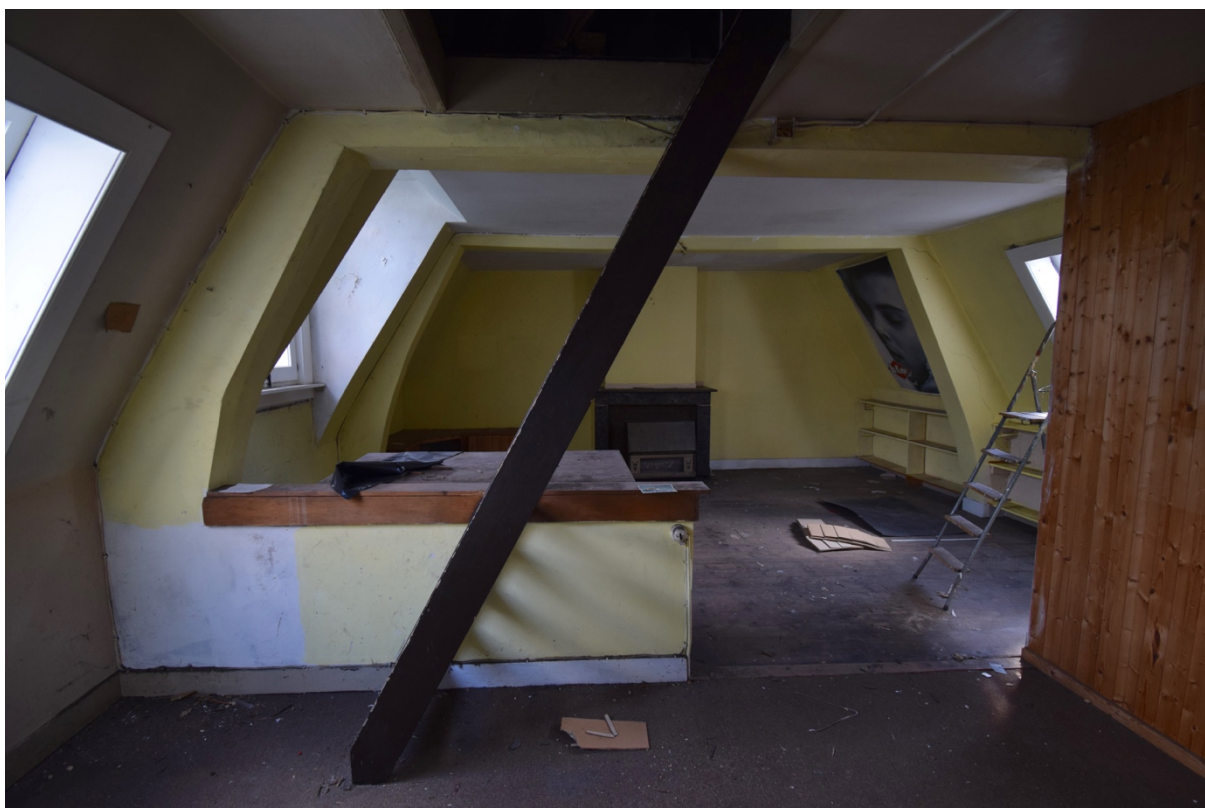
Afbeelding 194: eerste verdieping, links de standvensters aan de binnenplaats, rechts de omkaste traphal en er tussen de ladder naar zolder
