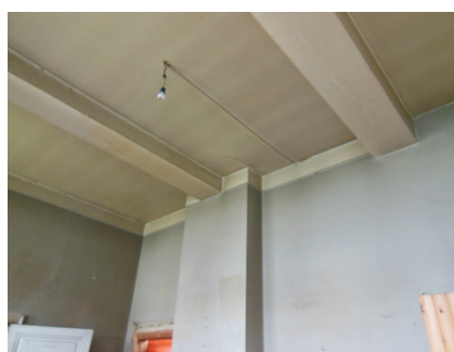
Afbeelding 110: Pleister op rinkellatten, woning 13/6
