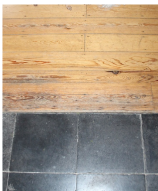
Afbeelding 105: Overgang Basècles-tegel op houten vloer, gelijkvloers woning 13/3
