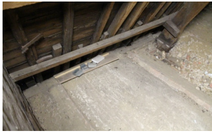
Afbeelding 68: bakstenen tongewelf aangebracht tussen dakgebinten, zolder woning 13/8
