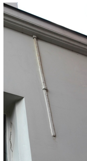
Afbeelding 56: Binnenplaats gekoppeld gevelanker
