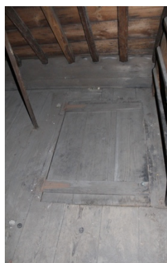
Afbeelding 107: Planken-zoldervloer en zolderluik, woning 13/6
