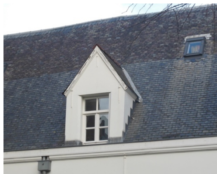
Afbeelding 94: Bovenste deel dakvlak: fumayleien, woning 13/2
