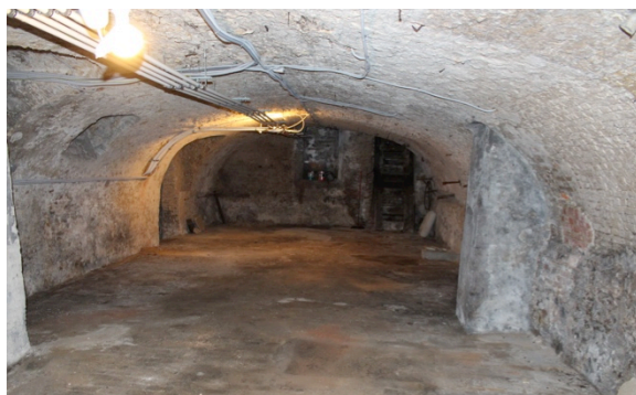
Afbeelding 80: Kelder woning 13/5 met trap achteraan.
