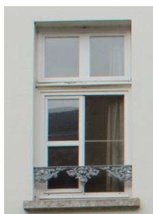
Afbeelding 52: Nieuw raam geplaatst in oude schrijnwerkkader, woning 13/5
