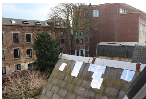
Afbeelding 156: Provisoire herstellingen en verroeste nokbeugels standvenster woning 13/4
