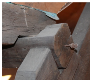
Afbeelding 149: Verbonden gordingen in woning 13/5
