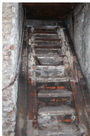
Afbeelding 86: Trap kelder 13/5 met railgeleiding
