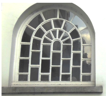
Afbeelding 51: Raam met ijzeren klein houten, woning 13/5
