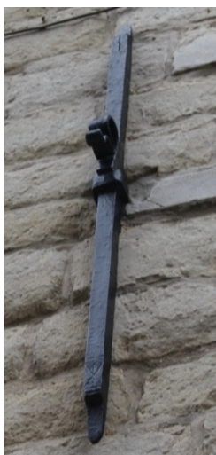
Afbeelding 53: Straatgevel anker
