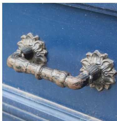
Afbeelding 45: Gegoten deurgreep, voordeuren binnenplaats
