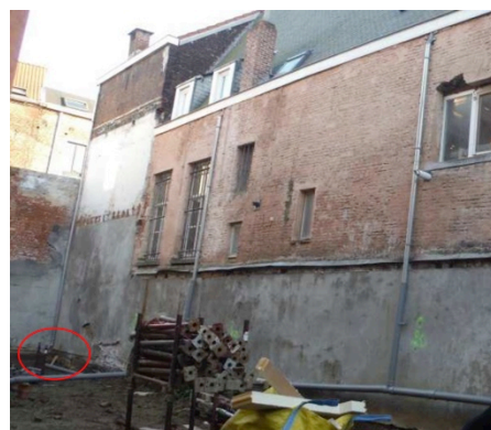
Afbeelding 139: Scheidingsmuur met Vekestraat, voor bekleding met gevelleien in 2016 (Monumentenwacht, 2015)
