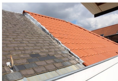
Afbeelding 157: Aansluiting pannendak woning 13/3
