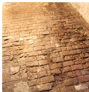
Afbeelding 108: Baksteenvloer, kelder woning 13/2
