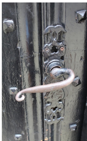
Afbeelding 42: Krukplaat en klink van klinket aan straatzijde
