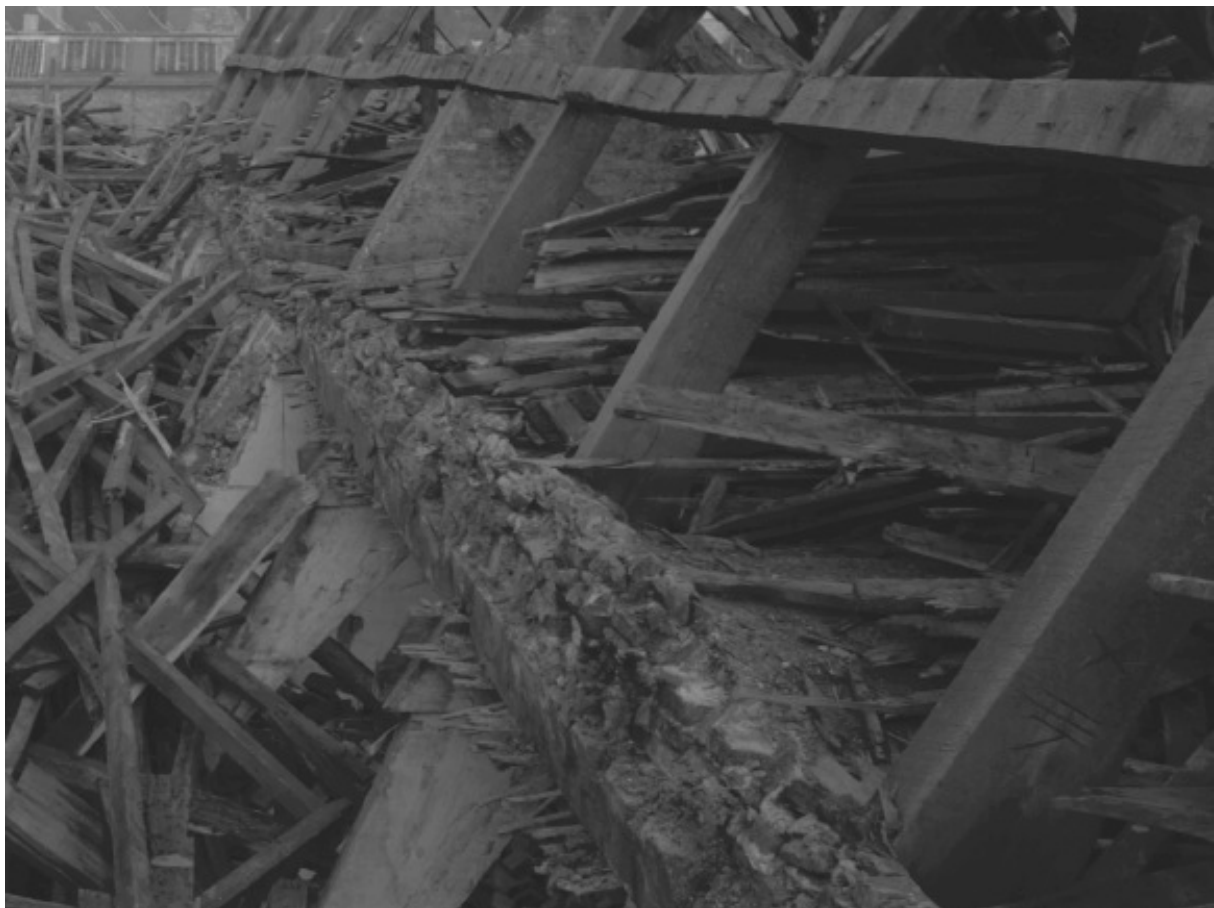
Afbeelding 180: detailopname van vorige foto, metselwerk op de gordingen
