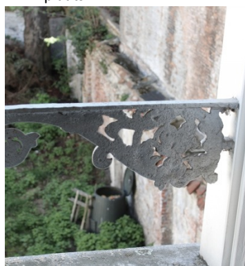
Afbeelding 47: Gietijzeren borstwering, woning 13/5
