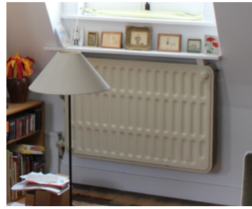
Afbeelding 130: Radiator en leidingen in opbouw, woning 13/4
