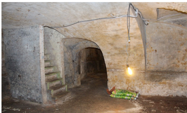
Afbeelding 81: Gewelf in tegengestelde richting, kelder woning 13/2
