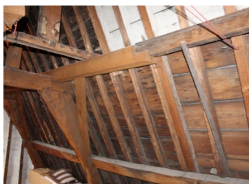
Afbeelding 147: Verwijderd spant in woning 13/3
