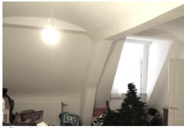
Afbeelding 69: onderzijde van tongewelfen op zolder van woning 13/8
