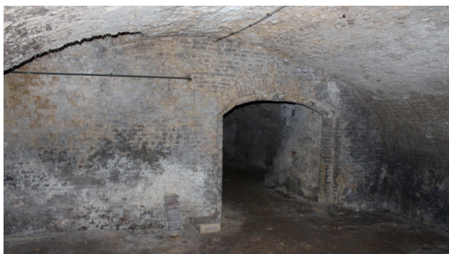
Afbeelding 79: Keldergewelven afdragend van gevel tot gevel, woning 13/6
