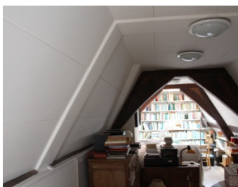
Afbeelding 148: Verwijderd spant in woning 13/4
