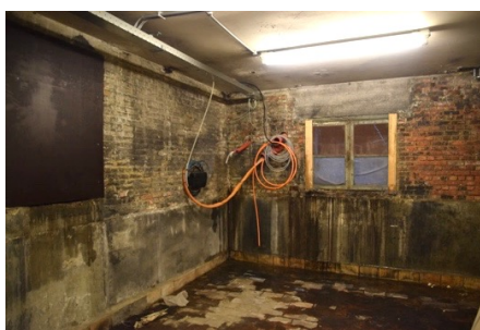
Afbeelding 89: Kelderruimte ondervoorhuis nr. 11 met aangepaste kelderopeningen
