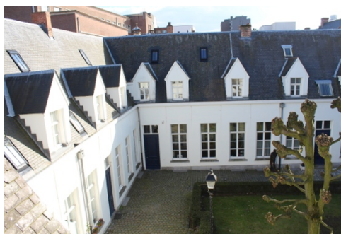
Afbeelding 90: Zuidelijk en westelijk dakvlak binnentuin
