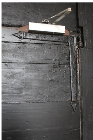
Afbeelding 40: Spoorhengsels klinket in toegangspoort
