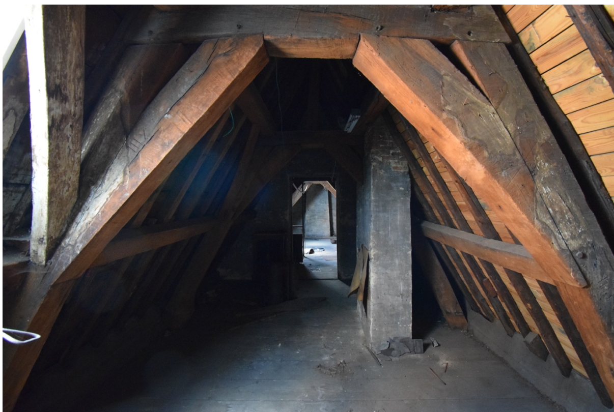
Afbeelding 196: Zolder boven de vorige foto, kapconstructie, tussenwand en schouwen
