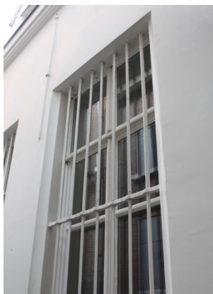
Afbeelding 58: Traliwerk binnenplaats, woning 15
