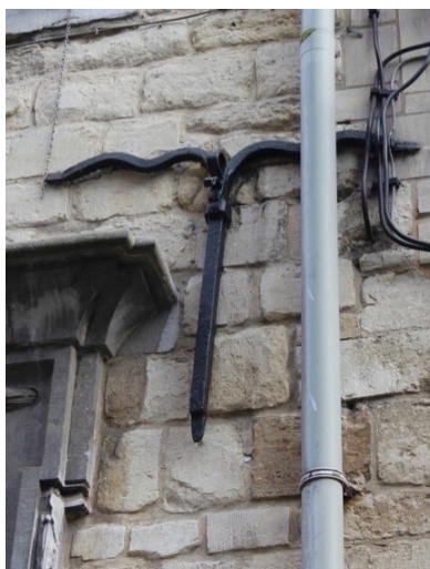
Afbeelding 54: Straatgevel anker t.h.v. scheidingsmuur Venusstraat 17
