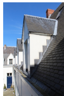
Afbeelding 92: Aansluiting standvenster
