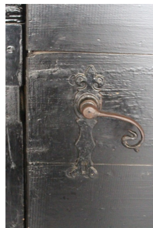
Afbeelding 43: Krukplaat en klink van klinket, zijde binnenplaats
