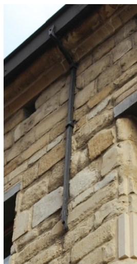
Afbeelding 55: Straatgevel anker t.h.v. kroonlijst
