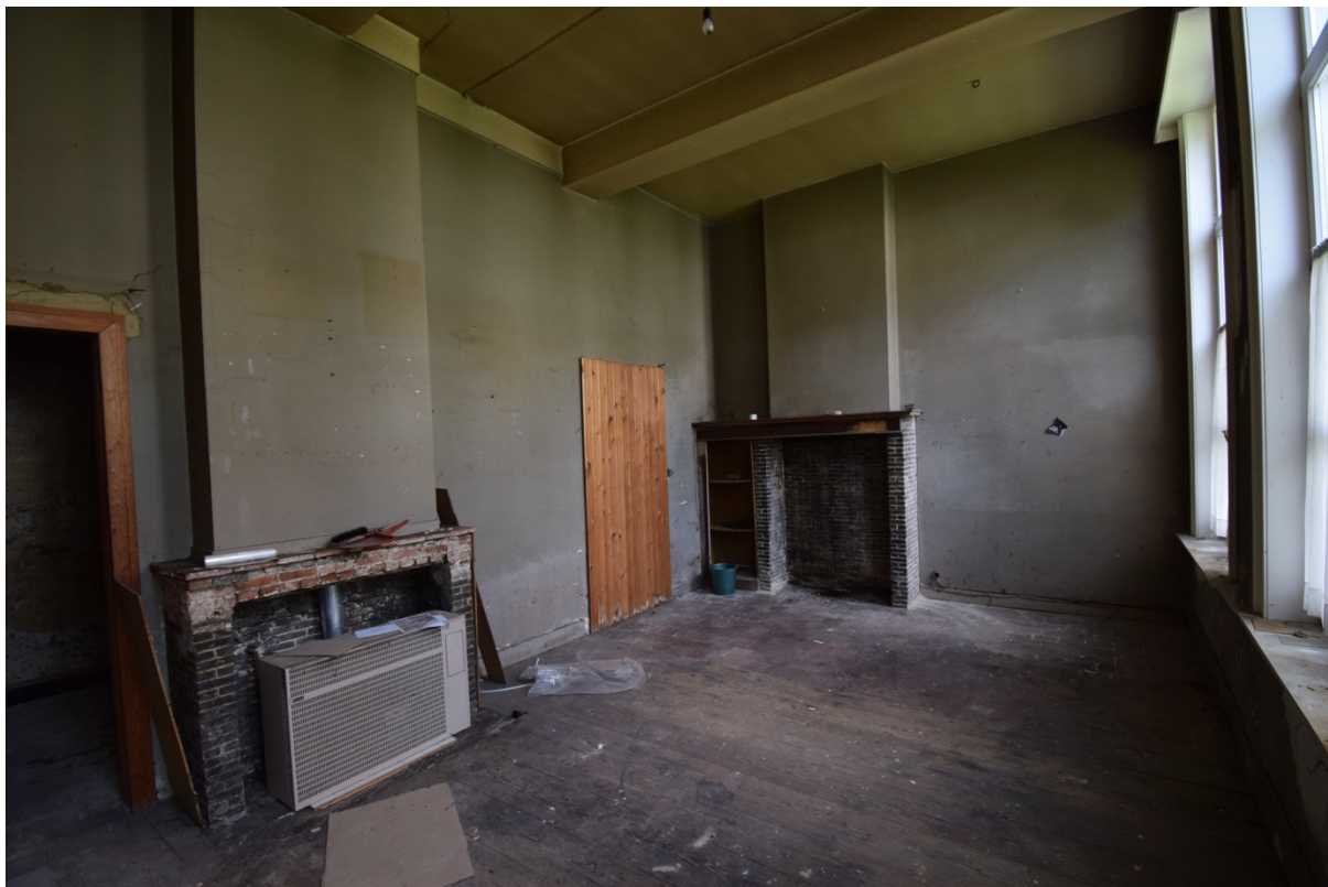
Afbeelding 193: Keuken met twee bakstenen haardmantels, gepleisterd plafond en balken, twee doorgangen naar bijkeuken, plankenvloer en achteraan plavuizenvloer
