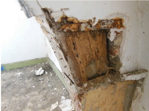
Afbeelding 143: Aantasting grote klopkever in spant, woning 13/6
