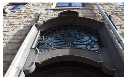
Afbeelding 67: Smeedijzerwerk in bovenlicht voordeur nr. 11
