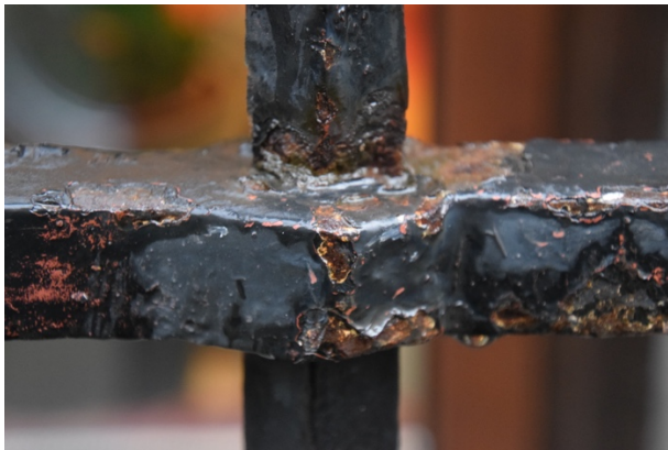
Afbeelding 145: Roestig diefijzer nr. 11
