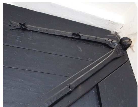
Afbeelding 39: Deurhengsels toegangspoort
