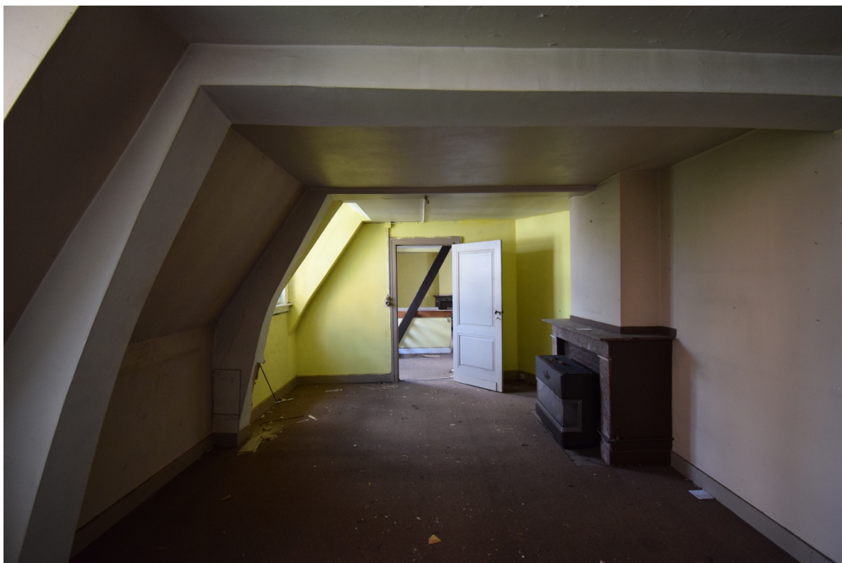
Afbeelding 195: Slaapkamer op de eerste verdieping, links de standvensters aan de binnenplaats, rechts een natuurstenen haardmantel, gepleisterd plafond en dakgebinte
