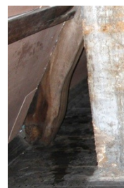
Afbeelding 150: Ingerotte spantvoet woning 13/7
