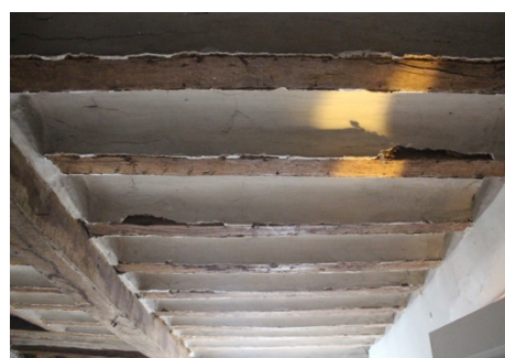
Afbeelding 111: Kalkwelfsels of troggewelven, woning 15
