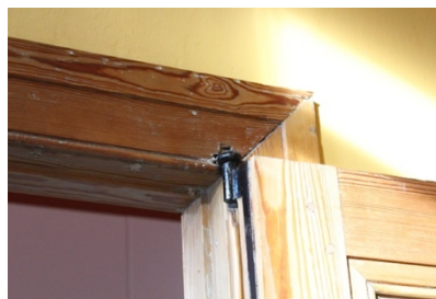
Afbeelding 117: Deurhengsel enkele paneeldeur, woning 13/1
