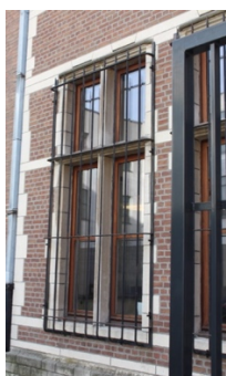
Afbeelding 61: IJzerwerk kopse gevel
