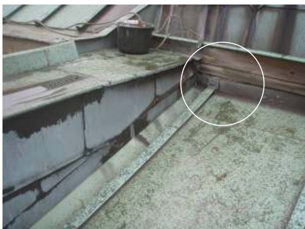
Dak [6], aansluiting met vleugel [1].
