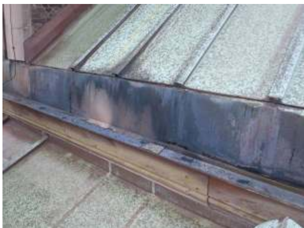
Dak [2]-zuid, in de oostelijke hoek.
