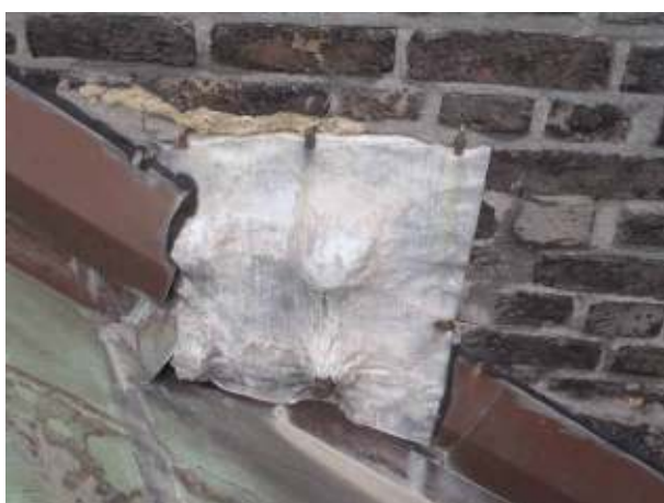
Dak [2]-zuid, geperforeerde loodaansluiting met vleugel [1].
