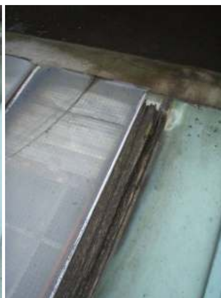
Dak [7], westelijk dakraam.
