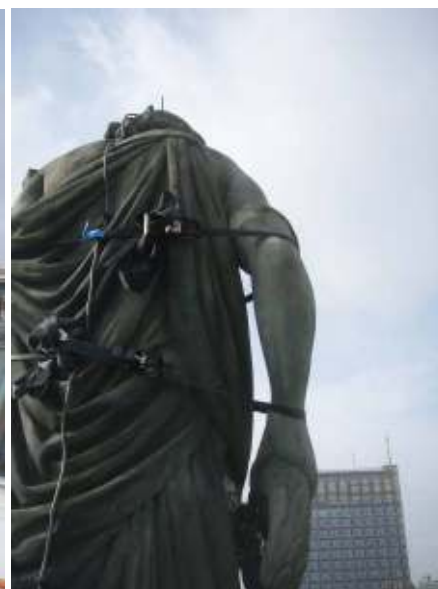
Tijdelijke verankering met spanbanden.
