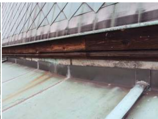
Dak [8], aansluiting met vleugel [1].
