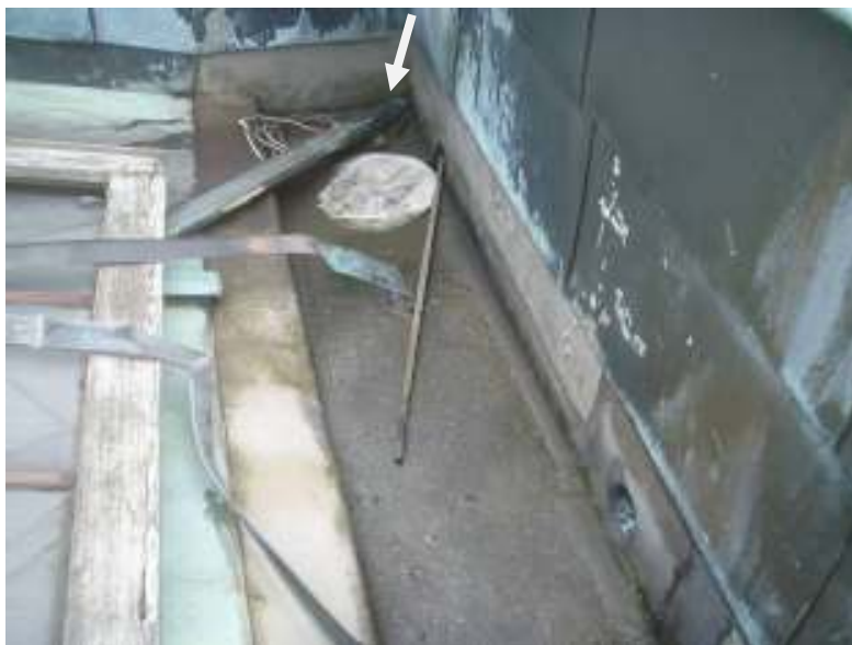
Dak [8] (pijl= waar afvoeropening zit).
