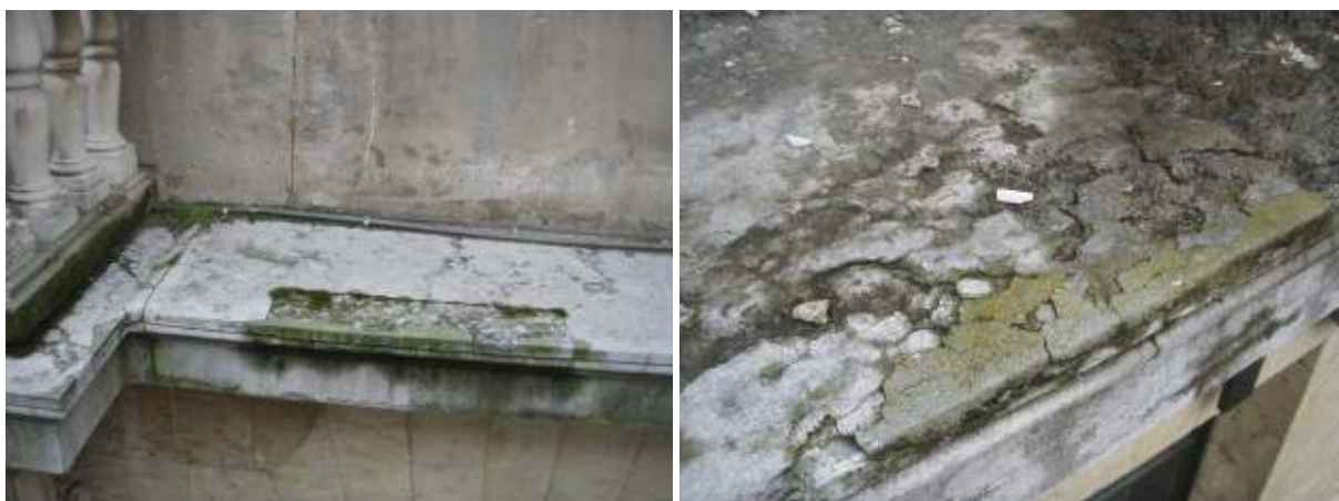
Vleugel [2]-zuid, afbrokkeling in de westelijke hoek van de waterlijst.
