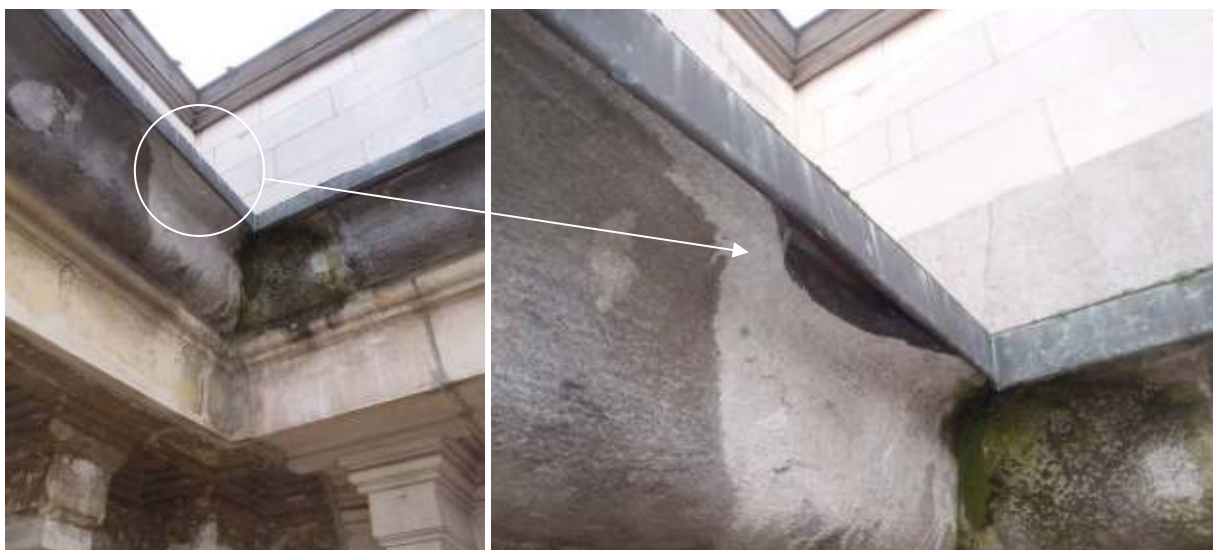
Vleugel [5]-west, voor en na verwijderen van een loszittende herstelling aan de kroonlijst uit blauwe steen.
