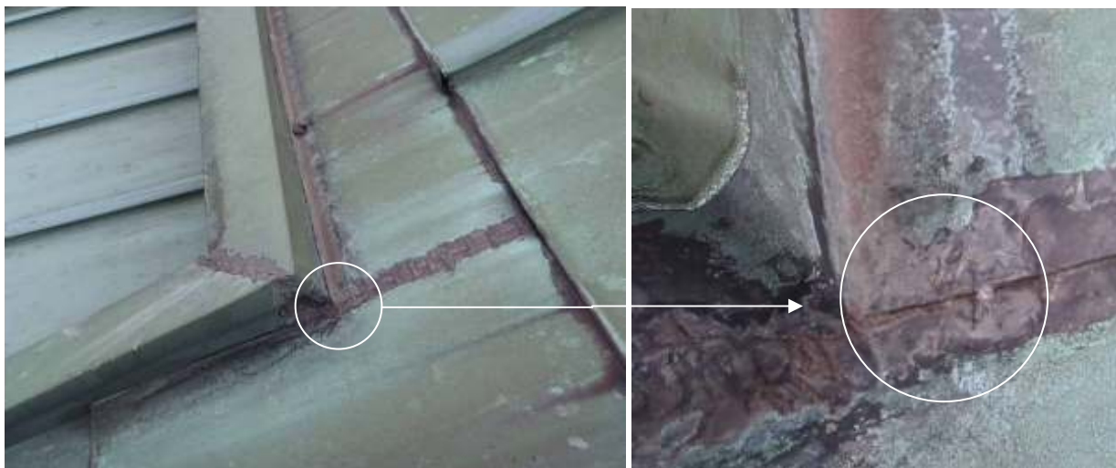
Dak [1]-noord, middelste rookkoepel, bovenaan de westelijke hoek.
