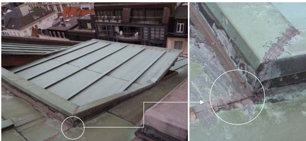
Dak [1]-noord, westelijke rookkoepel.
