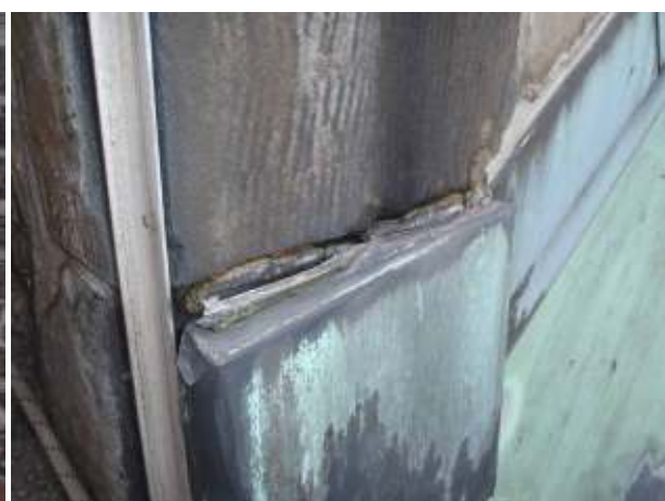
Dak [3], aansluiting aan de noordzijde in aansluiting met vleugel [2]-west.
