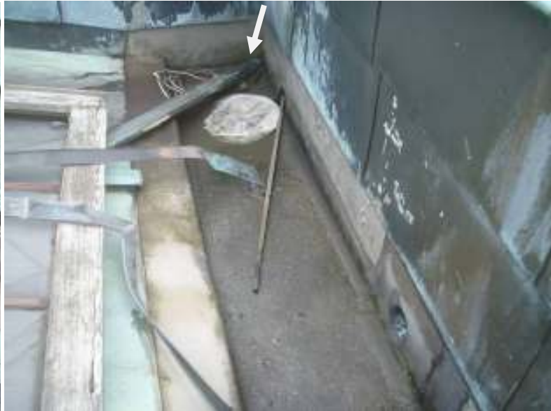
Dak [8] (pijl= waar afvoeropening zit).
