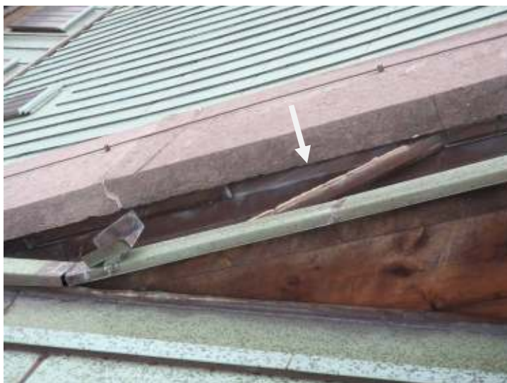
Dak [1]-zuid, in aansluiting met de westelijke topgevel.
