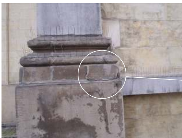
Vleugel [6], voor en na het wegnemen van het loszittend stuk steen en nog aanwezige roestige dook.
