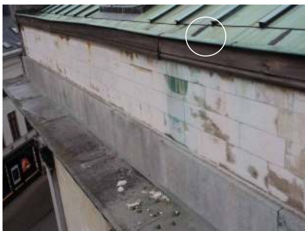
Dak [2]-zuid, westelijk deel.
