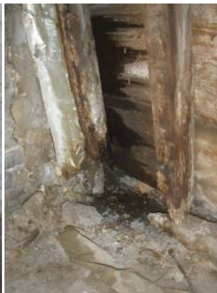
Dak [1]-zuid, in de oostelijke hoek.
