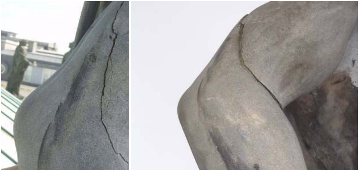
Scheurvorming bovenop elleboog 2011 en nu.
