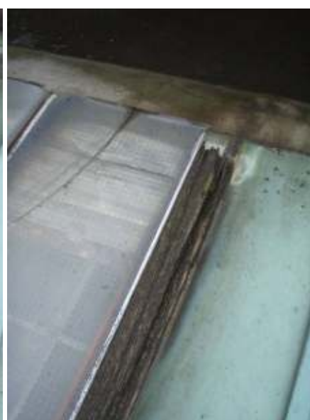
Dak [7], westelijk dakraam.
