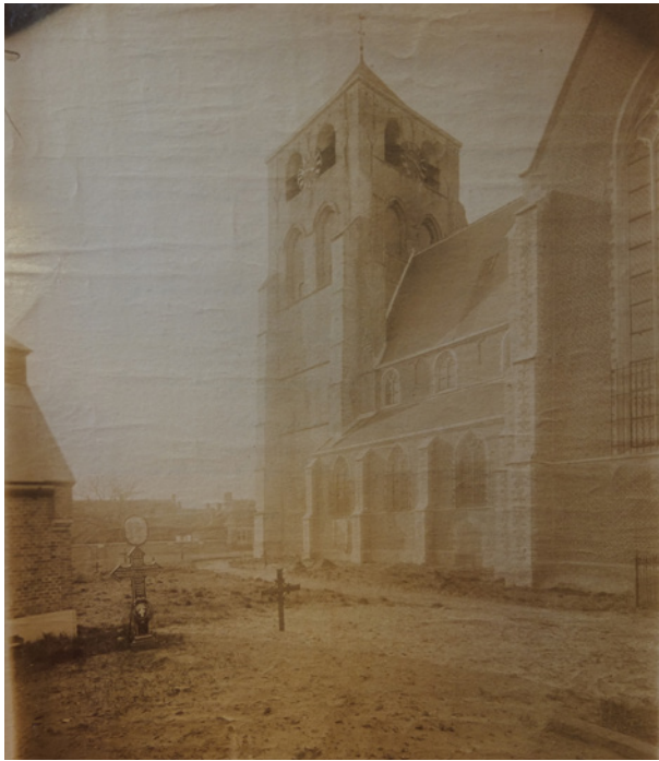
afb. 31: 1886 - Foto vóór de herstellingswerken
