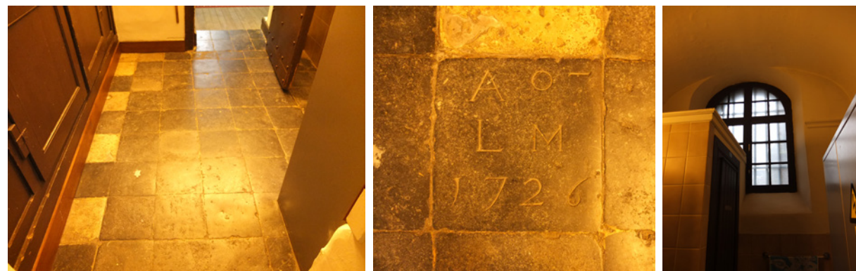
afb. 132: Vloer uit 1726 in het voorste deel van de sacristie met gaaf bewaarde jaarsteen
