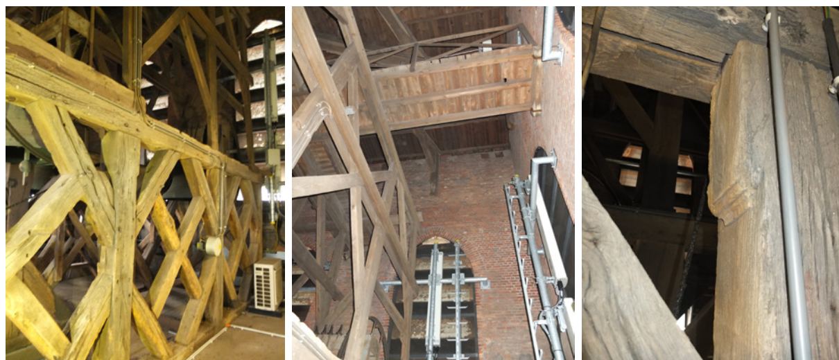
afb. 192: Foto's van de klokkenstoel
