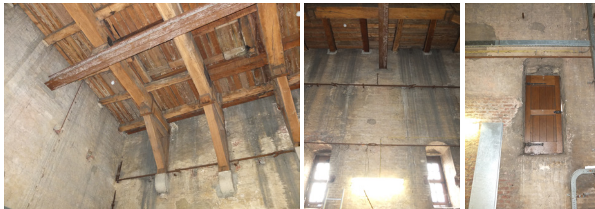
afb. 191: Foto's van de tweede tussenverdieping
