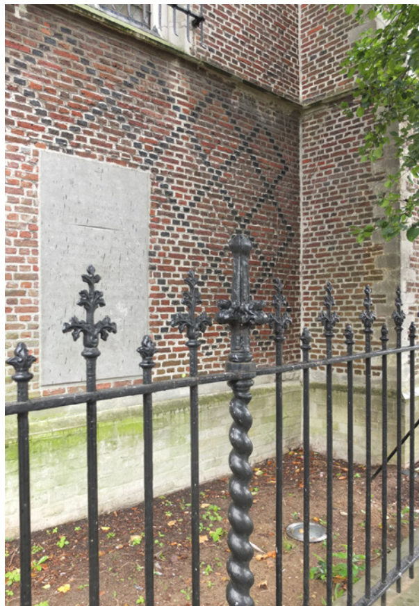
afb. 65: Ruitmotieven onderzijde kopgevel noordtransept
