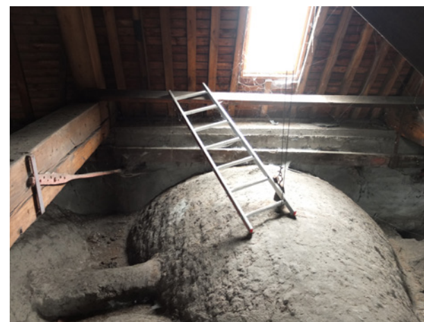
afb. 202: Bovenaanzicht van het bakstenen koorgewelf
