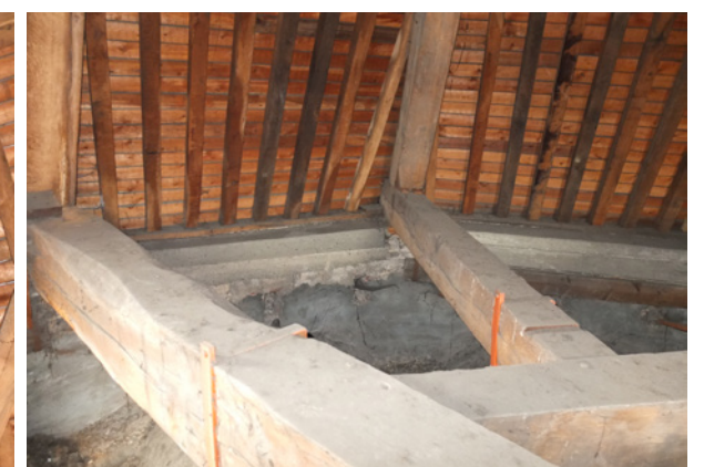
afb. 207: Betonnen ringbalk boven het koor
