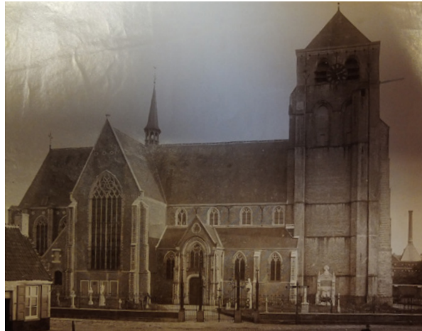
afb. 58: Foto vóór 1911, voor de restauratie van de toren
