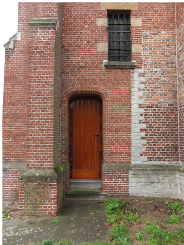
afb. 94: Verschil in hoekafwerking kruisverband ©K. Mulder
