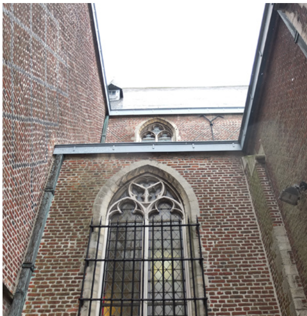
afb. 62: Verschillend voegwerk tussen portaal en zijbeuk
