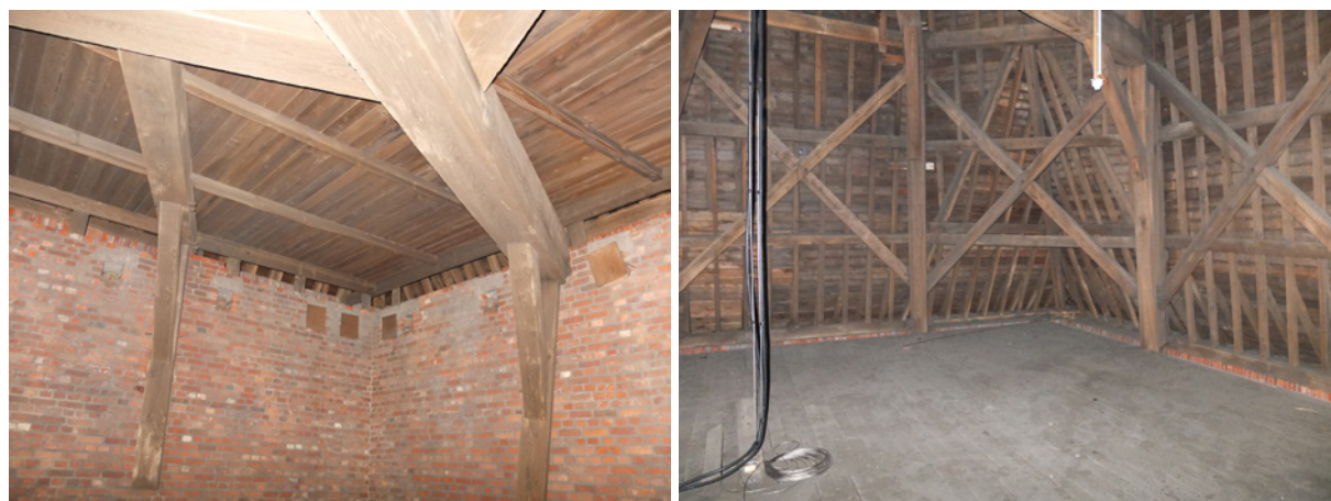
afb. 195: Onderaanzicht vloerstructuur torenspits
