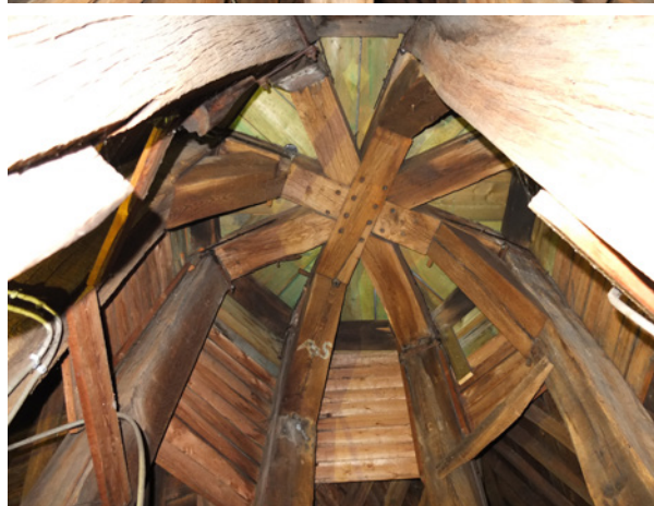
afb. 199: Dakstructuur van de vieringtoren
