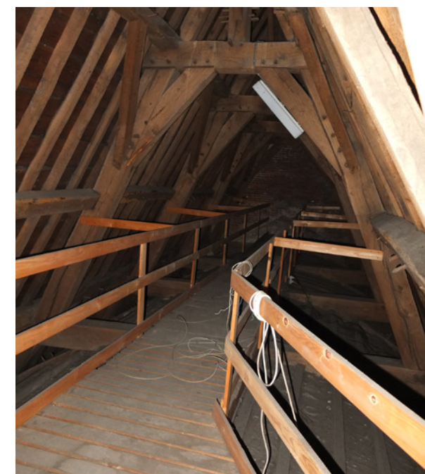
afb. 203: Dakstructuur boven het transept
