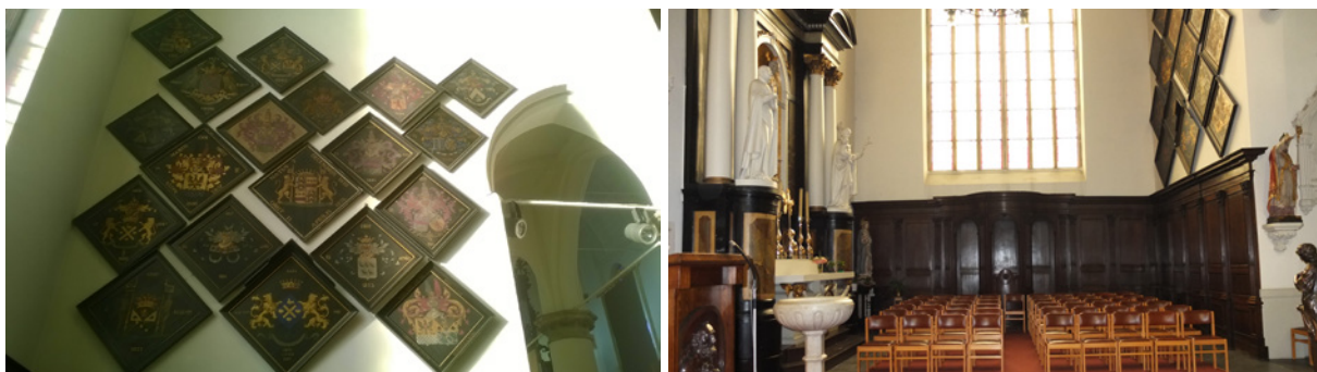
afb. 173: Obiits in het zuidtransept
