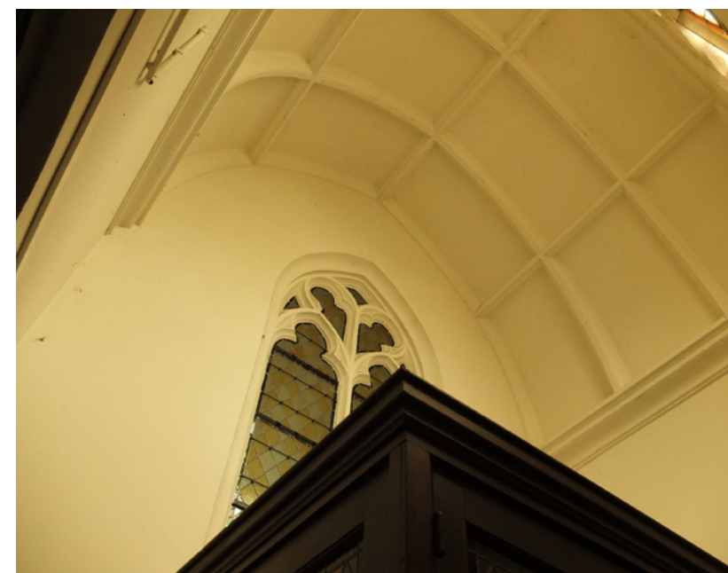
afb. 150: Gewelf uit 1871, met later toegevoegd volume voor de tochtsas
