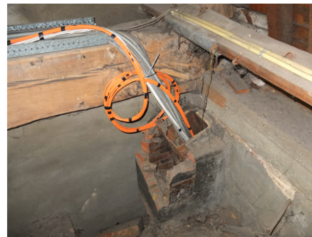
afb. 201: Latere schoorsteen vandaag voor technieken gebruikt
