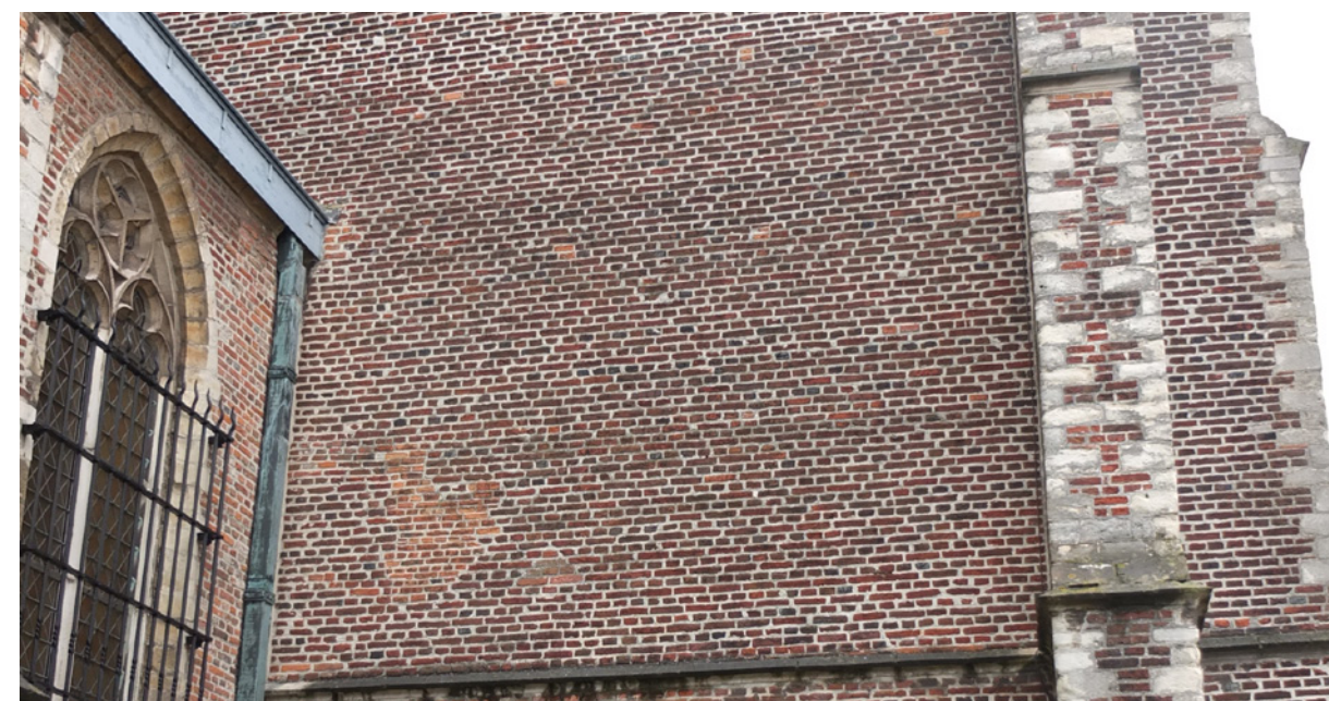
afb. 76: Dichtgemetste steigergaten en andere bouwsporen
