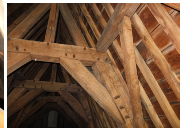
afb. 204: Detail telmerken en pen-en-gatverbindingen
