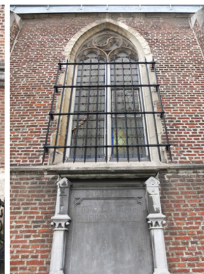
afb. 74: Raam zijbeuk met traliwerk
