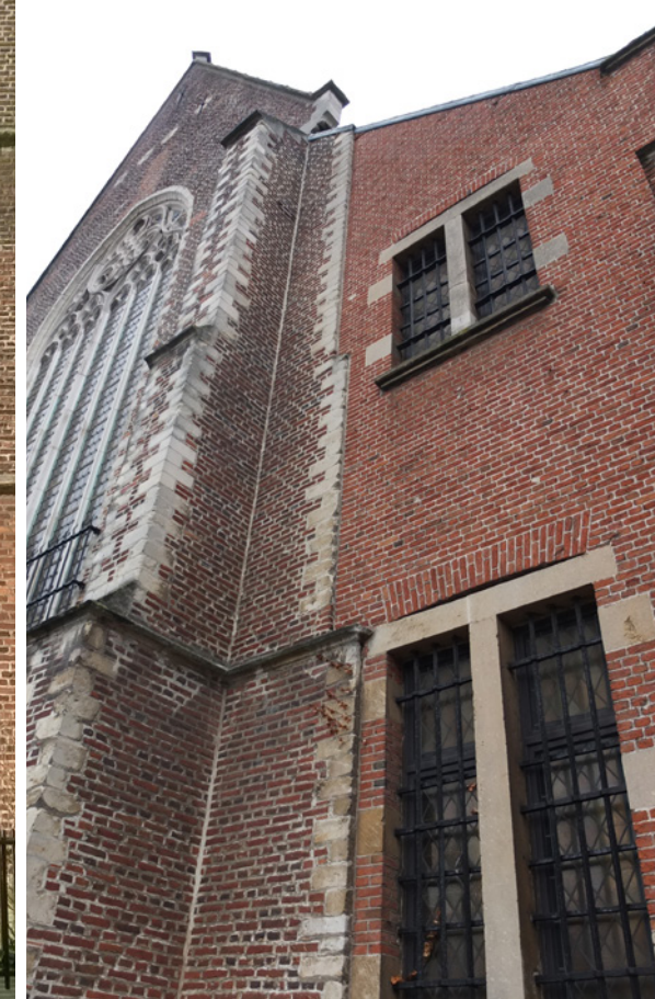
afb. 92: Verschil in bouwmethode, baksteen en witte steen
