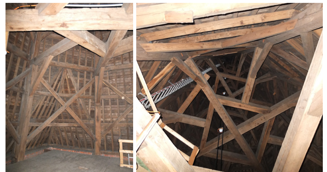
afb. 197: Binnenzicht en vloerstructuur torenspits
