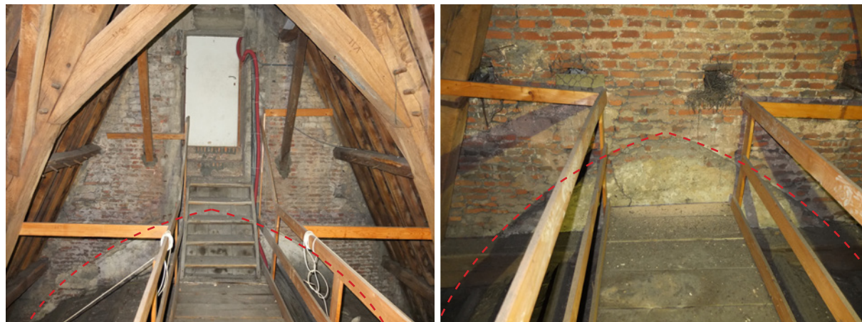
afb. 106: Bouwsporen oud gewelf, gezien richting de toegang tussen toren en zolder middenbeuk (links) en in zolder transept (rechts)
