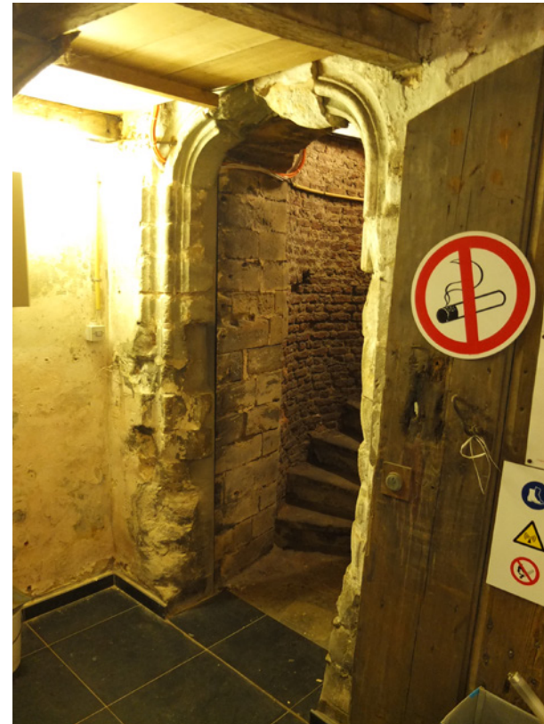
afb. 175: Deur naar de spiltrap, gelijkvloerse verdieping
