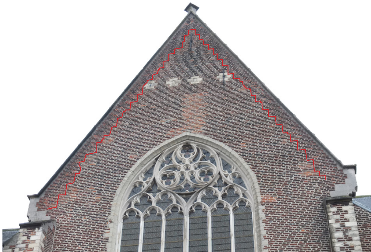
afb. 66: Bouwspoor in de puntgevels van beide transeptzijden
