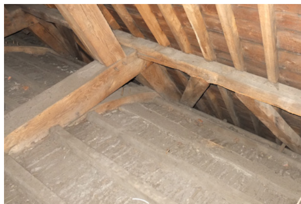
afb. 108: Houten draagstructuur en rinkelatten
