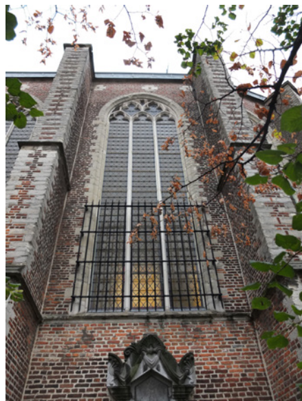
afb. 80: Hoog gotisch venster van het koor
