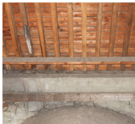
afb. 78: Betonnen ringbalk van restauratie
