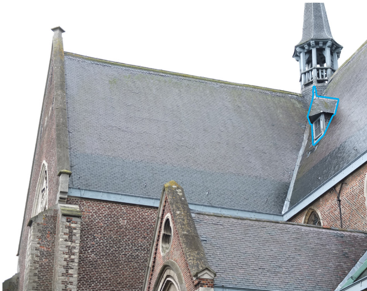
afb. 93: Foto van de noord- en westzijde van de daken, het verschil tussen de roze leien uit Fumay en de grijze leien is goed zichtbaar
