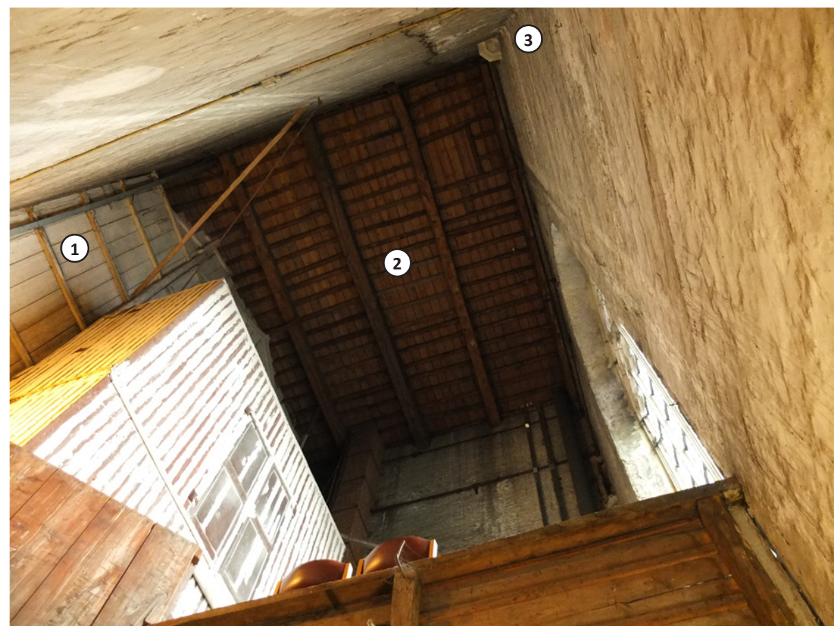
afb. 122: Ruimte achter het orgel in de toren
