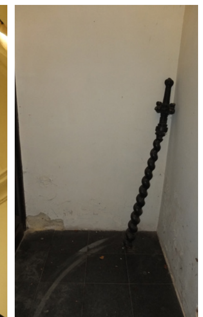
afb. 151: Zuil van het hekwerk (exterieur)
