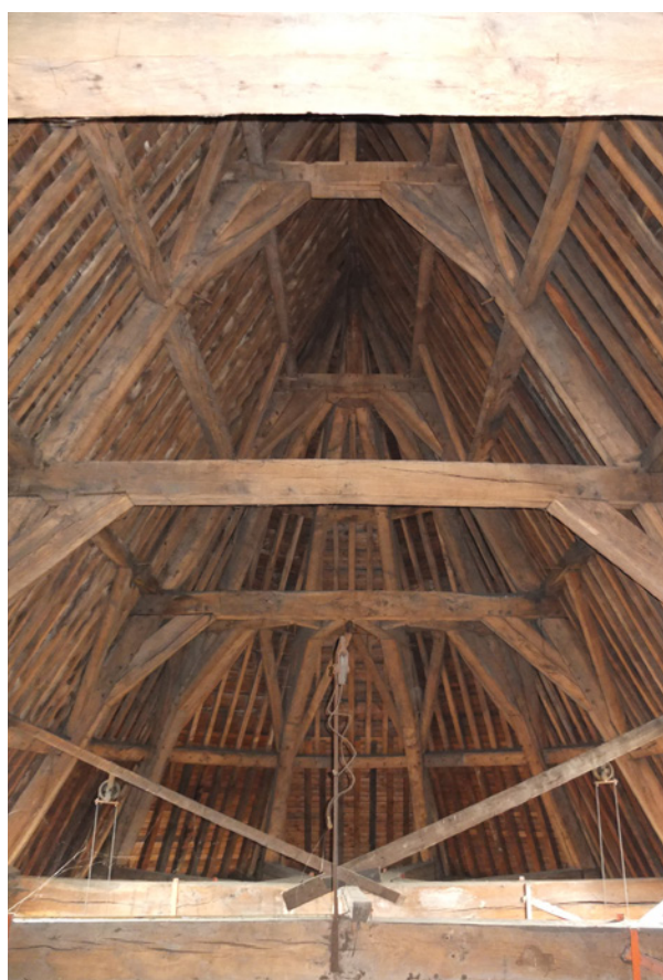
afb. 200: Dakstructuur boven het koor
