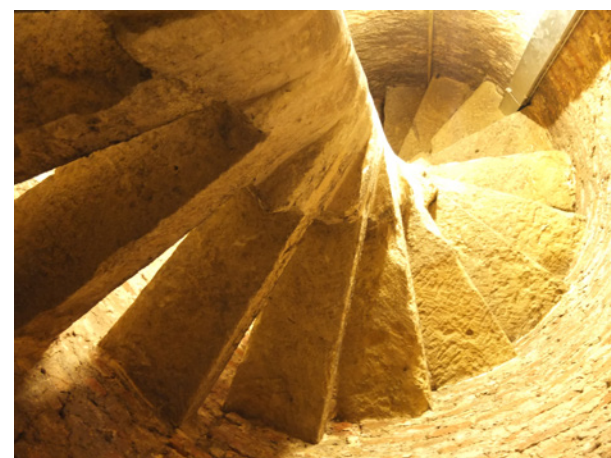
afb. 178: Onderaanzicht van de spiltrap
