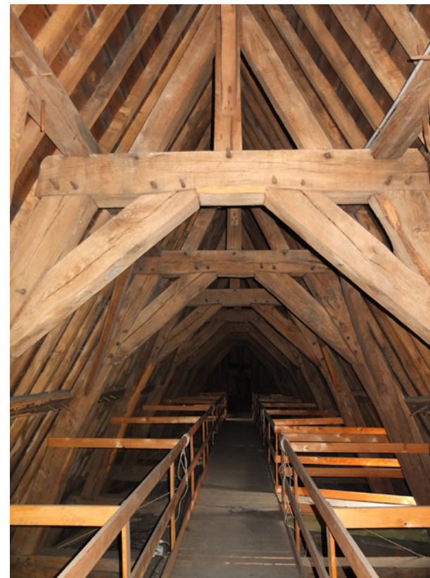
afb. 198: Genummerde spanten boven het schip
