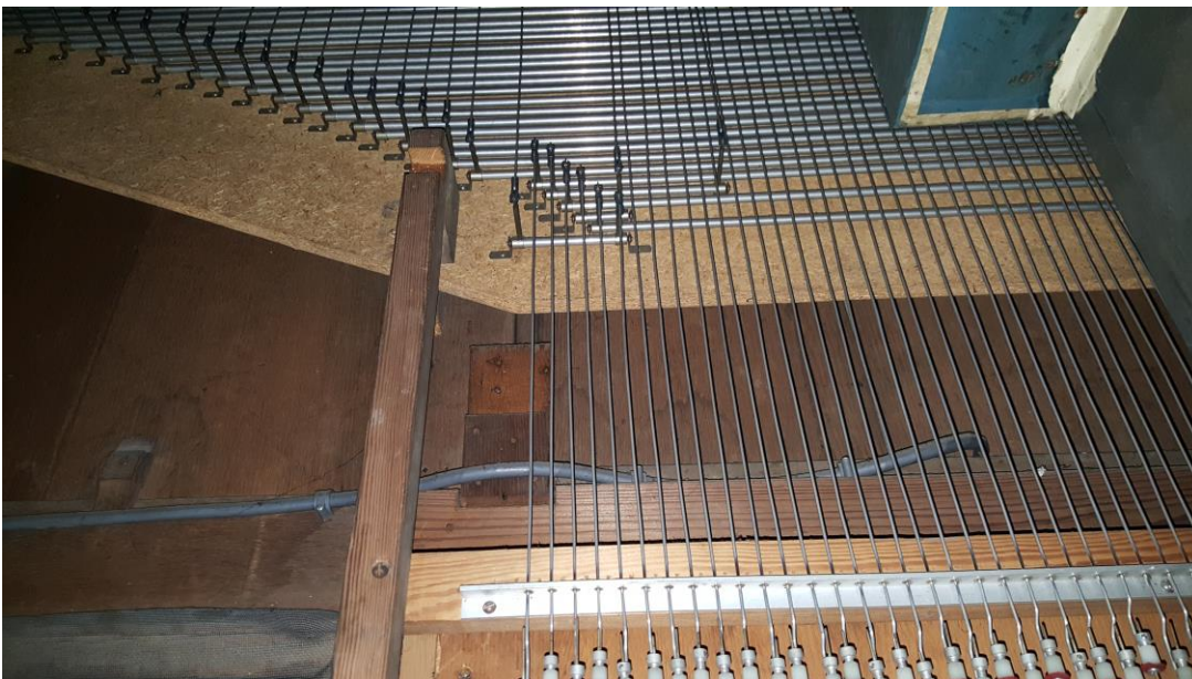
wellenboord hoofdwerk: aluminiumelementen op en gewone, niet duurzame vezelplaat gemonteerd
