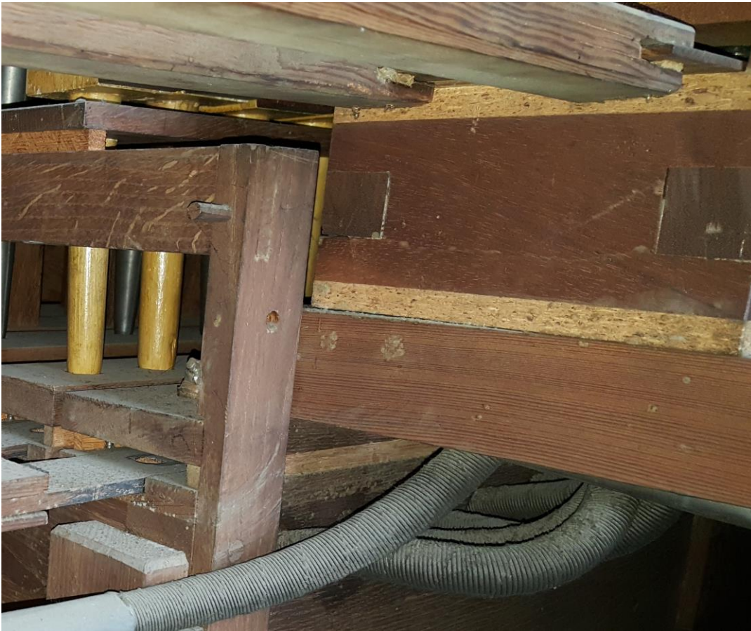
pedaalwindlade met gebruik van niet duurzame vezelplaat
