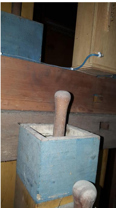
aantasting door houtworm aan het handvat van een pijp van de Zachtbas 16'
