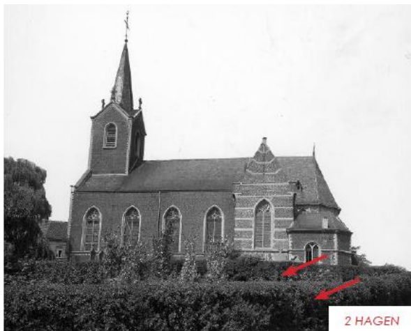
Figuur 10: Afwezigheid van kerkhofmuur (oostzijde) in 1944 (Fenikx bvba, 2011)
