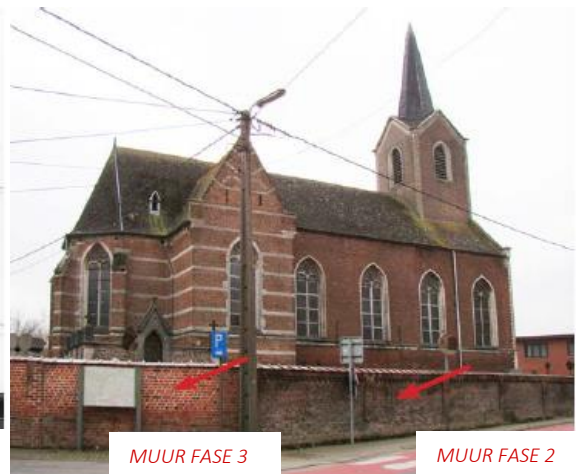
Figuur 14: Kerkhofmuur uit rode baksteen en afgedekt met pannen (Fenikx bvba, 2011)
