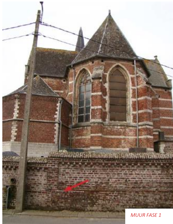
Figuur 12: Kerkhofmuur uitgevoerd met ezelsrug (Fenikx bvba, 2011)
