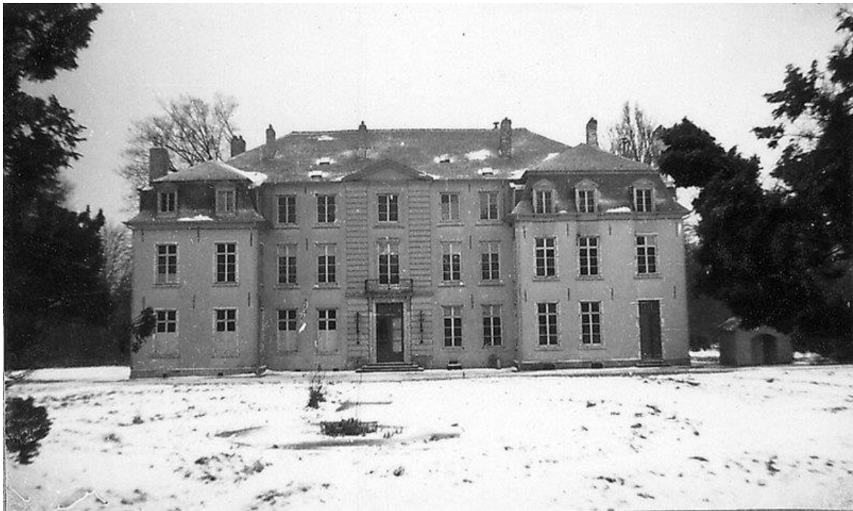
Afb. 6. Het kasteel omstreeks 1940. De deuromlijsting met hoek- en negblokomlijsting is nog aanwezig. Bron: KIK.
