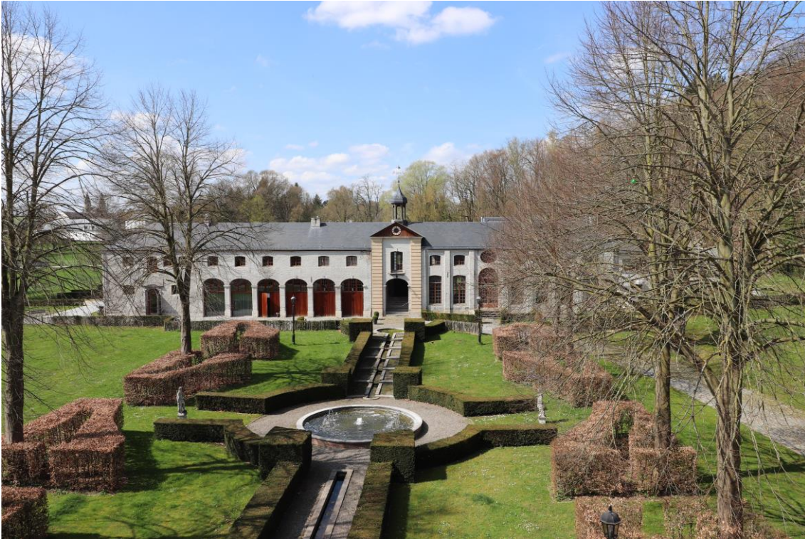
Afb. 31. Zicht op het koetshuis en de oranjerie vanuit het kasteel.
