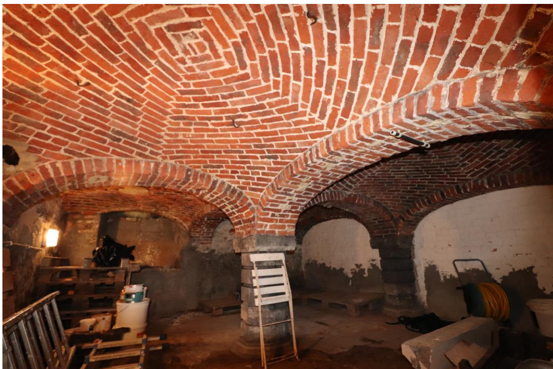
Afb. 27. Kelder met Boheemse kap onder de zuidelijke zijvleugel.
