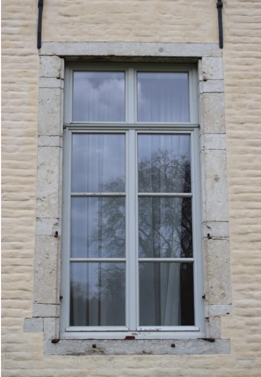
Afb. 24. Venster met verlaagde plattebandomlijsting in de noordgevel.
