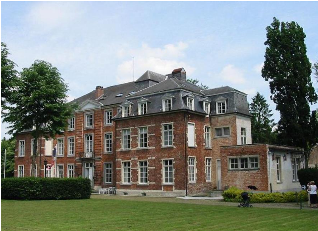
Afb. 5. Na verwijdering van de historische pleisterslaag in de jaren 1980 kwamen interessante bouwsporen aan de zuidelijke zijvleugel aan het licht. Bron: www.kasteelvanneerijse.be/album .
