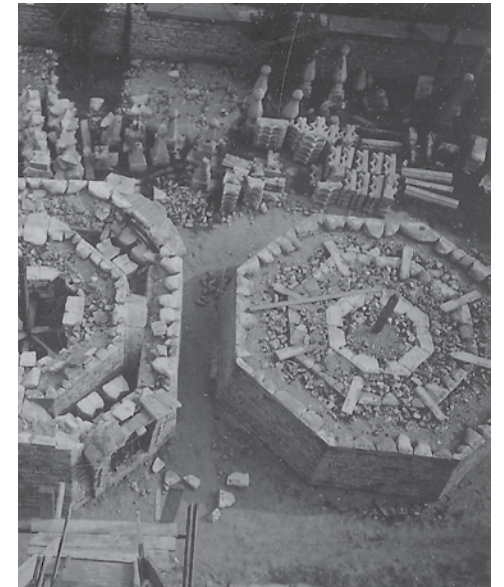
38. Opbouw van de toren in stapels. (KIK-IRPA)
