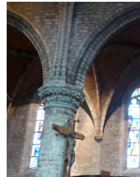
47. Overlopen van kapiteel in de ribben van de kruisribgewelven
