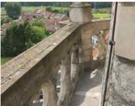
50. Gebruik van kalkzandsteen ivf detaillering als kenmerk voor de Brabantse Gotiek
