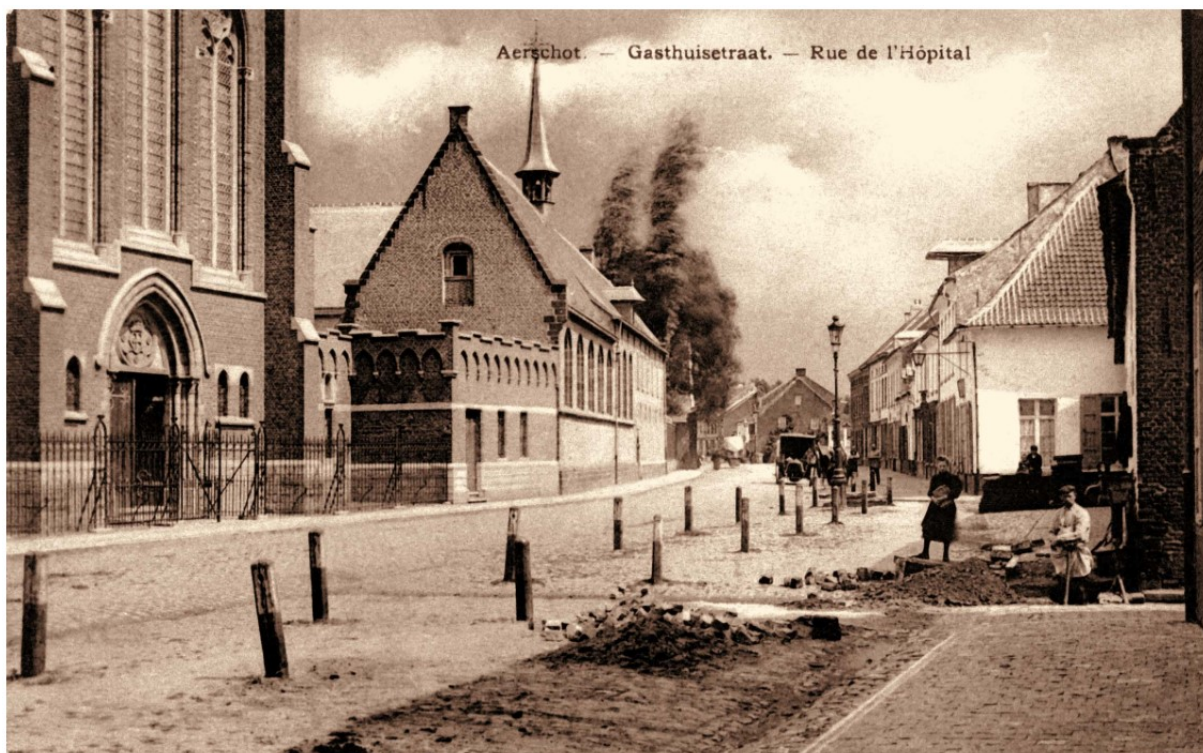
Figuur 7. Oude postkaart van na 1907 waarop de voorgevel van de vleugel in het verlengde van de oude kapel gelijk is gemaakt. De nieuwe neogotische kapel is links zichtbaar. Bron: Leuven, Archief Onroerend Erfgoed.
