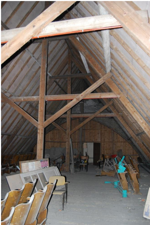
De zolder met rechts nog de makelaar van het nog originele makelaarsspan van het verdwenen tongewelf.
