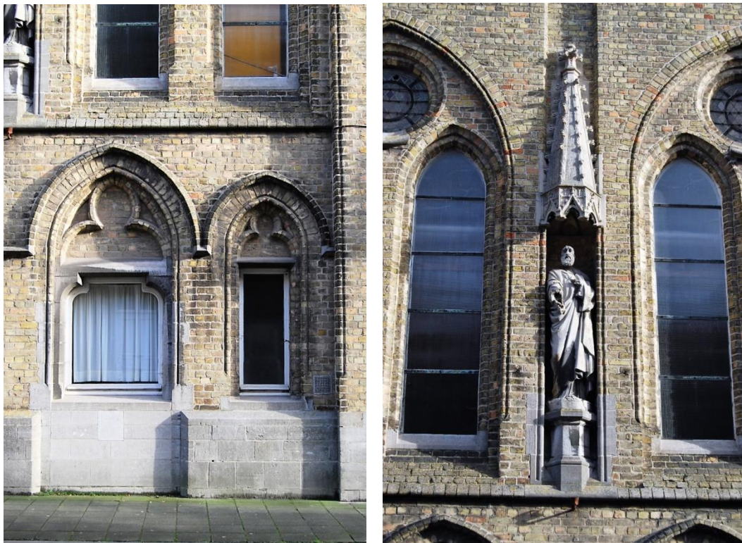
Details voorgevel met links de gedichte deurtravee en het venster. Rechts de beeldnis met het Sint-Jozefbeeld.
