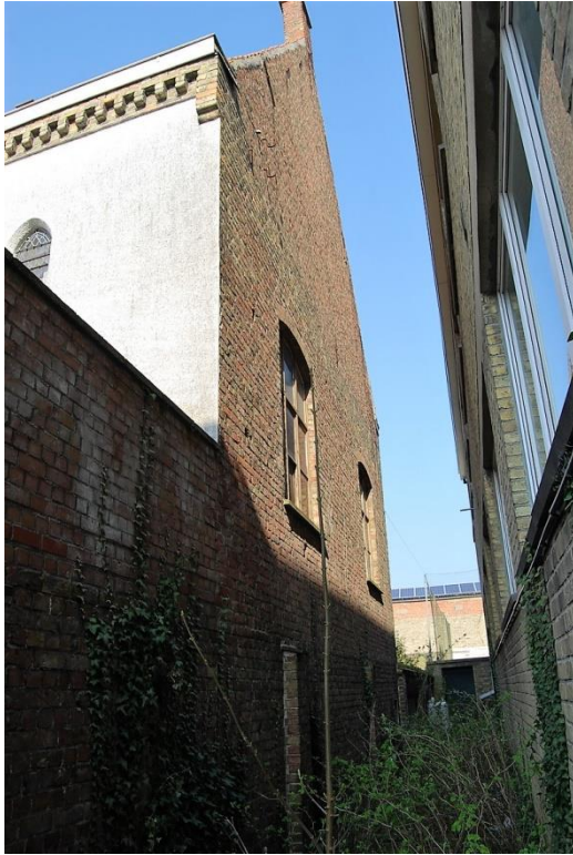
De korte oostgevel. Onderaan het gevelvlak zijn onregelmatig twee steunberen aangebracht.
