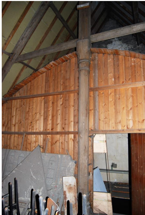
De zolder met rechts nog de makelaar van het nog originele makelaarsspan van het verdwenen tongewelf.
