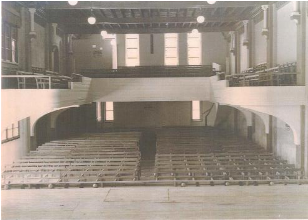
De tribune kort na de voltooiing, 1933. Bemerkt de twee ramen in de 4 de travee van de zuidmuur.
