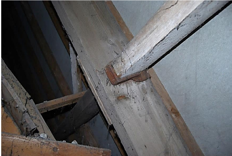
Bevestiging van de gordingbalken aan de kepers van het nog oorspronkelijke spant door middel van smeedijzeren beugels.
