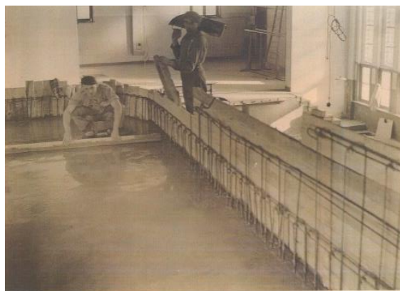
De constructie van de betonnen tribune van gewapend beton (fotoarchief ACV).
