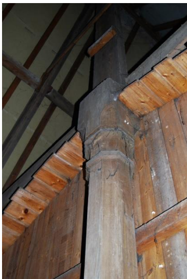
Links: het kapiteel van de makelaar; rechts de verbinding van moerbalk(1) met het spantbeen (2) en de kinderbalk (3).
