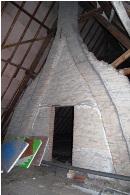
Scheidingsmuur op de zolder met de schoorsteenpijpen opgetrokken bij de wederopbouw. Zicht van de oostelijke zijde (links) en de westelijke zijde (rechts) van de muur.
