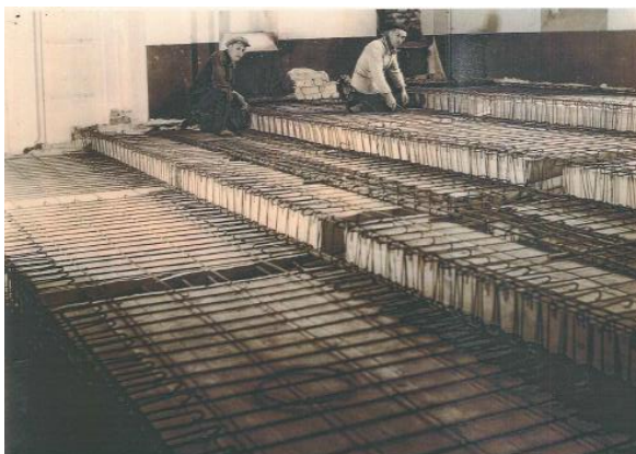
De constructie van de betonnen tribune van gewapend beton (fotoarchief ACV).
