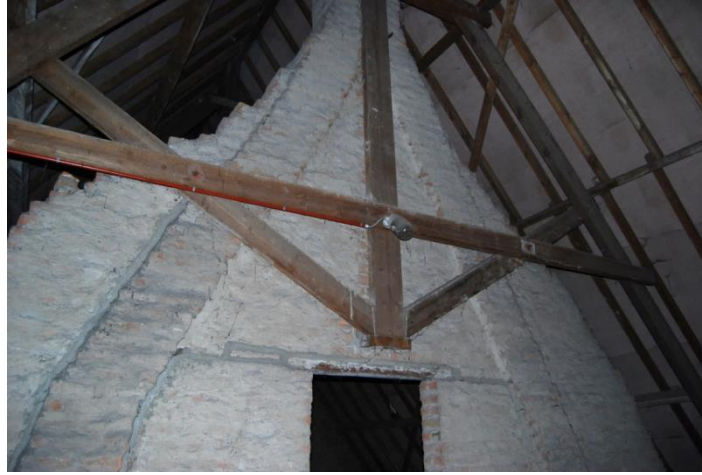
Scheidingsmuur op de zolder met de schoorsteenpijpen opgetrokken bij de wederopbouw. Zicht van de oostelijke zijde (links) en de westelijke zijde (rechts) van de muur.
