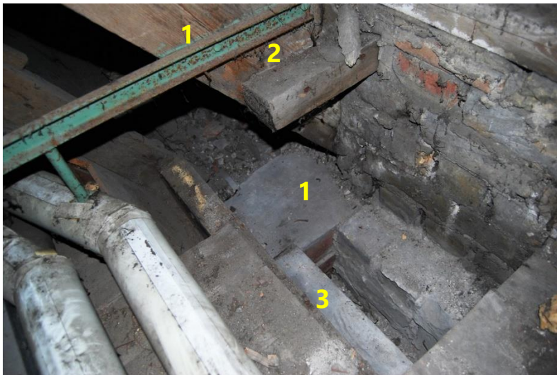
Links: het kapiteel van de makelaar; rechts de verbinding van moerbalk(1) met het spantbeen (2) en de kinderbalk (3).
