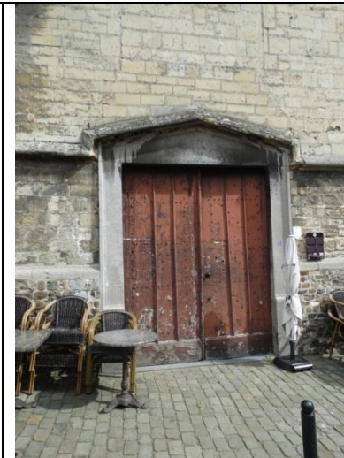
Toegangsdeur en portaal
