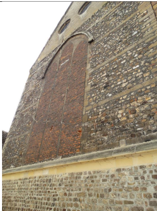
Buitenmuur koorzijde (oost)
