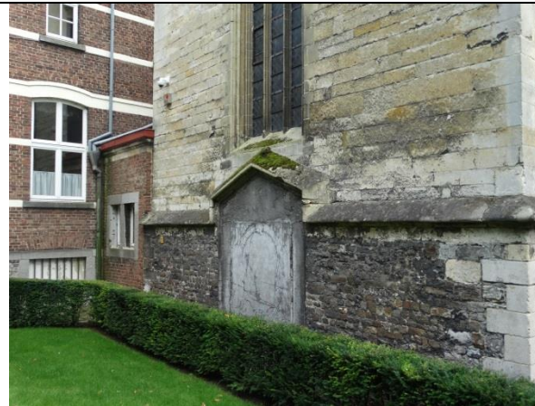
Buitenmuur transept noord met dichtgemaakte toegang naar het voormalige kerkhof
