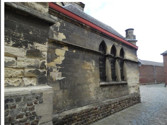
Sacristie zuid (binnenzijde en buitenzijde)
