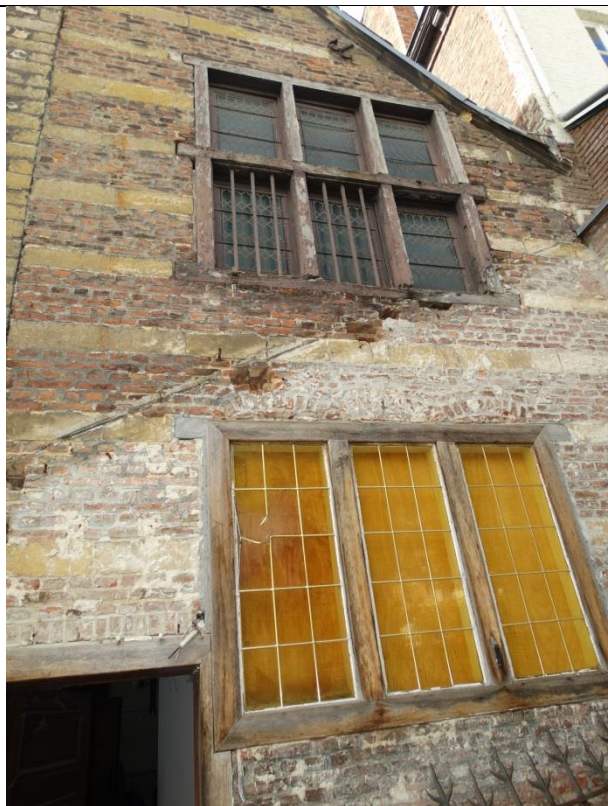
Buitenmuur ruimte zolder boven noordsacristie
