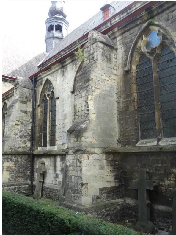
Buitenzijde (noord) met ramen en steunberen
