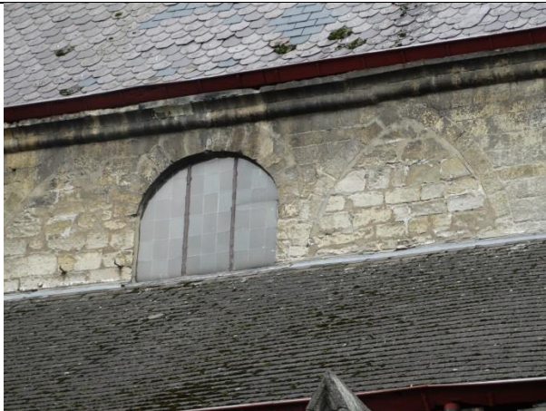
Gotisch raamprofiel (dichtgemaakt)
