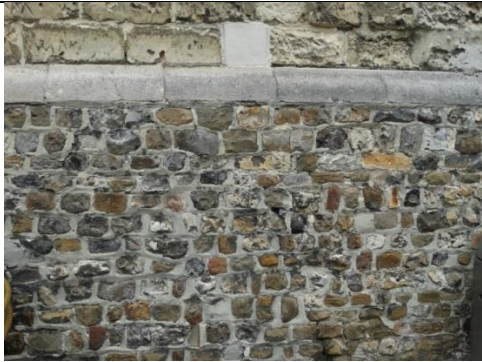
Basis westgevel (naast hoofdportaal)
