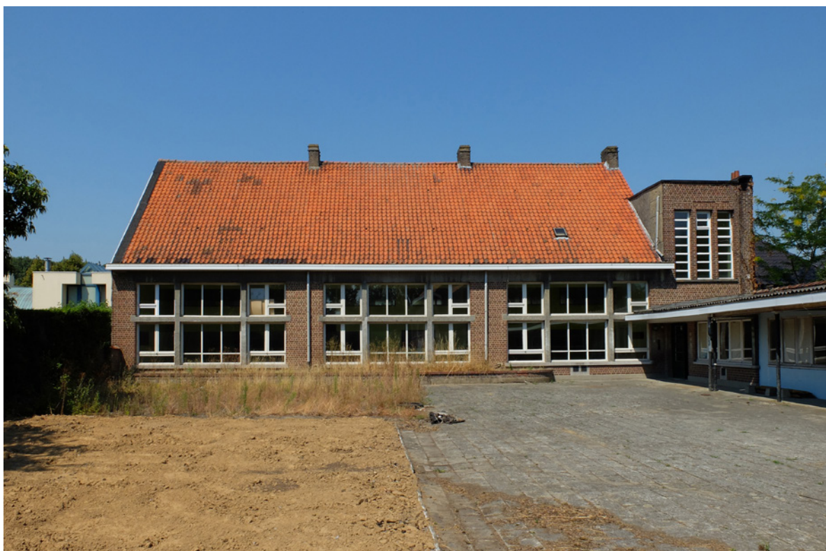
FOTO 7 Achtergevel beschermd monument
