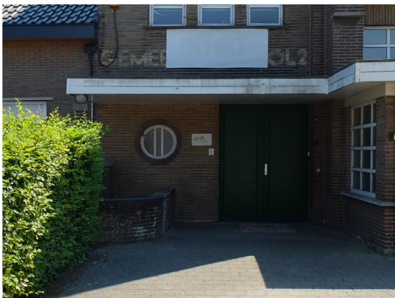
Massieve voordeur in plaats van beglaasde deur en wijzigingen aan de verdeling van het schrijnwerk van het ronde raam.
