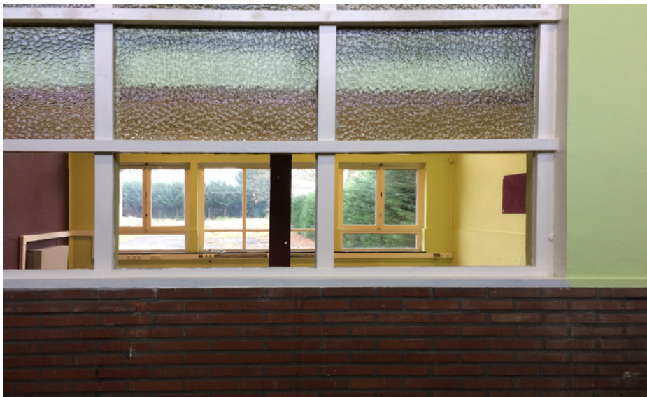
Huidige toestand van het binnenschrijnwerk tussen klaslokalen en gang.
