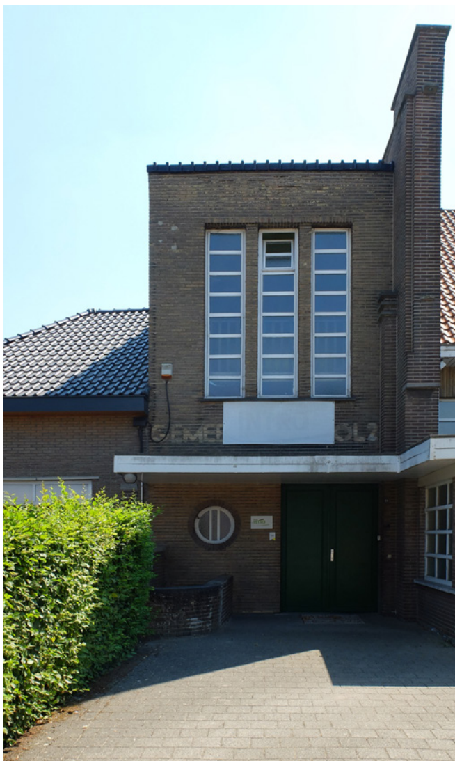
FOTO 3 Inkom schoolgebouw en volume traphal
