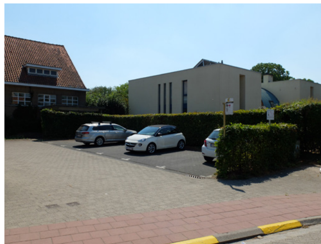
FOTO 4 Bestaande parking met oprit
