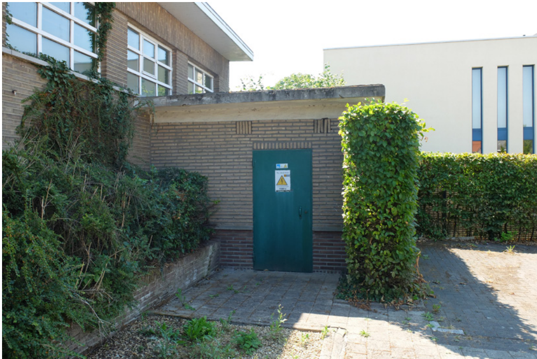
Aanbouw elektriciteitscabine tegen voorgevel
