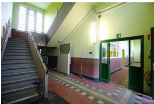
Deur en lichte wand breekt afgeronde hoek en lambrisering in de inkomhal.
