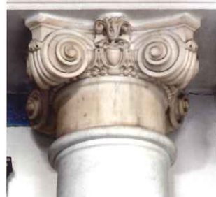
Kapiteel van de voormalige portieken (boven) en van de voormalige koorafsluiting (onder)
