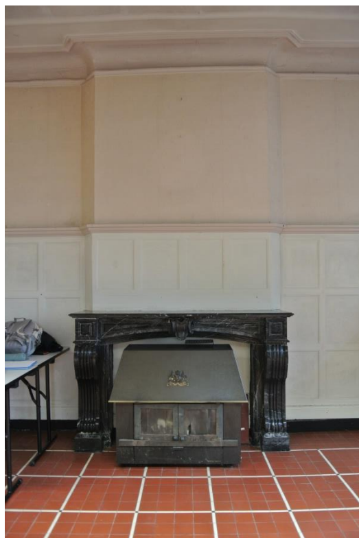
Figuur 66 (links): Detail raam met opgebouwde spanjolet uit smeedijzer Figuur 67 (rechts): Schouw in Belgisch blauw marmer op de gelijkvloerse verdieping
