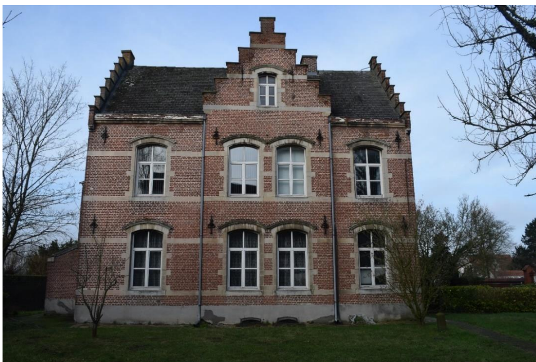
Figuur 13: Zijgevel van het nieuwbouwvolume uit 1892
