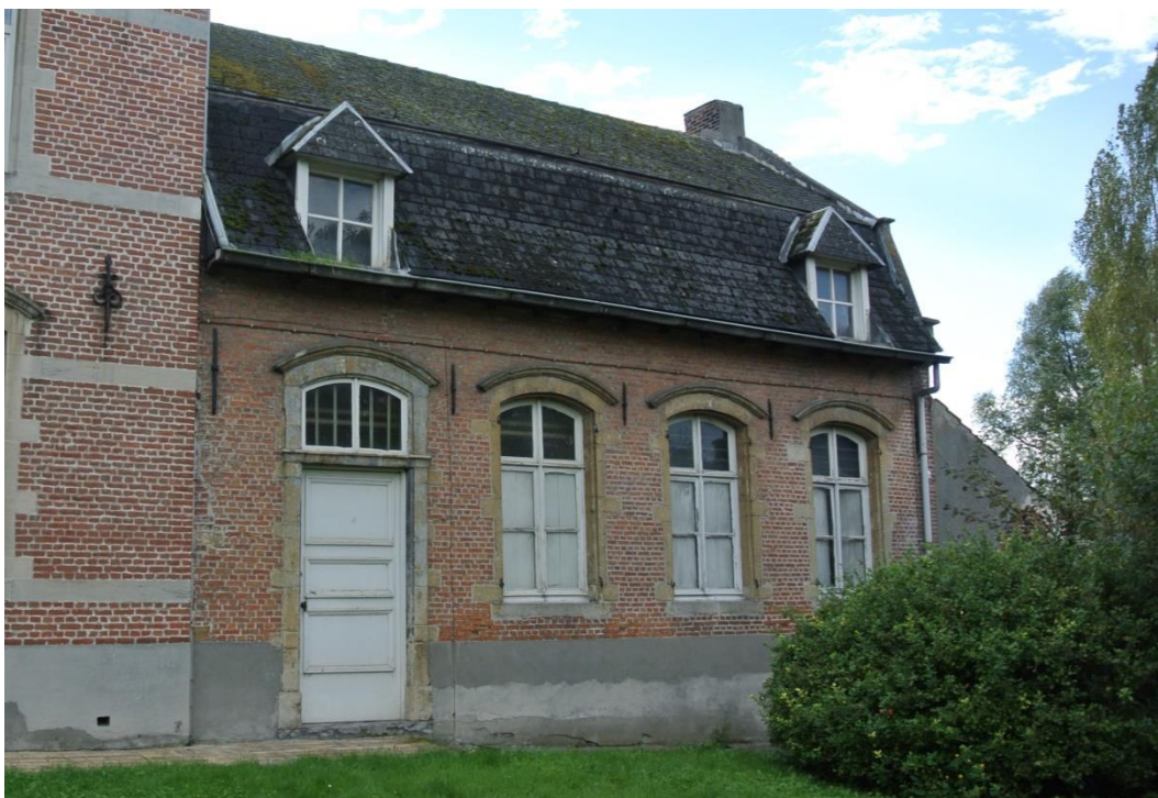
Figuur 50: Oudste bouwdeel uit 1745 met mansardedak
