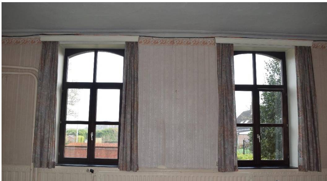
Figuur 34: Schrijnwerk uit de jaren '80: interieurzijde
