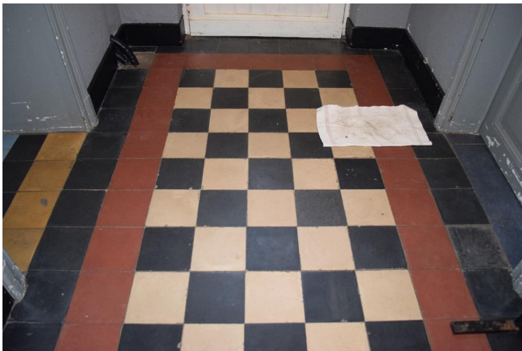
Figuur 14: 19 de -eeuwse cementtegelvloer in de gang op de gelijkvloerse verdieping
