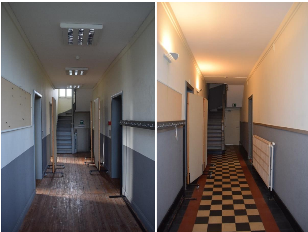
Figuur 37 (links): De gang van de eerste verdieping, herschilderd en met opnieuw blootgelegde plankenvloer
