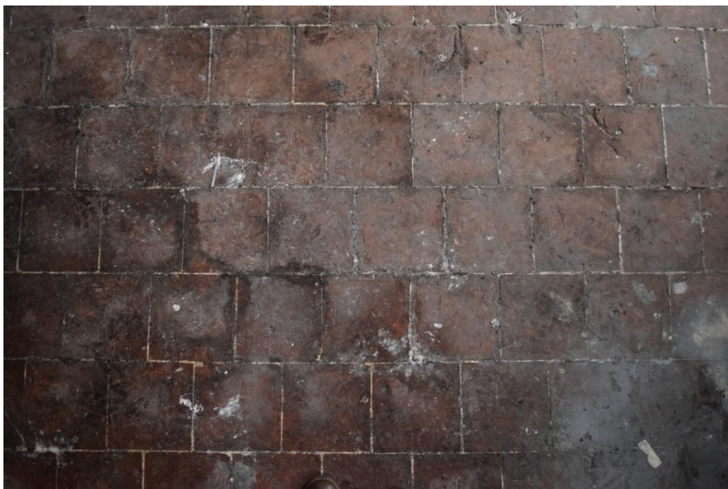
Figuur 53: Vloer in Boomse aardewerktegels van 14.3 x 14.3 cm
