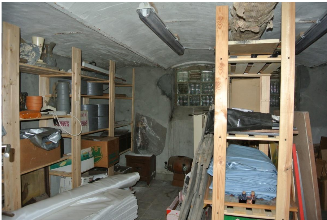
Figuur 81: Troggewelven op stalen liggers in de kelders
