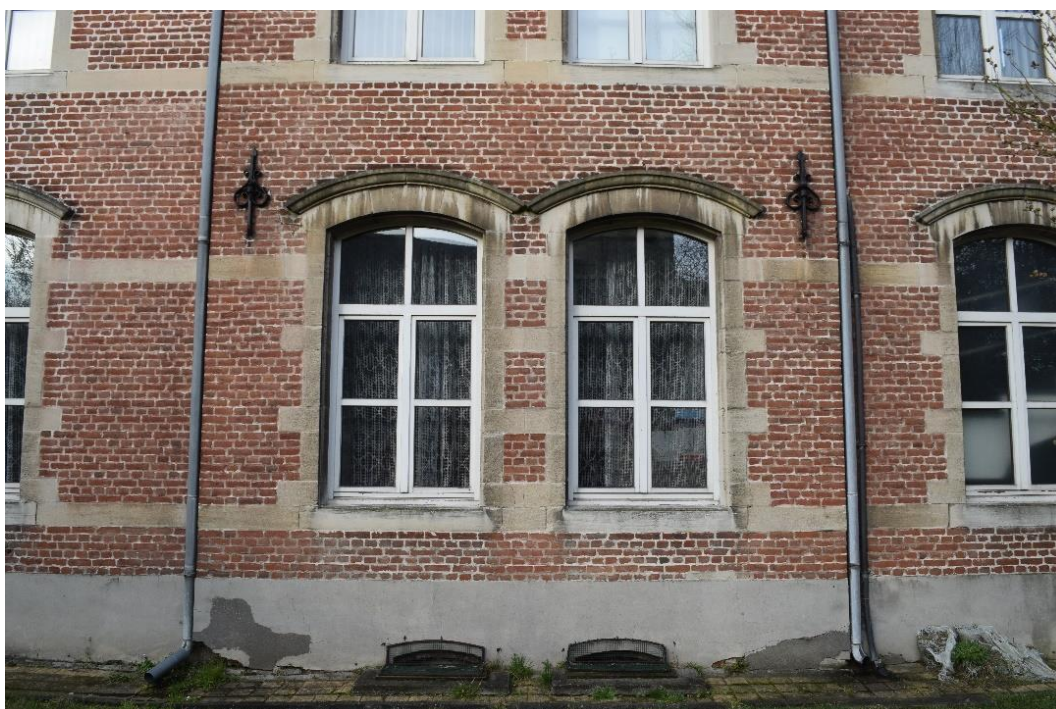
Figuur 35: Het schrijnwerk uit de jaren '80: exterieurzijde
