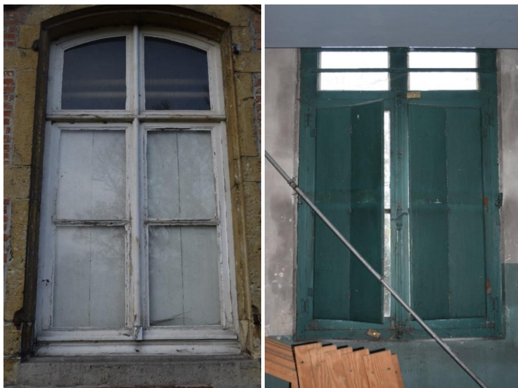
Figuur 58 (links): Schrijnwerk met gesloten binnenluik
