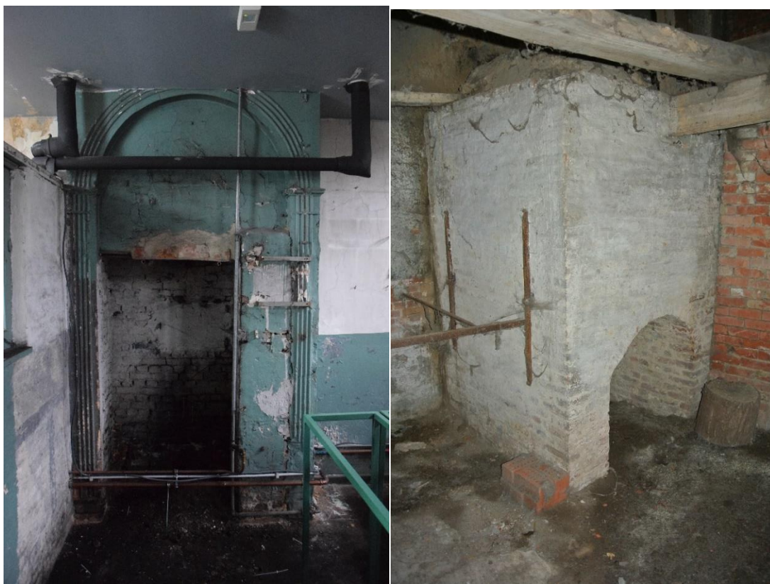
Figuur 54 (links): Haard met dichtgemetselde opening naar de bakoven
