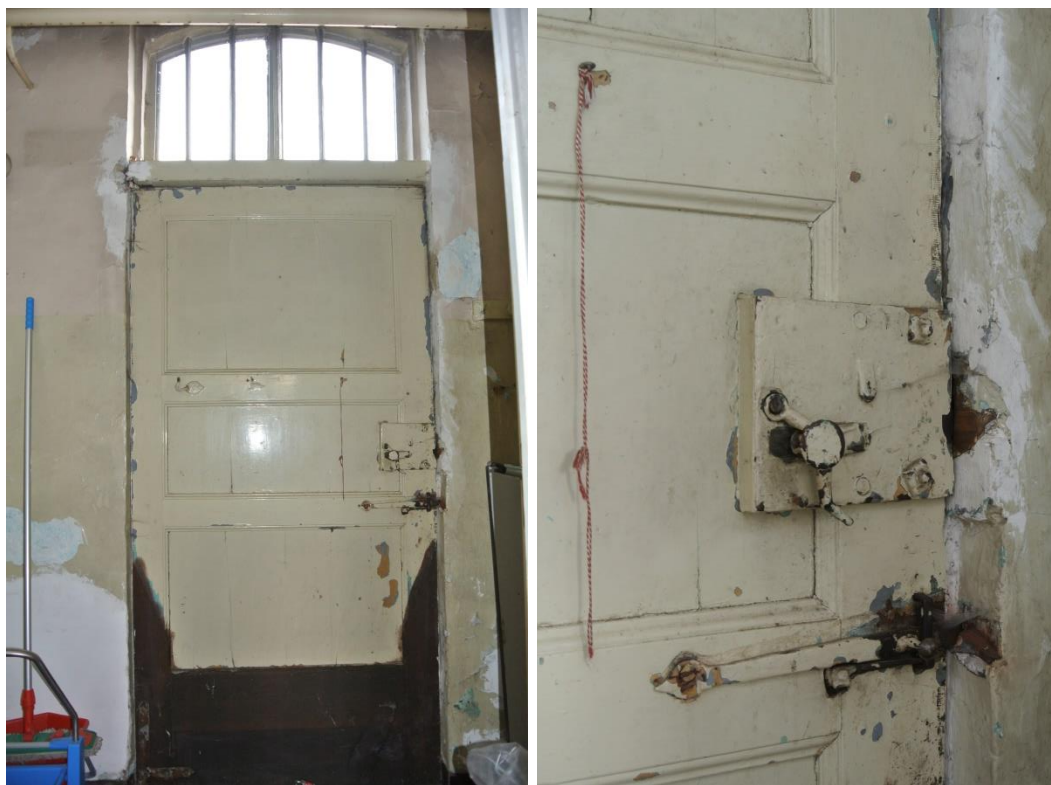
Figuur 56 (links): Achttiende-eeuwse voordeur met deurbeslag en tralie in bovenlicht
