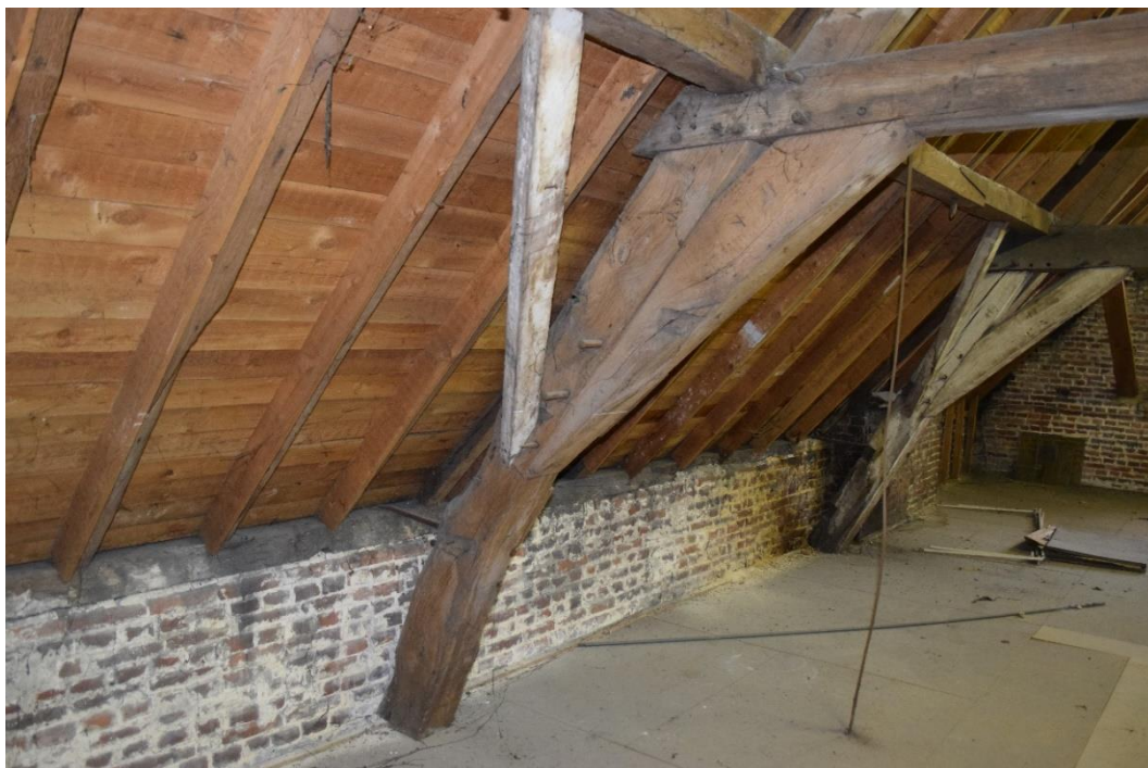
Figuur 69: 18 de -eeuwse dakconstructie in het volume van 1760
