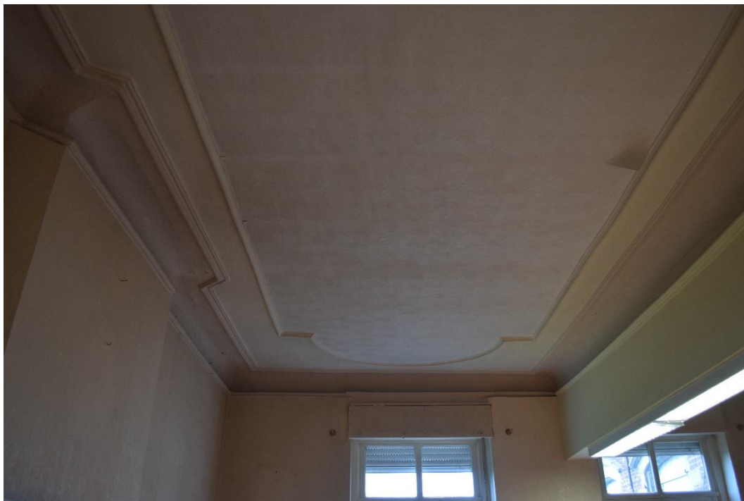
Figuur 63: 18 de -eeuws stucwerkplafond in het groot salon op de gelijkvloerse verdieping met keellijst
