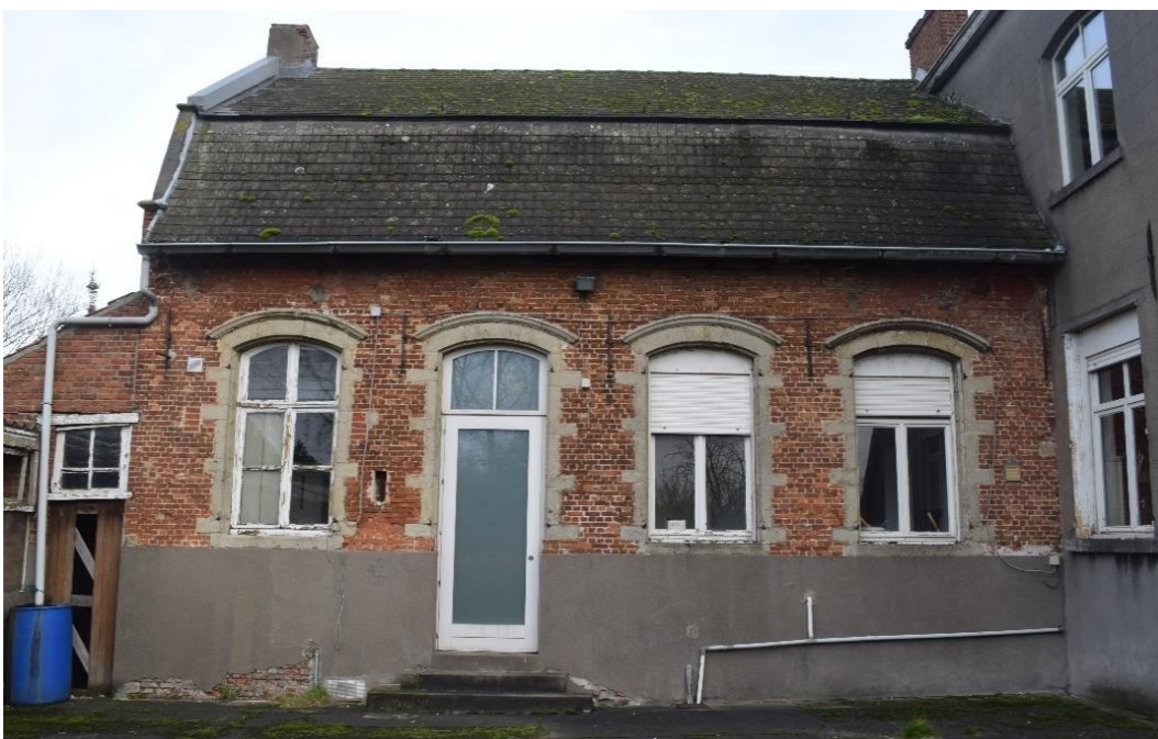
Figuur 51: Achtergevel van het bouwdeel uit 1745
