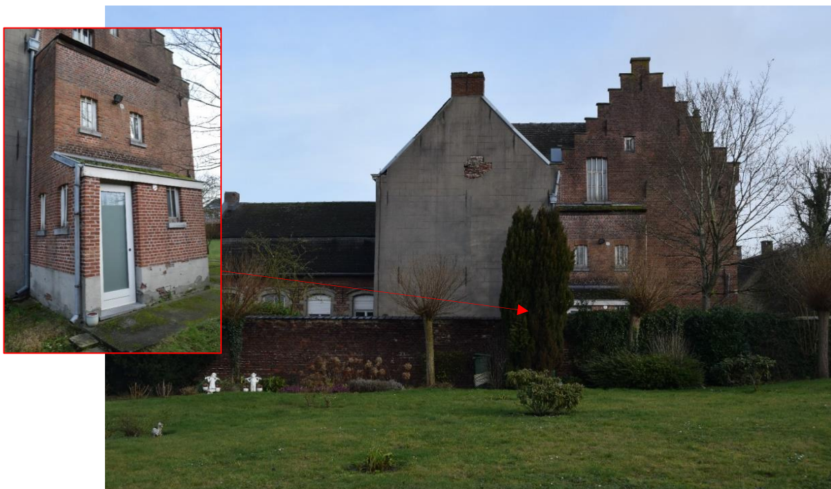
Figuur 16: Achtergevel van de pastorie met sanitair blok
