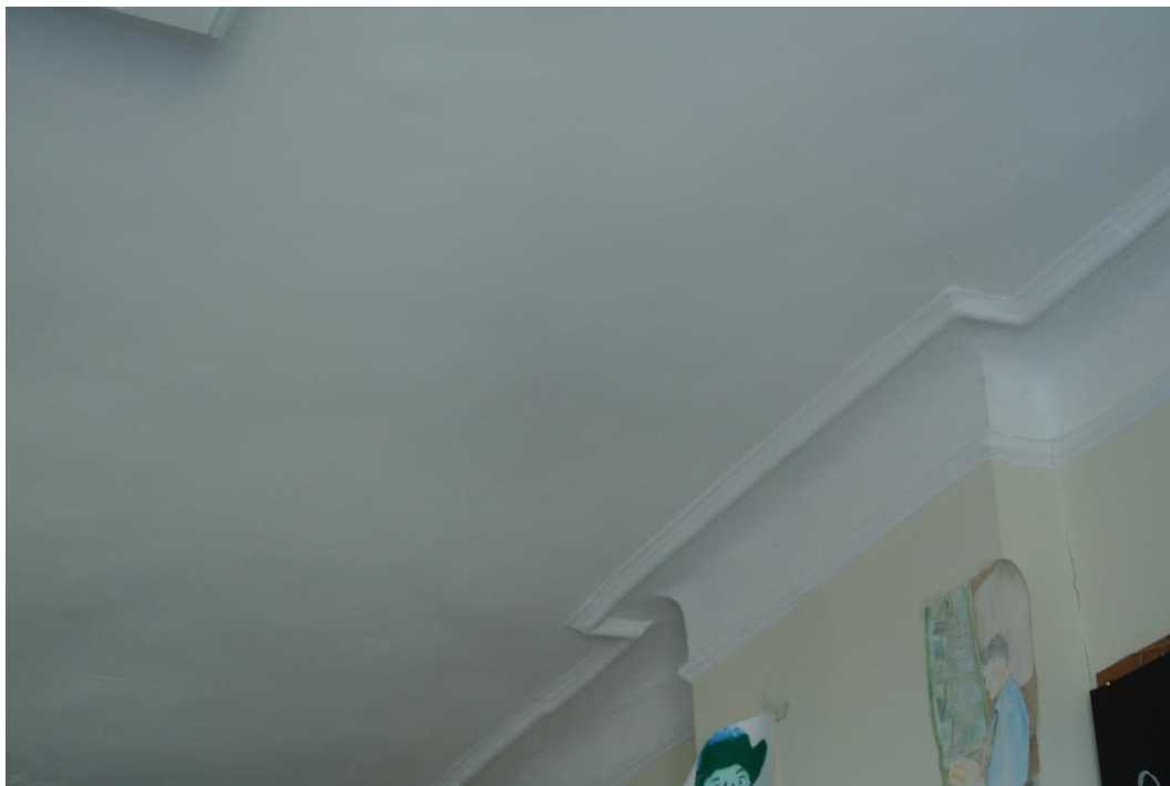
Figuur 65: Detail keellijst op de eerste verdieping
