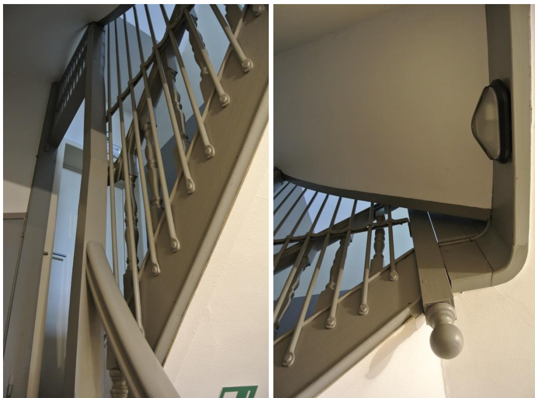
Figuur 74 (links): Detail hekwerk trap, oorspronkelijk was dit voorzien van een traliedeurtje die de trap volledig afsloot (duimen uiterst links nog te zien in de omlijsting)
