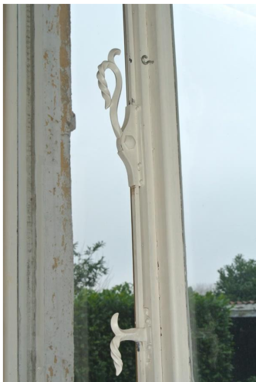
Figuur 66 (links): Detail raam met opgebouwde spanjolet uit smeedijzer Figuur 67 (rechts): Schouw in Belgisch blauw marmer op de gelijkvloerse verdieping
