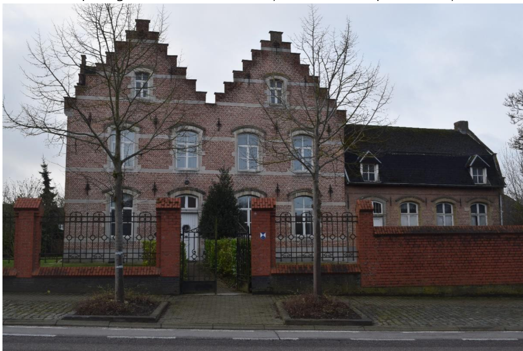
Figuur 1: Voorgevel van de pastorie
