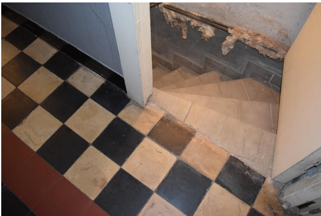
Figuur 32: De keldertrap van kelder 2
