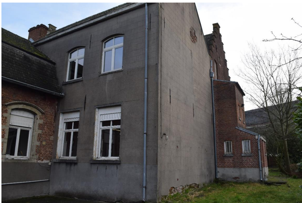
Figuur 49: Bouwdeel uit 1760 met cementbepleistering
