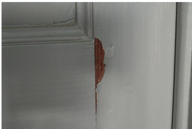
Figuur 76: Detail beschadigd schilderwerk met eronder imitatiehoutschildering
