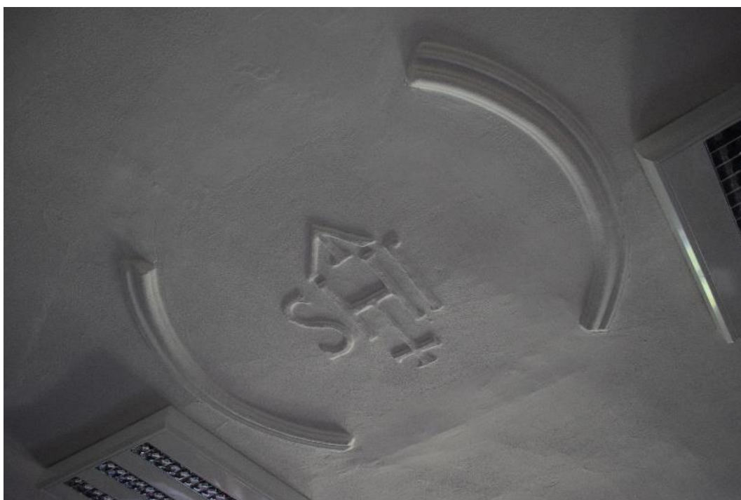
Figuur 64: 18 de -eeuws stucwerkplafond op de eerste verdieping met IHS-monogram
