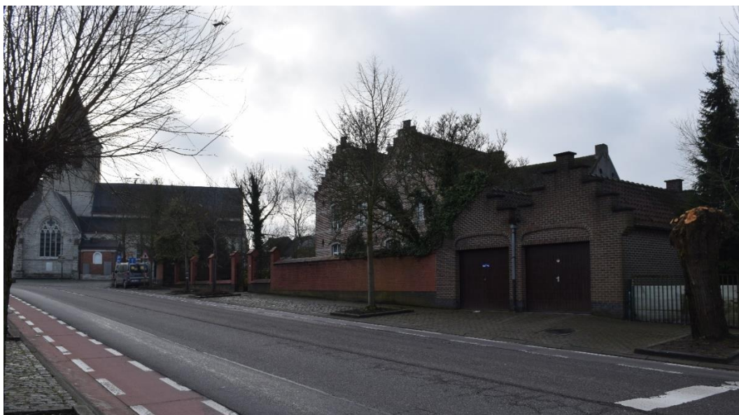
Figuur 30: De omheiningsmuur en garages uit 1981
