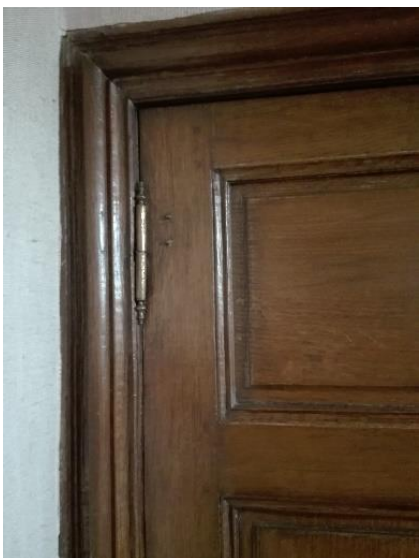
Paneeldeuren in eik met koperen scharnieren (foto WDZ 2018)
