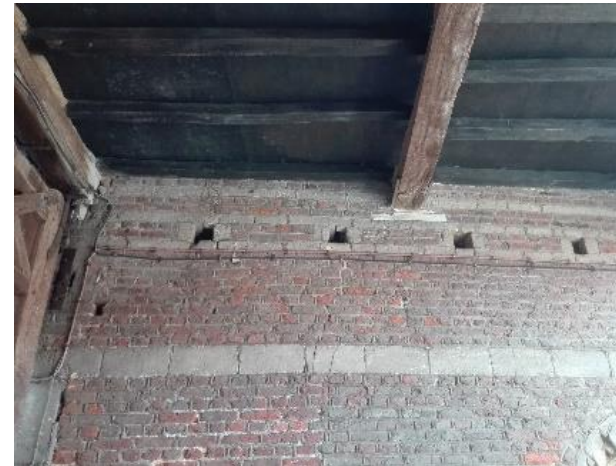
Steigergaten onder poorttoren
