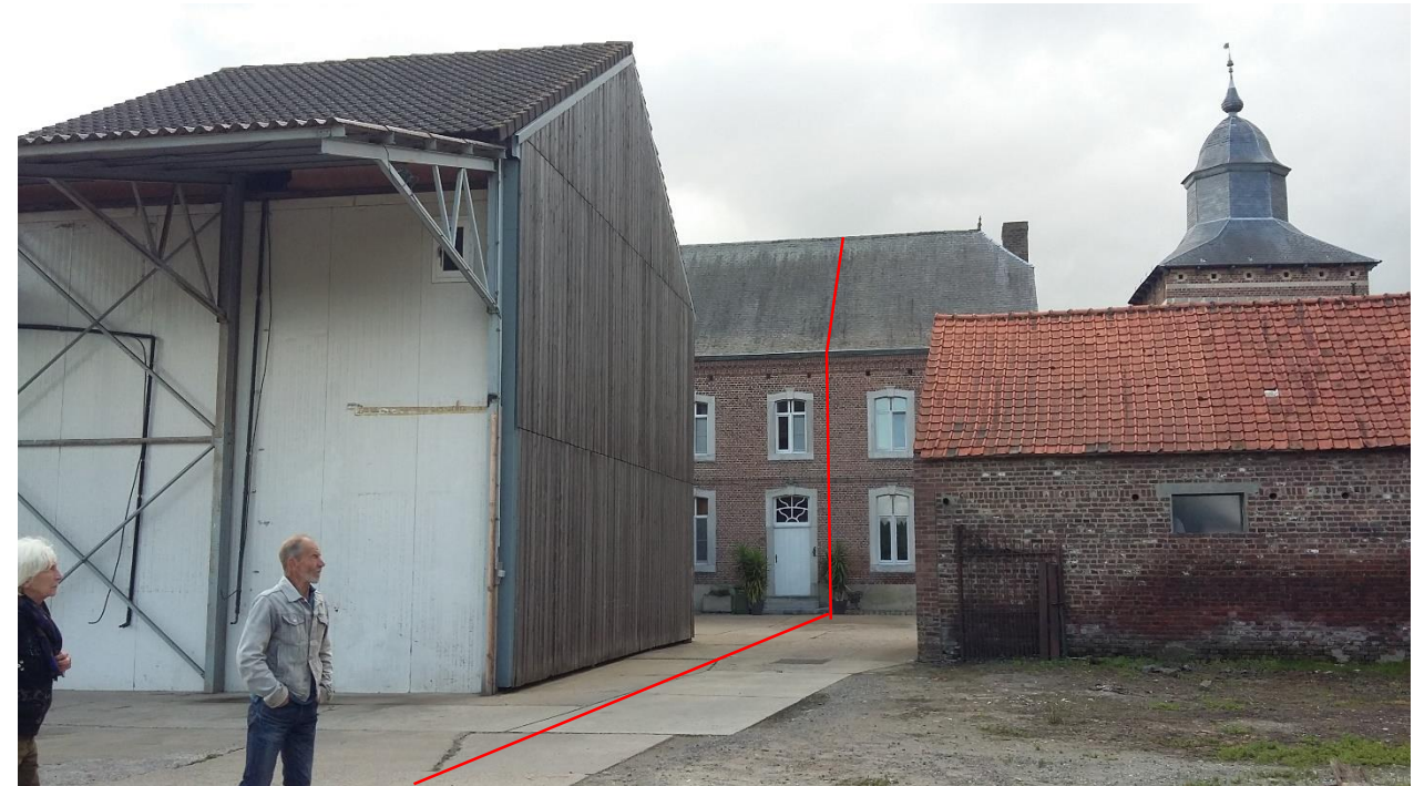
Achterzijde site: rechts stalvleugel uit jaren 1950, links landbouwloods van ca. 1998. De rode lijn geeft de opsplitsing weer in de percelering en eigendom.
