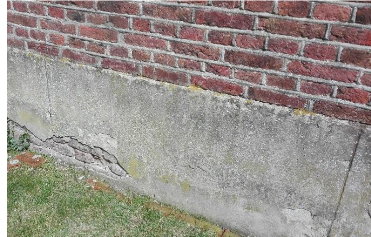
Plint in cementpleister 2018 (WDZ)
