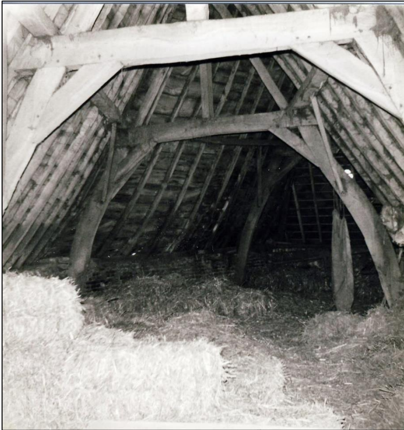
Reeks dekbalkjukken of schaargebinten van de stallen 1665. De spantbenen kort bij de draagmuur zijn steviger dan de ankerbalkjukken bij vakwerkgebouwen. Zwart-witfoto 1973 (WDZ)
