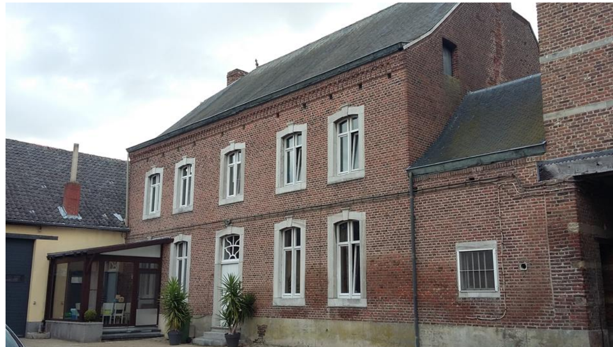
Erfgevel woonhuis nu, met recent aangebouwde veranda. Voor deze veranda heeft de eigenaar in 2015 stedenbouwkundig een regularisatie aangevraagd, maar niet verkregen
