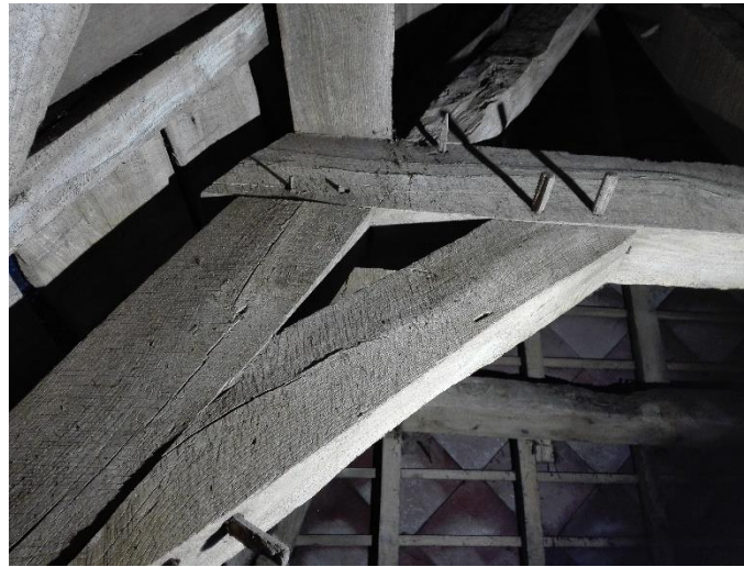
Reeks dekbalkjukken of schaargebinten van de stallen 1665. De spantbenen kort bij de draagmuur zijn steviger dan de ankerbalkjukken bij vakwerkgebouwen. Zwart-witfoto 1973 (WDZ)
