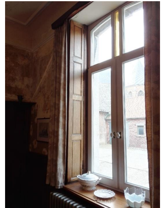
Recent vernieuwd raamschrijnwerk erfgevel, ontwerp De Wyngaert 2018 (WDZ)
