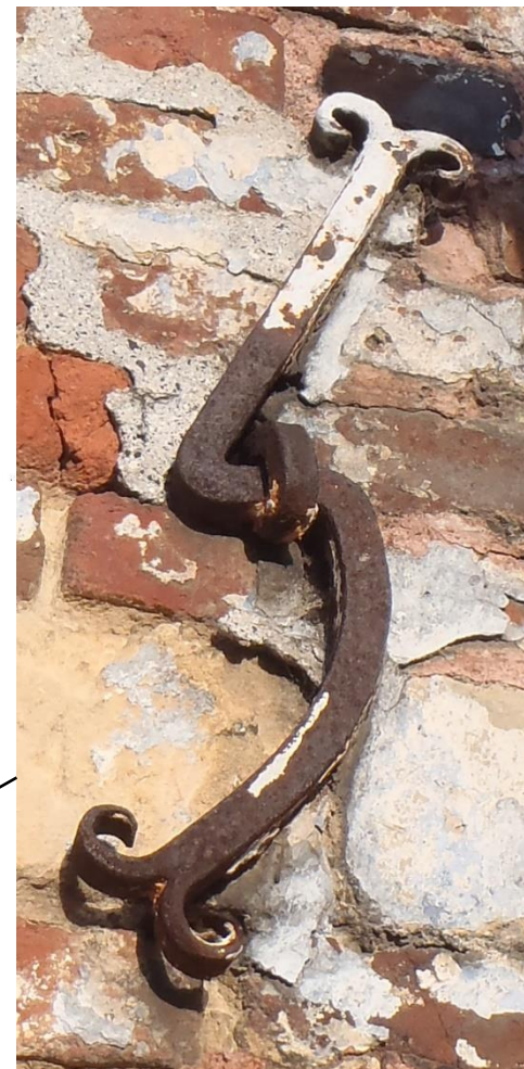
Smeedijzeren muuranker, cijfer 5
