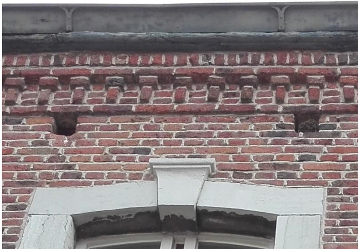
Baksteenfries met afwisseling van kopse en strekse lagen, dropmotief. Steigergaten erfzijde
