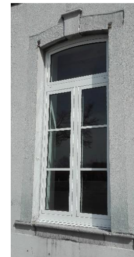
Boven: begaardenklooster Zepperen 1780, met geprofileerde dorpel en luikenspoor. Geen sponning nochtans
