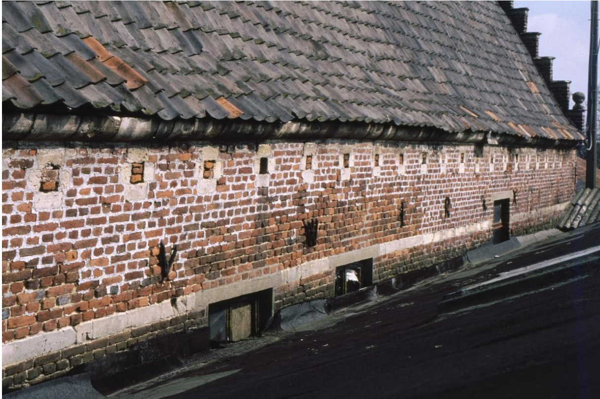
1999: reeks muurankers vormt de naam OVWERCX westgevel stallingen (WDZ)
