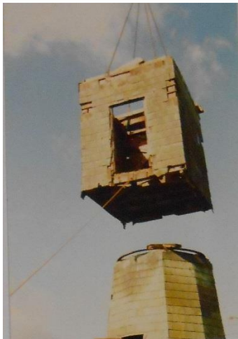
Het wegnemen van de te lichte Molenkast, ca. 1994 (© Peel).
