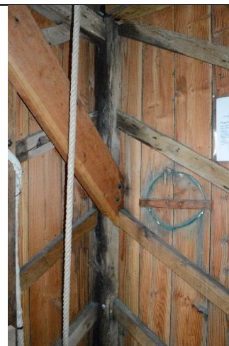
Hoek staartzijde – steenzijde met beluikt kijkgat
