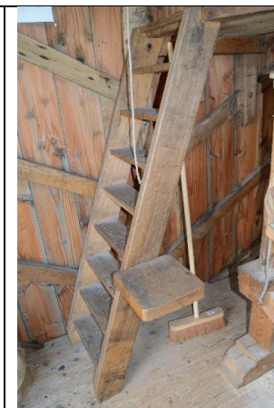
Steenzijde met molentrap ter bevoorrading van de graantremel van molentafel.
