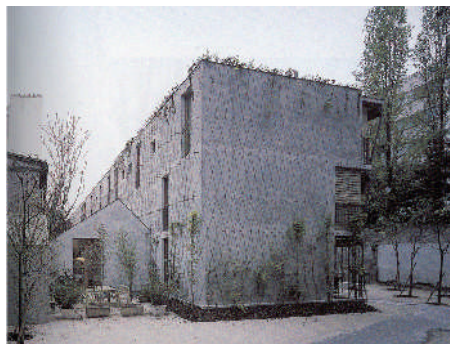
REFERENTIEPROJECT, APPARTEMENTSGEBOUWTE PARIS, HERZOG & DE MEURON
