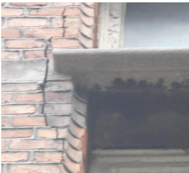
Westgevel van de oostvleugel: eerste verdieping raam gang
