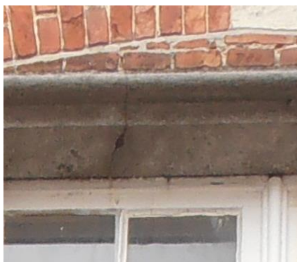
Westgevel begane grond: raam naast centrale deur
