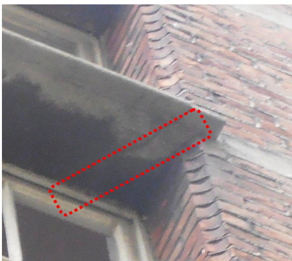
Straatgevel eerste verdieping: raam in kopse gevel vleugel B
