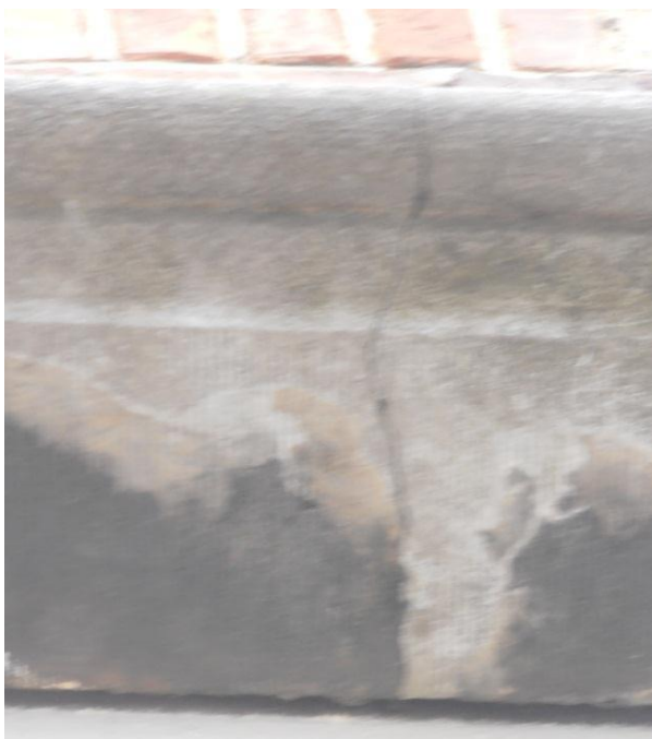
Westgevel begane grond: raam boven centrale deur
