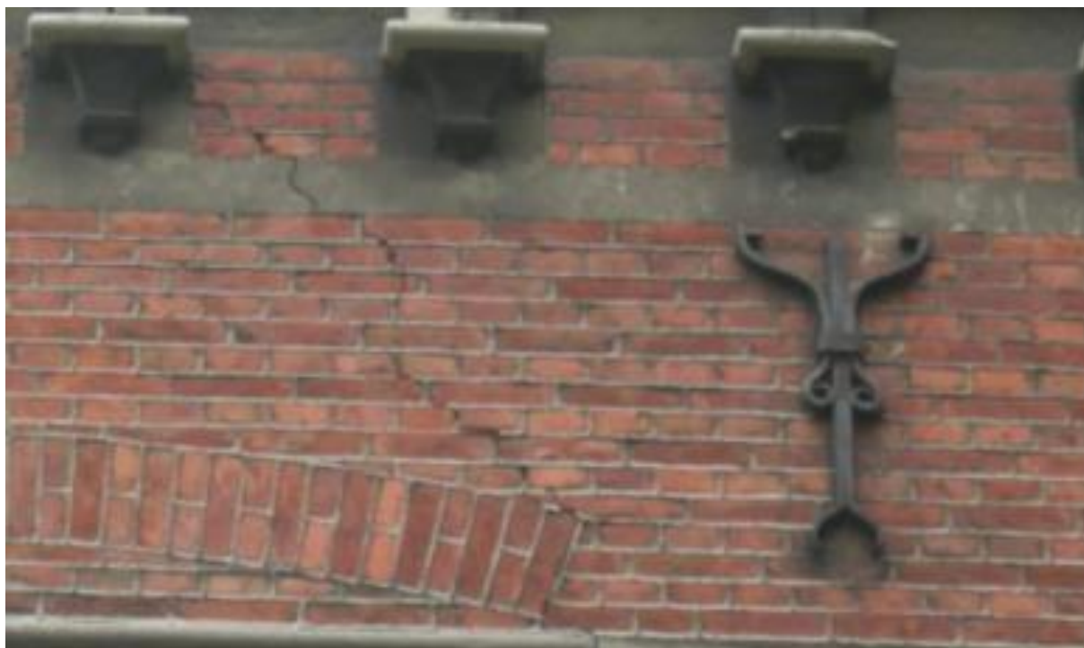
Zuidgevel van de oostgevel: boven raam van de gang op de eerste verdieping
