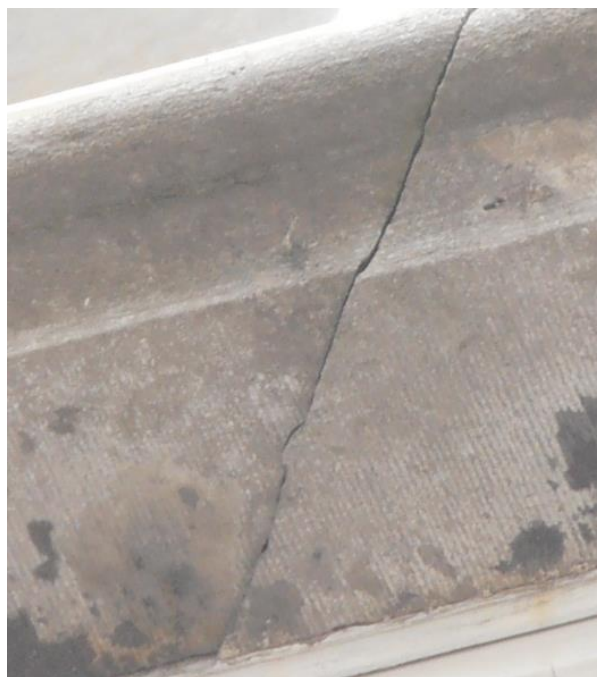
Westgevel eerste verdieping: raam links van centrale as
