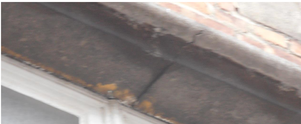
Raam traphal in oostgevel
