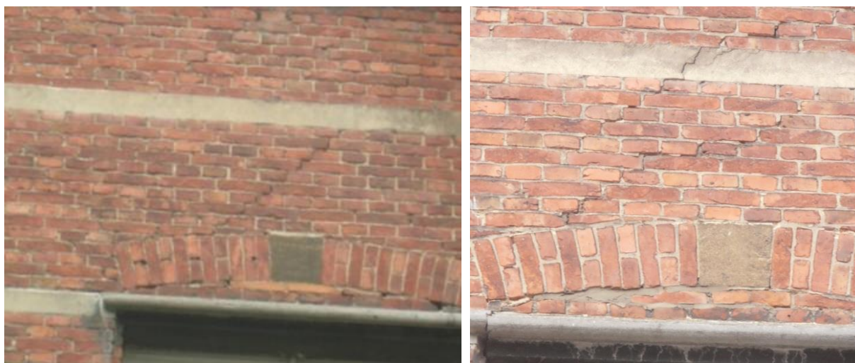
Oostgevel van de oostvleugel: boven twee ramen van de eerste verdieping
