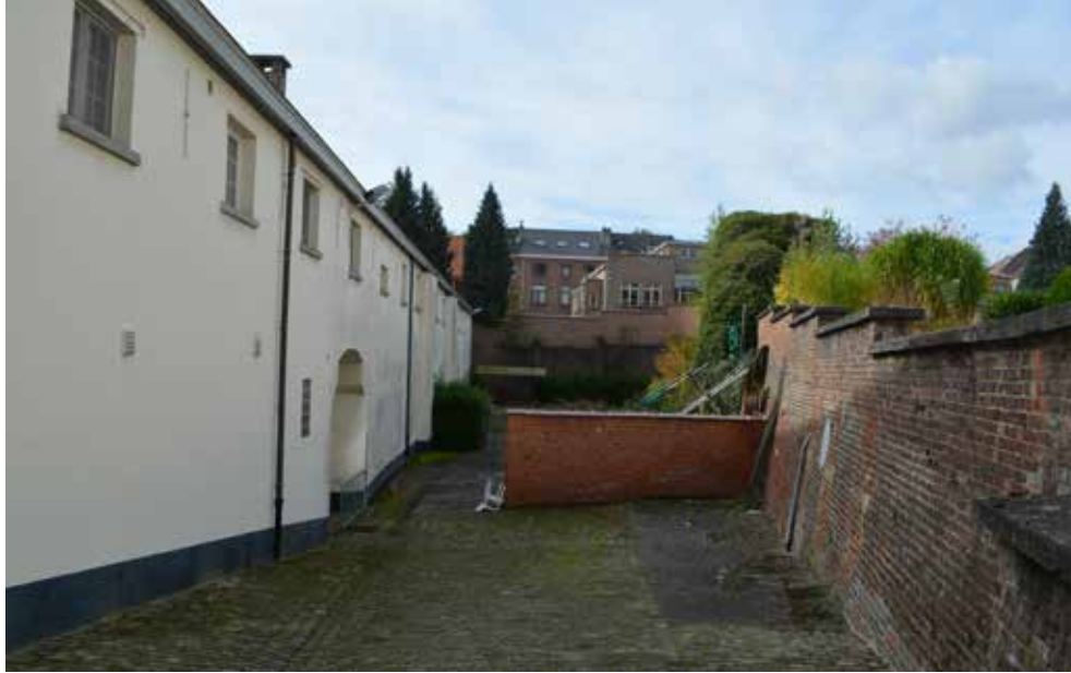
Figuur 210: Achterkant en doorgang oranjerie Kazerne Panquin (Bron: terreinwerk SumResearch)
