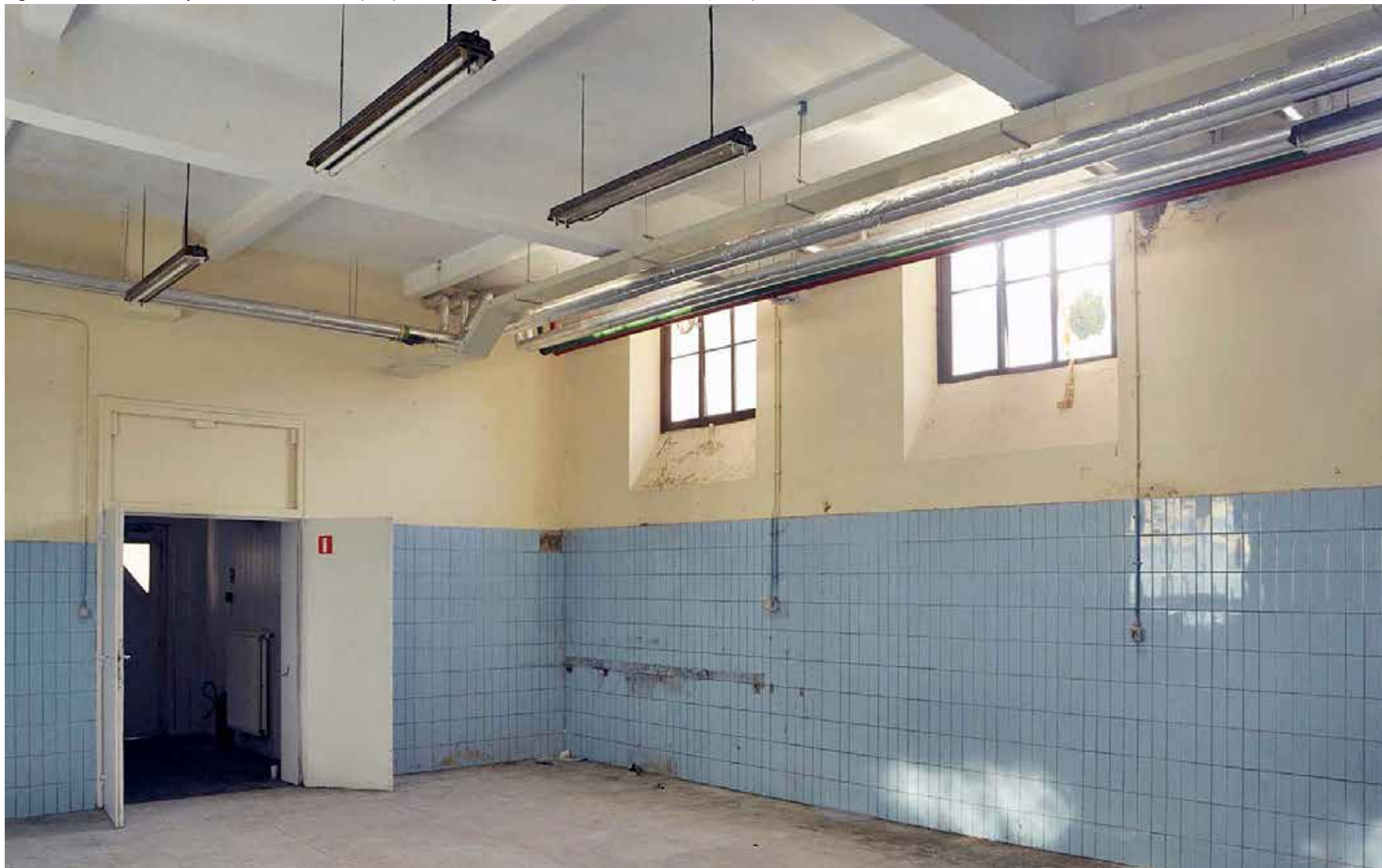
Figuur 211: Interieur orangerie Blok Q Kazerne Panquin (Bron: Stichting Architectuurarchieven - SAVE, 2015)
