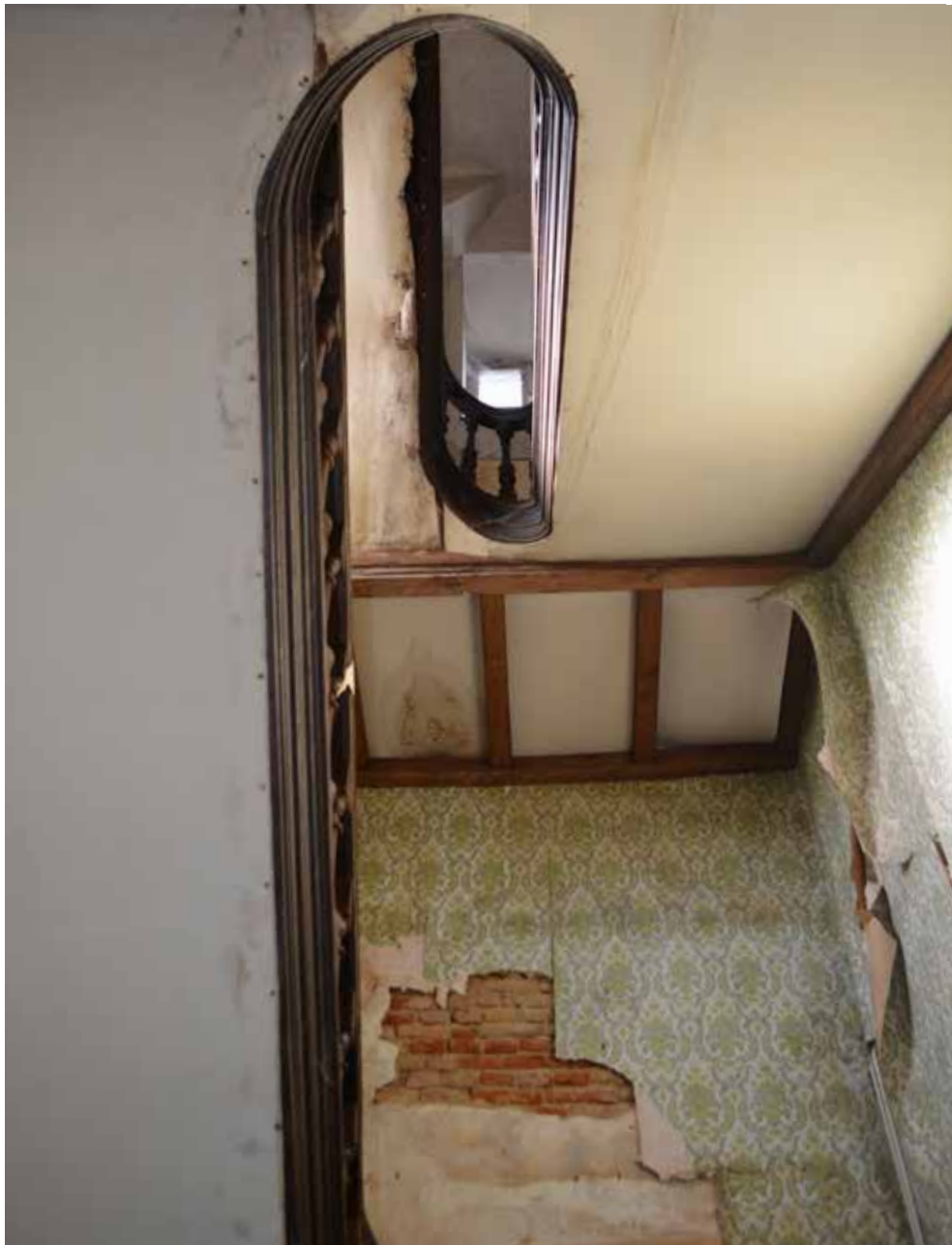
Figuur 167: Trap gelijkvloers - eerste verdieping hoekpaviljoen E-bis (Bron: terreinwerk SumResearch)
