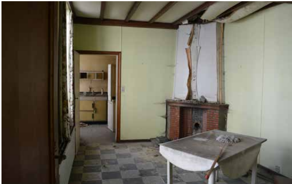
Figuur 156: Leefkamer aanbouw hoekpaviljoen E-bis (Bron: terreinwerk SumResearch)
