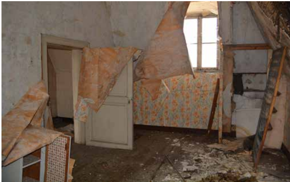
Figuur 177: Kamer J hoekpaviljoen E-bis (Bron: terreinwerk SumResearch )
