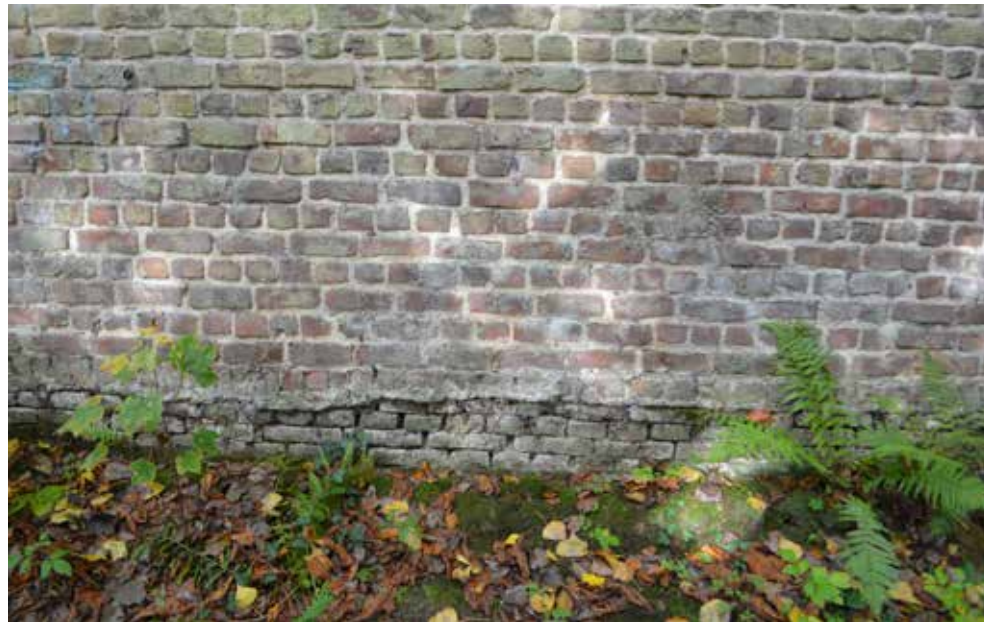
Figuur 99: Impressie parkmuur langsheen Waalse Baan - Constant Derymaekerlaan met aanzienlijke beschadigingen (Bron: terreinwerk SumResearch )
