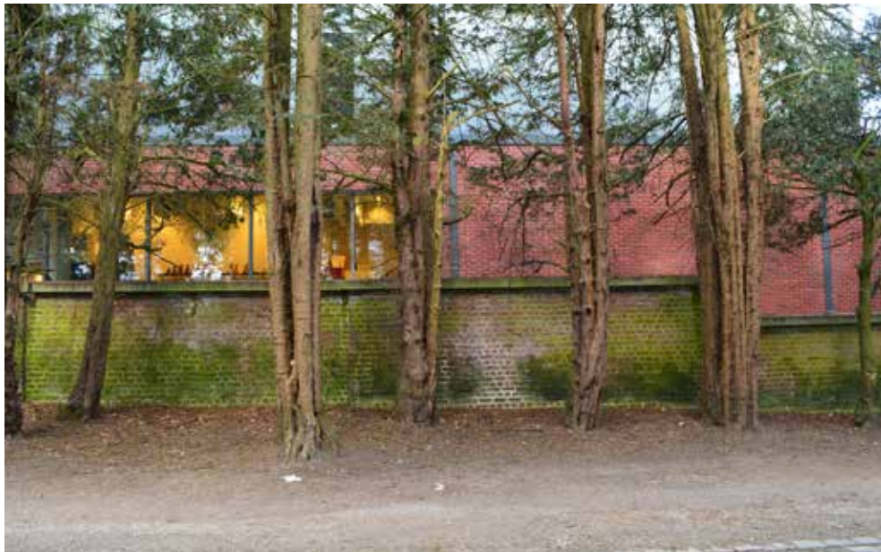
Figuur 149: Impressie muur School van Tervurendreef (Bron: terreinwerk SumResearch)
