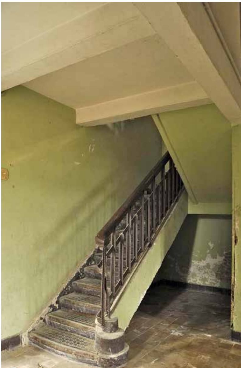
Figuur 233: Interieur Blok Z (Bron: Stichting Architectuurarchieven - SAVE, 2015)
