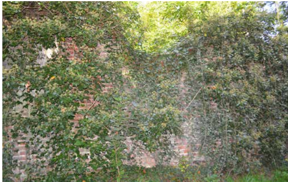
Figuur 100: Impressie parkmuur langsheen Waalse Baan - Constant Derymaekerlaan met aanzienlijke beschadigingen (Bron: terreinwerk SumResearch )
