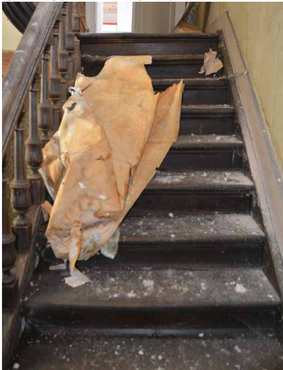
Figuur 168: Trap gelijkvloers - eerste verdieping hoekpaviljoen E-bis (Bron: terreinwerk SumResearch)
