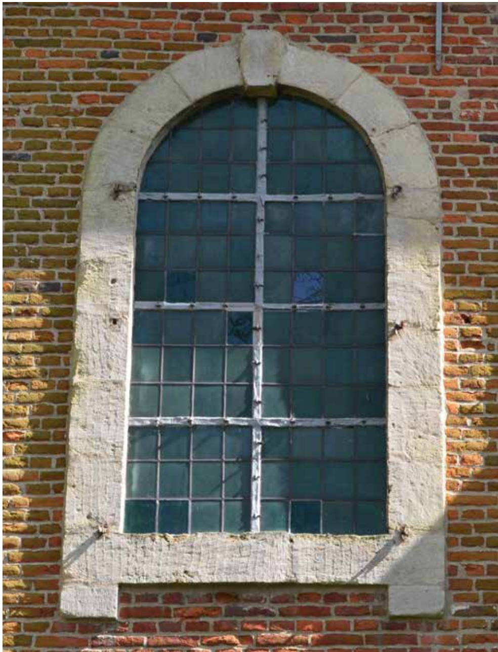
Figuur 266: Raamwerk zijgevel west Sint-Hubertuskapel (Bron: terreinwerk SumResearch)
