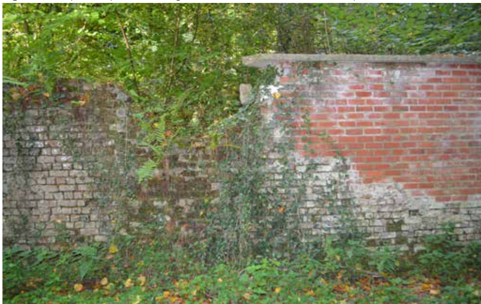
Figuur 98: Impressie parkmuur langsheen Waalse Baan - Constant Derymaeckerlaan met herstellingen en aanzienlijke beschadigingen (Bron: terreinwerk SumResearch )
