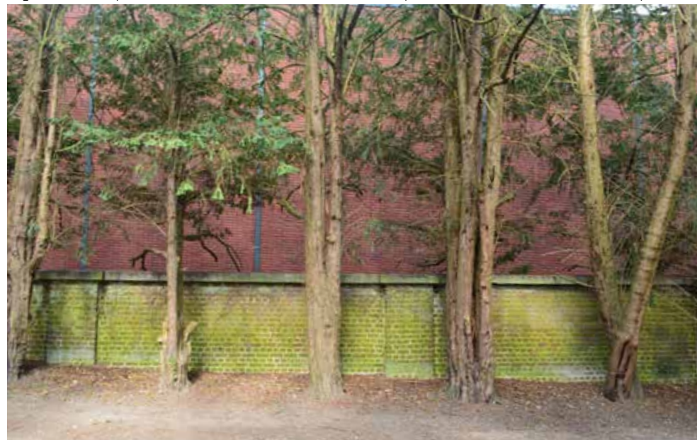
Figuur 148: Impressie muur School van Tervurendreef (Bron: terreinwerk SumResearch)
