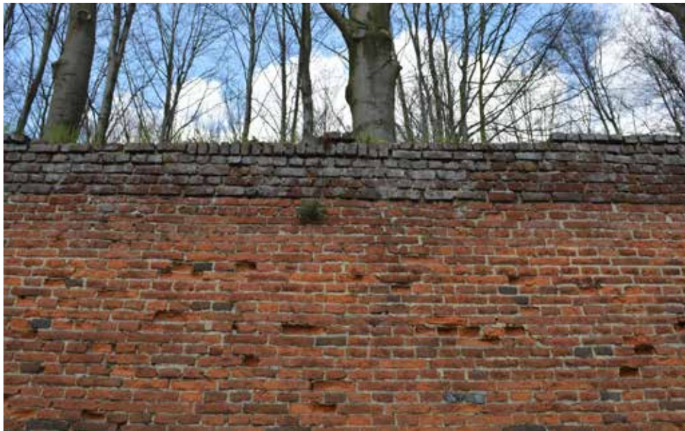
Figuur 124: Details muur langsheen de Duisburgsesteenweg (Bron: terreinwerk SumResearch )
