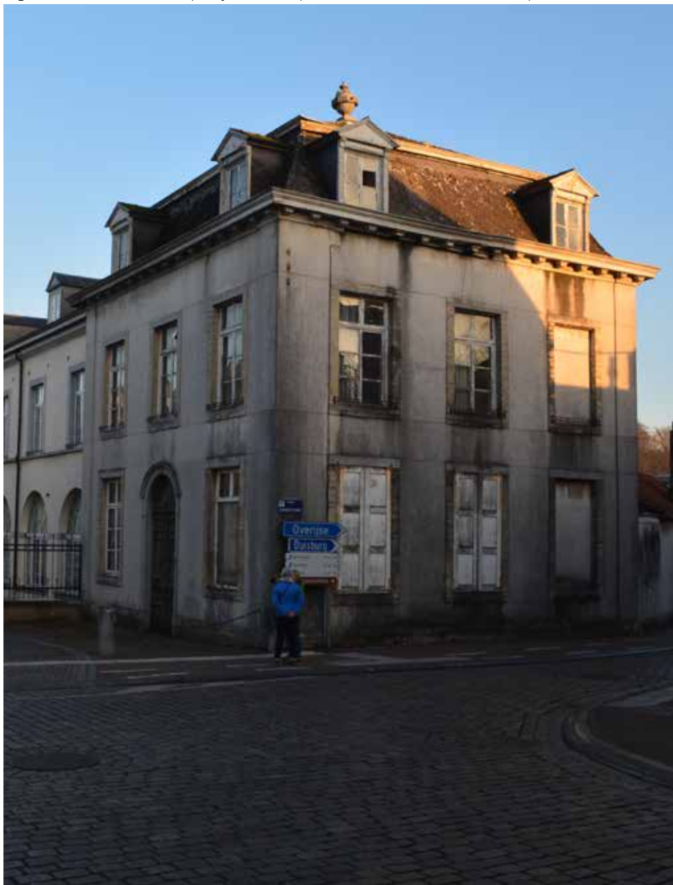
Figuur 154: Extérieur hoekpaviljoen E-bis (Bron: terreinwerk SumResearch)
