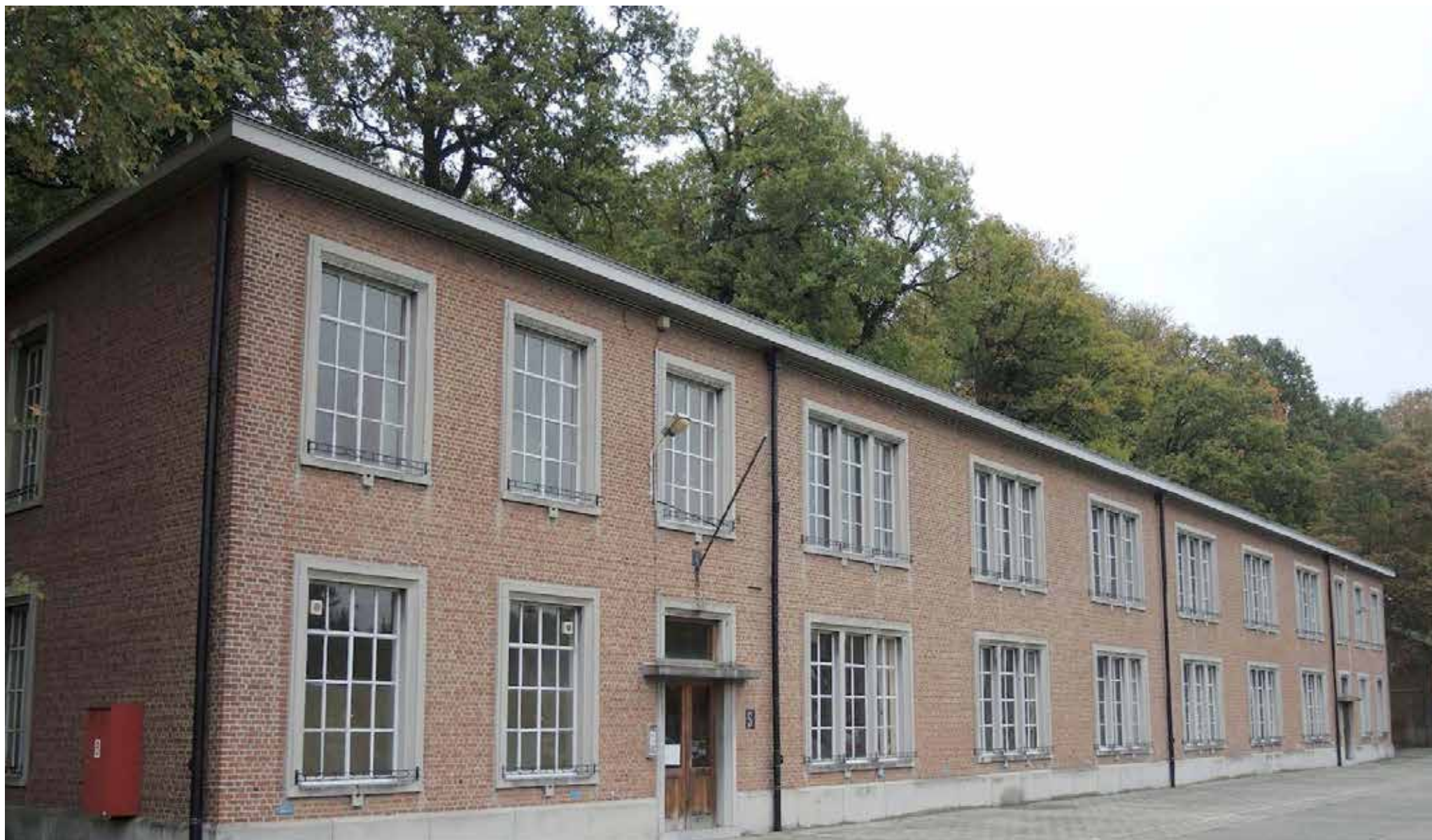
Figuur 220: Extérieur Blok S Kazerne Panquin (Bron: Stichting Architectuurarchieven - SAVE, 2015)
