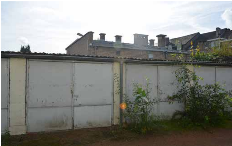
Figuur 214: Garages Kazerne Panquin (Bron: terreinwerk SumResearch)
