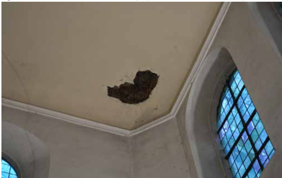
Figuur 278: Schade interieur Sint-Hubertuskapel (Bron: terreinwerk SumResearch)
