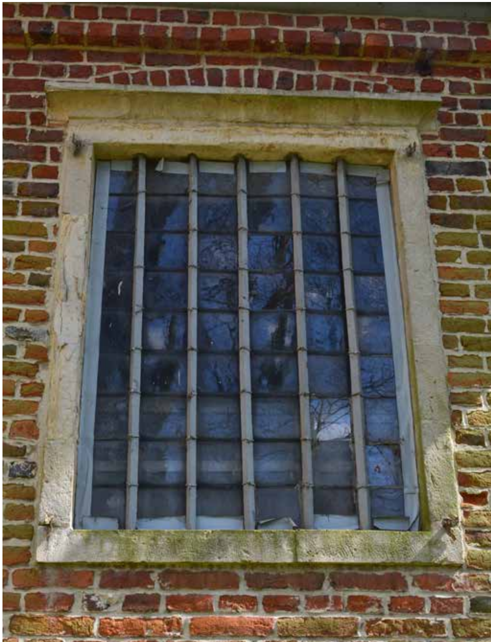
Figuur 267: Raamwerk zijgevel west Sint-Hubertuskapel (Bron: terreinwerk SumResearch)
