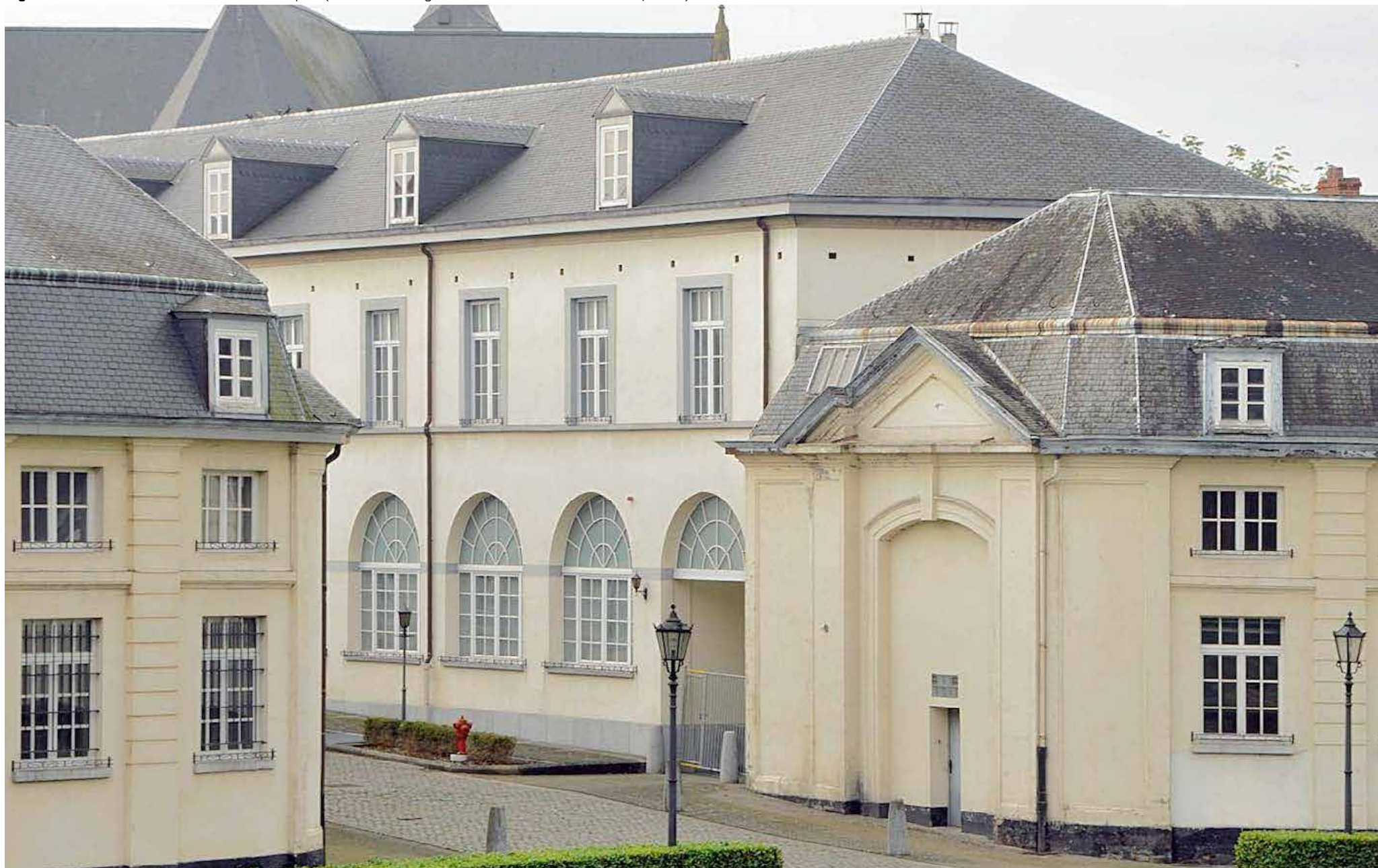
Figuur 198: Extérieur Blok G Kazerne Panquin (Bron: Stichting Architectuurarchieven - SAVE, 2015)
