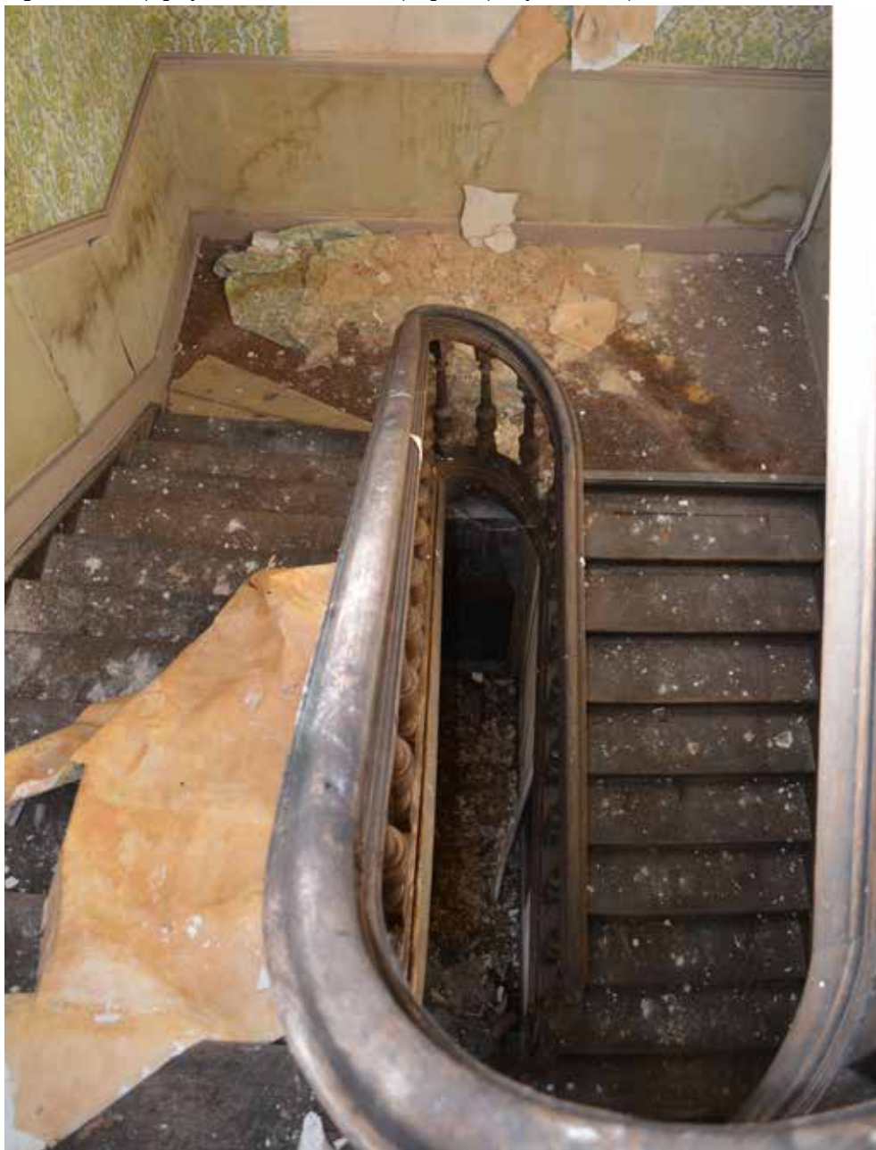
Figuur 169: Trap gelijkvloers - eerste verdieping hoekpaviljoen E-bis (Bron: terreinwerk SumResearch)
