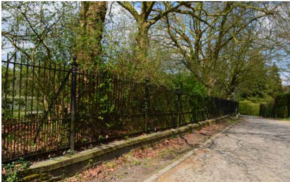
Figuur 92: Hekwerk langsheen de Zittekessstraat (Bron: terreinwerk SumResearch)
