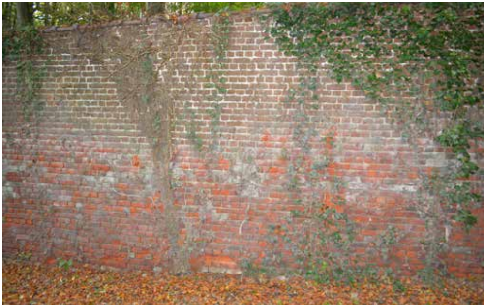
Figuur 106: Impressie parkmuur langsheen Waalse Baan - Constant Derymaekerlaan met aanzienlijke beschadigingen (Bron: terreinwerk SumResearch)
