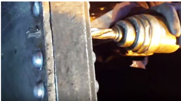
Ruimer voor het passend maken van gaten voor klinknagels.
