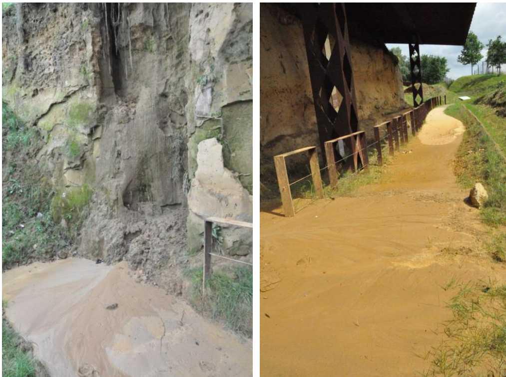
Uitgespoelde kleiige grond uit geul links van profiel 3(links: © Mowa, 25.01.2018 ; rechts: © Mowa, 28.06.2016)
