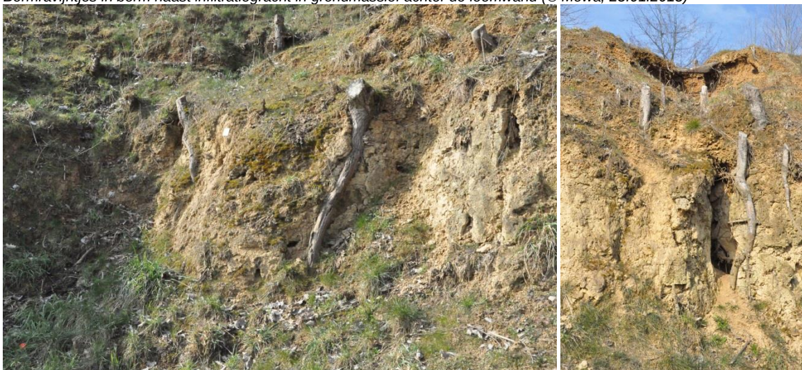
Wortels in tussenwanden (links: orthowand 7 ; rechts: orthowand 2) (© Mowa, 06.03.2018)
