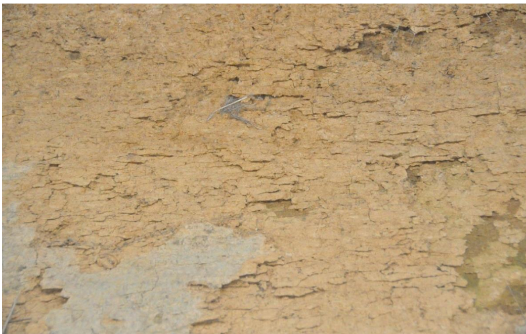
Detail afschilfering profiel 1 (© Mowa, 25.01.2018)
