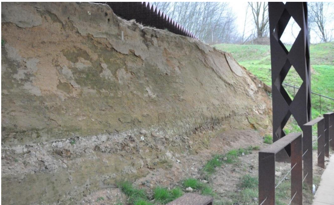
Afschilfering oppervlaktelaag profiel 1 (© Mowa, 25.01.2018)
