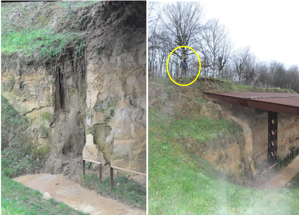
Uitspoeling langs linkerkant profiel 3, monumentenwachter (gele cirkel) staat ter hoogte van het dierenhol in de infiltratiegracht (© Mowa, 25.01.2018)
