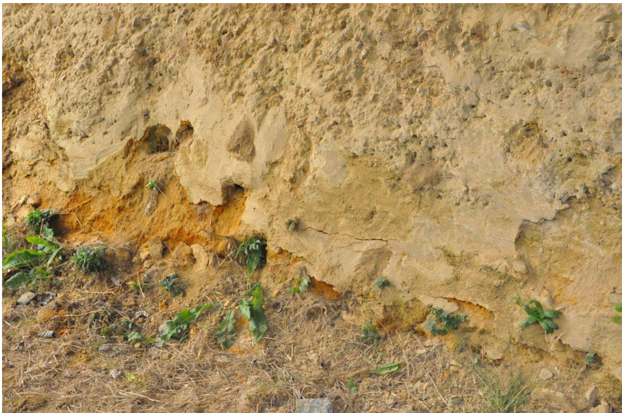
Dierlijke ingraveningen en afkalving onderaan profielwand 1 (© Mowa, 17.10.2017)
