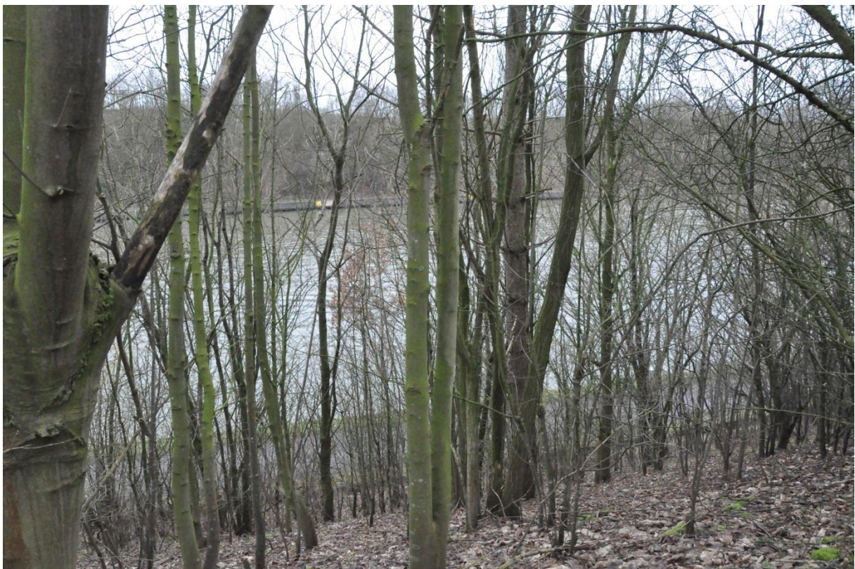
Zicht op het talud langs het Albertkanaal (© Mowa, 25.01.2018)
