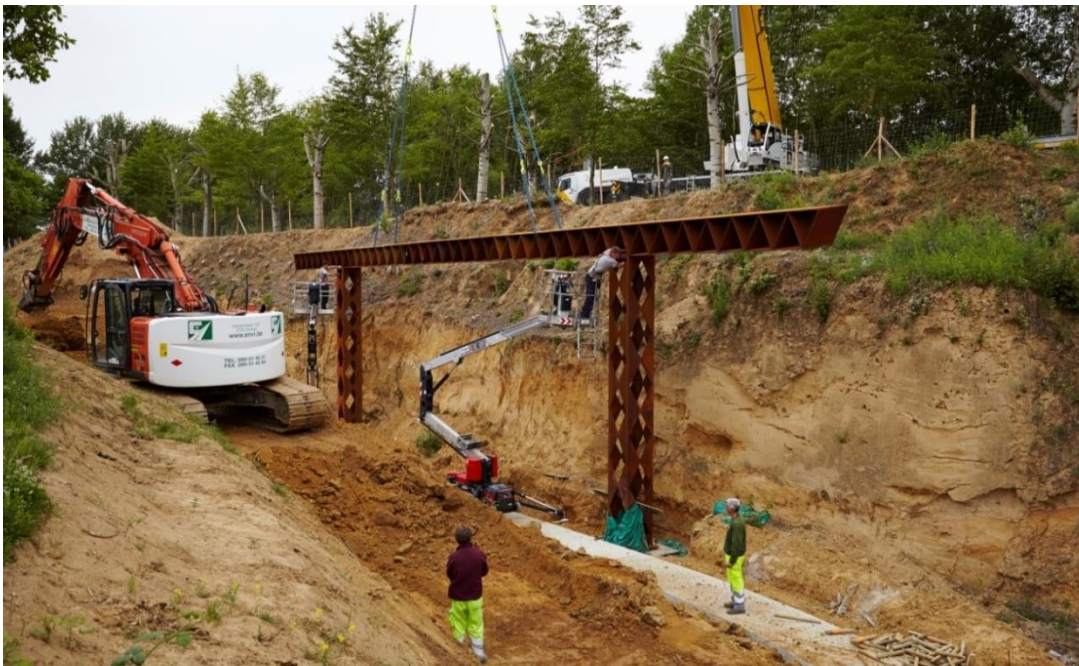
De Neanderthalsite tijdens de inrichtings- en restauratiewerken, overkapping van profiel 3 (Vandevorst, Kris, 25-05-2014, ©Vlaamse Gemeenschap)
