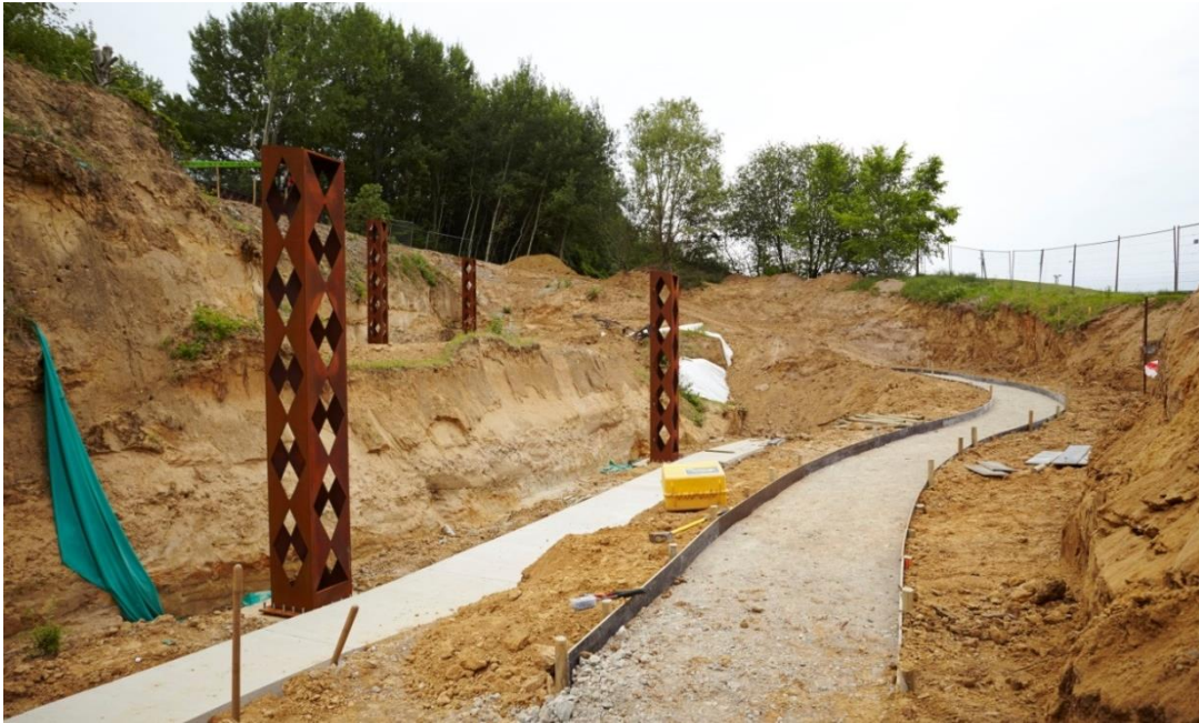
De Neanderthalsite tijdens de inrichtings- en restauratiewerken, overkapping van profiel 1 (voorgond) en profiel 2 (achteraan) (Vandevorst, Kris, 25-05-2014, ©Vlaamse Gemeenschap)
