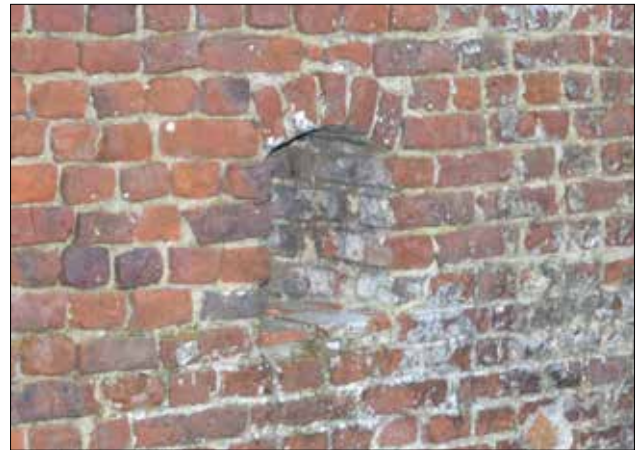
Het metselwerk van het scheidingsmuurtje tussen de hoeve en de moestuin bevindt zich in slechte staat. Een restauratie dient rekening te houden met de aanwezige bouwsporen (cfr. detailfoto rechts). © Callebaut-architecten (2018).
