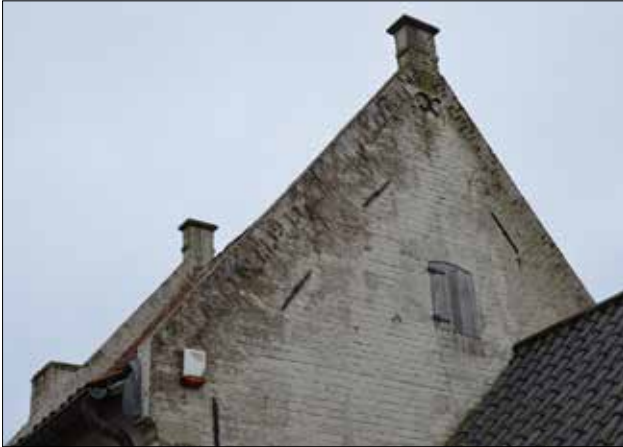
Het gevelmetselwerk van de hoeve en de stallingen is erg vervuild. © Callebaut-architecten (2018).
