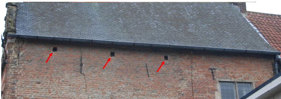
Afb. 78: Detail gevel koerzijde – openingen onder de dakrand.
