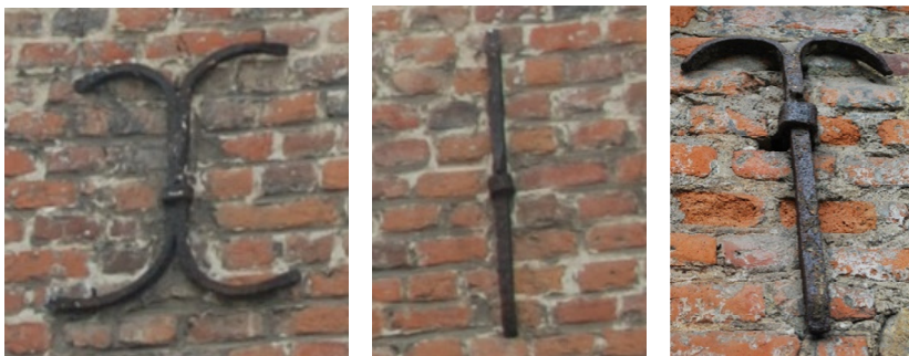
Afb. 79: Detail zijgevel koerzijde – verschillende ankers
