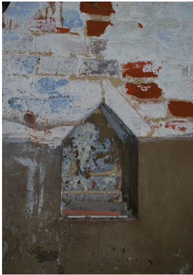
Afb. 188: Detail schuur/stal – nis.
