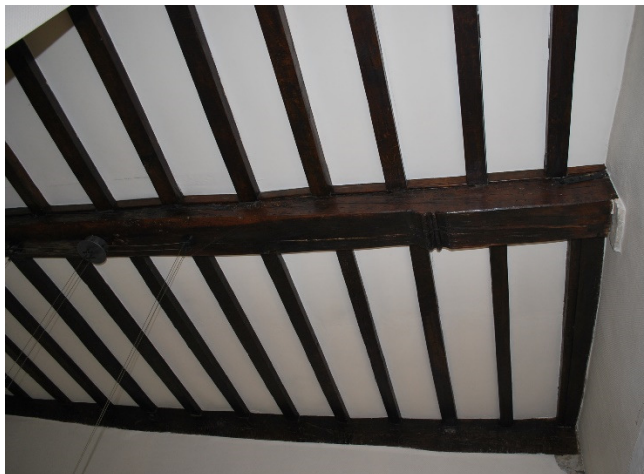
Afb. 105: Detail ruimte 2 – plafond.
