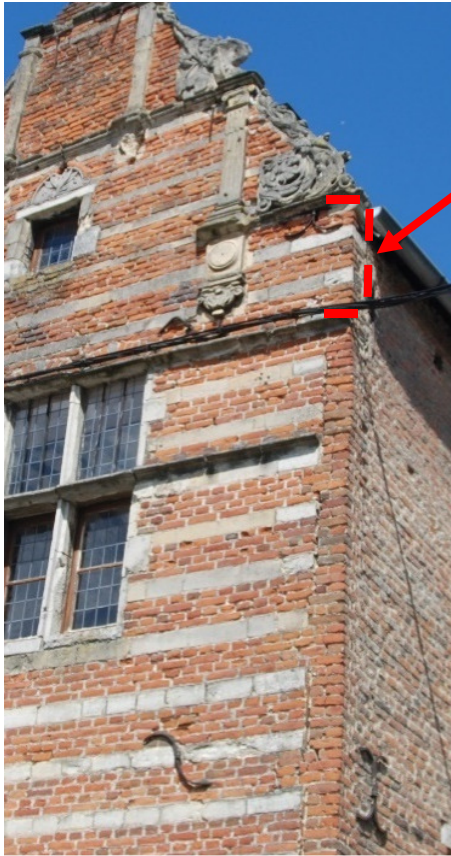
Afb. 70: Detail voor- en zijgevel koerzijde.- doorlopen van de speklagen bovenaan.
