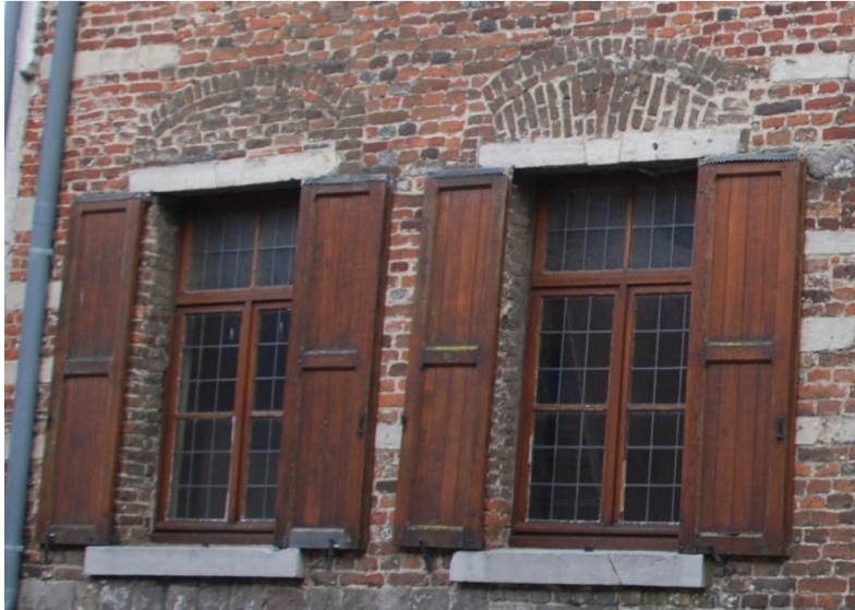
Afb. 49: Detail zijgevel Bogaerdenstraat – ontlastingsboogjes.
