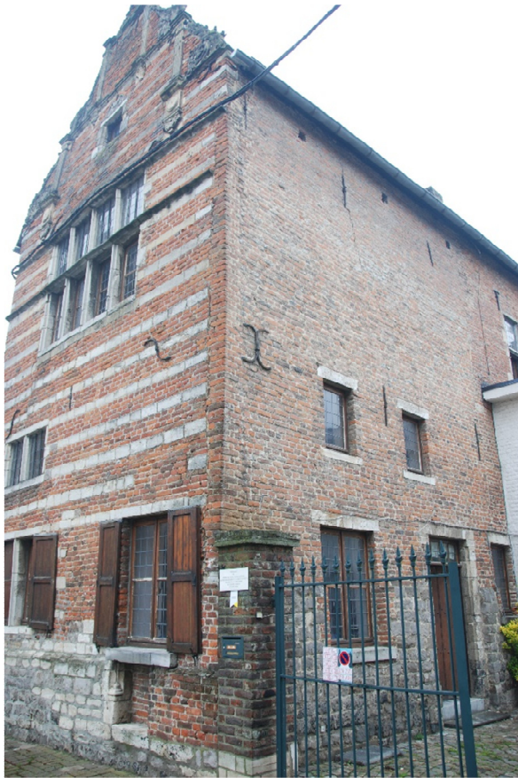
Afb. 69: Voorgevel en zijgevel koerzijde.
