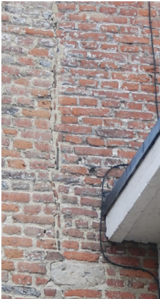
Afb. 77: Detail gevel koerzijde – opvulling bouwnaad.
