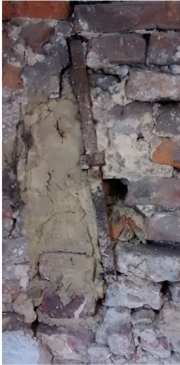
Afb. 180: Bijbouw Ruimte 1 verdieping – detail anker in de muur van het Spiegelhuis
