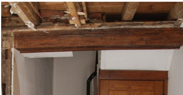
Afb. 94: Detail plafond ruimte 1 – moerbalk B1.
