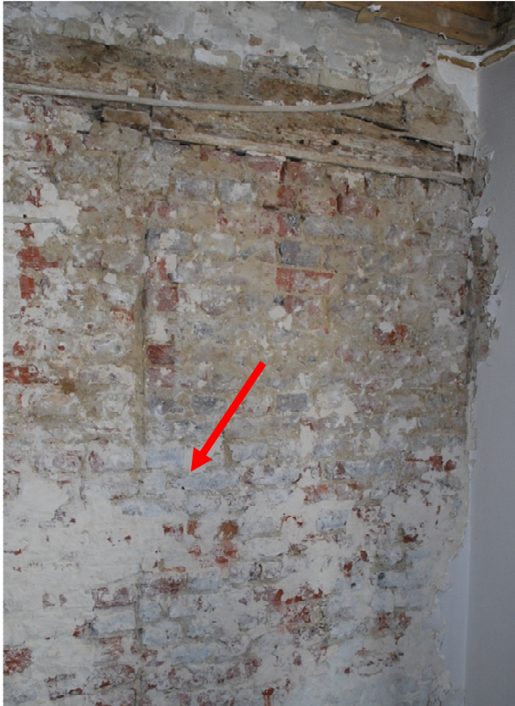
Afb. 91: Detail muur tussen ruimte 1 en 2 – aanduiding van de bouwnaad.
