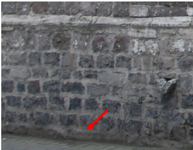
Afb. 83: Detail gevel Bogaerdenstraat – aanduiding van de locatie van keldergat van kelder 2.
