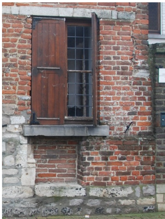
Afb. 63: Detail voorgevel - linkerzijde.
