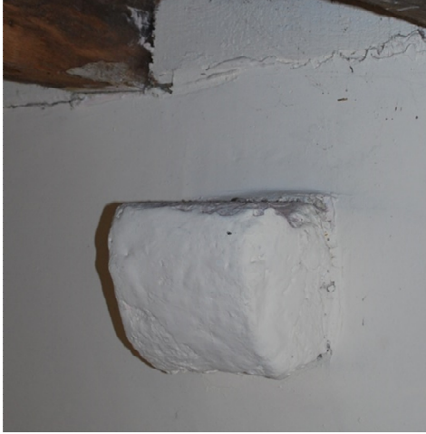
Afb. 114: Detail ruimte 3 – console in de voorgevel.
