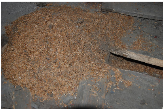
Afb. 158: Detail zolder – zoldervloer – droog plantaardig materiaal.
