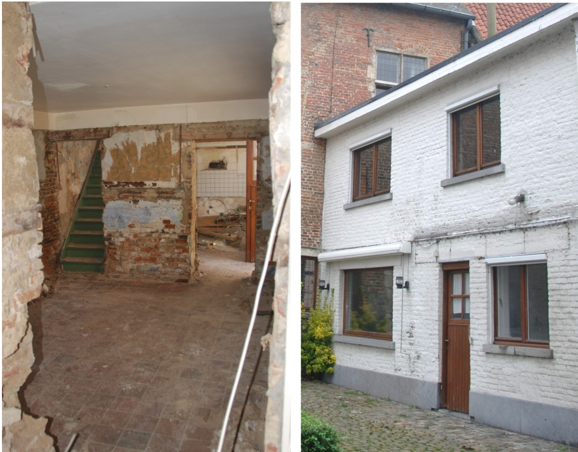
Afb. 174: Doorgang van het Spiegelhuis (ruimte 2) naar de Bijbouw (ruimte 1).
