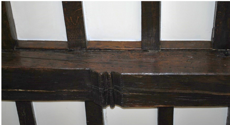
Afb. 107: Detail plafond ruimte 2 – moerbalk B3b.
