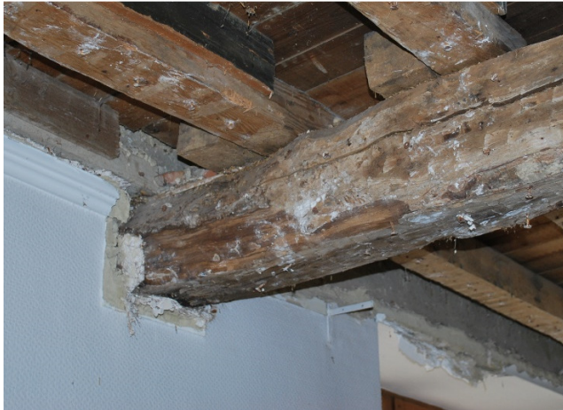
Afb. 93: Detail plafond ruimte 1 – moerbalk B1a.
