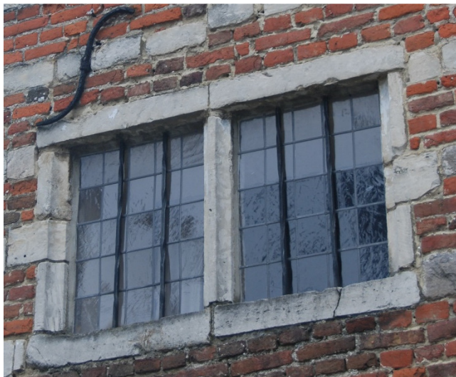
Afb. 30: Detail voorgevel – venster tussenverdieping.
