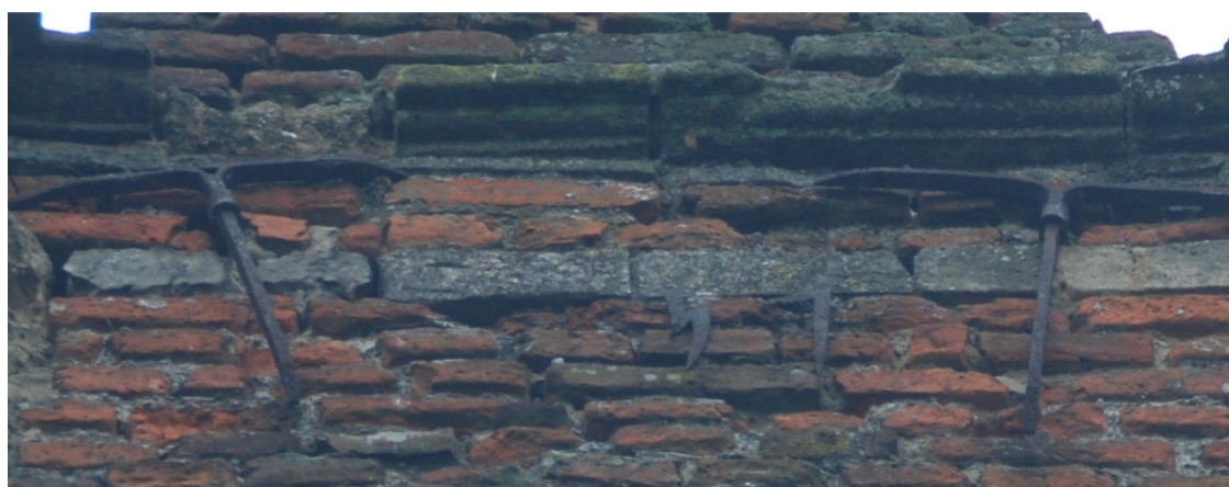
Afb. 19: Detail voorgevel – muurankers in de topgevel.
