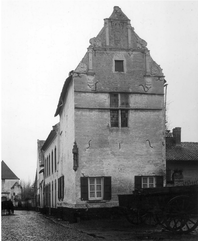
Afb. 20: Het Spiegelhuis anno 1914-1918 ©KIK-IRPA. Het huis heeft hier nog een pleisterlaag, de vensteropeningen in voor- en zijgevel zijn gedicht en het heiligenbeeld staat nog in de hoeknis.
