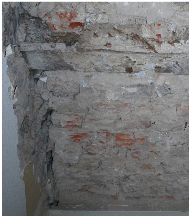
Afb. 90: Detail muur tussen ruimte 1 en 2 – zijde Bogaerdenstraat.
