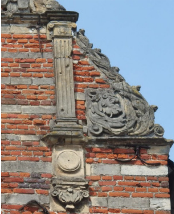
Afb. 41: Detail onderste pilaster (rechts) in een fijnkorrelig geel gesteente, allicht van dezelfde samenstelling als de grijzere voluten die in grote blokken zijn versneden. ©Dusar M., Rapport Spiegelhuis Zoutleeuw. Natuursteen in het parement, p. 11.
