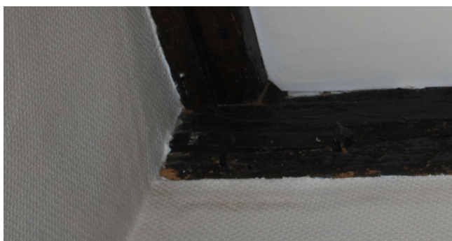
Afb. 108: Detail plafond ruimte 2 – moerbalk B2a.
