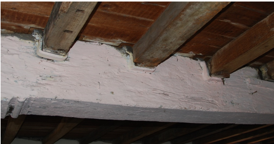
Afb. 115: Detail plafond ruimte 3 – smeedijzeren steun kinderbalken.
