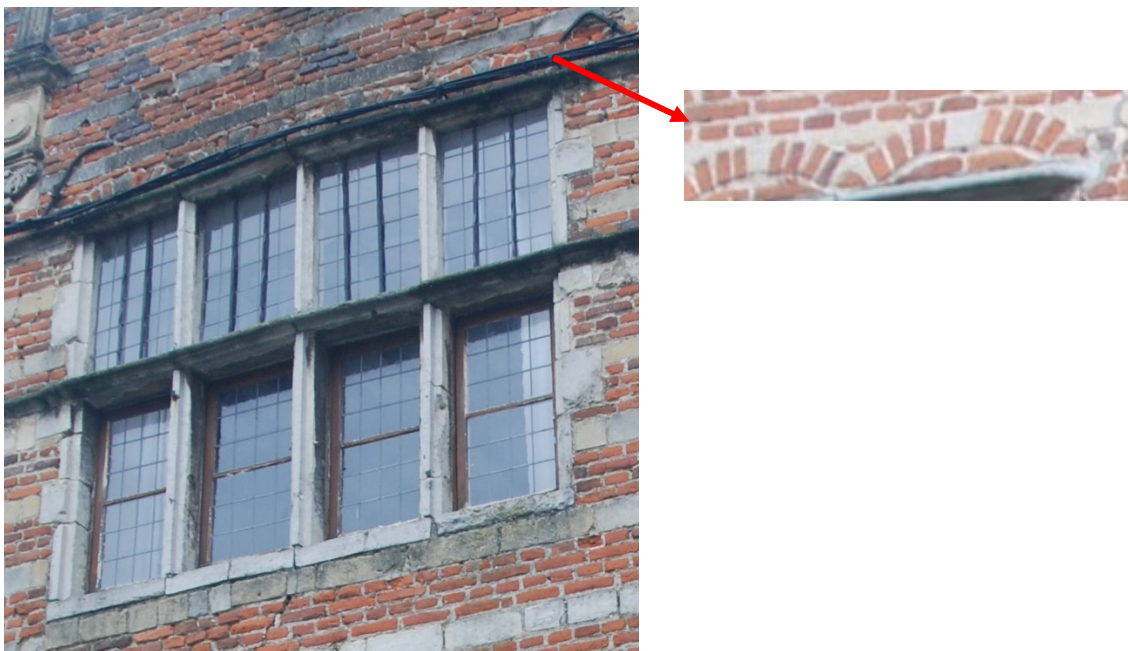
Afb. 32: Detail voorgevel – venster verdieping.
