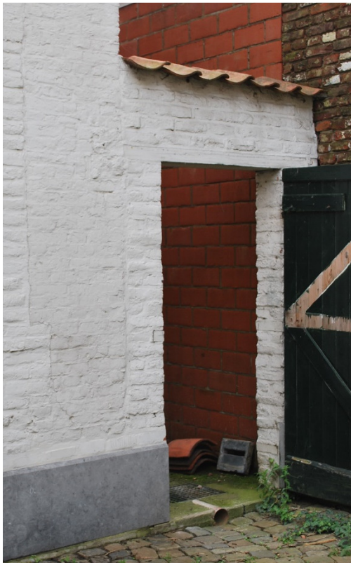
Afb. 186: Detail schuur/stal – doorgang aan de rechterzijde.
