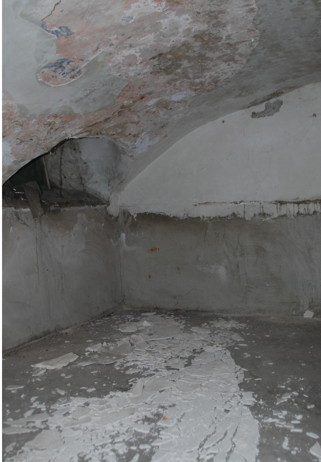
Afb. 80: Kelder onder ruimte 1.
