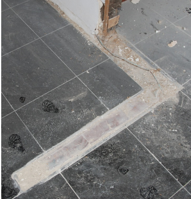
Afb. 87: Detail ruimte 1 – oudere roodbruine tegels onder de vroegere muur tussen de inkomhal en het bureel.
