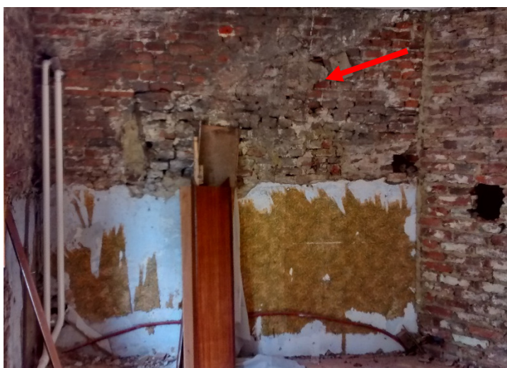
Afb. 179: Bijbouw Ruimte 1 verdieping – muur van het Spiegelhuis
