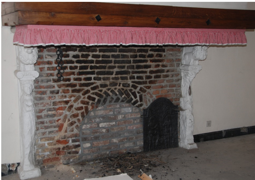
Afb. 101: Detail ruimte 2 – monumentale schouw
