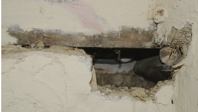
Afb. 109: Detail sondering naar console – B2a.
