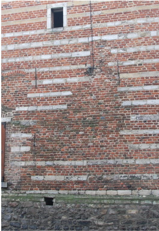
Afb. 54: Detail zijgevel Bogaerdenstraat.
