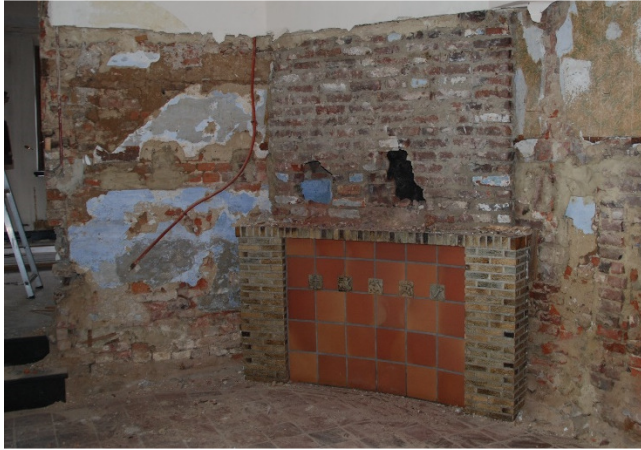
Afb. 176: Bijbouw Ruimte 1 – schouw.
