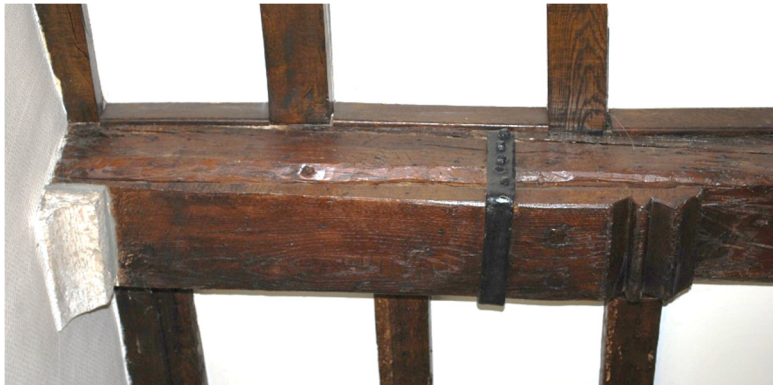
Afb. 106: Detail plafond ruimte 2 – moerbalk B3a.
