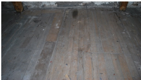
Afb. 159: Detail zolder – zoldervloer.
