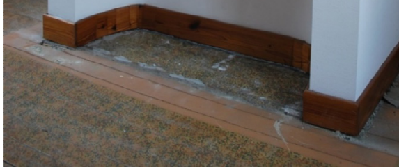
Afb. 134: Detail ruimte 5 – getamponneerde tapijtimmitatie.
