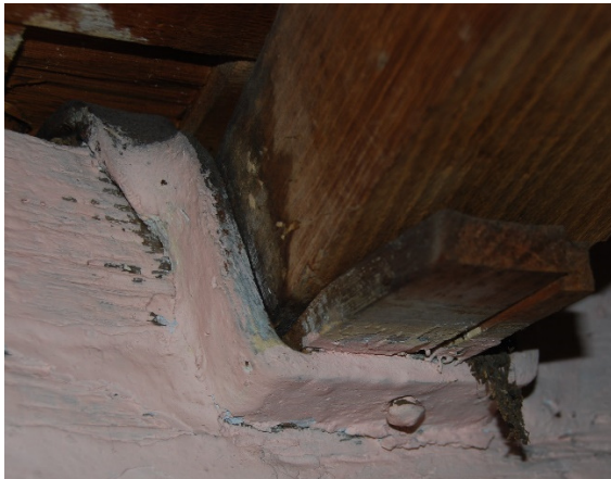
Afb. 116, 117, 118: Detail plafond ruimte 3 – smeedijzeren steunen kinderbalken.
