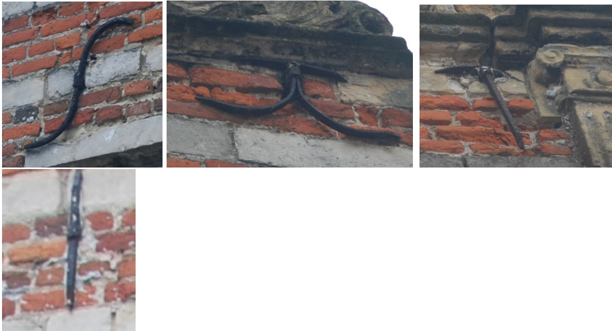
Afb. 43: Detail voorgevel – verschillende ankers
