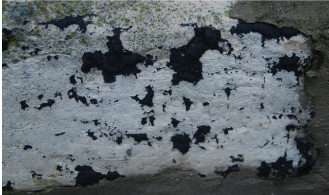
Afb. 51: Detail zijgevel Bogaerdenstraat – gespekte plint.
