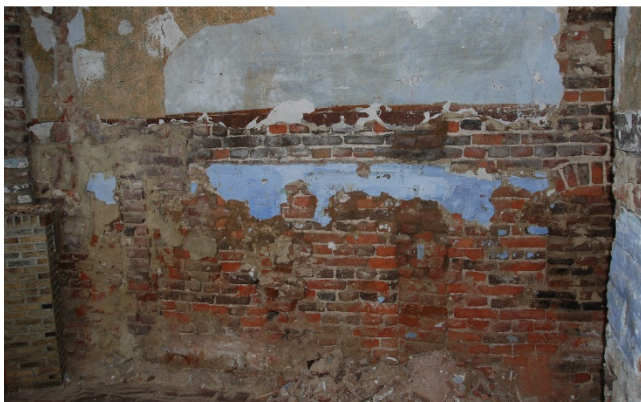
Afb. 177: Bijbouw Ruimte 1 – muur tegen de burens.
