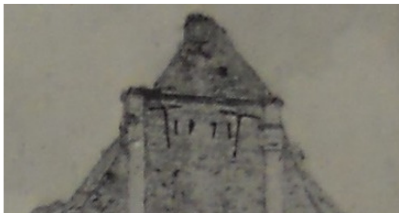
Afb. 18: Detail voorgevel – muurankers in de topgevel.
