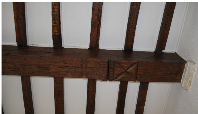
Afb. 123: Detail plafond ruimte 4 – moerbalk B6 en kinderbalken.
