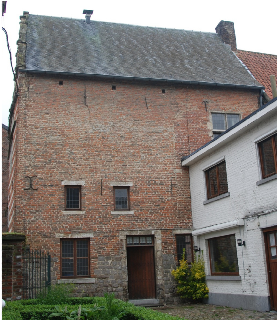
Afb. 166: Zijgevel pleinzijde met annex bijbouw.
