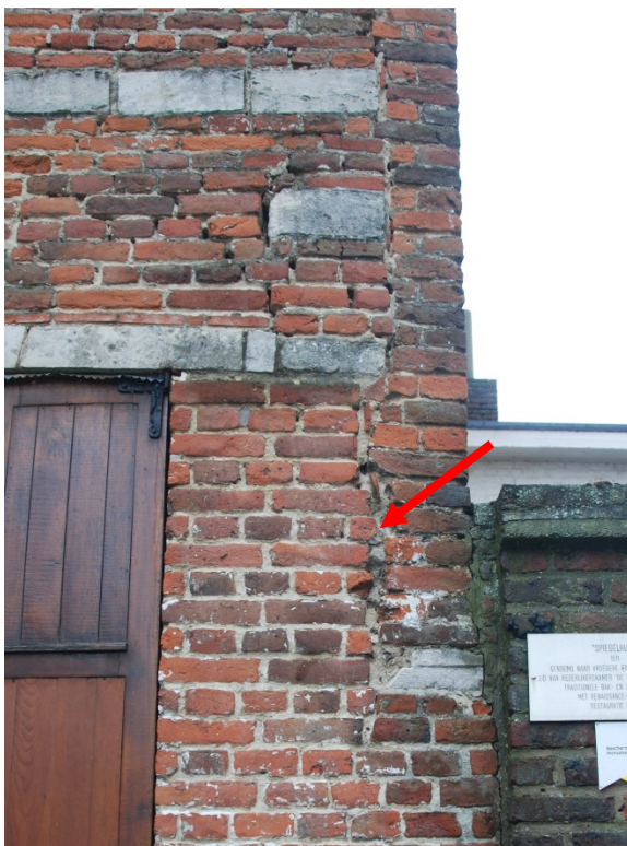
Afb. 72: Detail voor- en zijgevel koerzijde.- bouwnaad.
