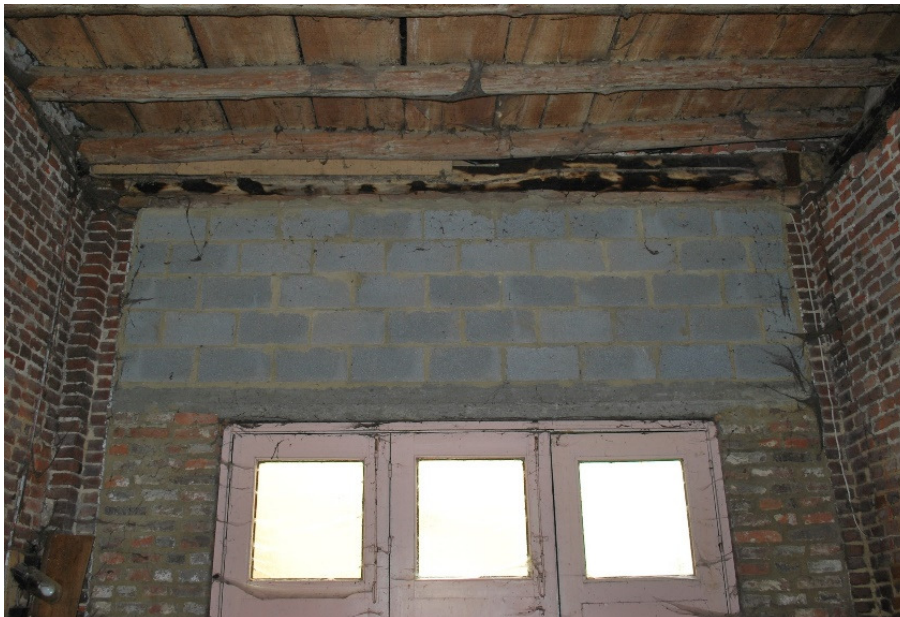
Afb. 184: Detail schuur/stal – verkleinen van de poort.
