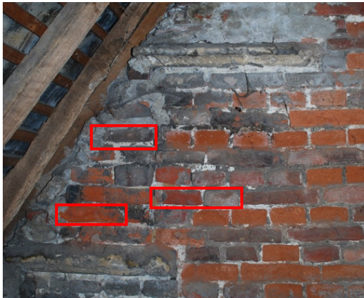
Afb. 155: Detail zolder – gevel buren langs de zijde Bogaerdenstraat – metselverband.
