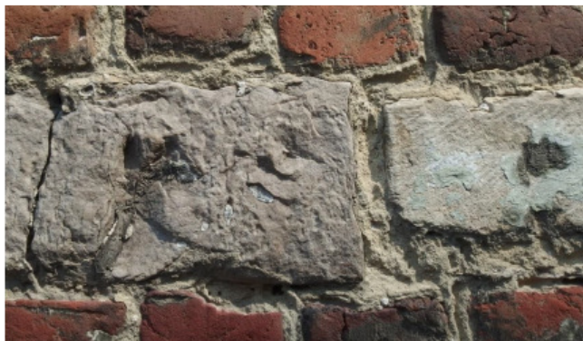
Afb. 56: Detail zijgevel Bogaerdenstraat – speklaag met Tiense kwartsiet naast Gobertangesteent. ©Dusar M., Rapport Spiegelhuis Zoutleeuw. Natuursteen in het parement, p. 6.
