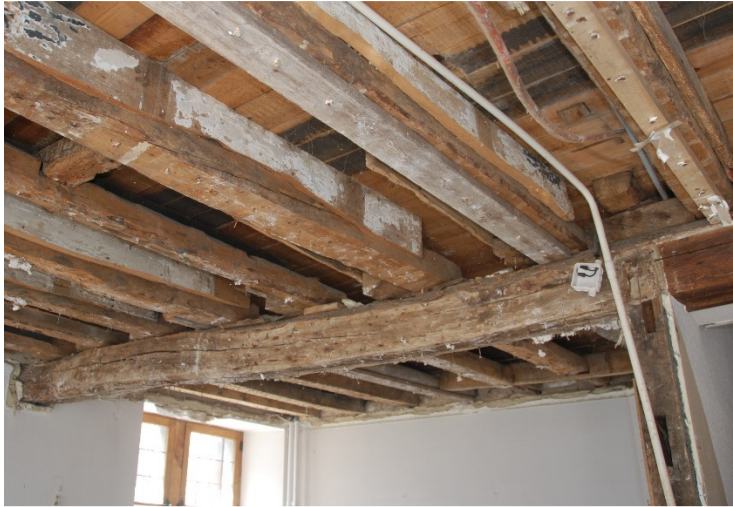
Afb. 92: Detail ruimte 1 – verlaagd plafond.
