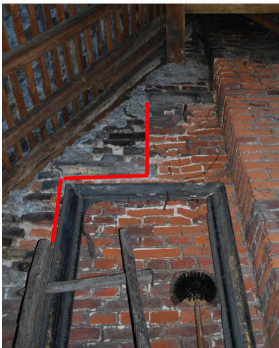
Afb. 153: Detail zolder – gevel burens langs de zijde Bogaerdenstraat met aanduiding van waar zich vroeger de vlechting bevond.
