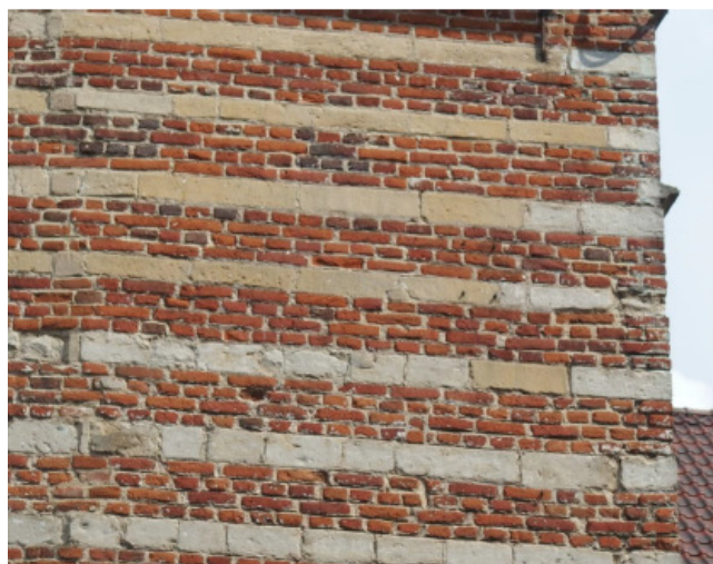
Afb. 57: Detail zijgevel Bogaerdenstraat – speklagen in Gobertangesteent overgaand in gele (vermoedelijk) Maastrichtersteen. Hoekstenen in Gobertangesteent. ©Dusar M., Rapport Spiegelhuis Zoutleeuw. Natuursteen in het parement, p. 6.
