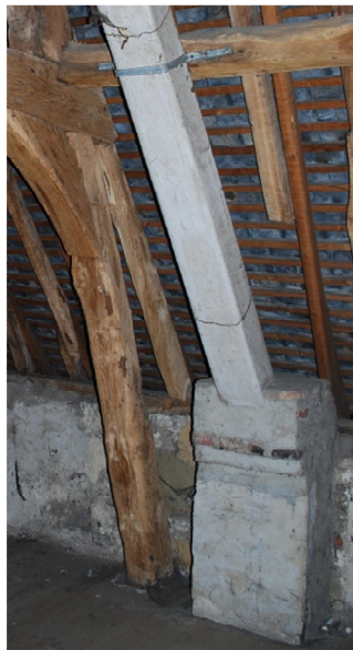
Afb. 165: Detail zolder – afvoerbuis oude schoorsteen ruimte 4.
