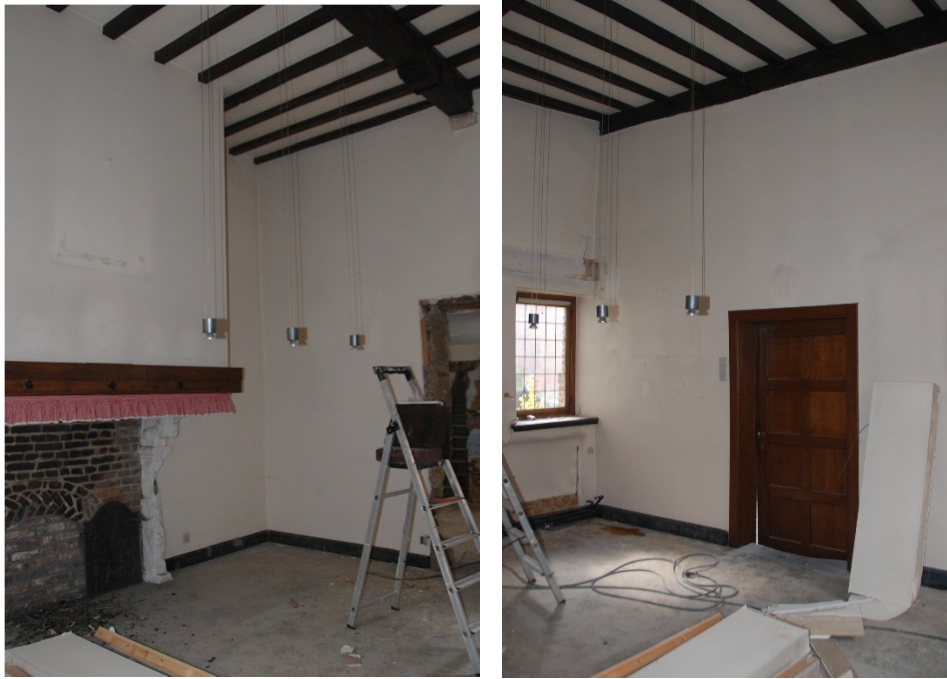
Afb. 97-98: Detail ruimte 2 – zicht vanaf de muur aan de Bogaerdenstraat.
