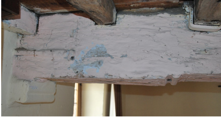
Afb. 112: Detail plafond ruimte 3 – moerbalk B4a.
