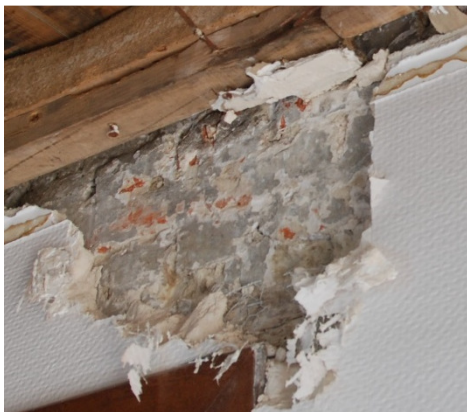
Afb. 88: Detail ruimte 1 – sondering muur tussen ruimte 1 en 2.
