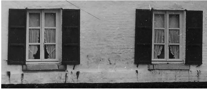
Afb. 26: Detail voorgevel – ramen gelijkvloers anno 1943. ©KIK-IRPA.
