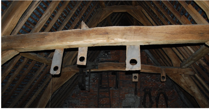
Afb. 164: Detail zolder - dakgebinte.
