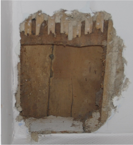
Afb. 129: Detail plafond ruimte 4b – sondering plafond.
