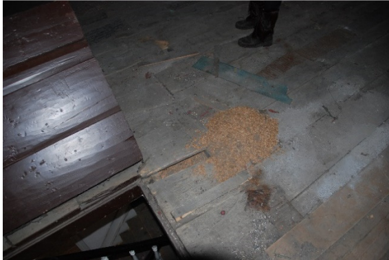
Afb. 157: Detail zolder – zoldervloer.
