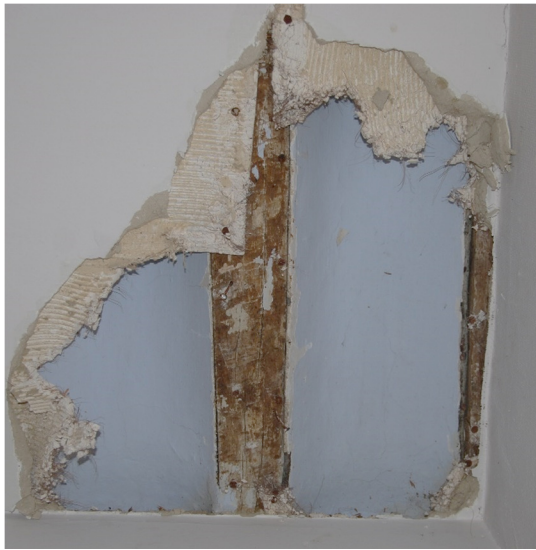
Afb. 136: Detail plafond ruimte 5 – troggewelfjes.
