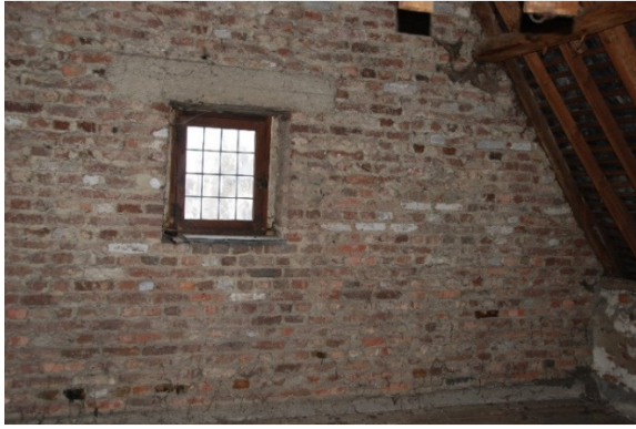
Afb. 149: Detail zolder – voorgevel.
