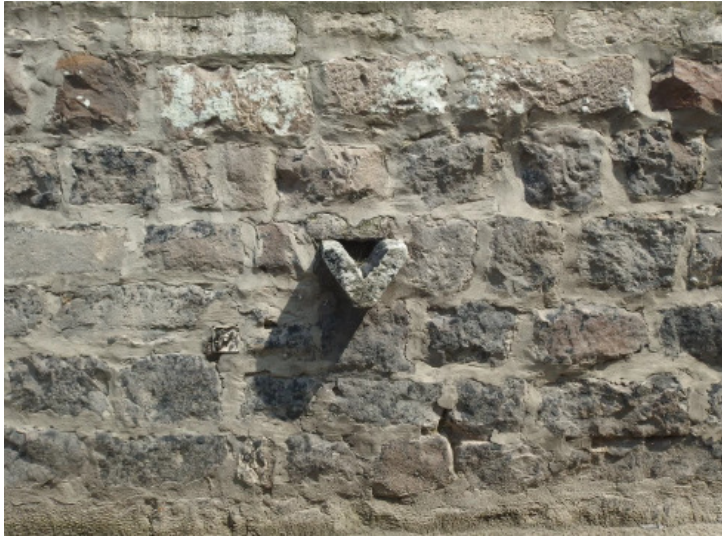
Afb. 53: Detail plint in Tiense kwartsiet, ruw afgewerkt maar rijkelijk bestreken met portlandcement. Uitstekende watergoot in Gobertangesteent. ©Dusar M., Rapport Spiegelhuis Zoutleeuw. Natuursteen in het parement, p. 4.
