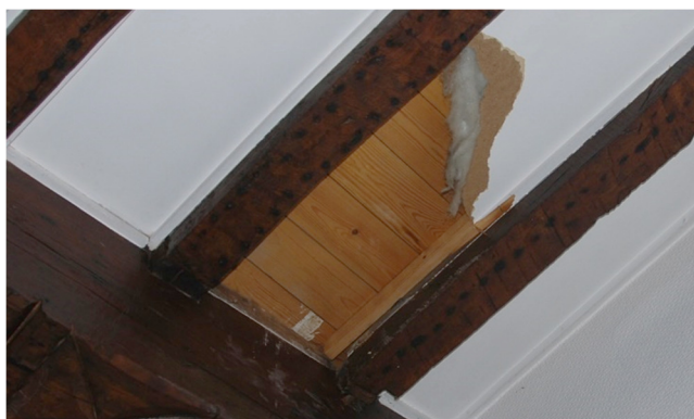
Afb. 124: Detail plafond ruimte 4 – wegnemen van tussenschotten.
