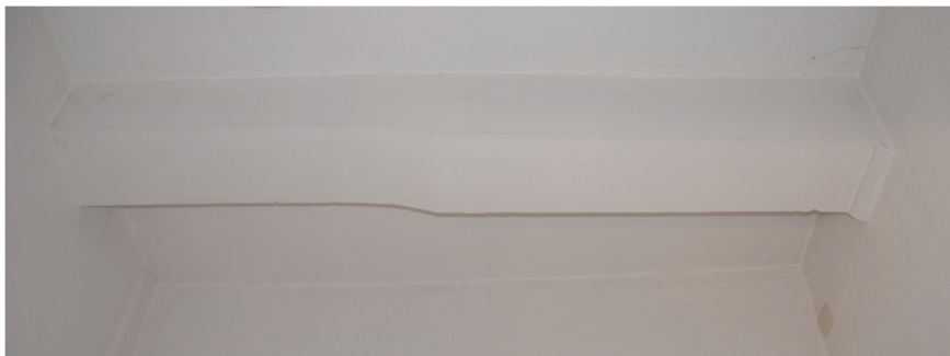
Afb. 128: Detail plafond ruimte 4b – moerbalk B7a.
