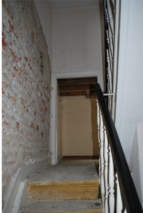
Afb. 139: Detail traphal – trap naar de tussenverdieping.
