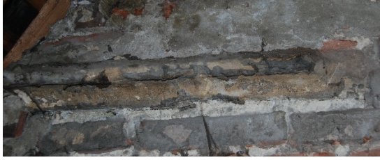
Afb. 154: Detail zolder – gevel buren langs de zijde Bogaerdenstraat – natuurstenen trap.
