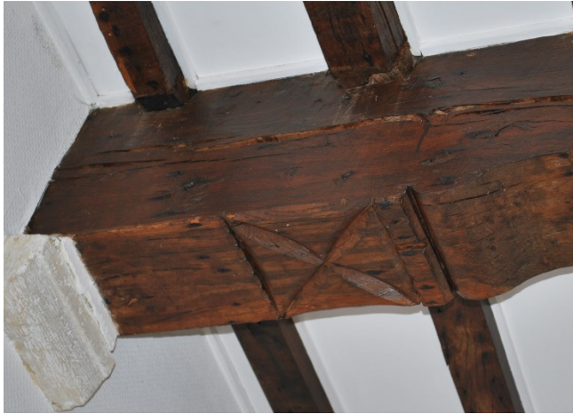
Afb. 125: Detail plafond ruimte 4 – console en balksleutel.
