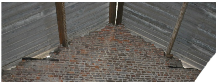
Afb. 191: Detail schuur/stal – dak.
