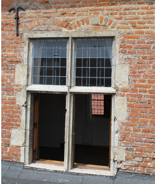
Afb. 68: Detail zijgevel koerzijde – venster verdieping.
