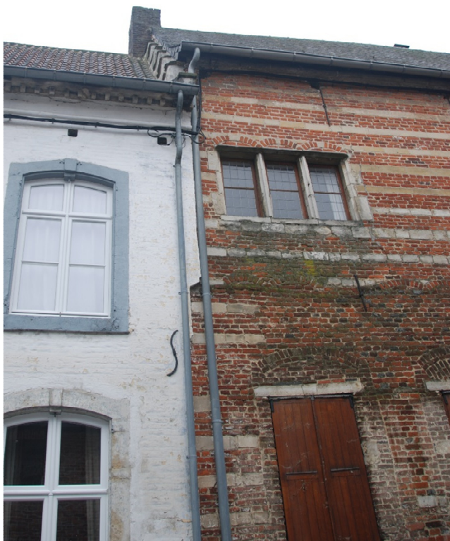
Afb. 50: Detail zijgevel Bogaerdenstraat – inspringen van de gevel van de burens in de gevel van het Spiegelhuis..
