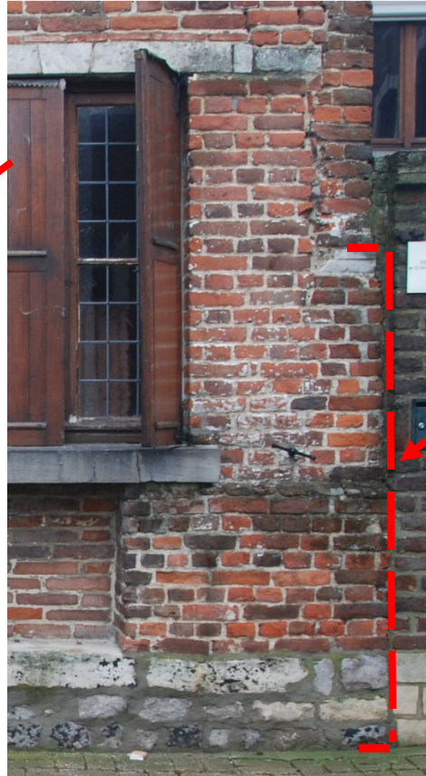
Afb. 70: Detail voor- en zijgevel koerzijde.- doorlopen van de speklagen bovenaan.
