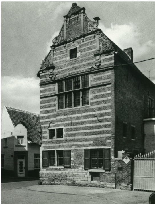
Afb. 21: Het Spiegelhuis anno 1970 ©fotoarchief Jan Peeters. Het huis is ontdaan van zijn pleisterlaag, de vensteropeningen in voor- en zijgevel zijn opnieuw open gemaakt. Het heiligenbeeld in de hoeknis is hier reeds verdwenen.
