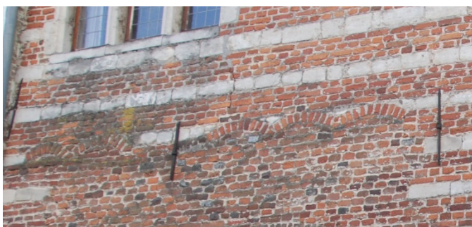
Afb. 48: Detail zijgevel Bogaerdenstraat – ontlastingsboogjes.
