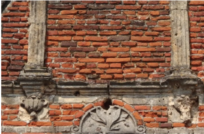
Afb. 42: Detail bovenste pilasters in een gele grofkorrelige kalksteen, mogelijk fosfaatkrijt. ©Dusar M., Rapport Spiegelhuis Zoutleeuw. Natuursteen in het parement, p. 12.
