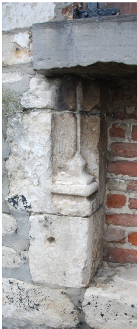
Afb. 28: Detail hergebruik van de hoeksteen met plintlijst(?).
