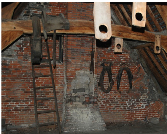
Afb. 156: Detail zolder – gevel buren.
