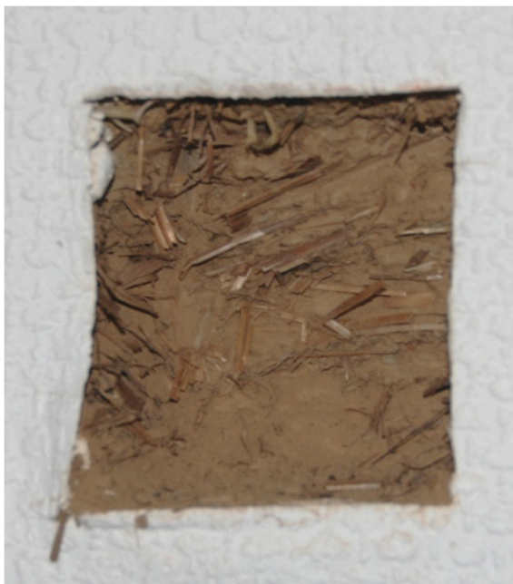
Afb. 127: Detail ruimte 4b – sondering op de muur tegen ruimte 5.
