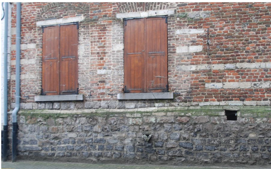
Afb. 52: Detail zijgevel Bogaerdenstraat – plint.
