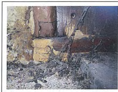
Foto: zwamvorming in vast kader en opengaand deel van het zolderraam
