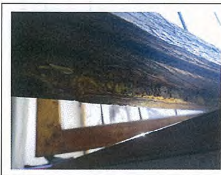
Foto: zwamvorming in opengaand deel van de ruit
