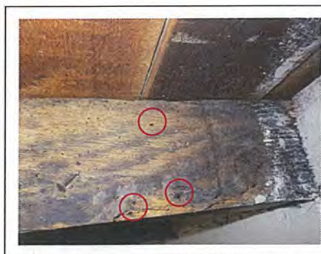
Foto: lichte maar niet actieve aantasting door houtborende insecten.
