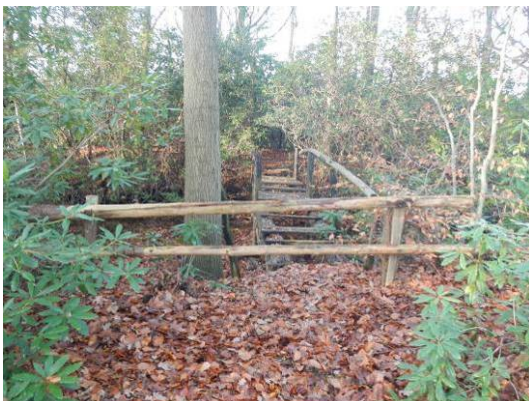
Figuur 91: Brug west - vooraanzicht west
