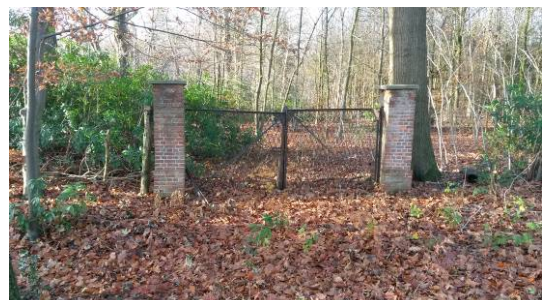
Figuur 78: Metalen poort - buiten gebruik
