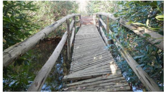
Figuur 94: Brug oost - close-up noord
