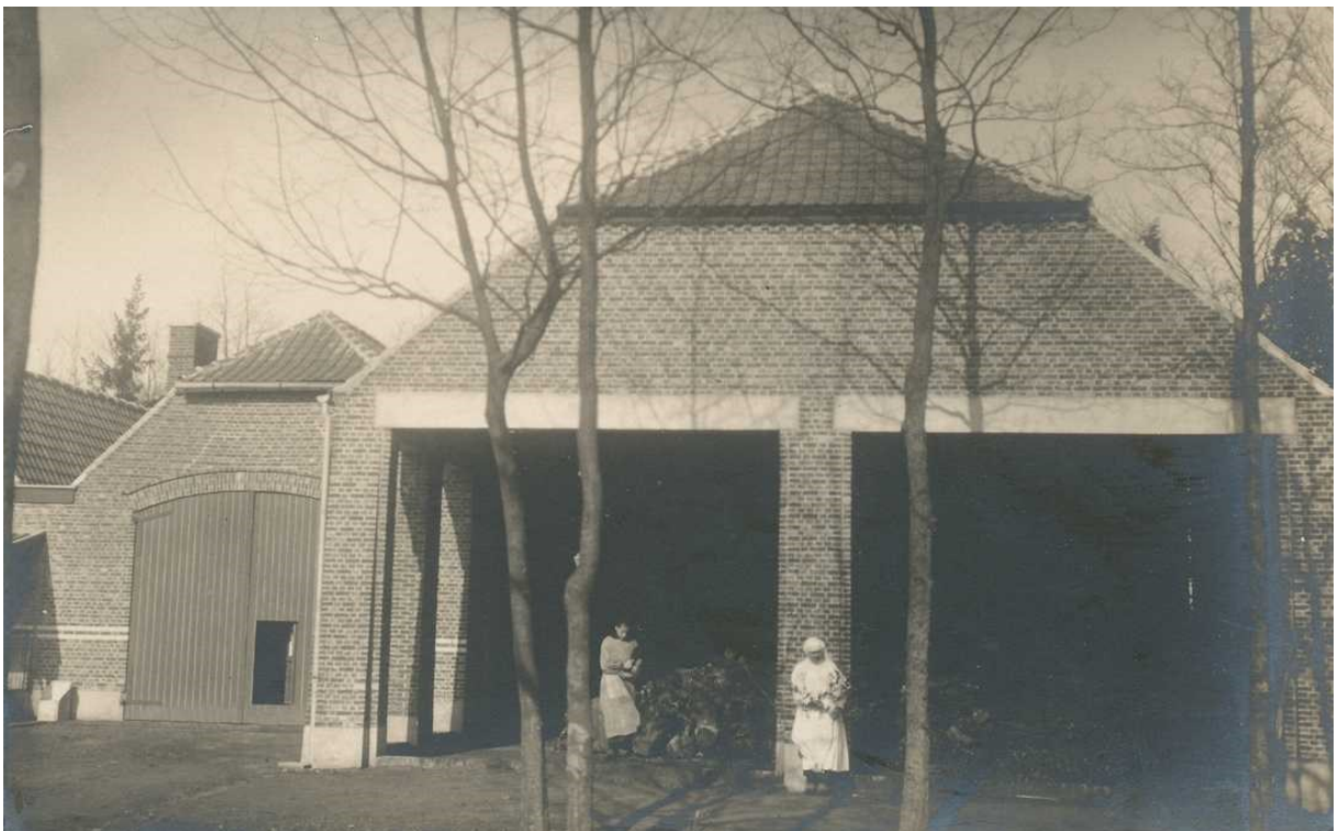
Afb. 78: Achterzijde van de hoeve naast de kloostergebouwen, na 1929. www.oudwezelopdefoto.be .
