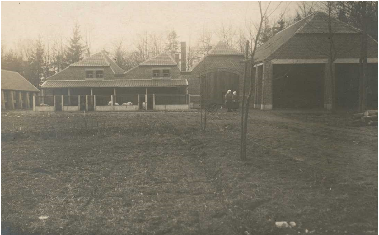
Afb. 76: Achterzijde van de hoeve naast de kloostergebouwen, na 1929. www.oudwezelopdefoto.be .
