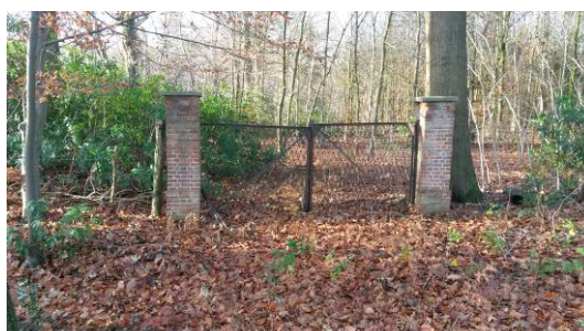
Figuur 78: Metalen poort - buiten gebruik
