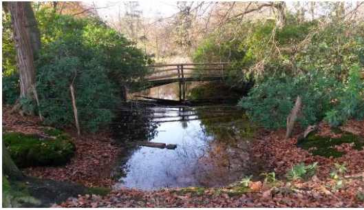
Figuur 93: Brug oost - zij aanzicht west
