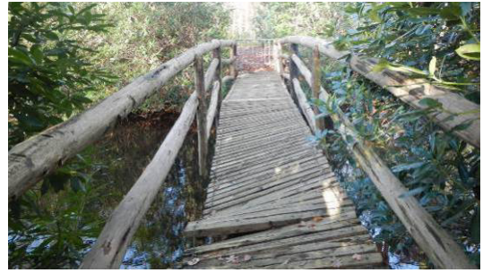
Figuur 94: Brug oost - close-up noord
