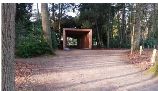
Figuur 75: Houten toegangstunnel begraafplaats
