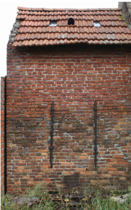
▲ foto 2.35: oud en nieuw metselwerk westgevel, mechanische pannen
