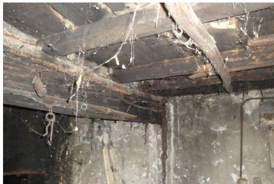
▲ foto 3.35: bakhuis vloerstructuur
