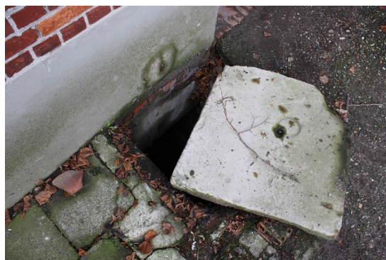
▲ foto 2.22: deksel gierput aan buitenzijde stal
