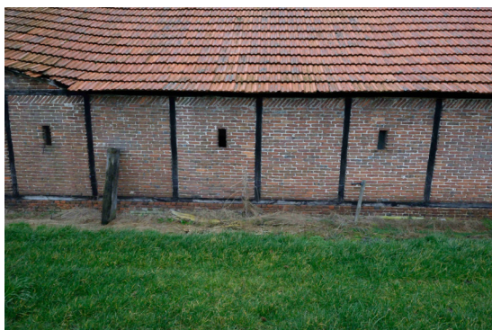
▲ foto 2.31: houten stijlen en stroomlagen: vroeger: hout- en leembouw
