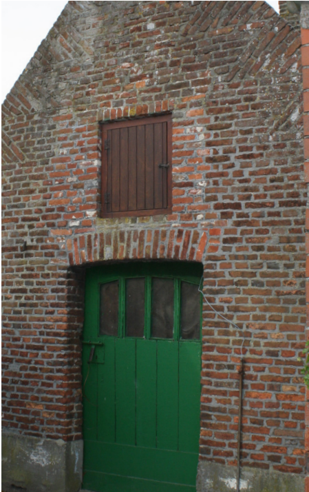
▲ foto 2.33: nieuw metselwerk zolderraam zuidgevel
