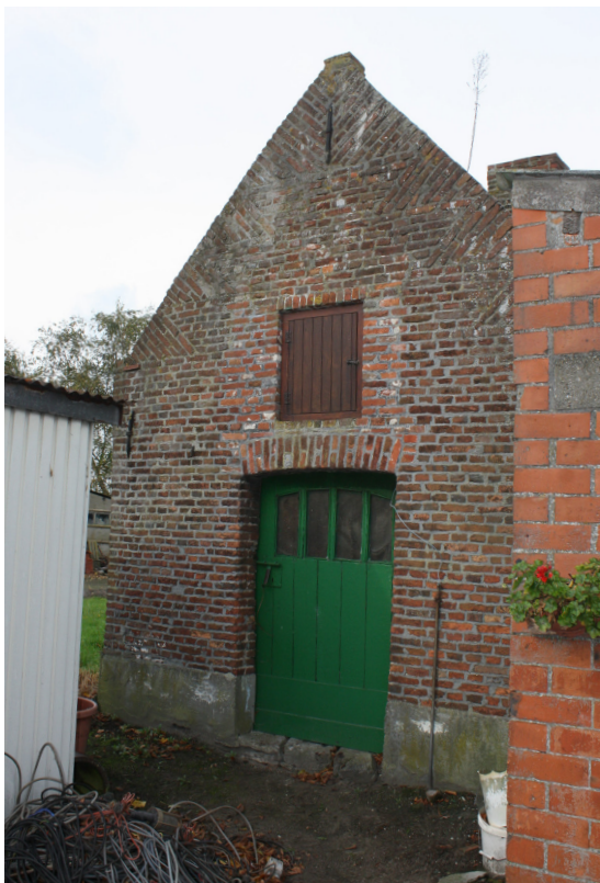
▲ foto 3.36: bakhuis gevel zuid met houten deur
