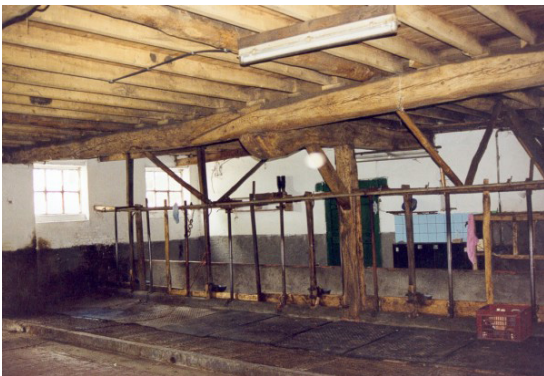
▲ foto 3.24: woonstalhuis stalvloer
