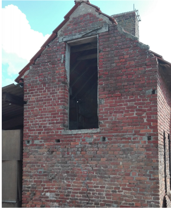
▲ foto 2.34: oud en nieuw metselwerk zuidgevel
