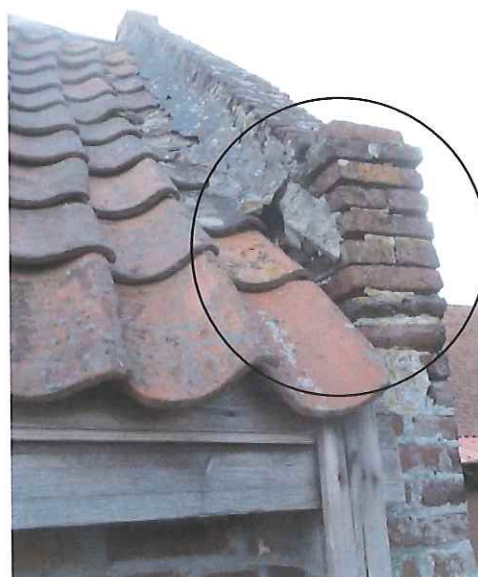
Dak [4]-zuidelijke topgevel
