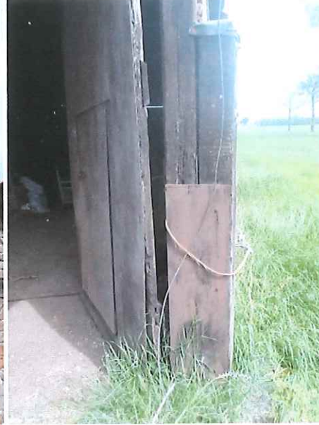
Ingerotte en verstevigde stijl langs zuidoostelijke poort
