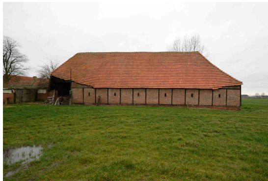
▲ foto 3.28: schuur gevel oost
