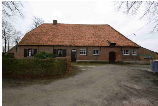
▲ foto 3.8: woonstalhuis gevel oost
