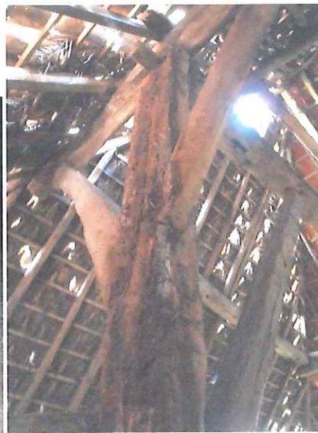
Vleugel [2]-noordwestelijke stijl
