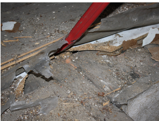
▲ foto 2.21: doorlopende balken boven scheiding opkamer en eetkamer
