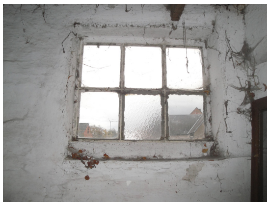
▲ foto 3.14: woonstalhuis betonnen stalramen
