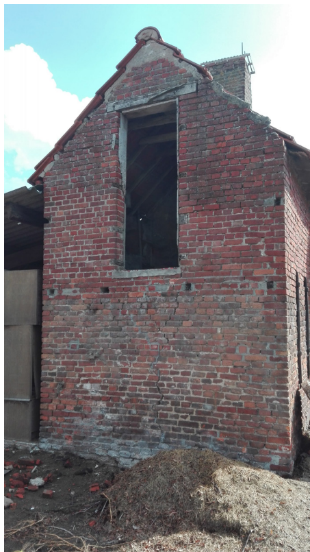
▲ foto 3.37: bakhuis gevel noord
