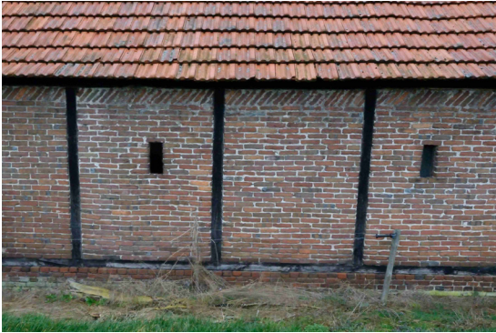
▲ foto 3.31: schuur vakwerk westgevel
