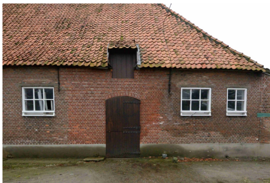
▲ foto 2.13: nieuw metselwerk ter hoogte van oostelijke stalpoort het metselwerk boven de stalvensters vertoont sporen van voormalige segmentbogen (baksteenmaat: 170x80x45mm)
