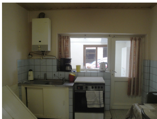
▲ foto 2.16: nieuwe deur en raam, zichtbaar aan compleet verschillende vorm als oorspronkelijke hoeveramen
