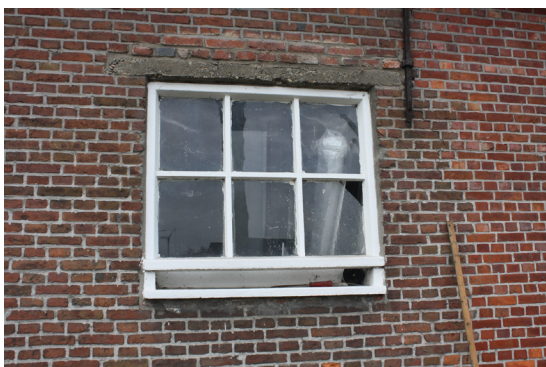
▲ foto 3.13: woonstalhuis betonnen stalramen
