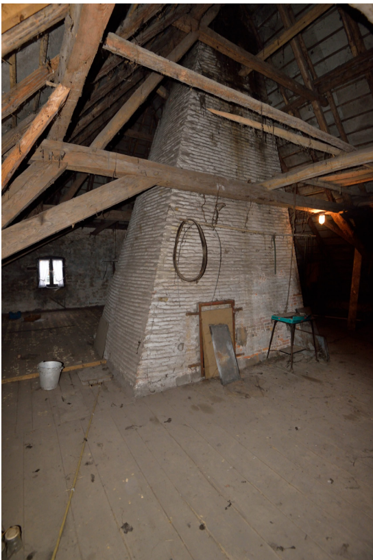
▲ foto 3.17: schouw op zolder
