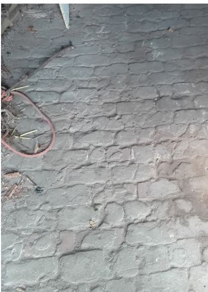
▲ foto 3.42: bakhuis, stenen vloer
