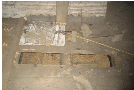
▲ foto 3.22: woonstalhuis plankenvloer zolder
