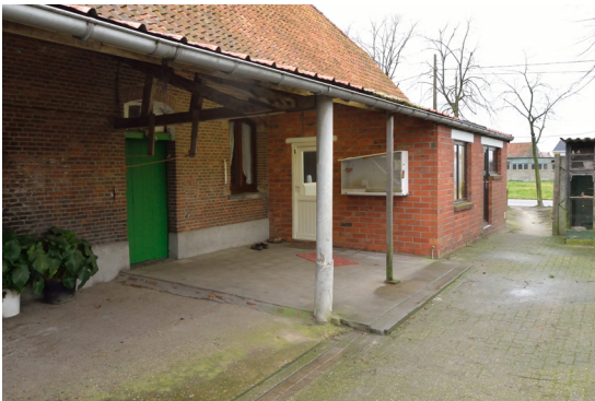
▲ foto 2.9: snelbouwsteen latere aanbouw westelijk volume
