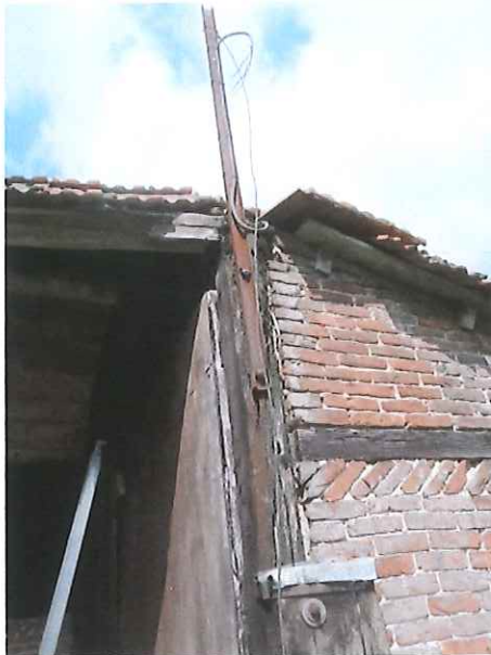
Ingerotte en verstevigde stijl langs zuidoostelijke poort
