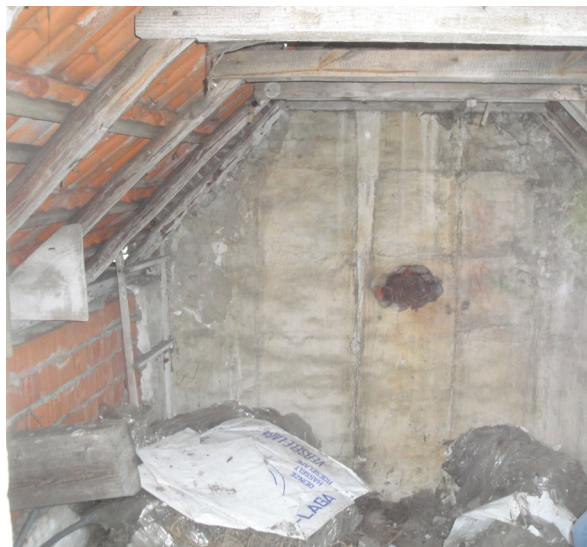
▲ foto 2.36: snelbouw wand
