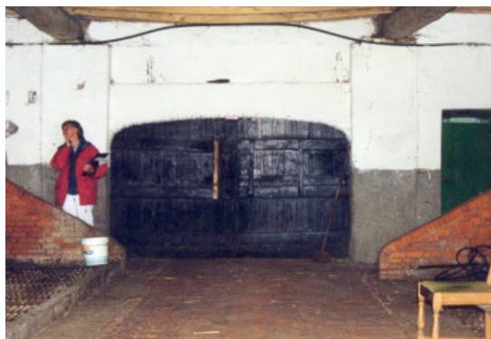
▲ foto 3.12: woonstalhuis westelijke stalpoort, interieur
