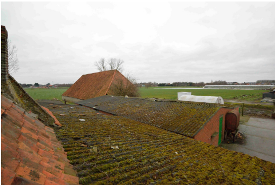
▲ foto 2.3: golfplaten van de nieuwe gebouwen tegenover de originele pannen van de kerngebouwen
