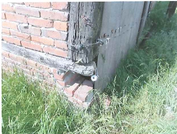
Ingerotte houtverbinding, noordoostelijke hoek
