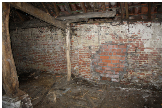
▲ foto 2.30: dichtgemetste opening in schuur (vóór aanbrengen van cementering want langs buiten niet zichtbaar)
