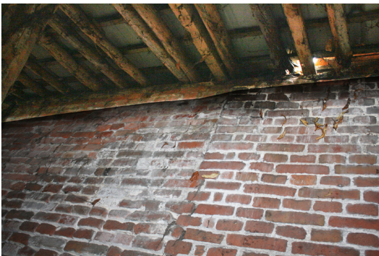
▲ foto 2.10: aanbouw noordelijk volume
