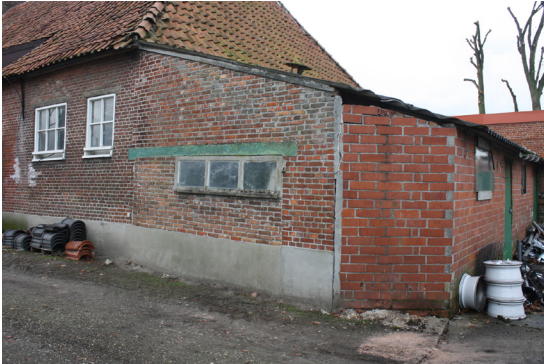
▲ foto 2.8: nieuwer metselwerk en snelbouwsteen, ander metselwerkverband van latere volumes aan de noordzijde, groene kleur balk (baksteenmaat onderaan: 200x?x45mm baksteenmaat boven en rechts: 180x80x47mm)
