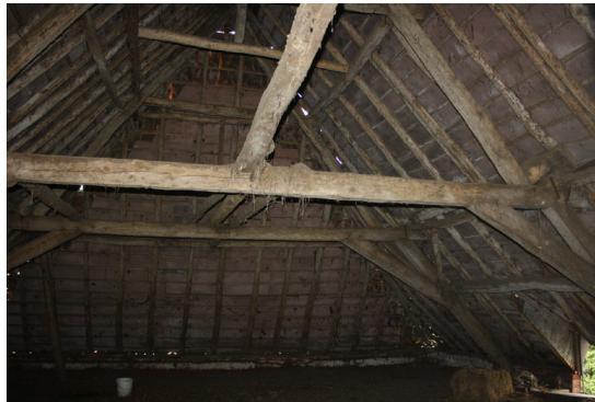
▲ foto 3.2: woonstalhuis dakconstructie stal
