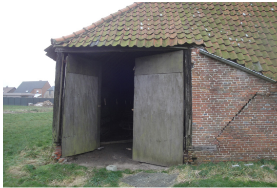
▲ foto 3.33: schuur poort noordkant
