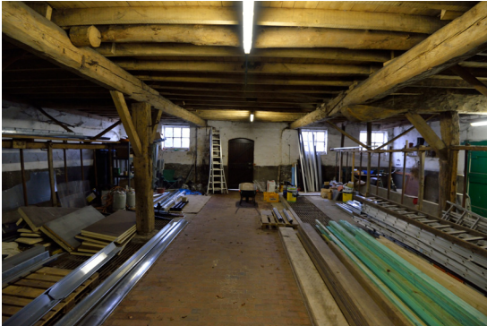
▲ foto 3.5: woonstalhuis constructie stal
