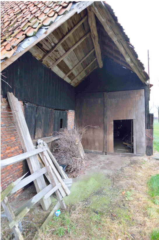
▲ foto 3.32: schuur poorten zuidkant
