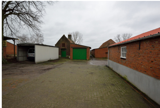
▲ foto 2.4: snelbouwsteen, nieuwere baksteen en golfplaten nieuwe aanbouw
