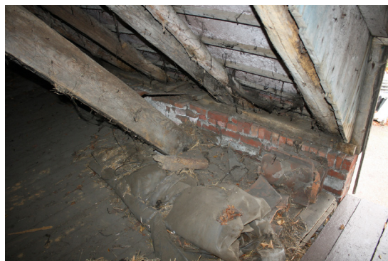
▲ foto 2.14: onderbreking in metselwerk aan binnenzijde van vroegere oostelijke stalpoort
