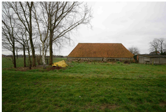
▲ foto 3.30: schuur gevel west
