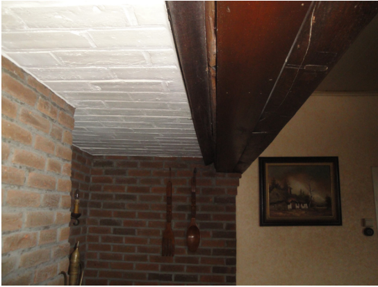
▲ foto 2.18: oorspronkelijke balk haard zichtbaar onder omkasting
