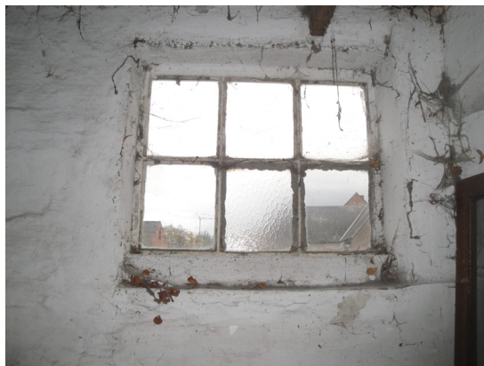
▲ foto 3.14: woonstalhuis betonnen stalramen
