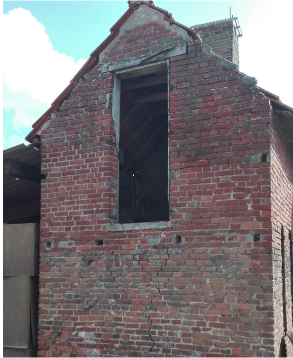
▲ foto 2.34: oud en nieuw metselwerk zuidgevel
