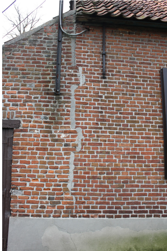
▲ foto 2.11: onderbroken metselwerk ter hoogte van kolenhok (baksteenmaat: 200x95x50mm)
