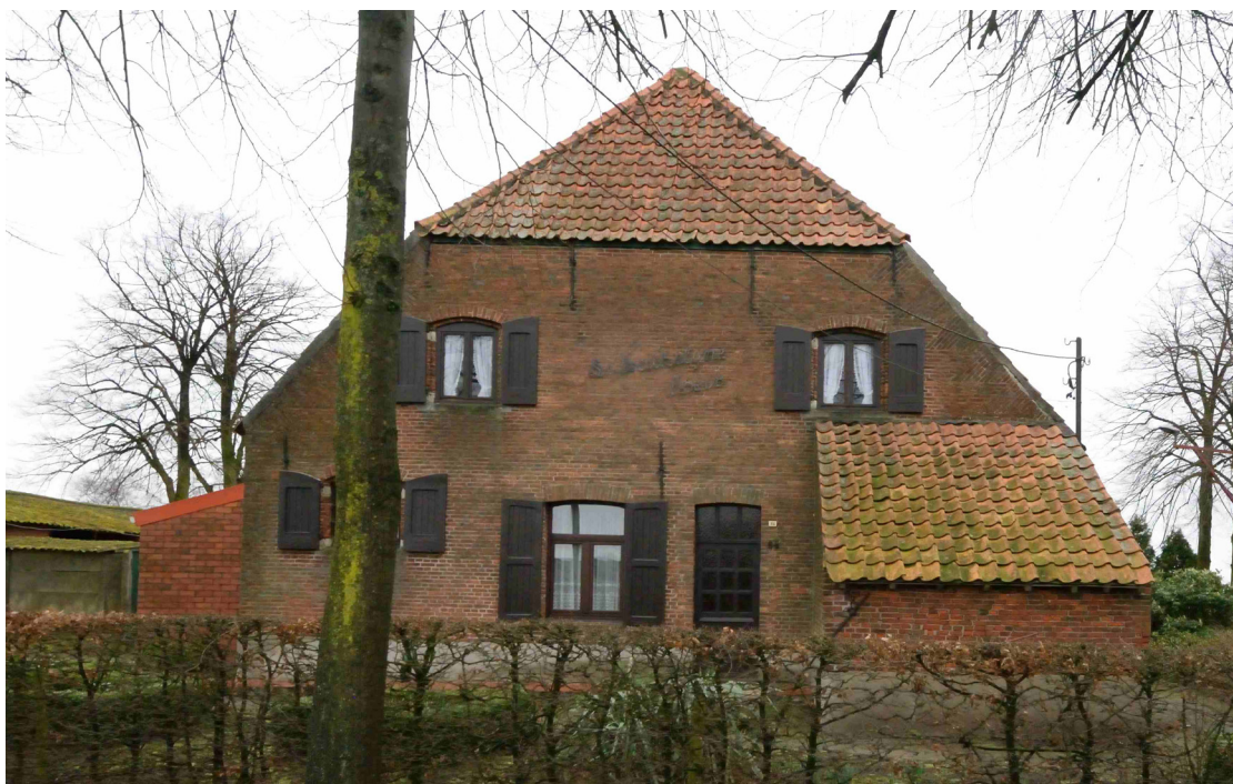
▲ foto 2.17: sporen aan gevelopeningen in zuidgevel
