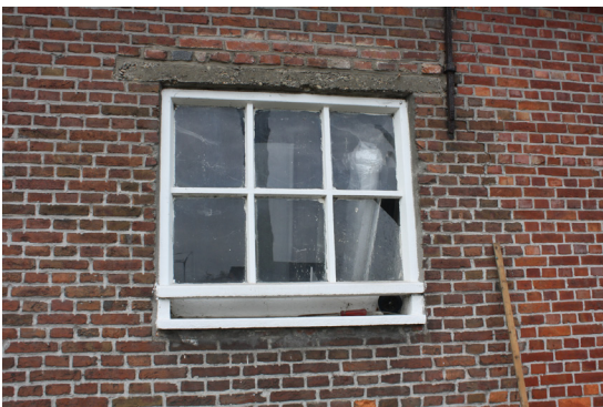
▲ foto 3.13: woonstalhuis betonnen stalramen
