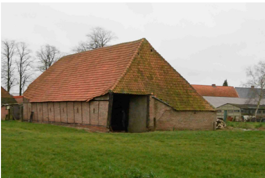
▲ foto 3.29: schuur gevel noord
