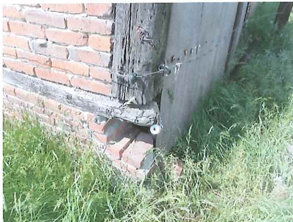
Ingerotte houtverbinding, noordoostelijke hoek
