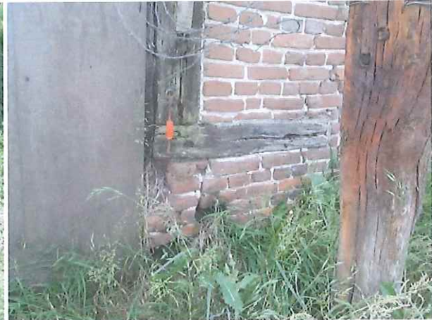
Ingerotte houtverbinding naast noordelijke poort
