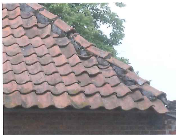
Dak [1]-noordwestelijke hoekkeper
