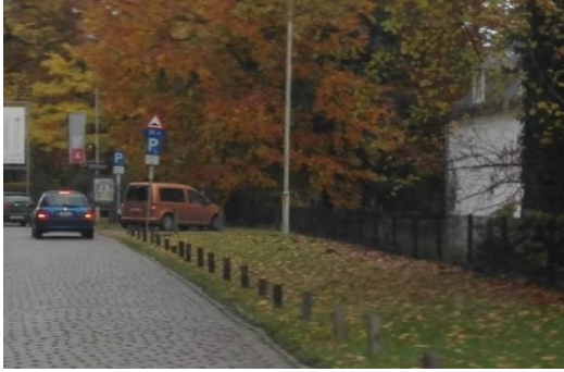
Foto: bescherming van een berm tegen wagengebruik met lage blokpaaltjes
