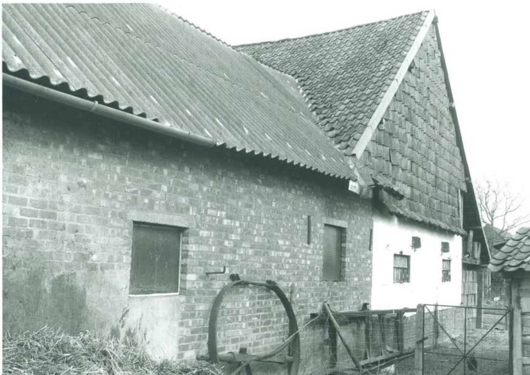
Afb. 7: zicht op de achterzijde van de hoeve. Links de versteende zuidelijke stal en rechts de zijgevel van de oostelijke vleugel in vakwerk met pannen beschieting in de geveltop.
