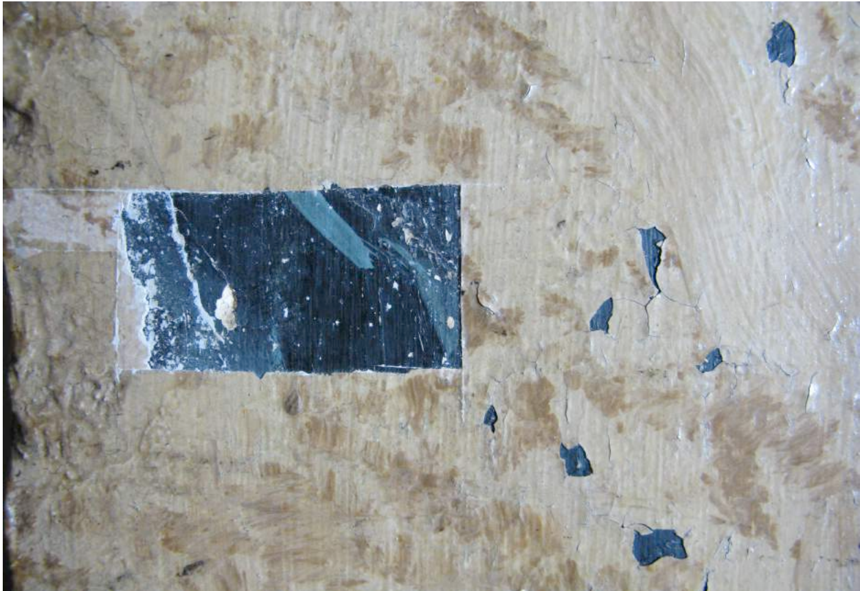
Controlesondering zwarte marmerimitatieschildering
