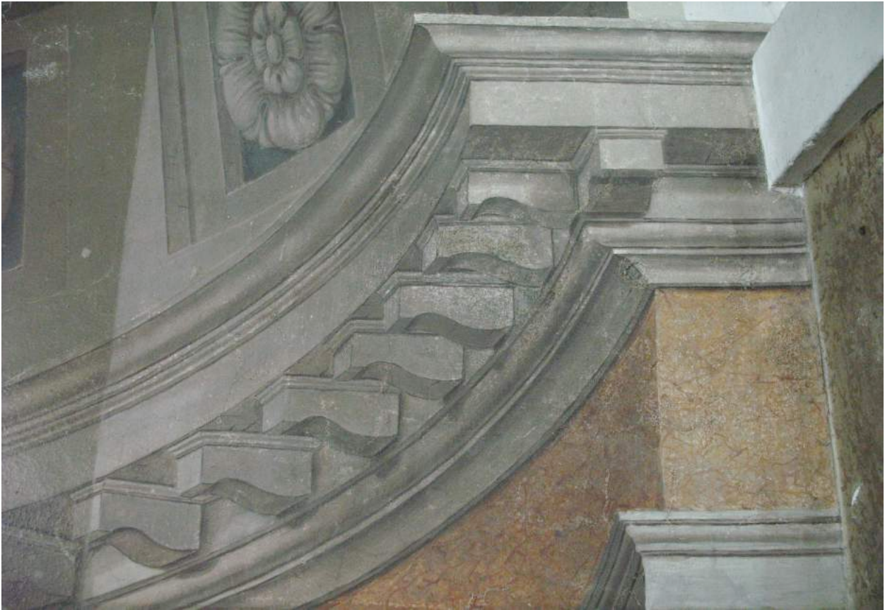
Proef 2: Zuidtransept, nis, na consolidatie/fixatie en na retouche: detail.
