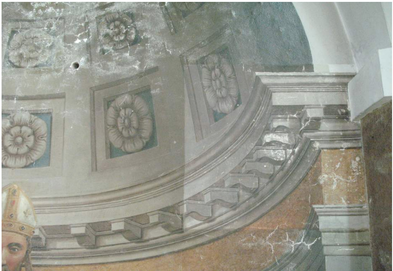
Proef 2: Zuidtransept, nis, na verwijderen van zouten en na vernisafname.
