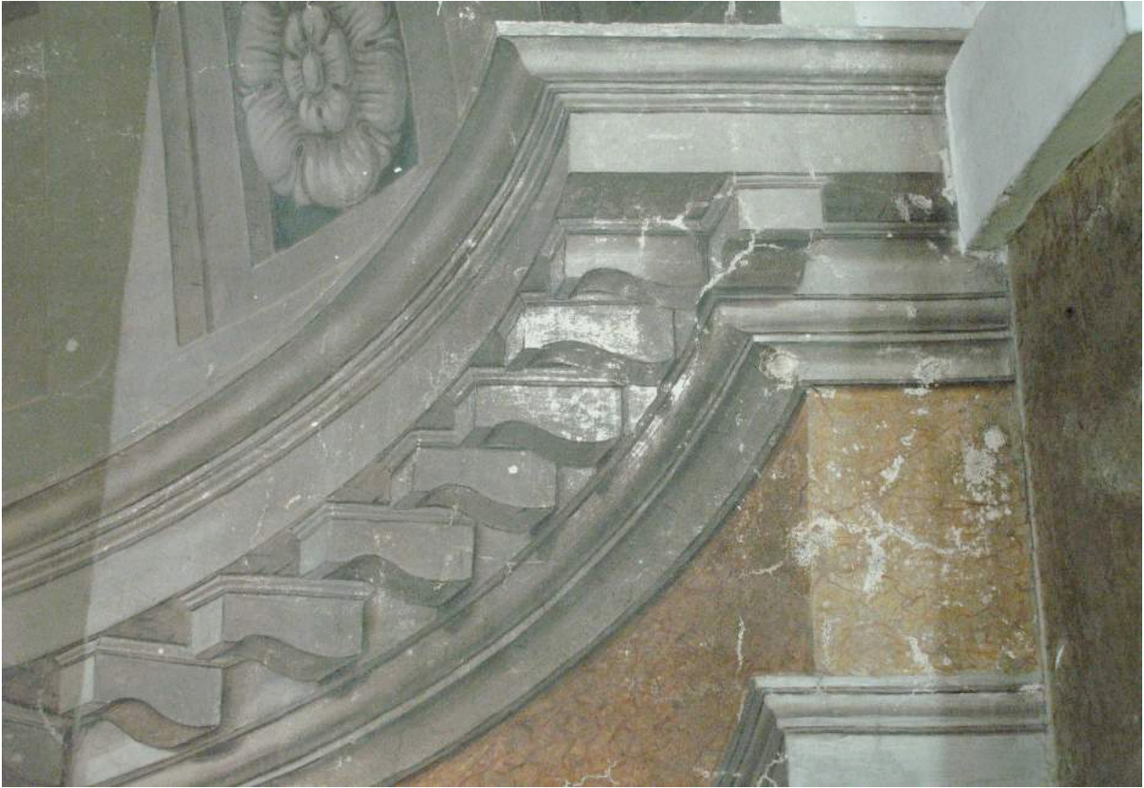
Proef 2: Zuidtransept, nis, na verwijderen van zouten en na vernisafname: detail.
