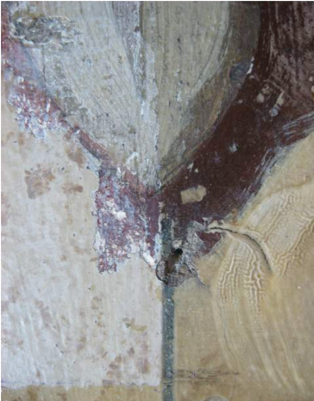
Koor, figuratieve schildering op rechter penant: vrijlegproef naar tweede fase, detail.
