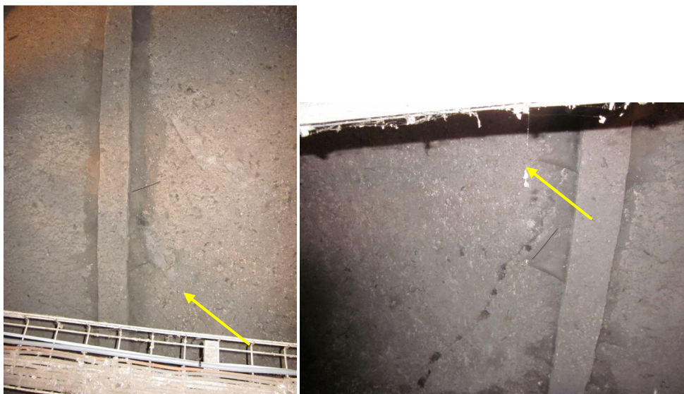
Figuur 5: kruisribgewelven in de middenvleugel van de kerk gezien vanaf de bovenzijde
