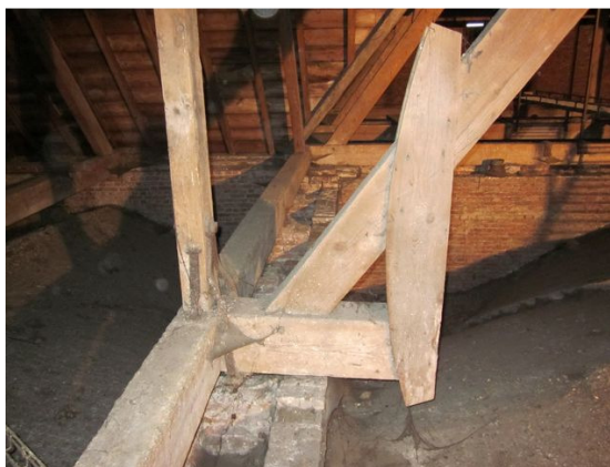
Figuur 12: afwijkende vormgeving van spanttype 3
