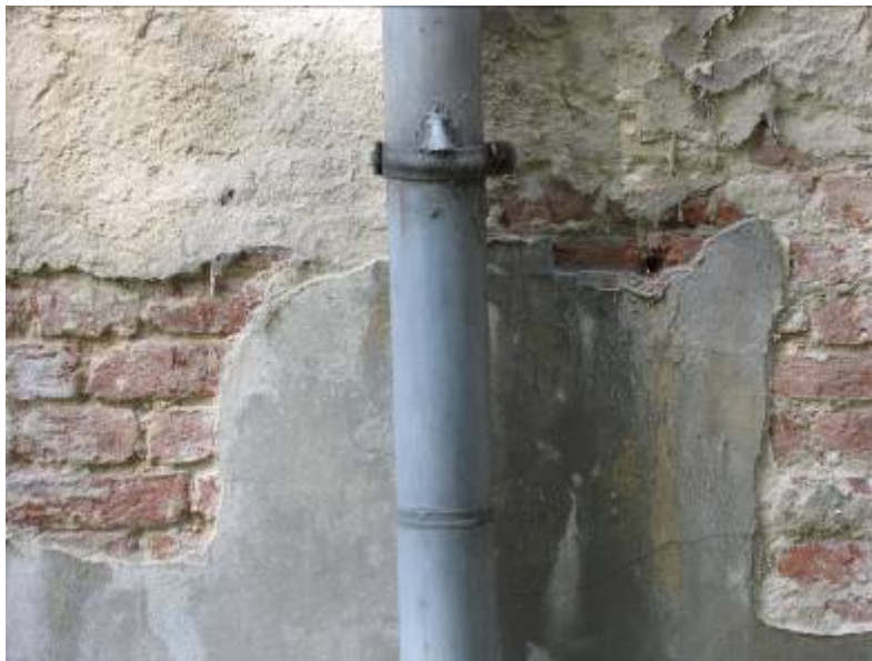
Fig. 10: oostvleugel, bouwnaad tussen de derde en de vierde travée (optellend vanaf de abdijkerk). De bouwnaad bevindt zich achter de regenpijp, maar wordt aangegeven door de verschillende positie van de lintvoegen links en rechts van de regenpijp.
