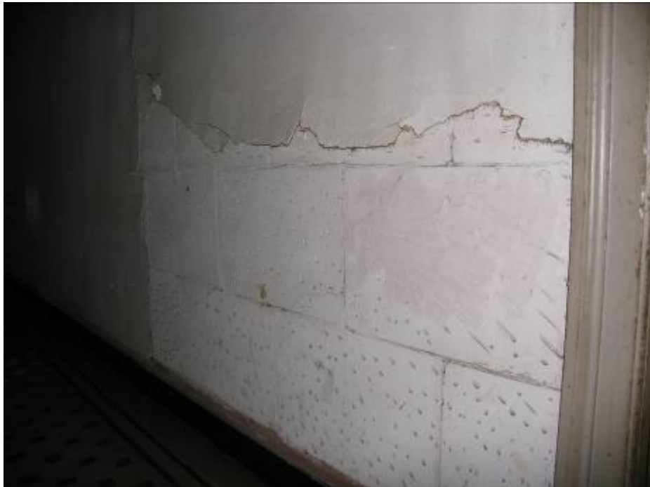
Fig. 19: middengang van de oostvleugel ter hoogte van vertrek 131-132. Vernieuwde oostwand in gipsplaten.
