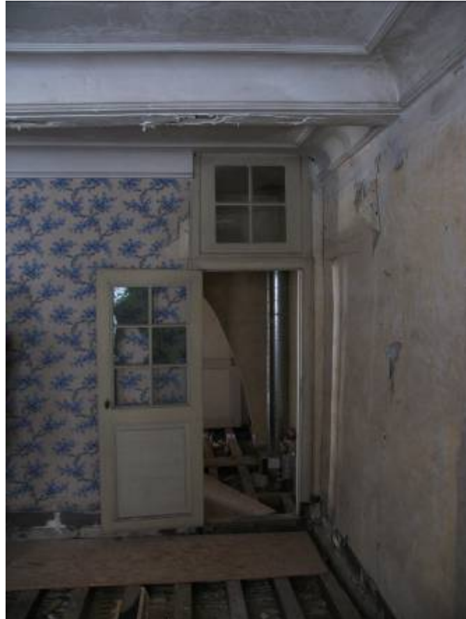
Fig. 20: Hingene (Bornem), kasteel d'Ursel. Vertrek op eerste verdieping: plafond versierd met kooflijst afgeboord met profielen, Venster boven de deur. Jaren 1790.
