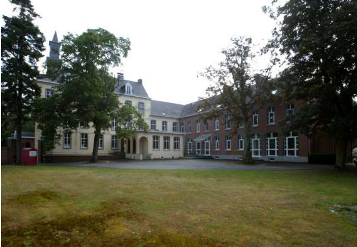
Fig. 5: de westvleugel en de voormalige vleugel van de lekenbroeders, gezien vanuit het noordwesten. Bemerkt het zgn. college met twee verdiepingen.
