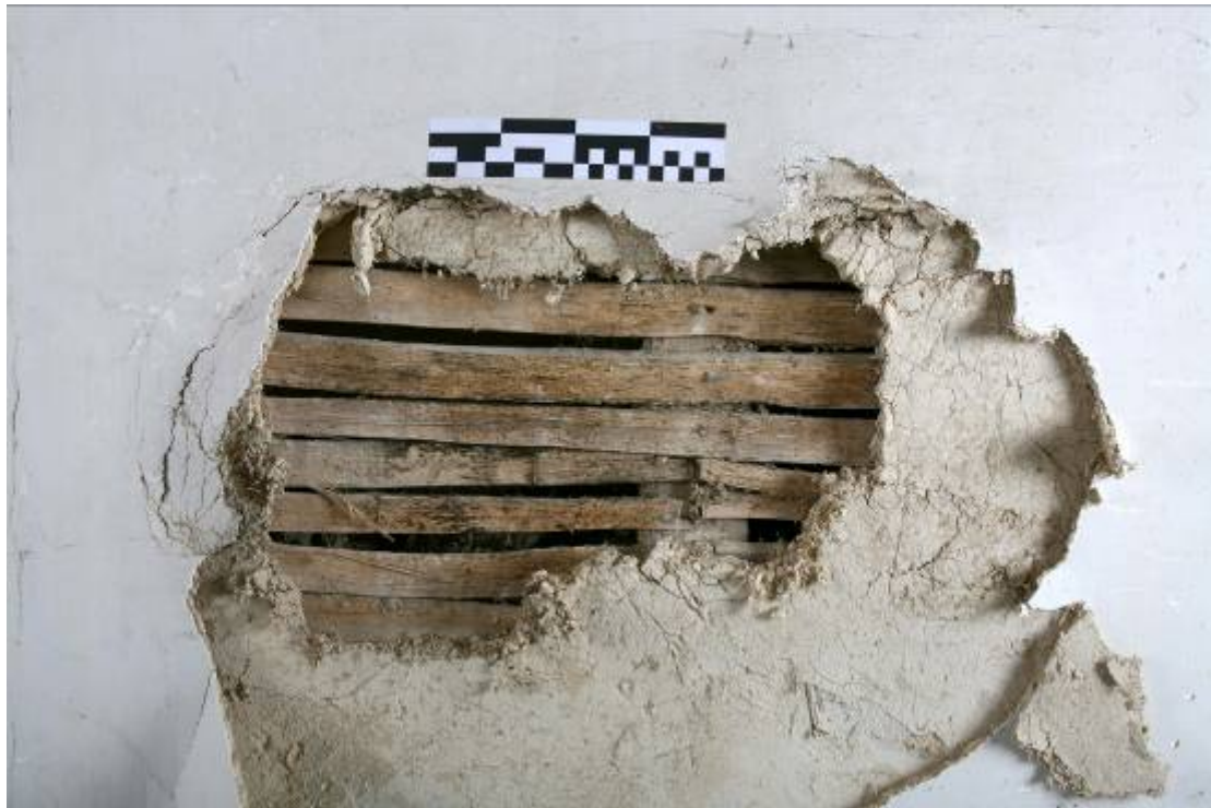
Fig. 16: oostwand van de middengang ter hoogte van vertrek 127-128. Stijl- en regelwerk waarop houten latjes zijn gespijkerd, vervolgens bepleisterd.
