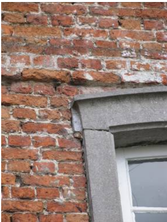
Fig. 8: hardstenen vensterlijst, rechts van de bouwnaad in de westvleugel. Met blokvorm van de segmentboog.
