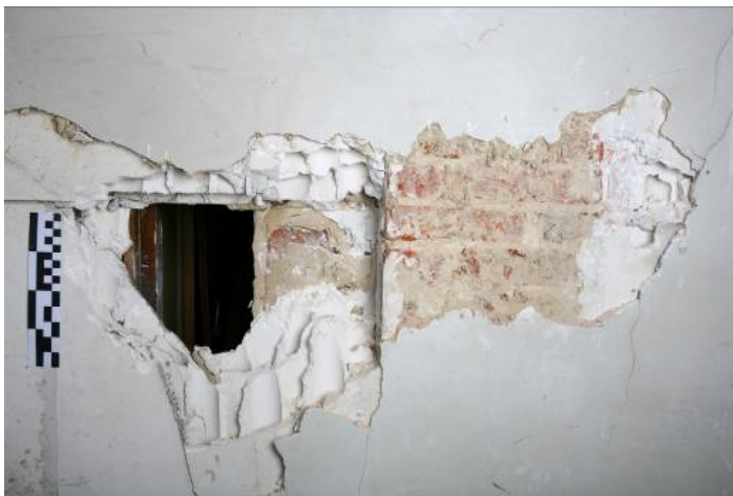
Fig. 15: bakstenen dwarsmuur tussen de vertrekken 128 en 129, gezien vanuit de middengang.
