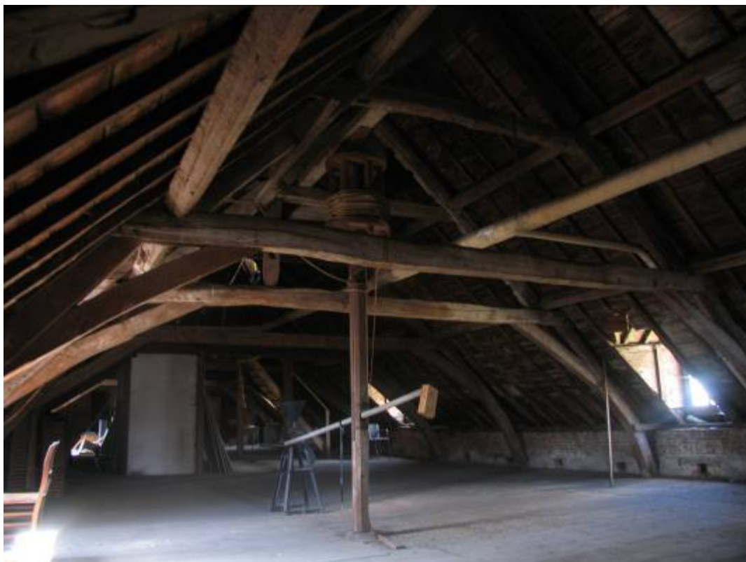
Fig. 13: zicht op de dakkap van de zuidvleugel.
