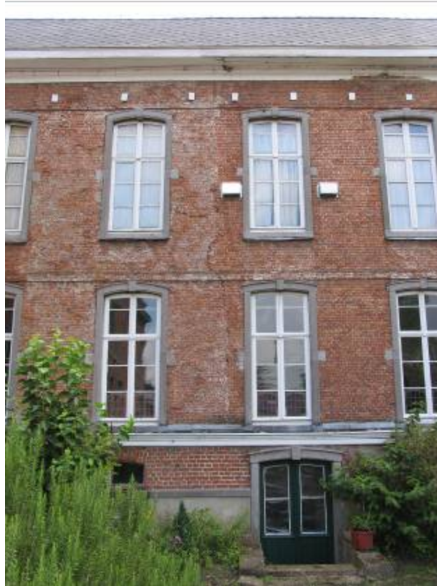
Fig. 7: westvleugel, bouwnaad tussen de tweede en derde travee (optellend vanaf de voormalige vleugel van de lekenbroeders).
