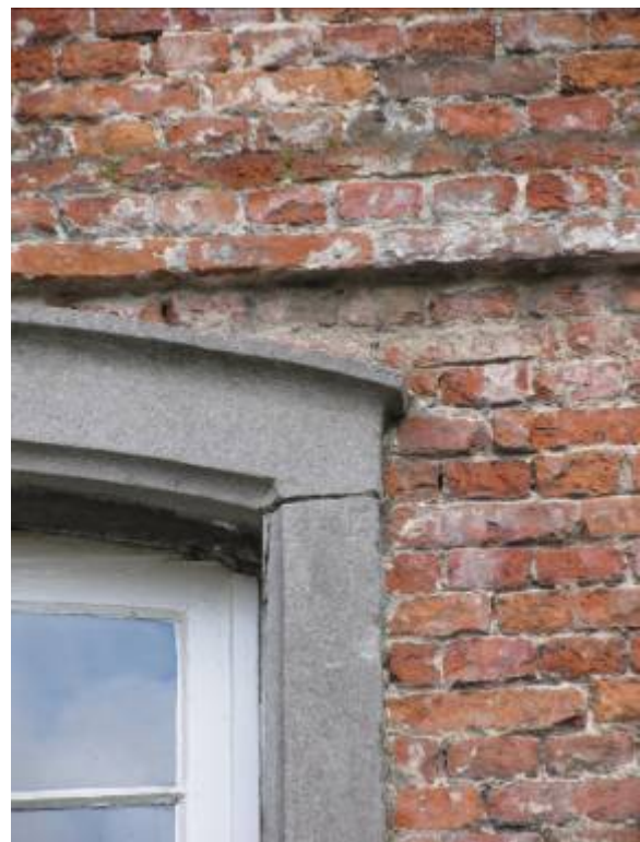
Fig. 9: hardstenen vensterlijst, links van de bouwnaad in de westvleugel. Zonder blokvorm van de segmentboog.
