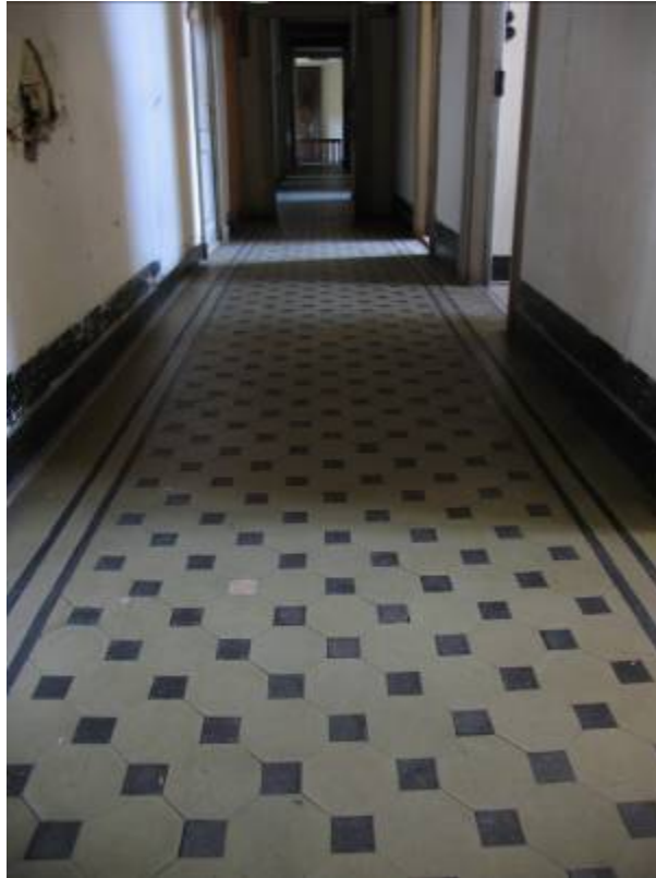
Fig. 18: middengang van de oostvleugel, vloerbedekking in linoleum.
